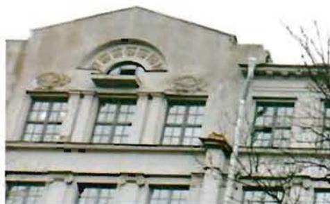
антаблемент между 4-м и 5-м этажами (гладкий фриз, профилированный карниз);
