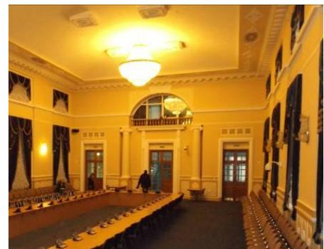
дверное заполнение (одинаковое для трех дверных проемов) – материал (дерево), конструкция (двухстворчатая, каждая створка на три филенки, в верхней части остеклена на 6-ть частей; фрамуга восьмичастного остекления (фацет); в нижней части "отбойники" из латунных пластин;
