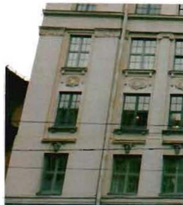
сдвоенные пилястры фланкируют оконный проем по 10-й световой оси в уровне 5-го этажа;
