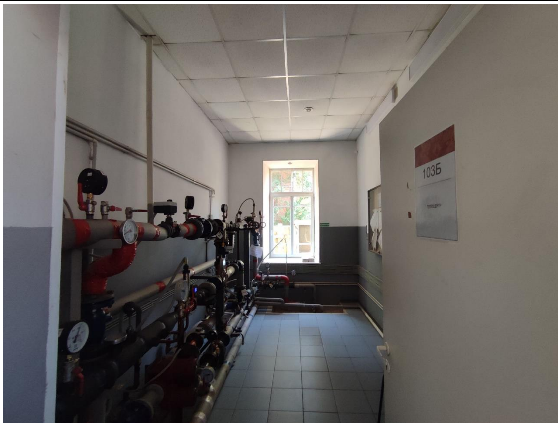
14. Общий вид пом. 1-Н (9) в уровне 1-го этажа.
