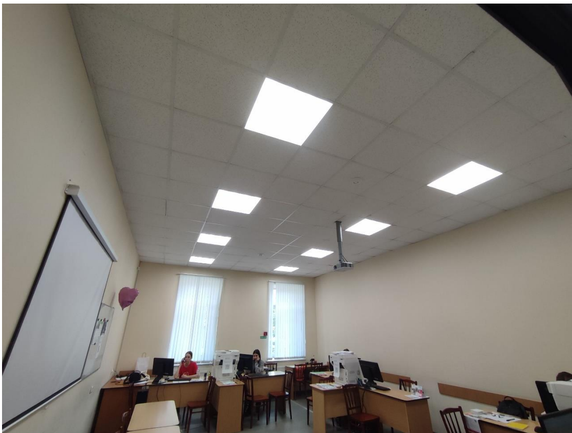
22. Общий вид пом. 1-Н (29) в уровне 1-го этажа.
