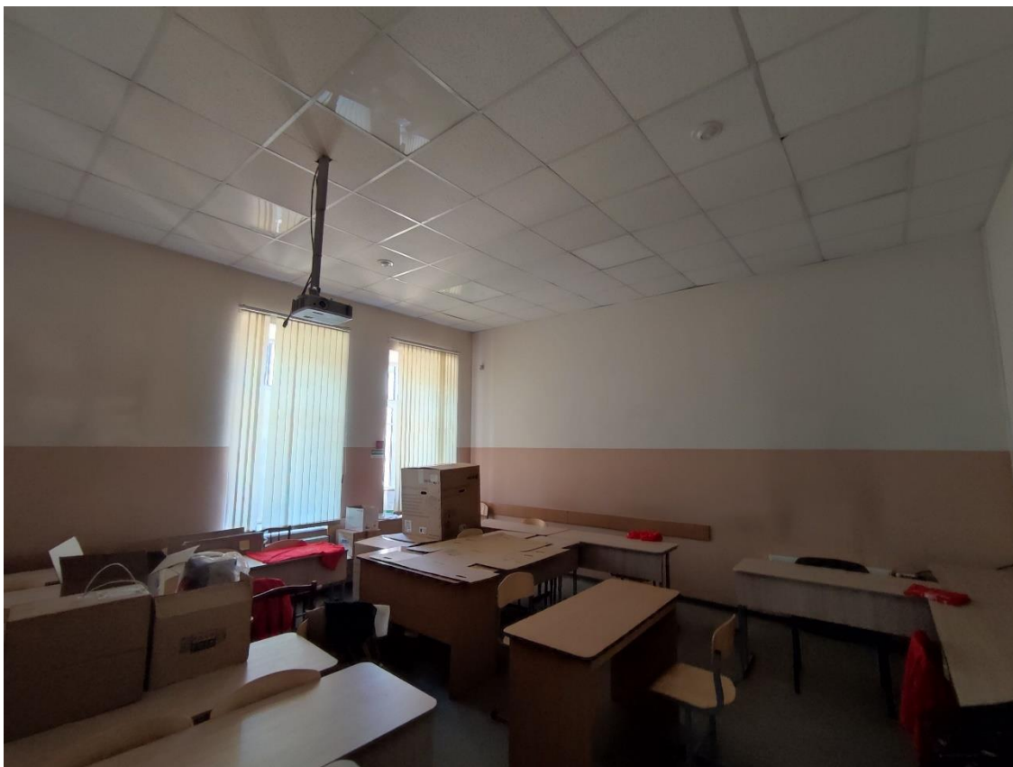
24. Общий вид пом. 1-Н (25) в уровне 1-го этажа.
