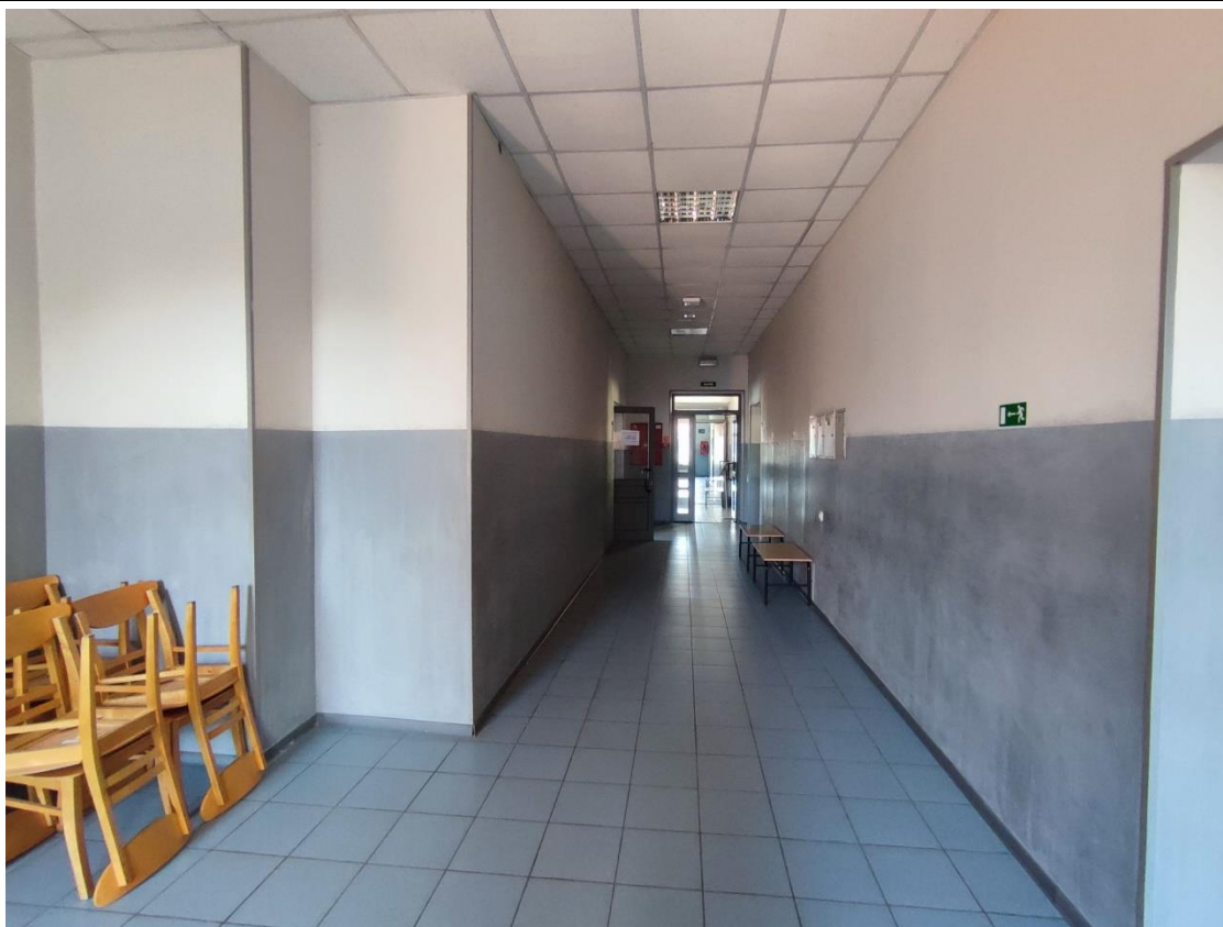
44. Общий вид пом. 1-Н (54) в уровне 3-го этажа.
