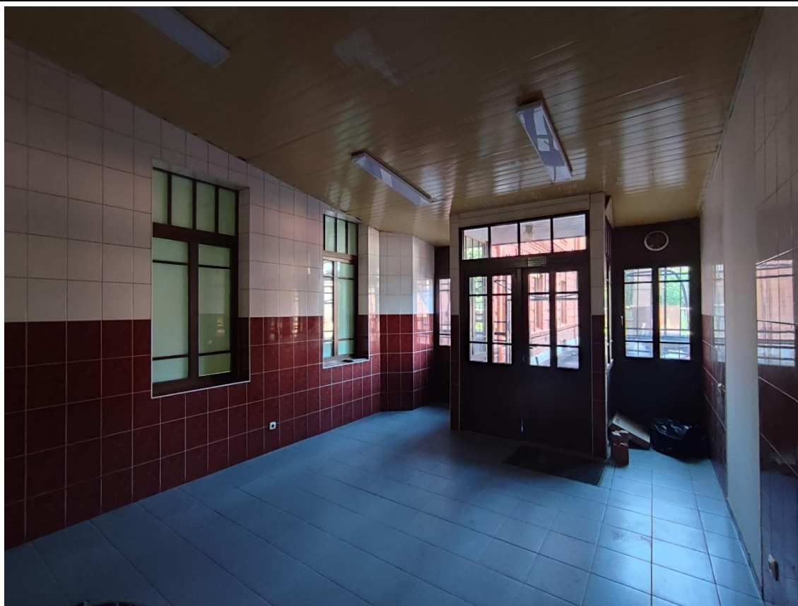
20. Общий вид пом. 1-Н (23) в уровне 1-го этажа.
