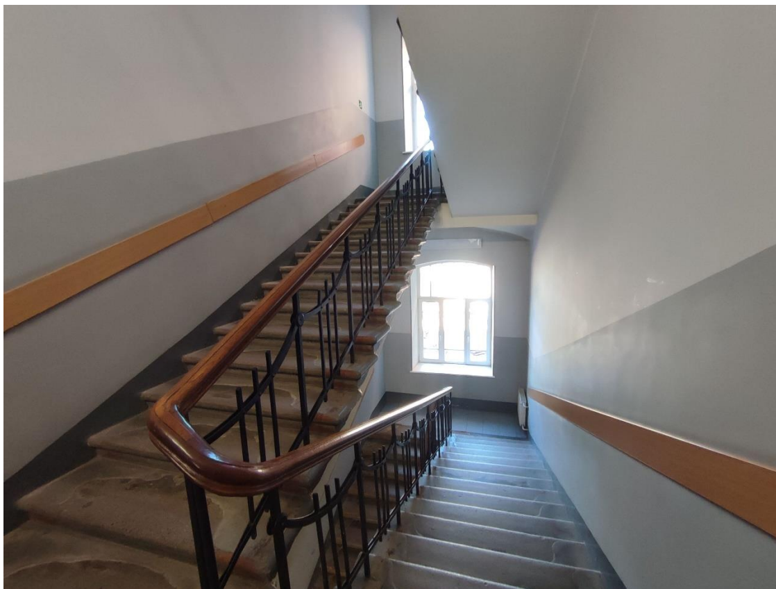
34. Общий вид главной двухмаршевой лестницы (пом. 1-Н (30)) в уровне 2-го этажа.
