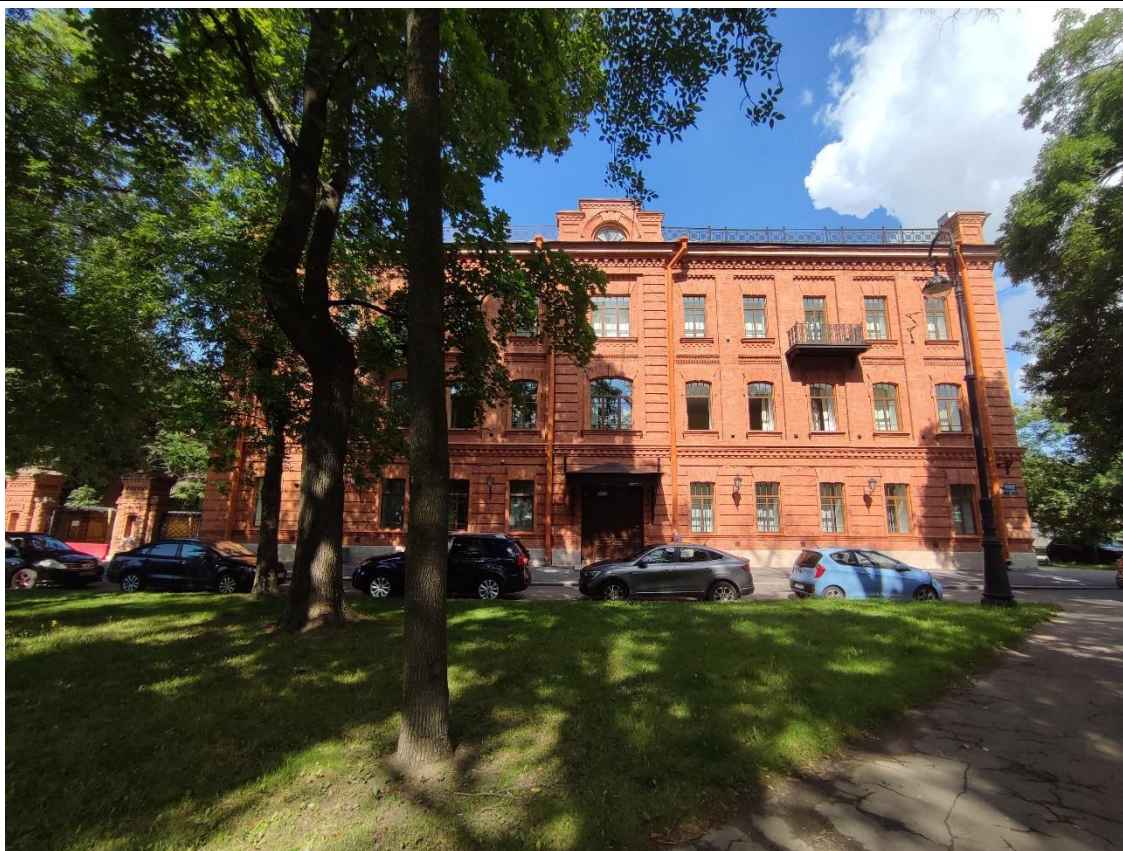
2. Общий вид юго-восточного лицевого фасада объекта культурного наследия регионального значения «Полицейский дом».
