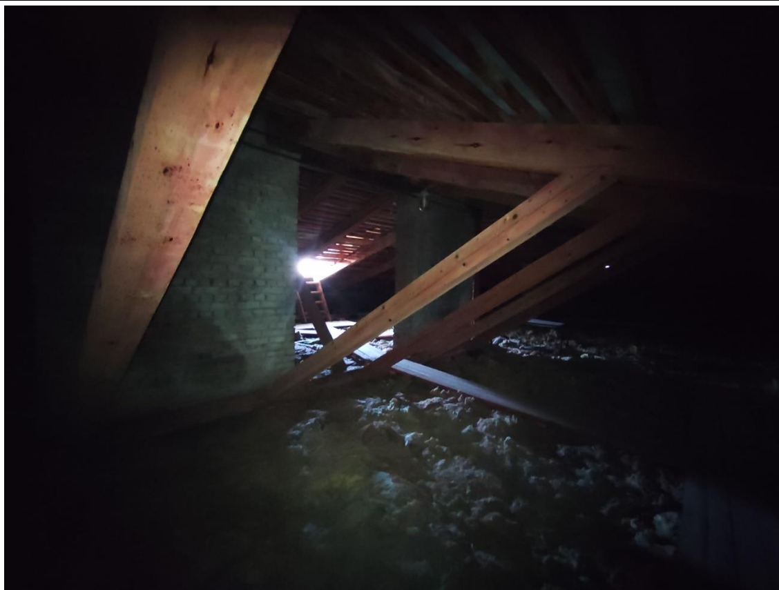
55. Элементы стропильной системы крыши в северной части здания.
