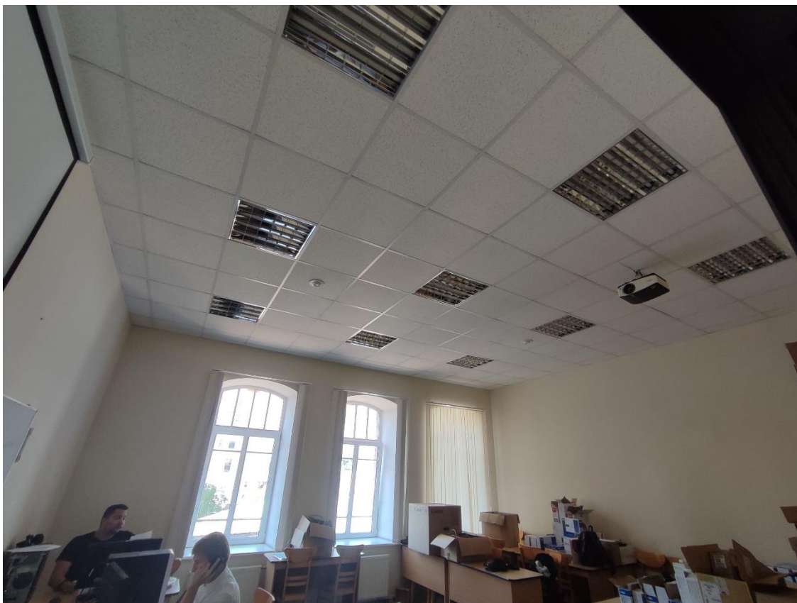
28. Общий вид пом. 1-Н (46) в уровне 2-го этажа.
