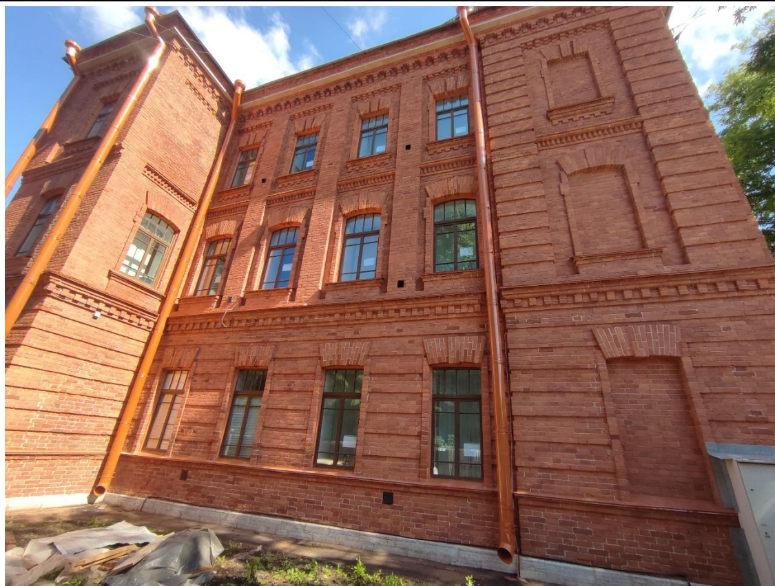
4. Общий вид юго-западного торцевого фасада объекта культурного наследия регионального значения «Полицейский дом».
