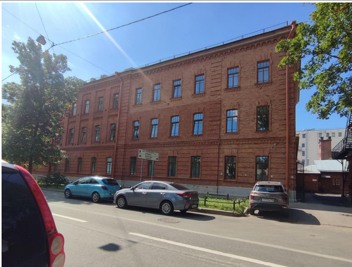
3. Общий вид северо-восточного лицевого фасада объекта культурного наследия регионального значения «Полицейский дом».
