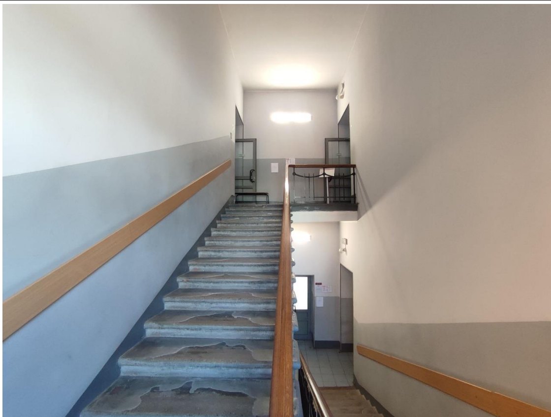
40. Общий вид главной двухмаршевой лестницы (пом. 1-Н (50)) в уровне 3-го этажа.
