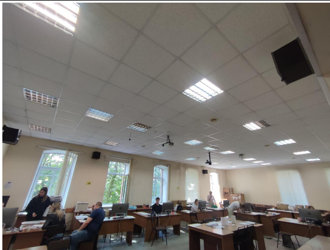
36. Общий вид пом. 1-Н (34) в уровне 2-го этажа.
