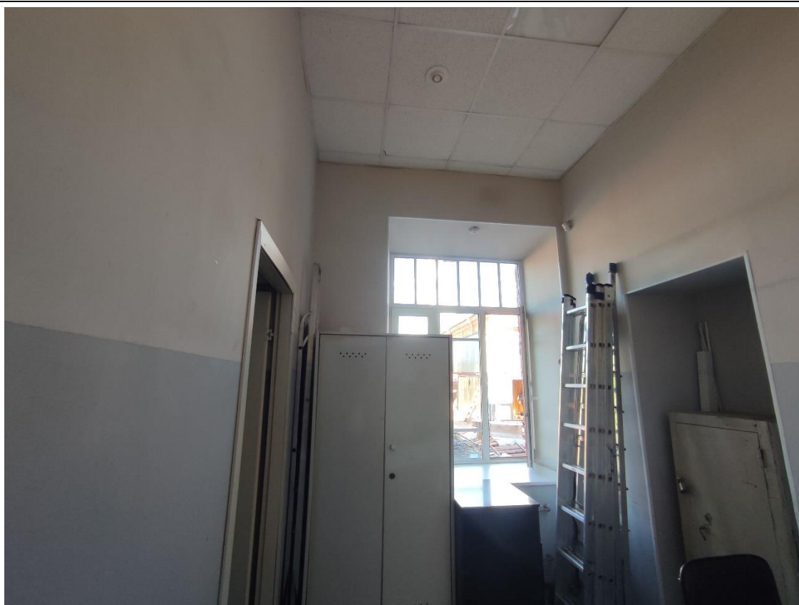
13. Общий вид пом. 1-Н (10) в уровне 1-го этажа.
