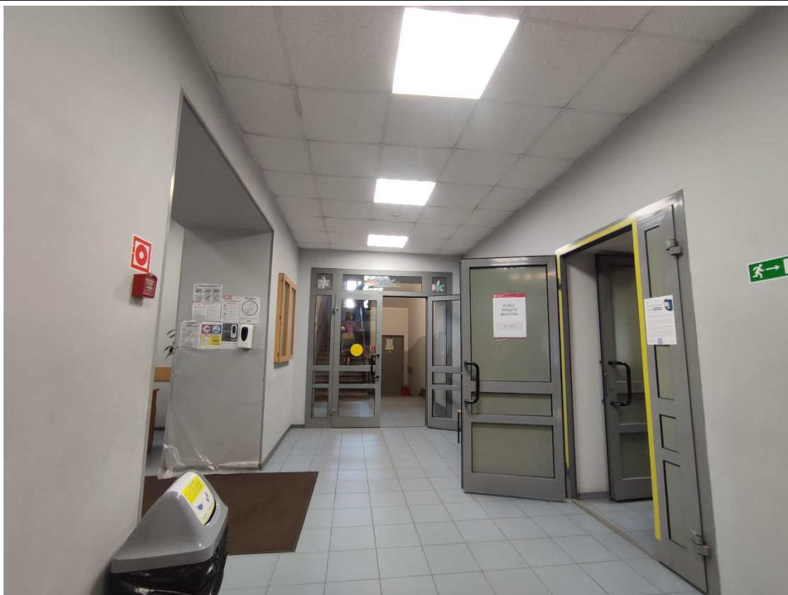
7. Общий вид пом. 1-Н (2) в уровне 1-го этажа.
