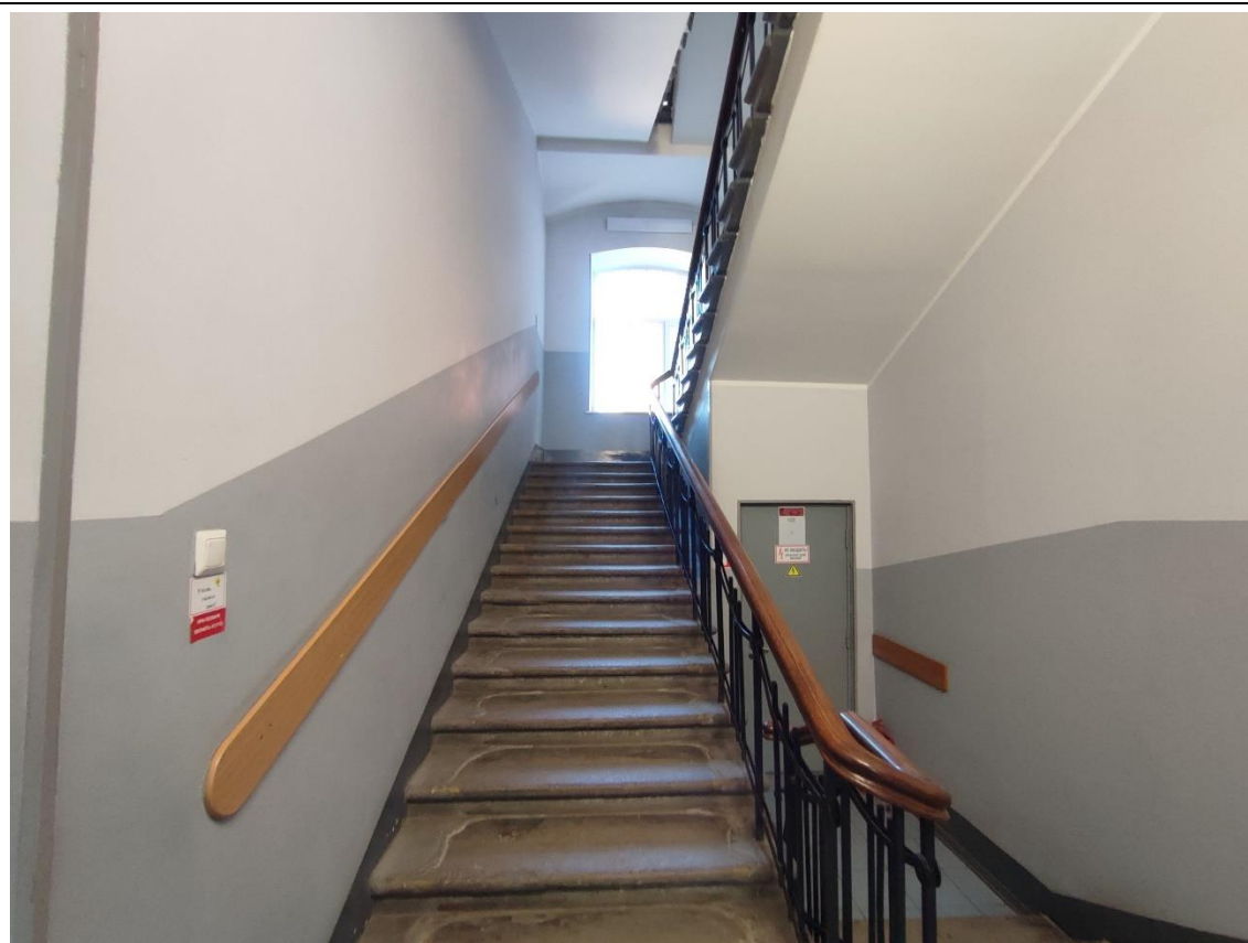
16. Общий вид главной двухмаршевой лестницы (пом. 1-Н (3)) в уровне 1-го этажа.
