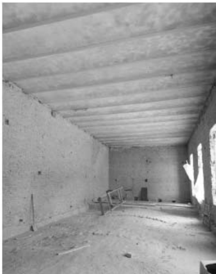
Фото 15.Общий вид южного помещения второго этажа, прусские перекрытия.
