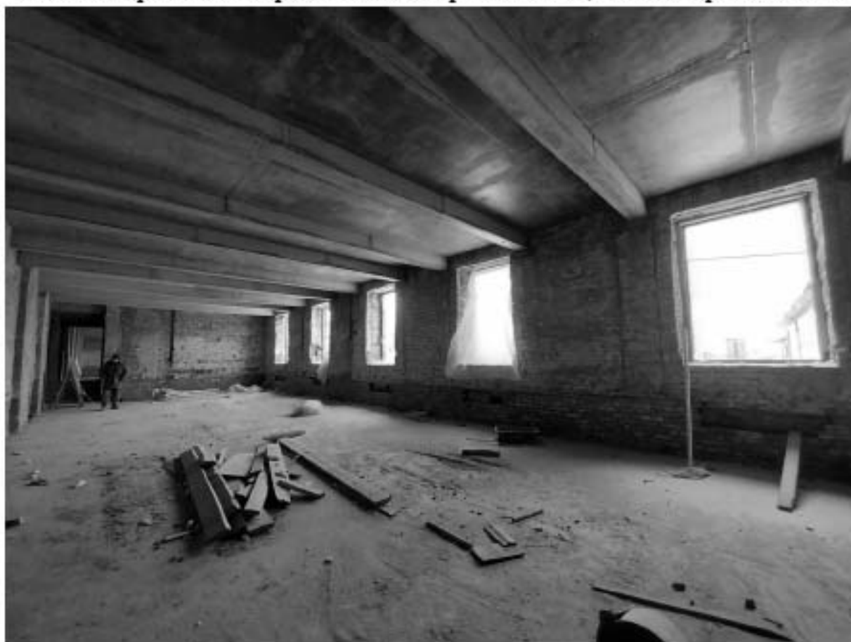
Фото 30. Общий вид северного помещения четверного этажа.
