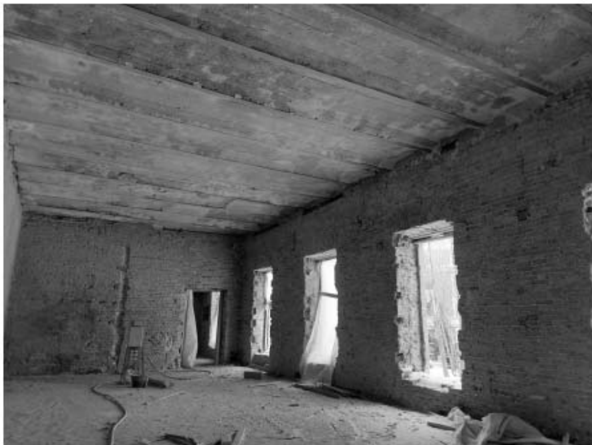
Фото 13. Помещение в северной части второго этажа, прусские перекрытия по металлическим балкам.
