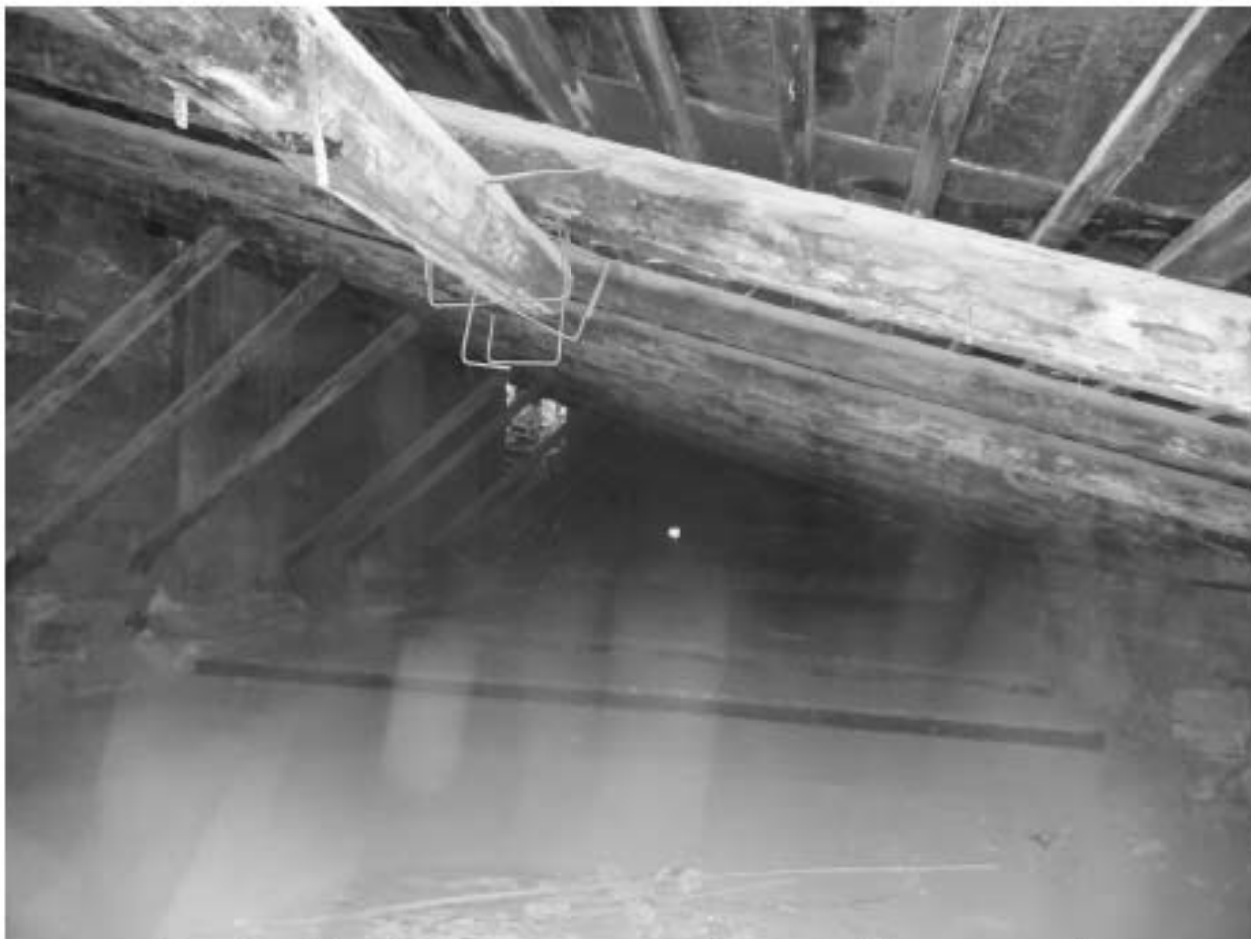
Фото 33. Общий вид со стропильной системой (южная часть)
