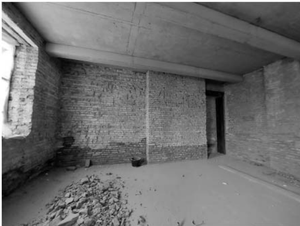
Фото 27. Фрагмент южного помещения четвертого этажа.
