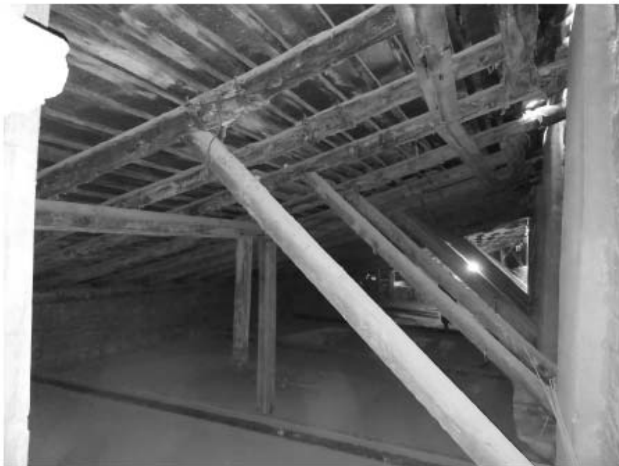
Фото 35. Общий вид и стропильной системы в северной части.
