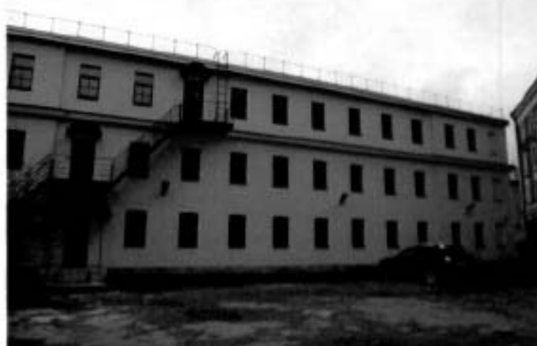
7. Объект культурного наследия регионального значения "Казарма для холостых нижних чинов с двумя дворовыми флигелями" (пр. Римского-Корсакова, дом 22, лит. В, Д) (Фрагмент дворового фасада)
