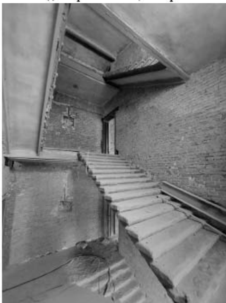
Фото 24. Общий вид лестницы на четвертый этаж.
