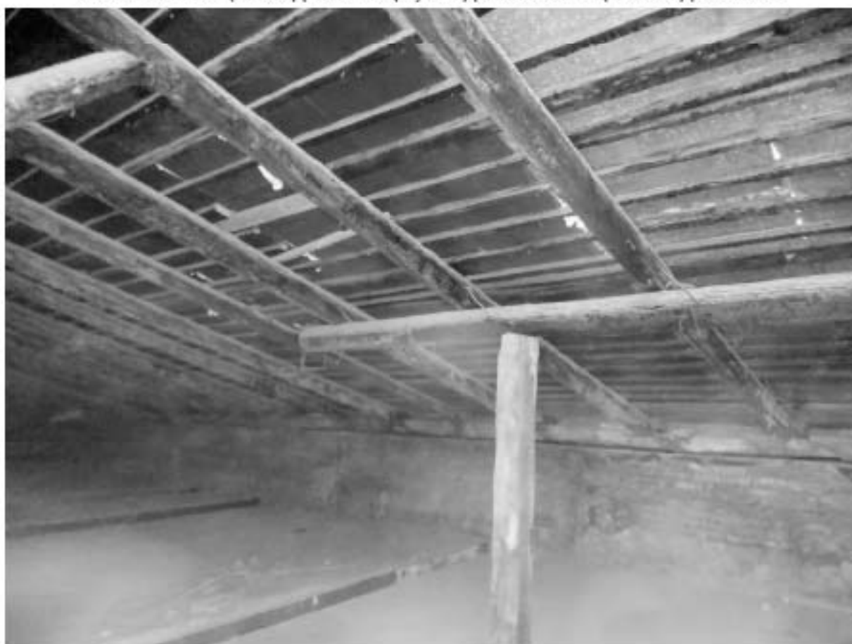
Фото 32. Фрагмент стропильной системы и обрешетки (южная часть).
