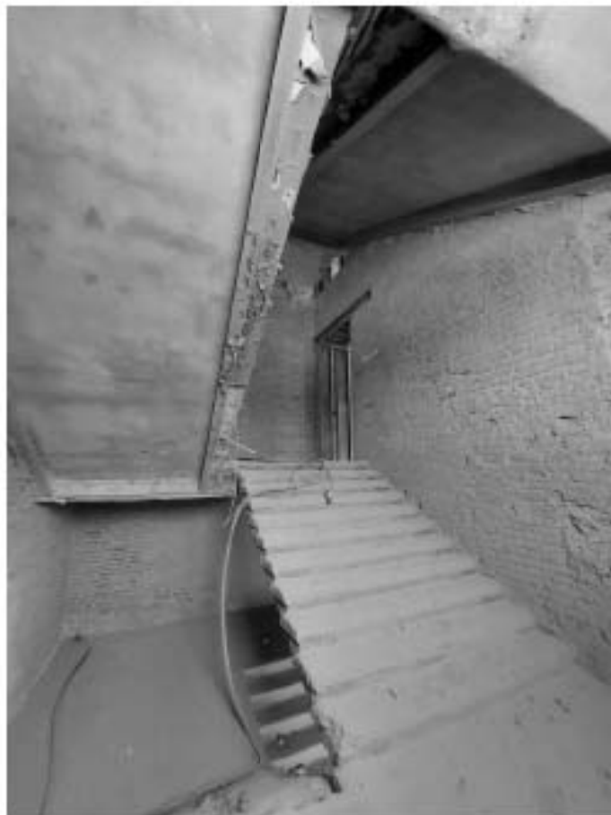
Фото 17. Общий вид лестницы с поздним измененным шагом.
