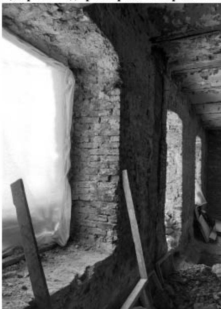
Фото 10. Северное помещение, прусские своды по металлическим балкам, проемы.
