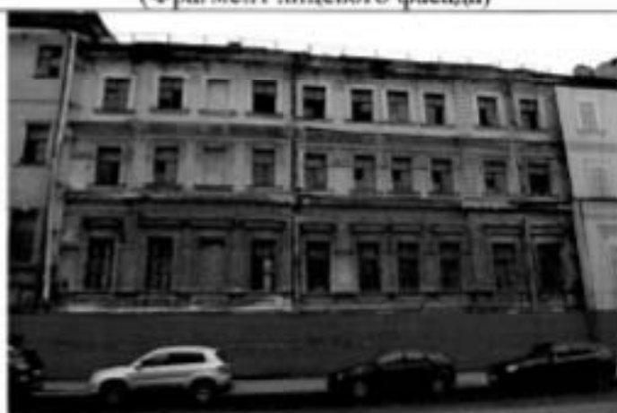
2. Объект культурного наследия регионального значения "Штаб и обер-офицерский дом" (пр. Римского-Корсакова, дом 22, лит. В) (Фрагмент лицевого фасада)
