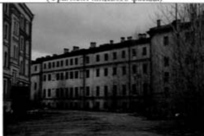
3. Объект культурного наследия регионального значения "Штаб и обер-офицерский дом" (пр. Римского-Корсакова, дом 22, лит. В) (Фрагмент дворового фасада)
