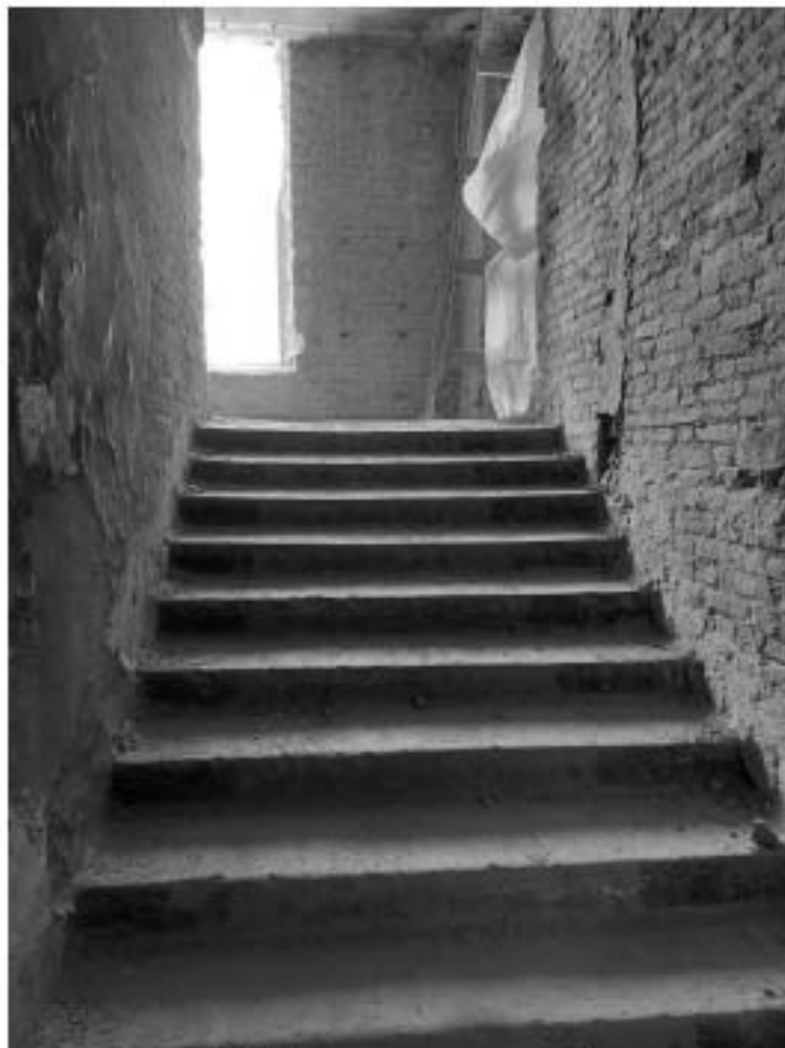
Фото 11. Лестница на второй этаж.
