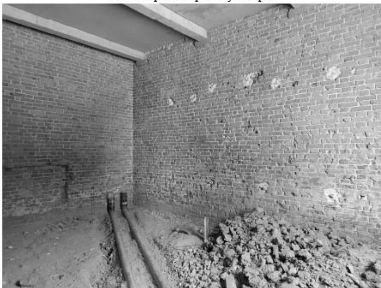
Фото 8. Крайнее южное помещение с поздним перекрытием.
