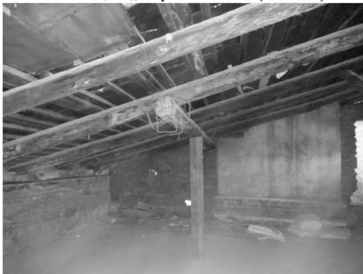
Фото 34. Северная стена и крыша в южной части.
