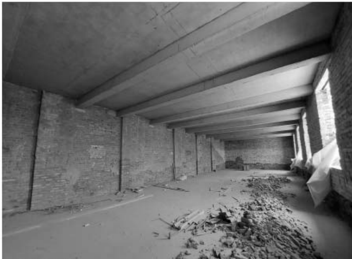
Фото 25. Общий вид южного помещения четвертого этажа, позднее перекрытие.
