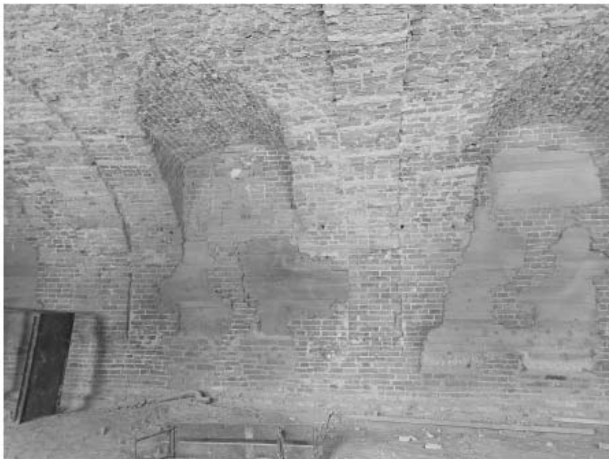
Фото 7. Фрагмент распалубок арки.
