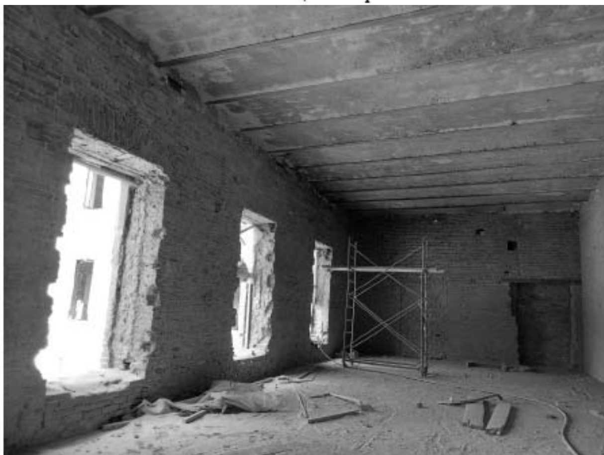
Фото 12. Общий вид северного помещения второго этажа.
