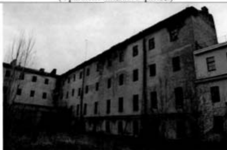
6. Объект культурного наследия регионального значения "Казарма для холостых нижних чинов с двумя дворовыми флигелями" (пр. Римского-Корсакова, дом 22, лит. В, Д) (Фрагмент дворового фасада)
