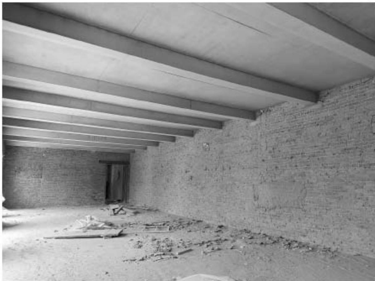
Фото 19. Помещение в южной части третьего этажа.
