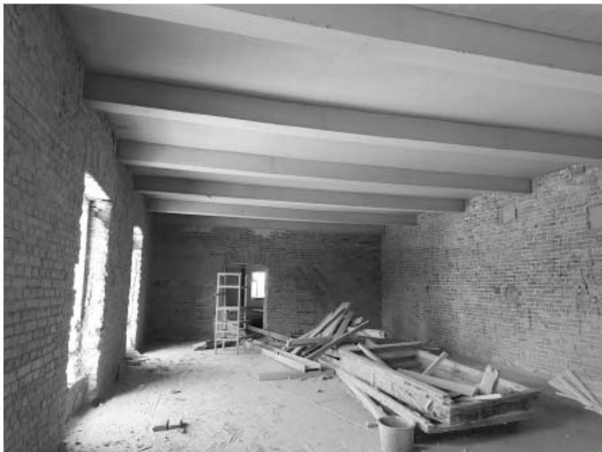
Фото 21. Общий вид северного помещения третьего этажа, поздние перекрытия.
