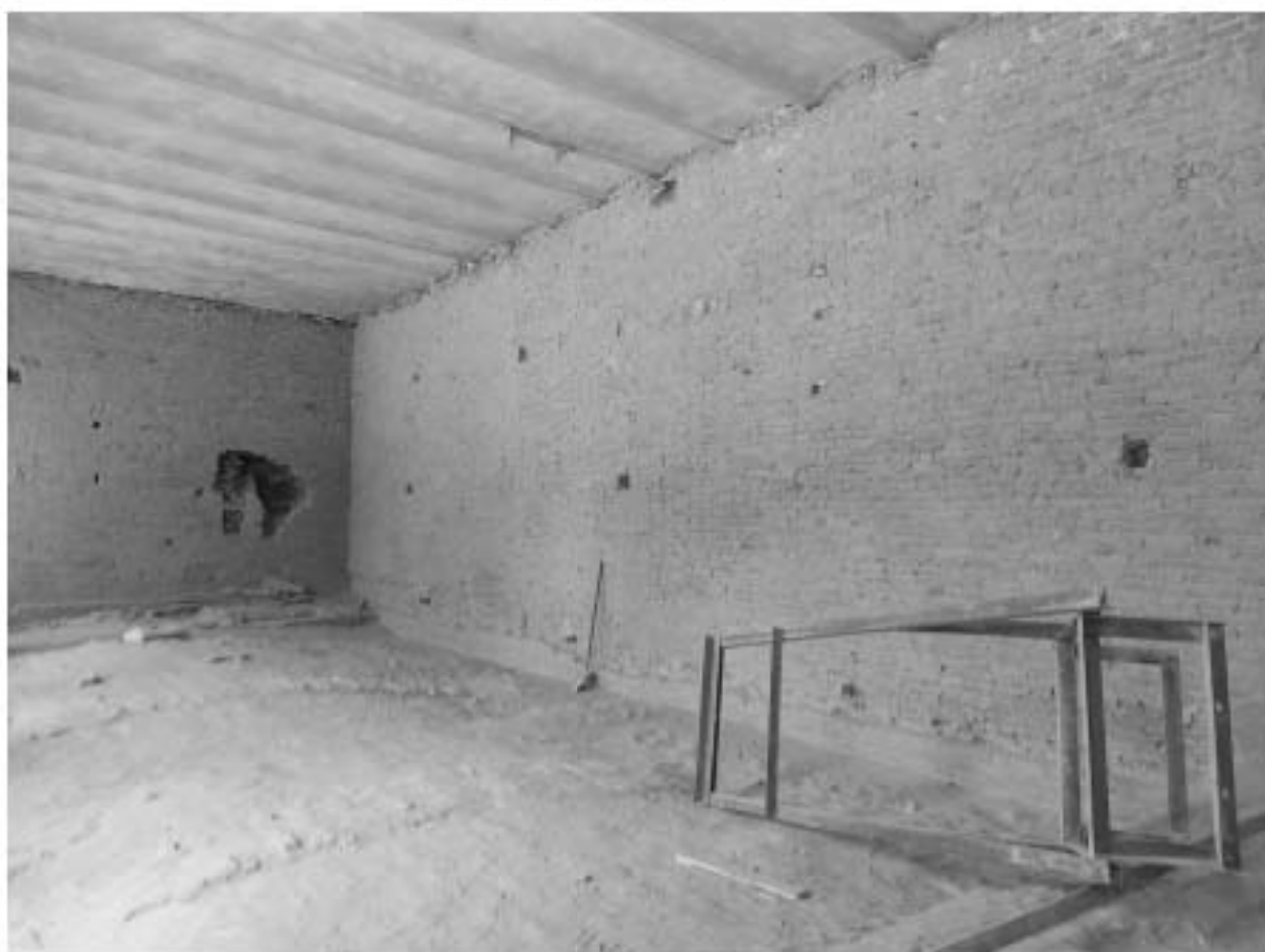
Фото 14. Южное помещение второго этажа, восточная стена.
