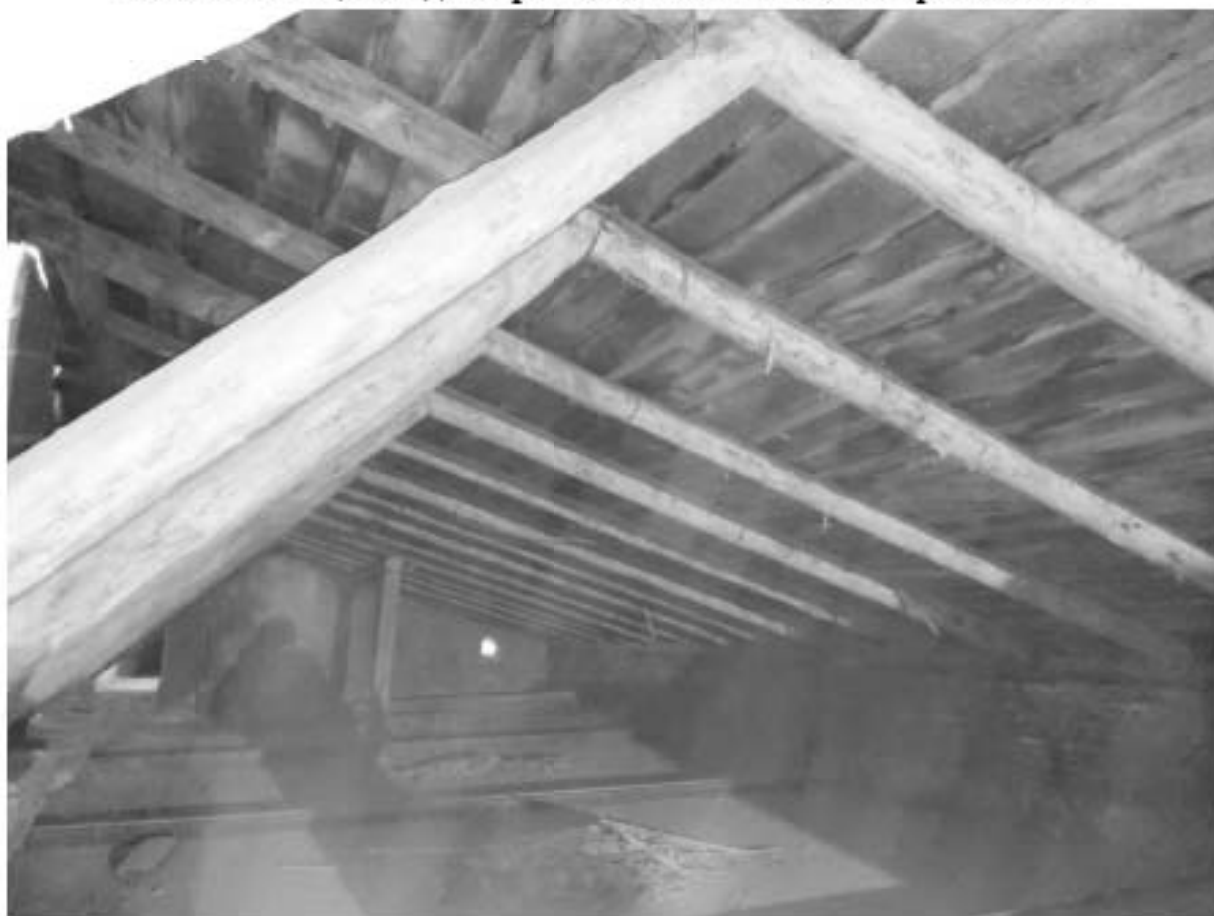
Фото 36. Стропильная система северной части.
