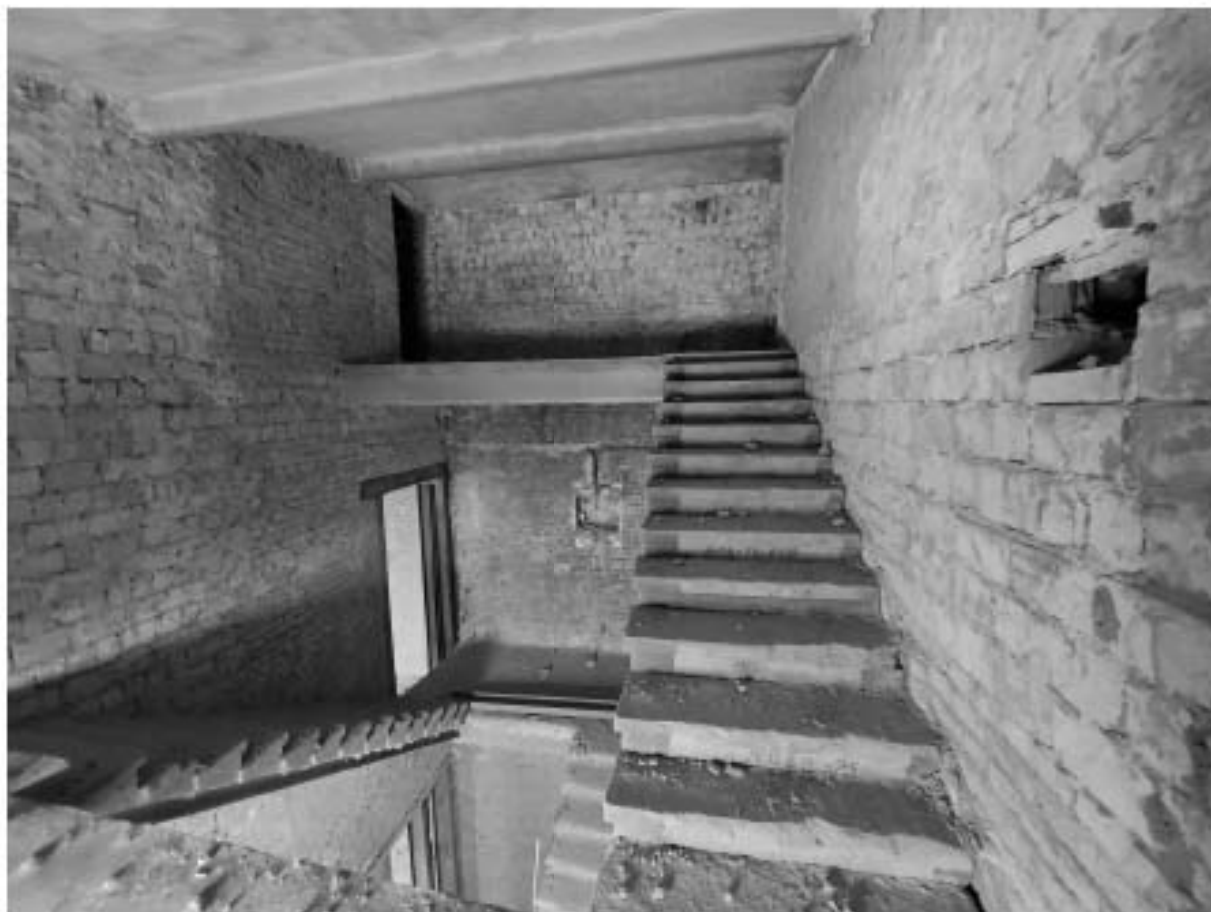
Фото 31. Общий вид лестницы, поздняя лестница и кладка стен.
