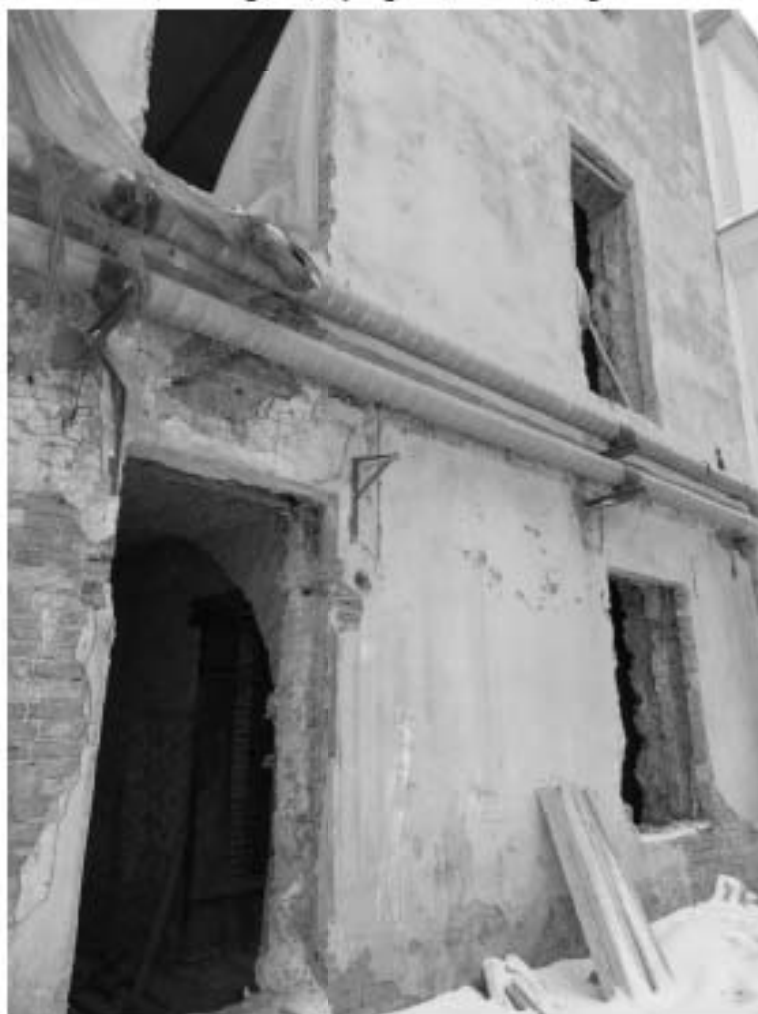
Фото 4. Южная часть фасада (вход).
