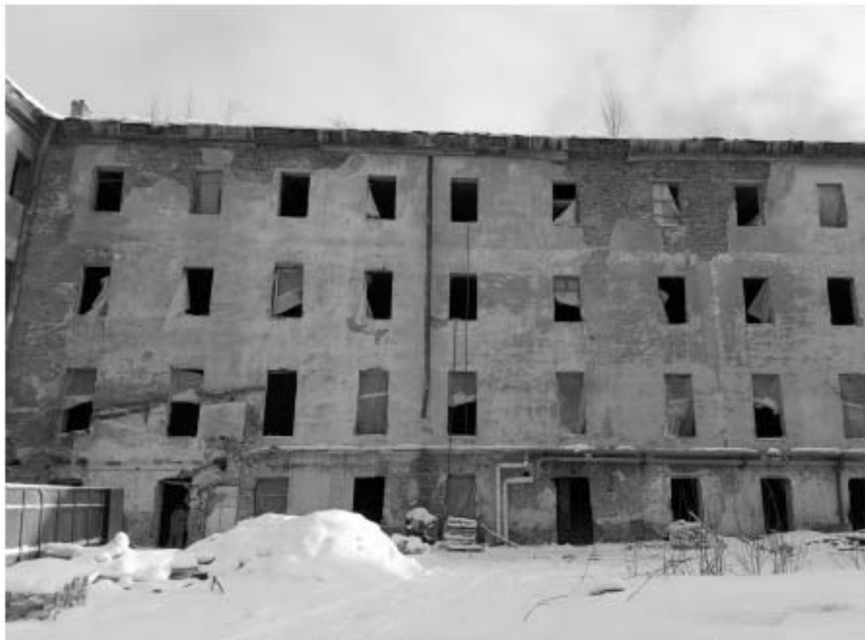
Фото 3. Лицевой фасад (обращен во двор комплекса).
