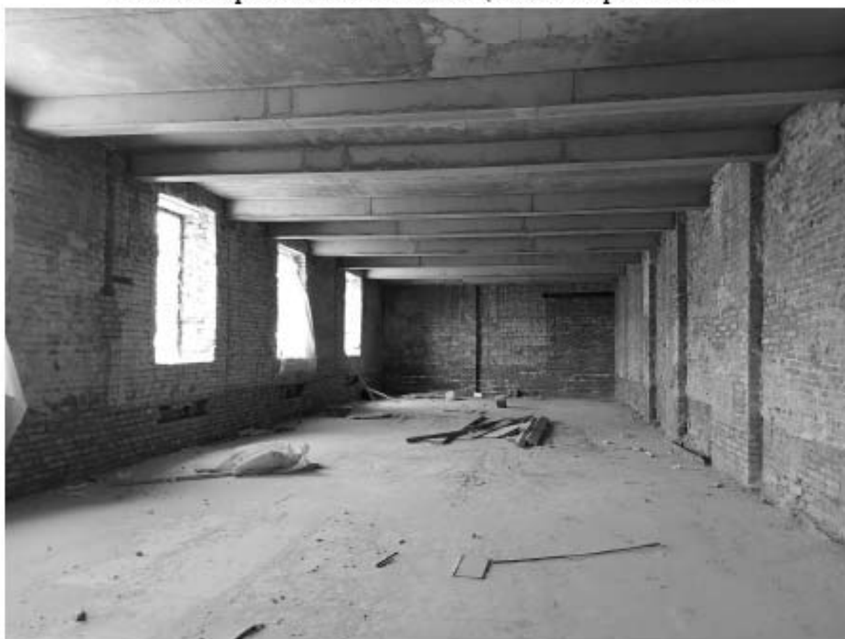
Фото 28. Общий вид северного помещения четвертого этажа, позднее перекрытие.
