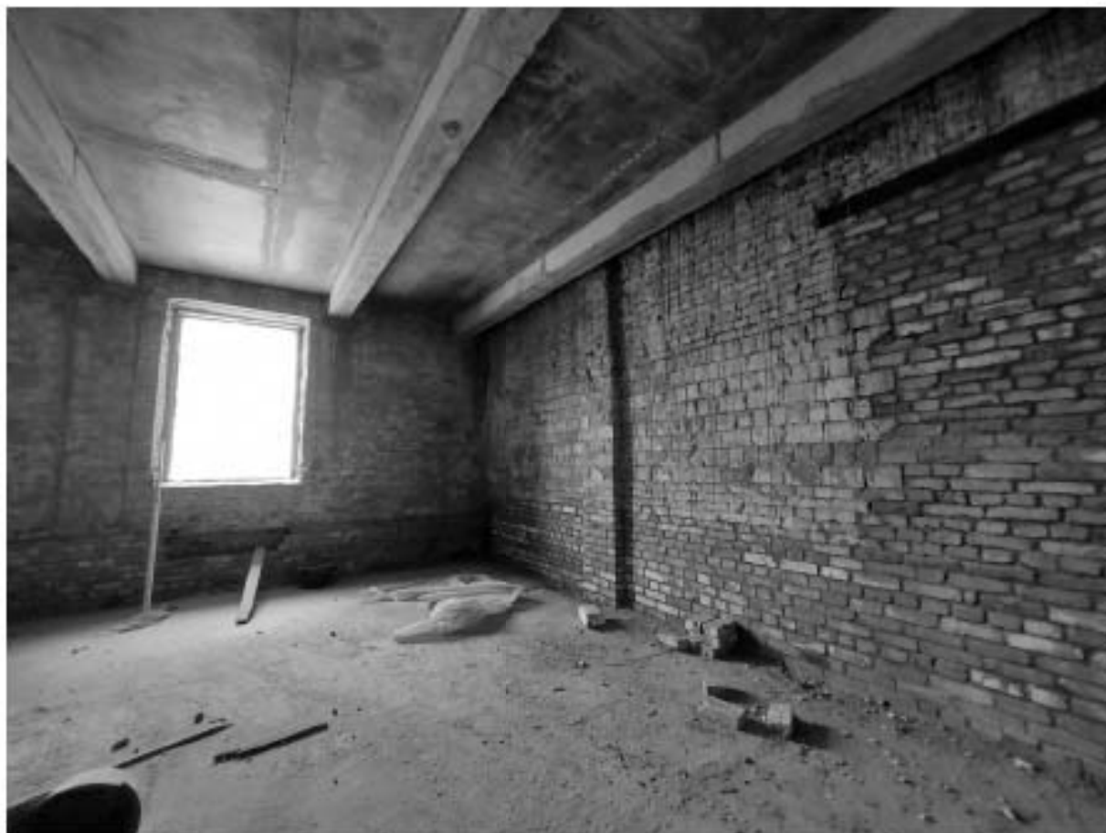
Фото 29. Фрагмент северной стены северного помещения четверного этажа.
