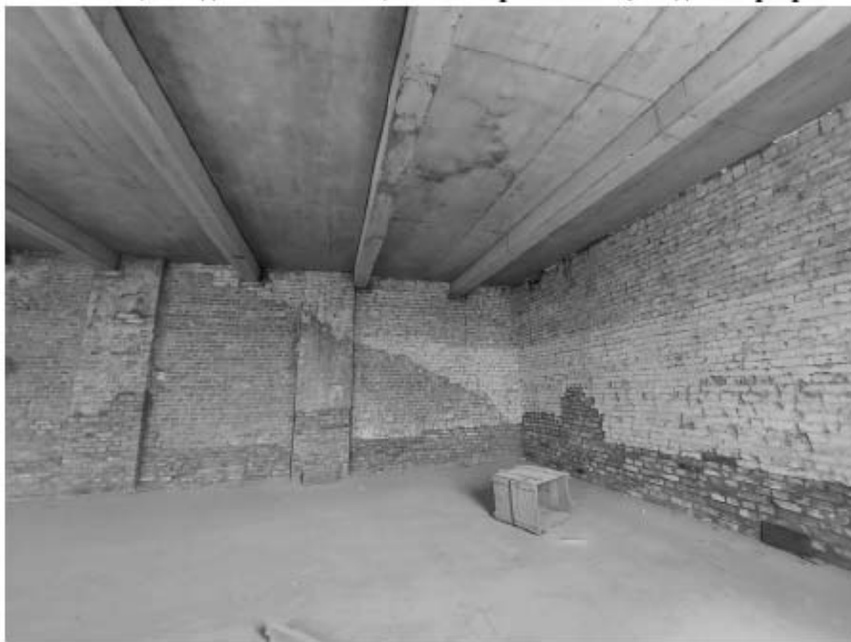
Фото 26. Фрагменты разновременной (поздней) кладки стен четвертого этажа.
