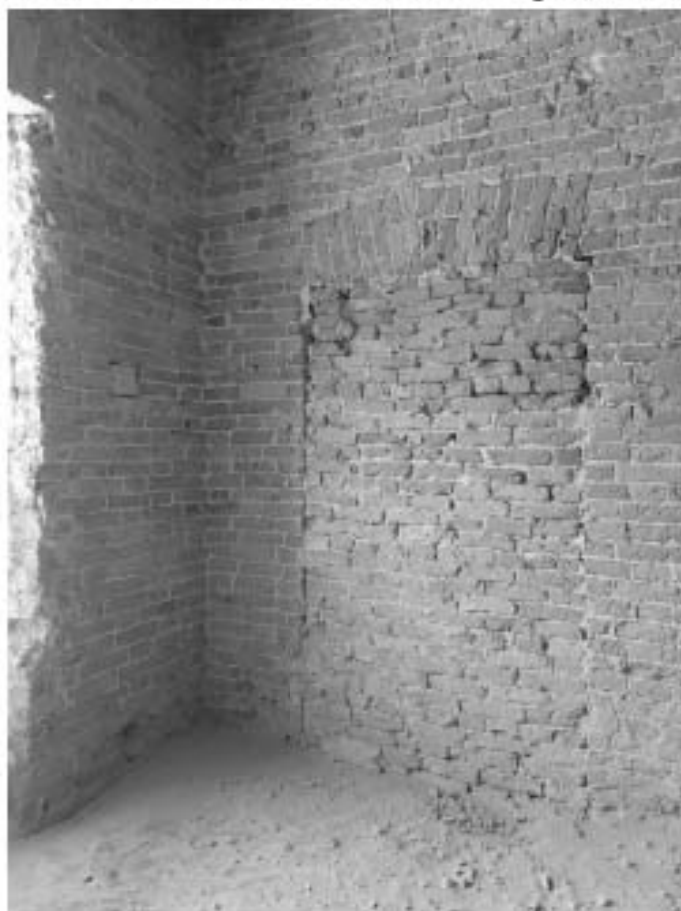
Фото 20. Заложенный в позднее время проем в северной стене южного помещения третьего этажа.
