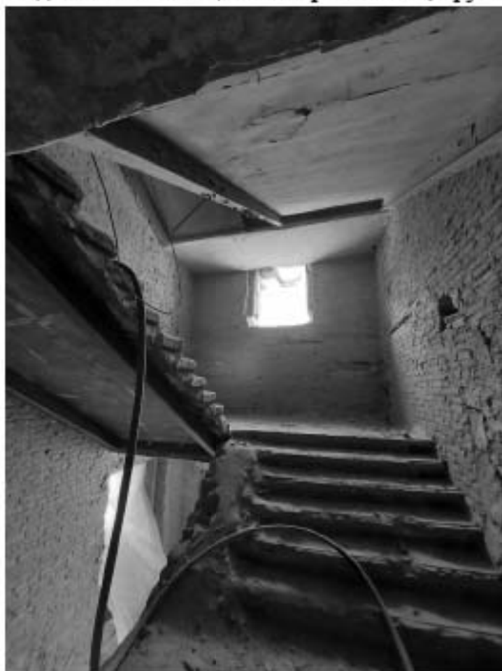
Фото 16. Лестница на третий этаж, междуэтажная площадка с оконным проемом.
