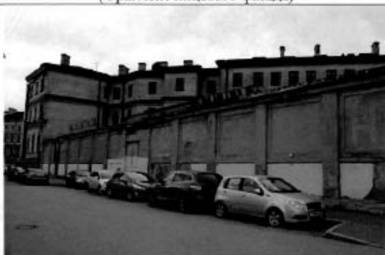
11. Объект культурного наследия регионального значения "Служебный корпус" (пр. Римского-Корсакова, дом 22, лит. Г) (Фрагмент лицевого фасада)
