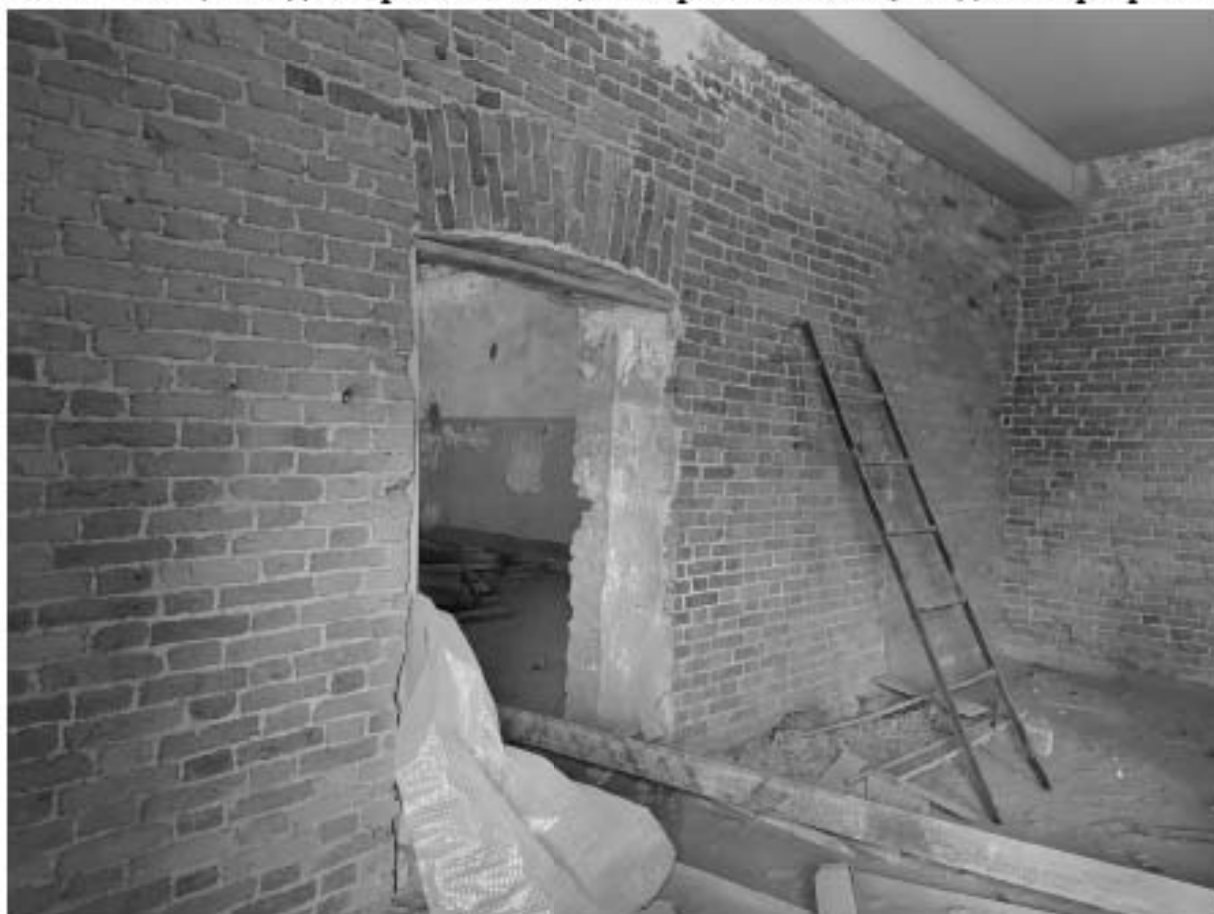
Фото 22. Проем в подлитеру В2.
