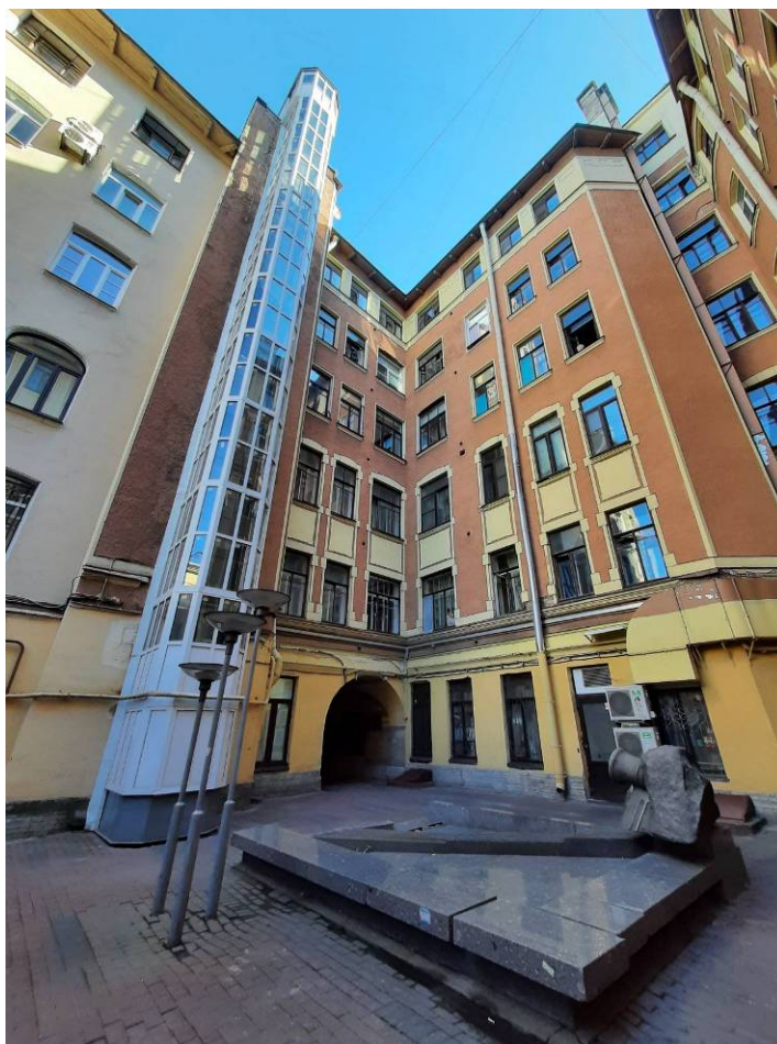
Фото 5. Фрагмент дворового фасада выявленного объекта культурного наследия «Дом С.М. Дейчмана»
