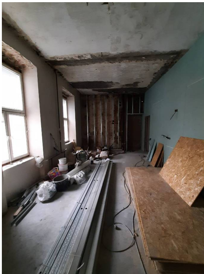
Фото 17. Интерьер квартиры № 6 выявленного объекта культурного наследия «Дом С.А.Визлер (А.Ф.Бубыря)»
