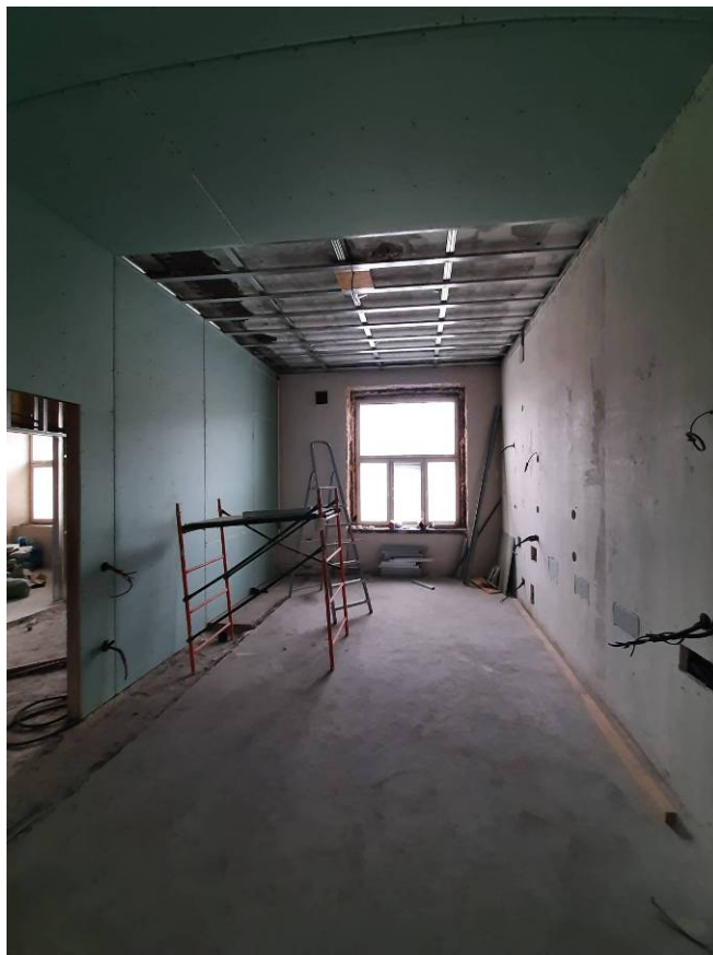
Фото 13. Интерьер квартиры № 6 выявленного объекта культурного наследия «Дом С.А.Визлер (А.Ф.Бубыря)»
