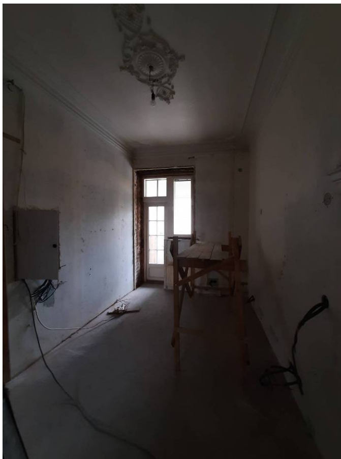
Фото 11. Интерьер квартиры № 6 выявленного объекта культурного наследия «Дом С.А.Визлер (А.Ф.Бубыря)»
