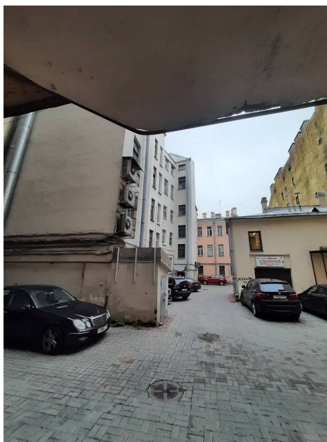
Фото 8. Фрагмент дворового фасада выявленного объекта культурного наследия «Дом С.А.Визлер (А.Ф.Бубыря)»
