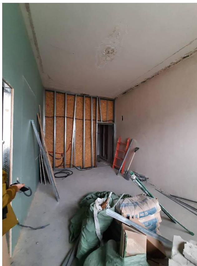
Фото 14. Интерьер квартиры № 6 выявленного объекта культурного наследия «Дом С.А.Визлер (А.Ф.Бубыря)»
