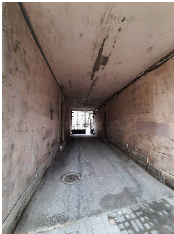
Фото 5. Фрагмент дворового фасада выявленного объекта культурного наследия «Дом С.А.Визлер (А.Ф.Бубыря)», воротные проезд на Ковенский пер.
