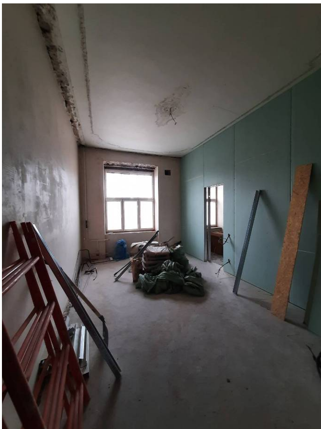
Фото 15. Интерьер квартиры № 6 выявленного объекта культурного наследия «Дом С.А.Визлер (А.Ф.Бубыря)»
