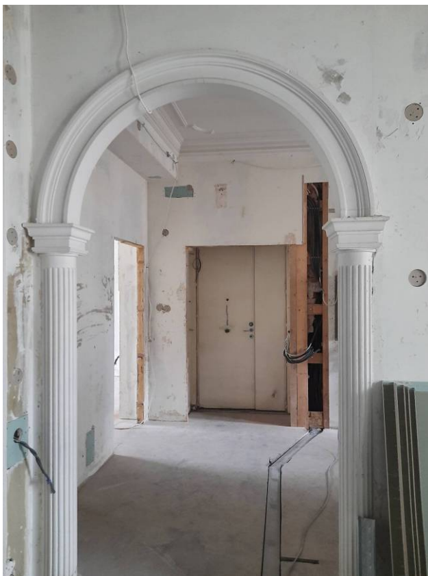
Фото 21. Интерьер квартиры № 6 выявленного объекта культурного наследия «Дом С.А.Визлер (А.Ф.Бубыря)»
