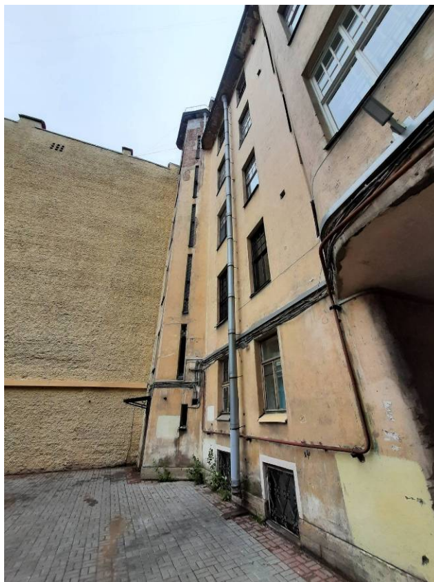
Фото 7. Фрагмент дворового фасада выявленного объекта культурного наследия «Дом С.А.Визлер (А.Ф.Бубыря)»
