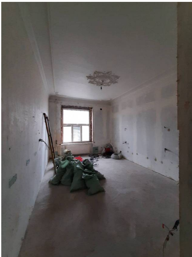
Фото 9. Интерьер квартиры № 6 выявленного объекта культурного наследия «Дом С.А.Визлер (А.Ф.Бубыря)»
