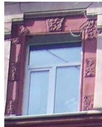
венчающий профилированный раскрепованный карниз;
