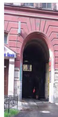
местоположение (по 6, 9, 18, 21-й осям), габариты, конфигурация дверных проемов (с щипцовым завершением на профилированных штукатурных кронштейнах, с угловыми лопатками, остекленной фрамугой лучковой конфигурации, с замковым камнем в виде клинчатого руста);
