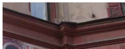
подоконный профилированный карниз, раскрепованный карниз, под оконными проемами 5-го этажа;
