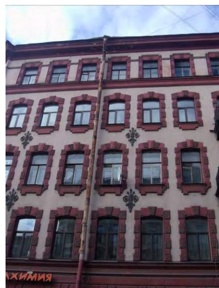
профилированные наличники, рустованное обрамление, замковые камни в виде веерного руста оконных проемов 1-го этажа;
