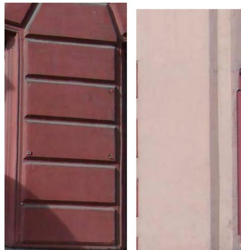
подоконный профилированный карниз, раскрепованный карниз, под оконными проемами 2-го этажа;
