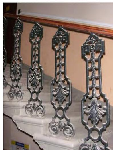
парадная лестница по 21-й оси лицевого фасада - тип сводов (коробовые), местоположение, габариты, тип и конфигурация лестницы (маршевая с поворотом), материал ступеней (лещадная плита); ограждение – габариты, материал (металл), техника исполнения (литье), рисунок (вертикальные стойки со сквозным ажурным рисунком в виде мотива меандра, завитков и пальметт).
