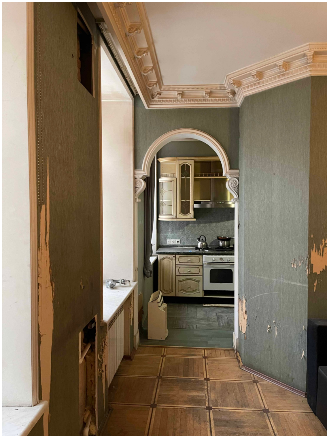
10. “Дом Р.А. Гедике”. 8-я линия В.О., дои 23, лит. А. Фрагмент интерьера 2-Н кв. № 6. Фото: 01.07.2022 г.
