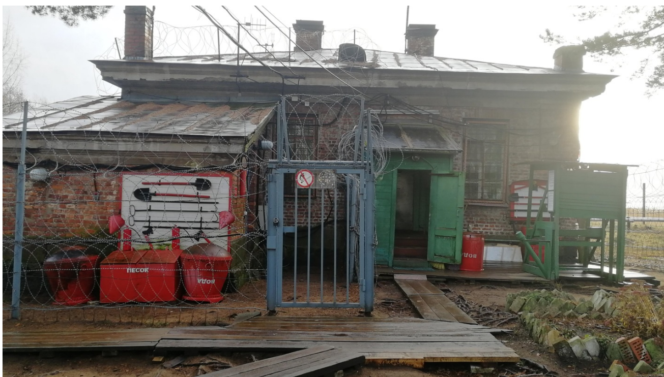
Фото 13. Караульная. Западный фасад.
