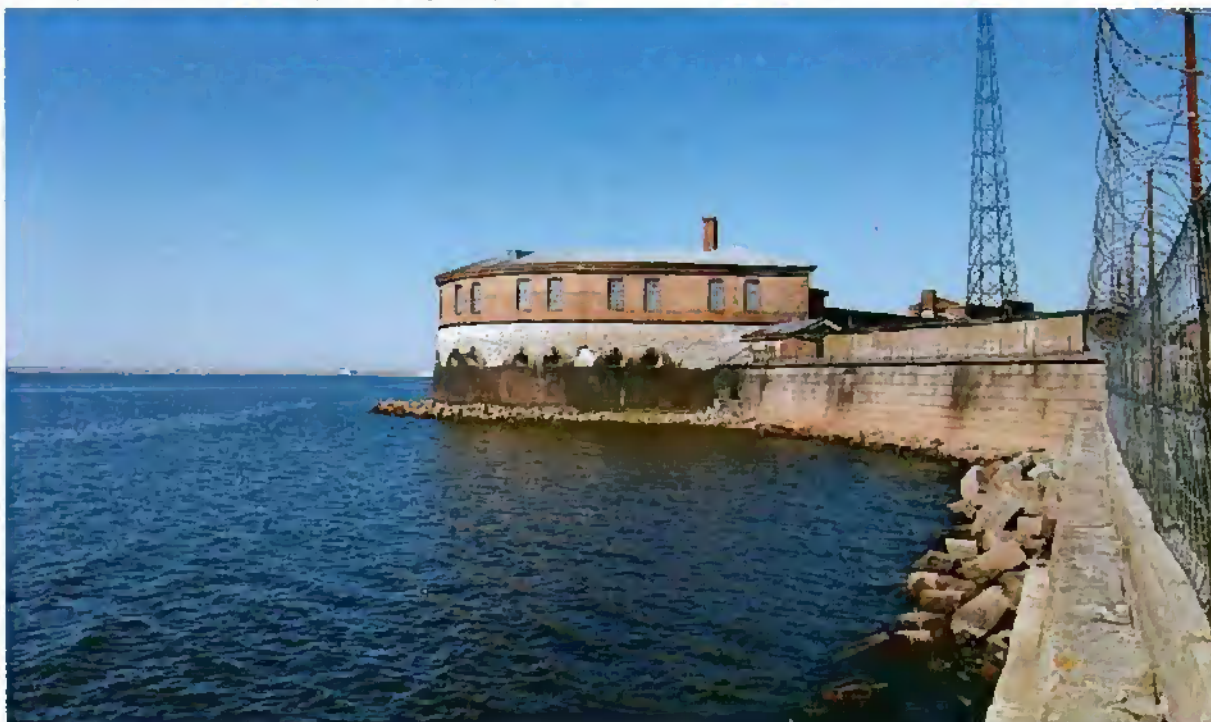
1. Фронтальная башня (южный фасад).
