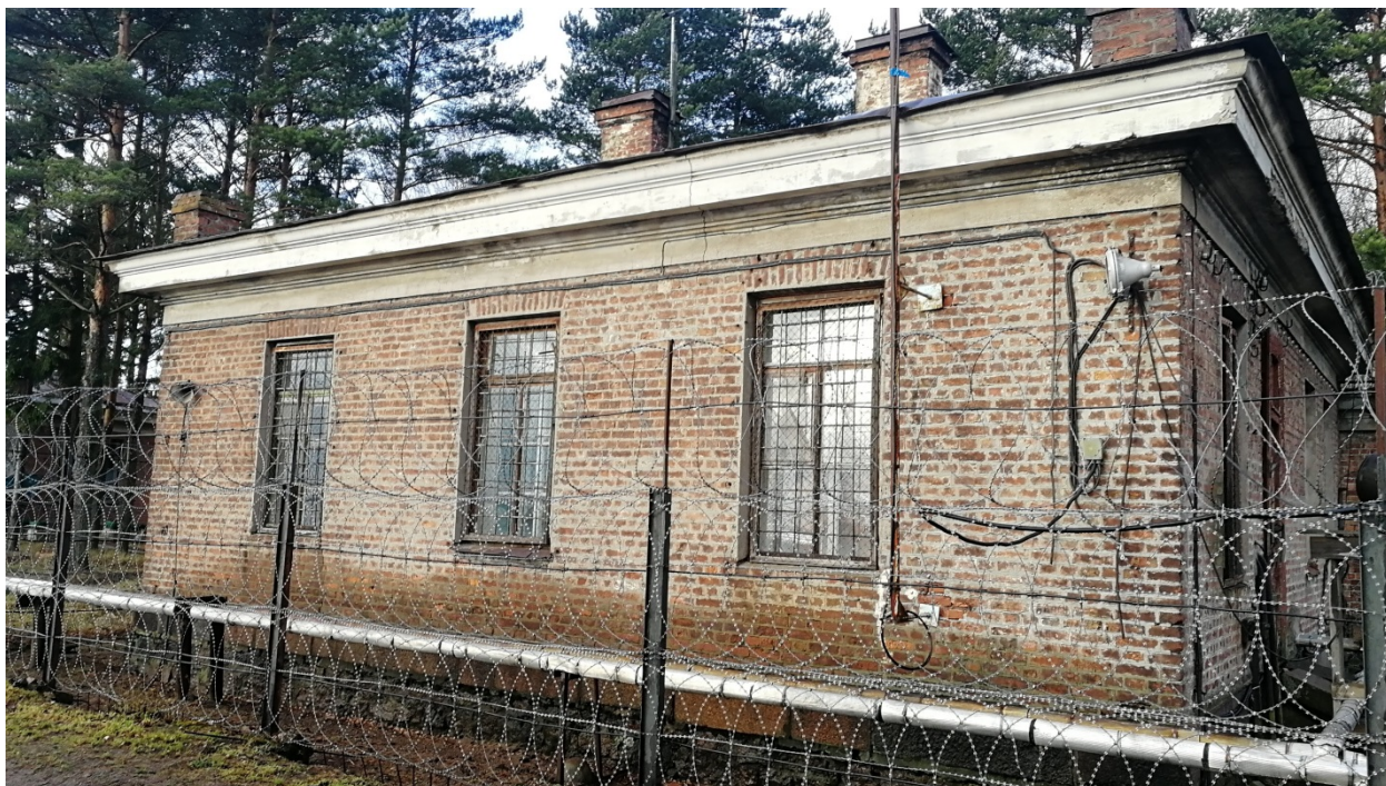
Фото 11. Караульная. Восточный фасад.
