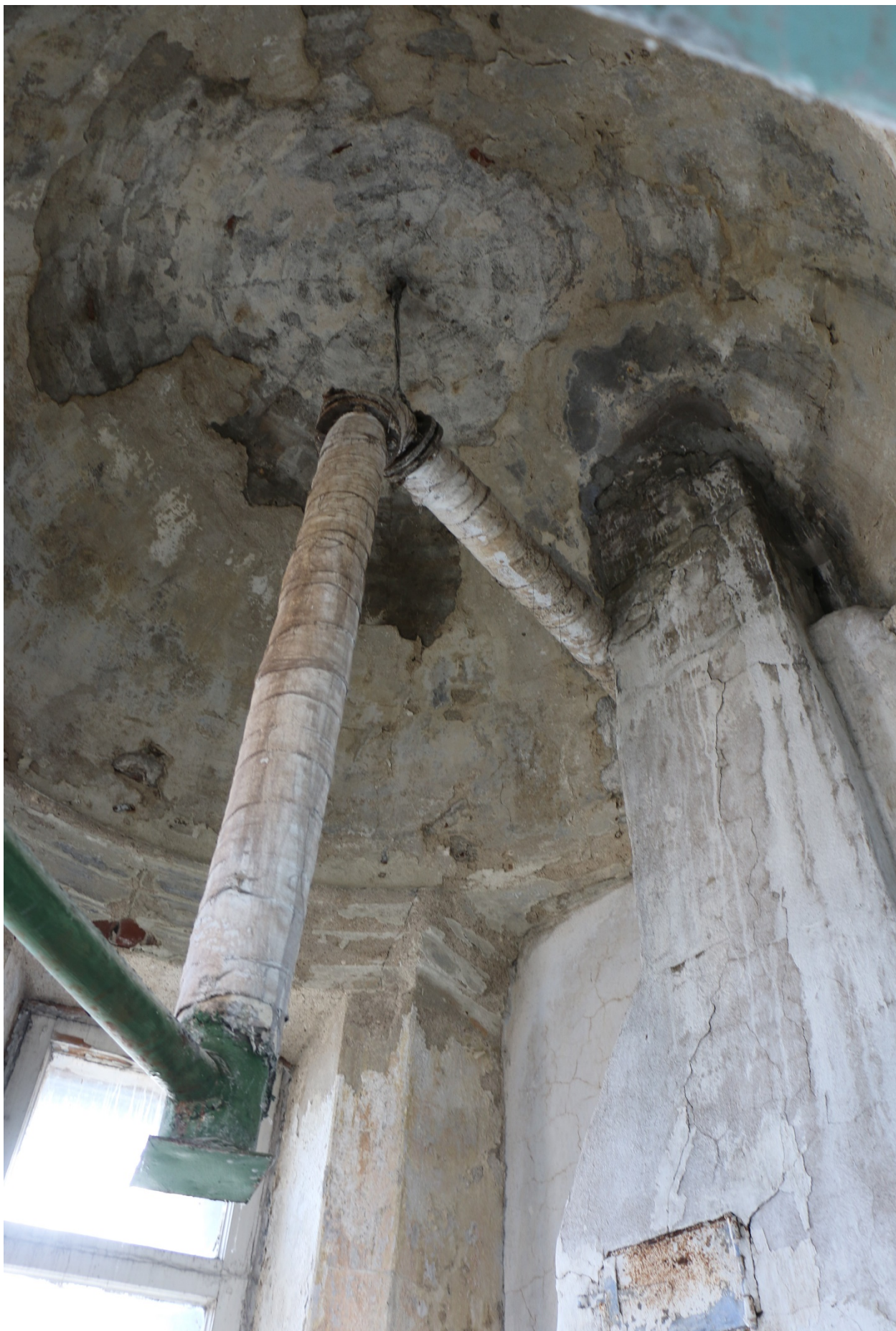
Фото 27. Купольный свод круглой башни.
