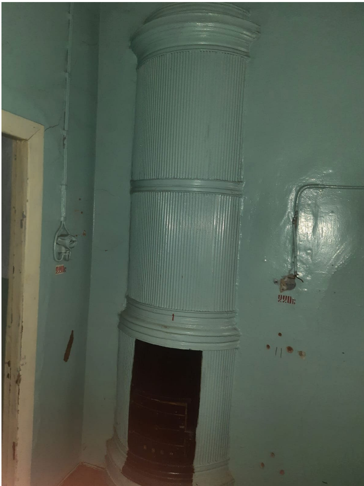
Фото 38. Вид на печь.
