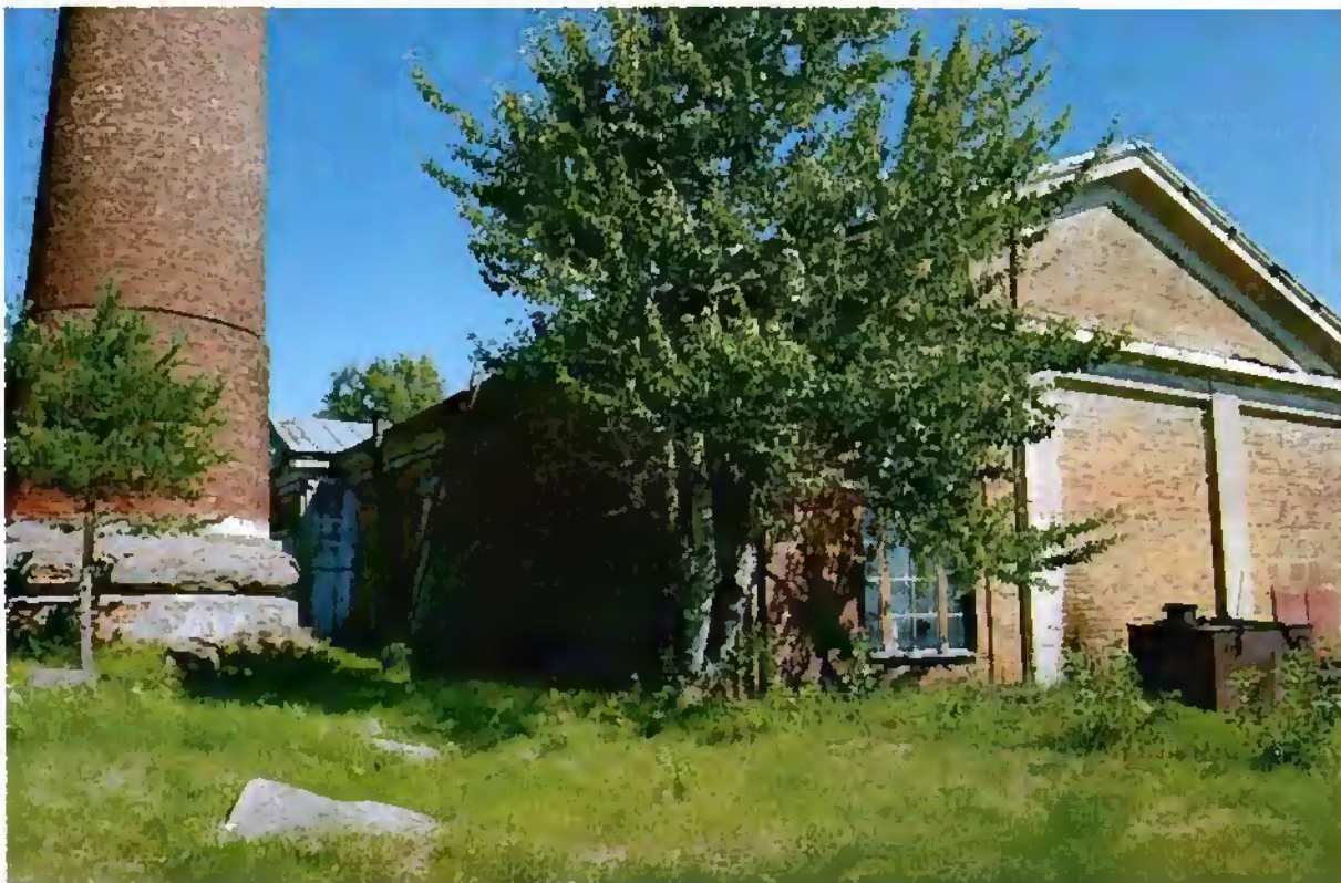
11. Котельная (западный и южный фасады).
