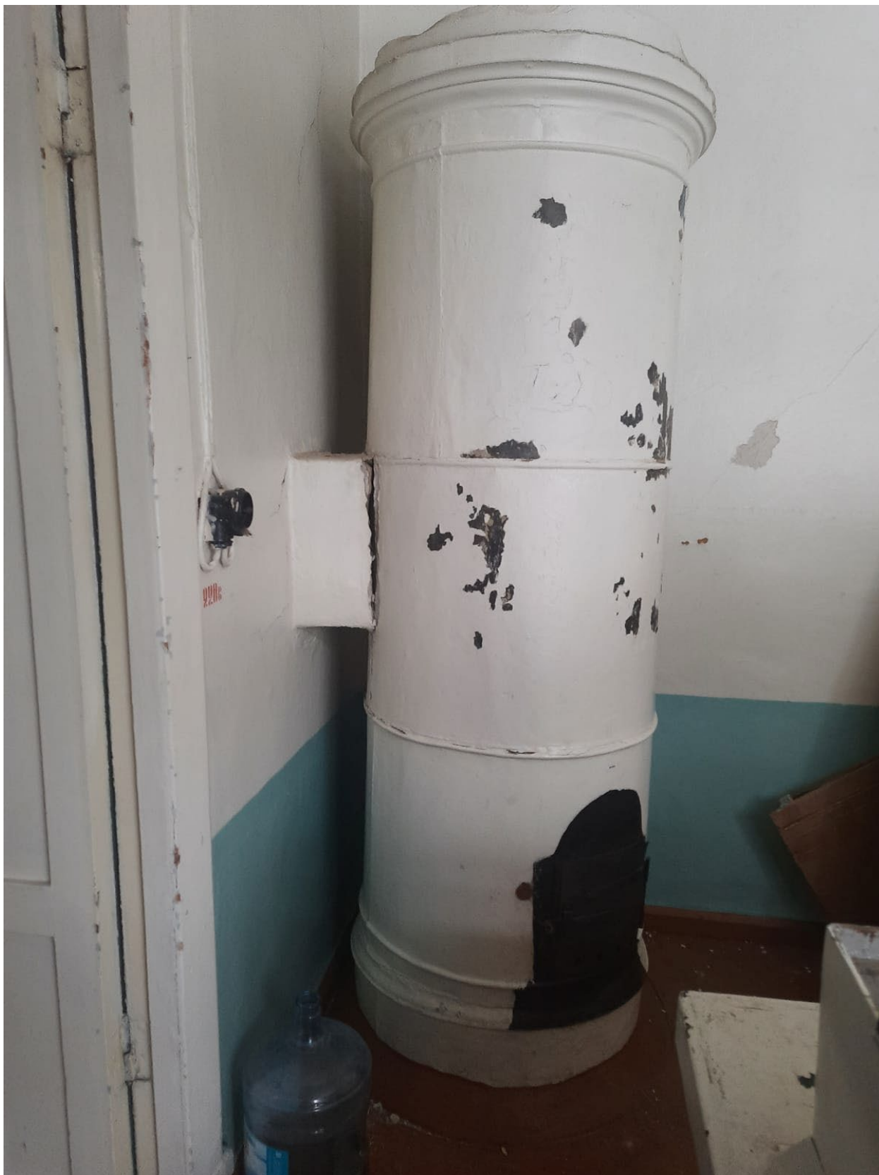
Фото 36. Вид на печь.
