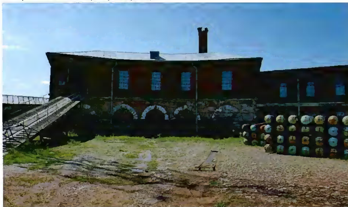
2. Фронтальная башня (северный фасад).
