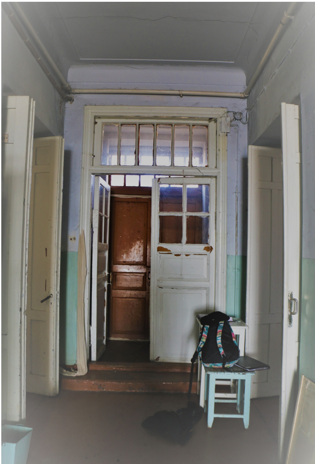
Фото 30. Входная дверь. Вид изнутри.
