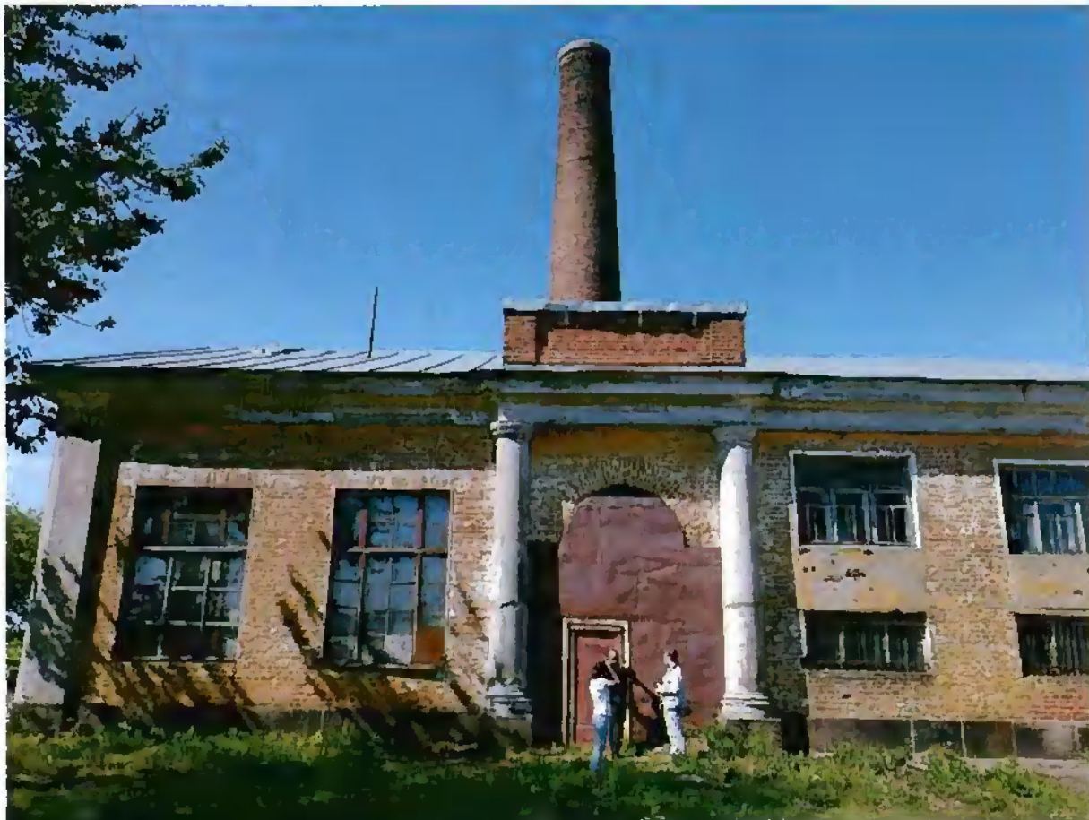
10. Котельная (восточный фасад).
