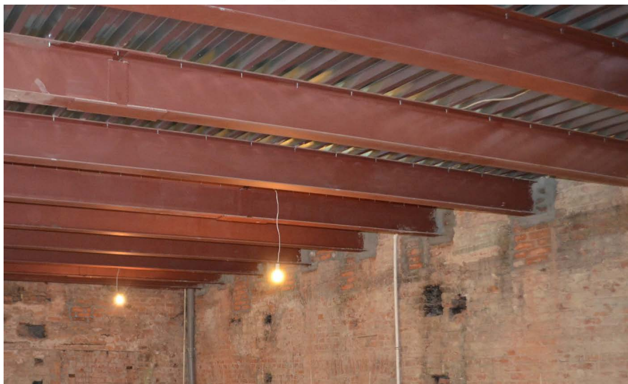
10. Помещение 2-Н. Выявленный объект культурного наследия «Дом С. Крамера (Г.А. Лепена)», по адресу: Санкт-Петербург, Большая Морская ул., 50; Мойки р. наб., 95. Дата съемки: 20.04.2022г.
