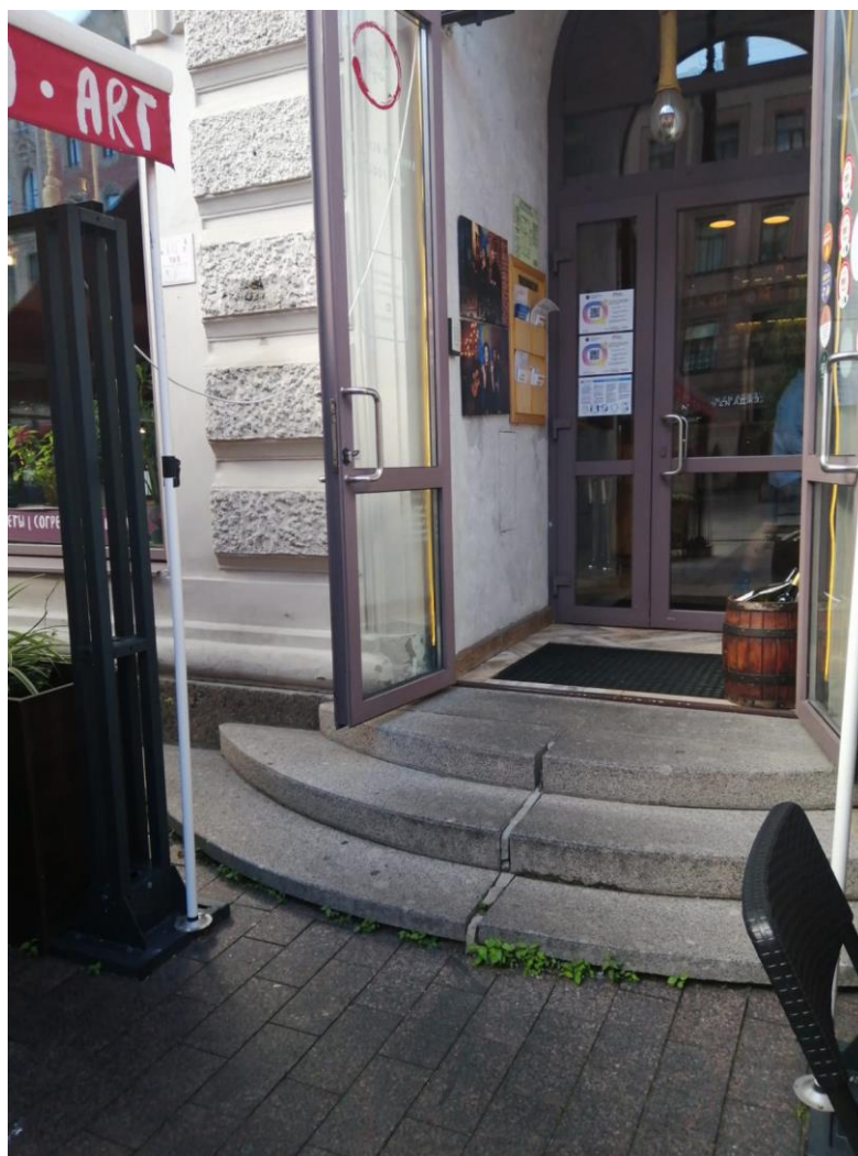
4. Выявленный объект культурного наследия «Дома немецкой лютеранской церкви св. Петра» (Невский пр., 22-24). Дом № 7 по Малой Конюшенной улице. Главный фасад. Вход (главный вход) в помещение 34-Н. Крыльцо (позднее).
