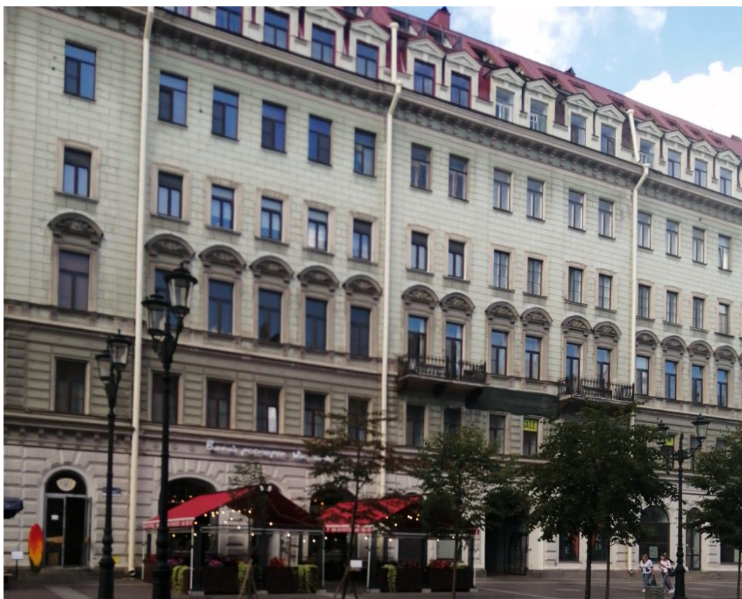
1. Выявленный объект культурного наследия «Дома немецкой лютеранской церкви св. Петра» (Невский пр., 22-24). Дом № 7 по Малой Конюшенной улице. Вид вдоль Малой Конюшенной улицы.
