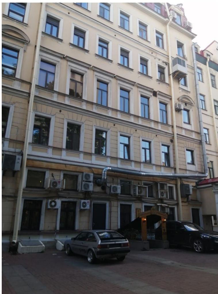
5. Выявленный объект культурного наследия «Дома немецкой лютеранской церкви св. Петра» (Невский пр., 22-24). Дом № 7 по Малой Конюшенной улице. Дворовый фасад. Фрагмент.
