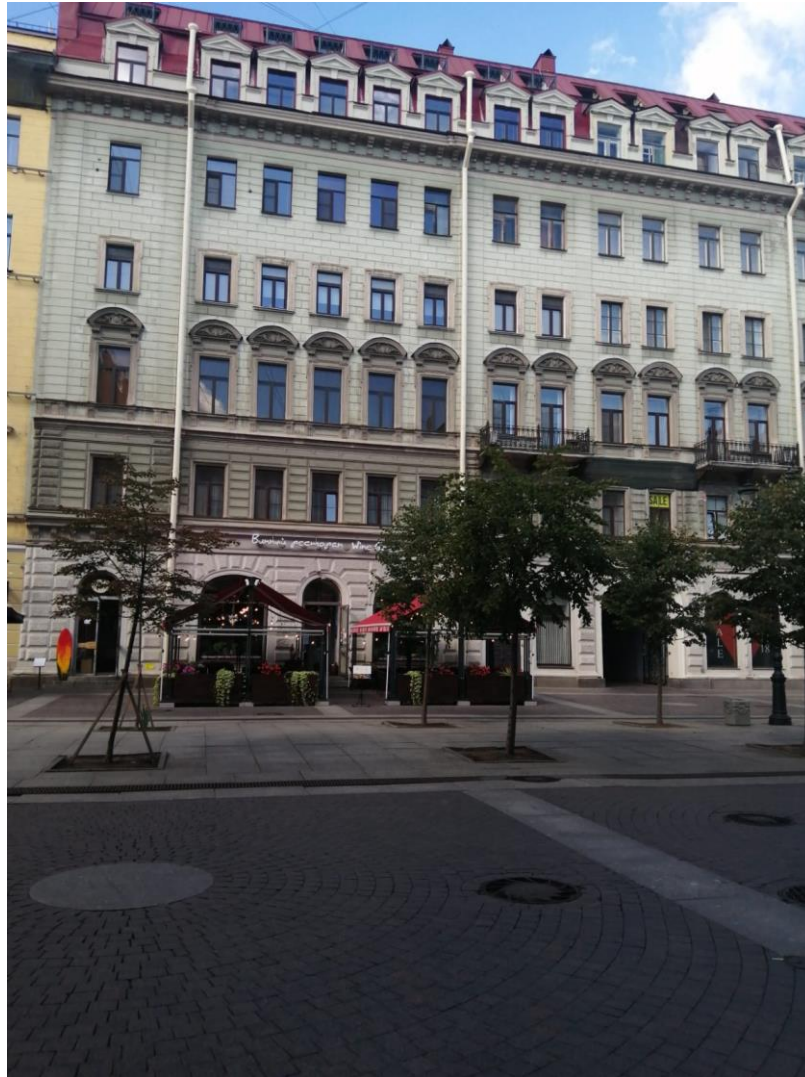
2. Выявленный объект культурного наследия «Дома немецкой лютеранской церкви св. Петра» (Невский пр., 22-24). Дом № 7 по Малой Конюшенной улице. Главный фасад. Общий вид.
