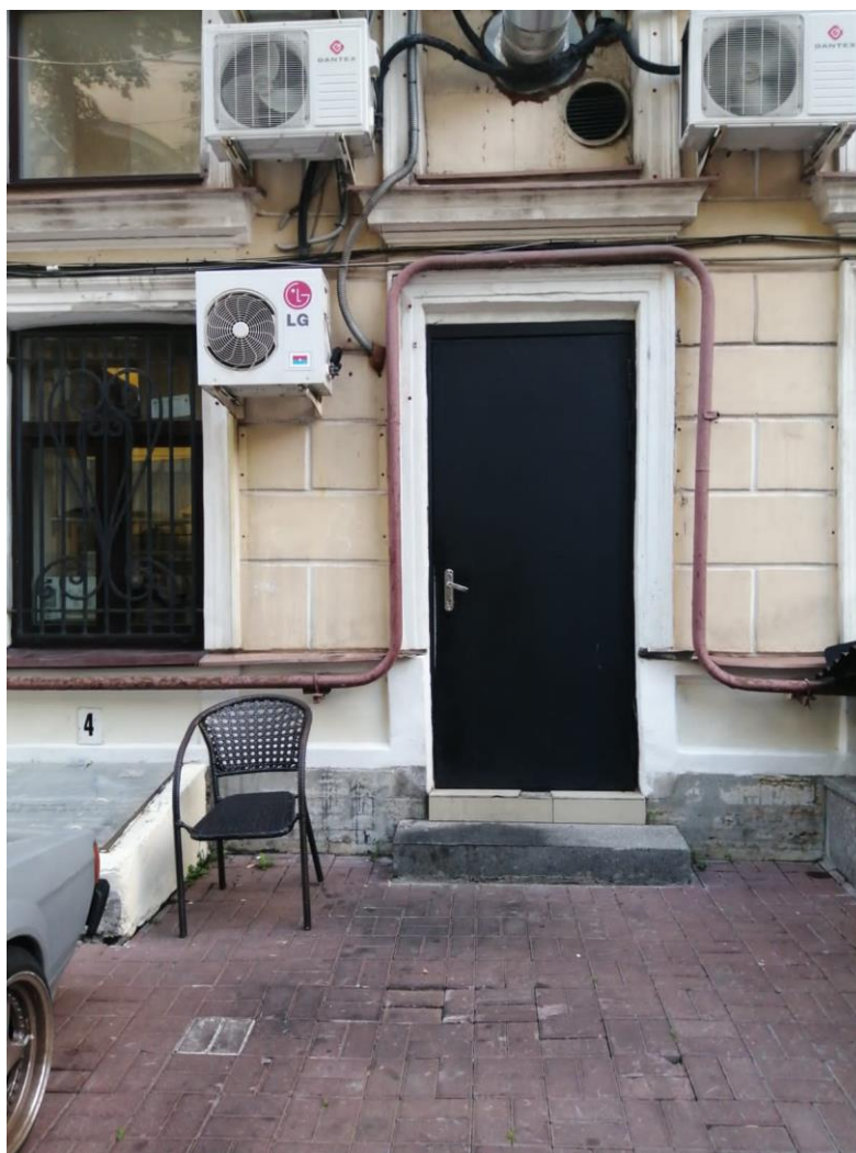
7. Выявленный объект культурного наследия «Дома немецкой лютеранской церкви св. Петра» (Невский пр., 22-24). Дом № 7 по Малой Конюшенной улице. Дворовый фасад. Вход в помещение 34-Н. Дверное заполнение (позднее).
