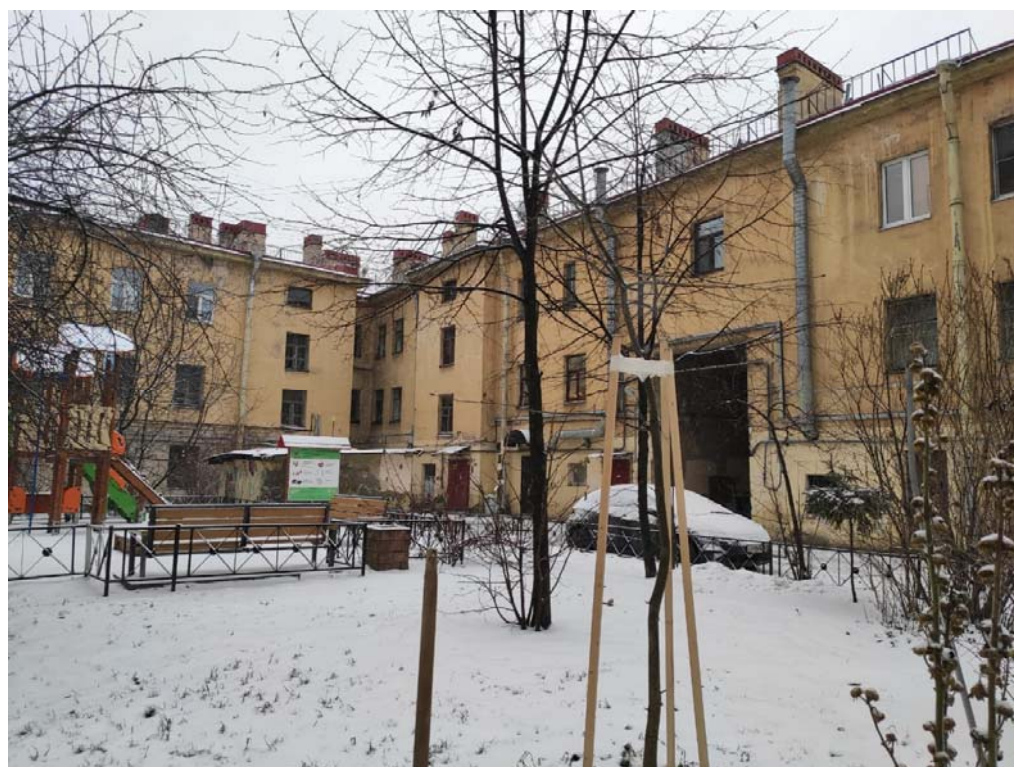
Фото №7. Внутривдворовая территория. Фрагмент дворовых фасадов здания
