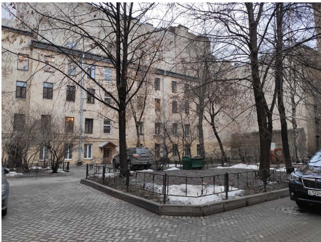
Фото №5. Дворовые фасады, фрагмент внутривортовой территории
