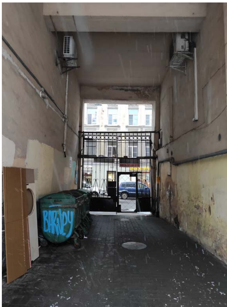
Фото №10. Сквозной арочный проем. Металлическое заполнение.
