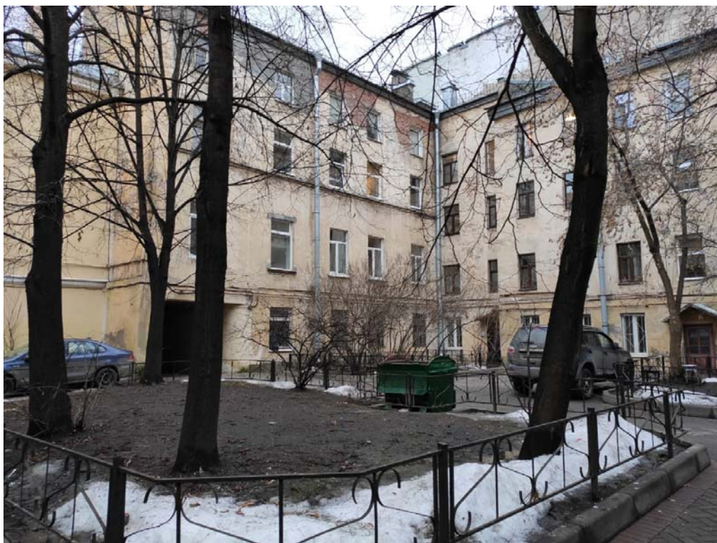
Фото №3. Дворовые фасады, фрагмент внутривортовой территории
