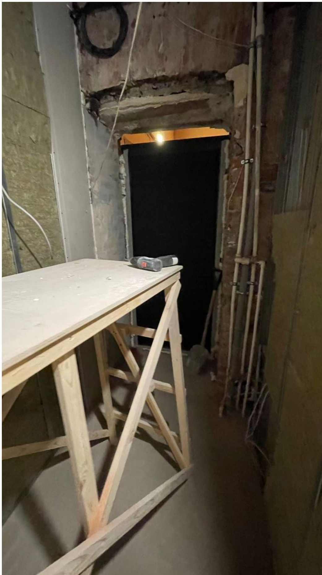
14. Вид на входную дверь в квартире (выход на чёрную лестницу);
