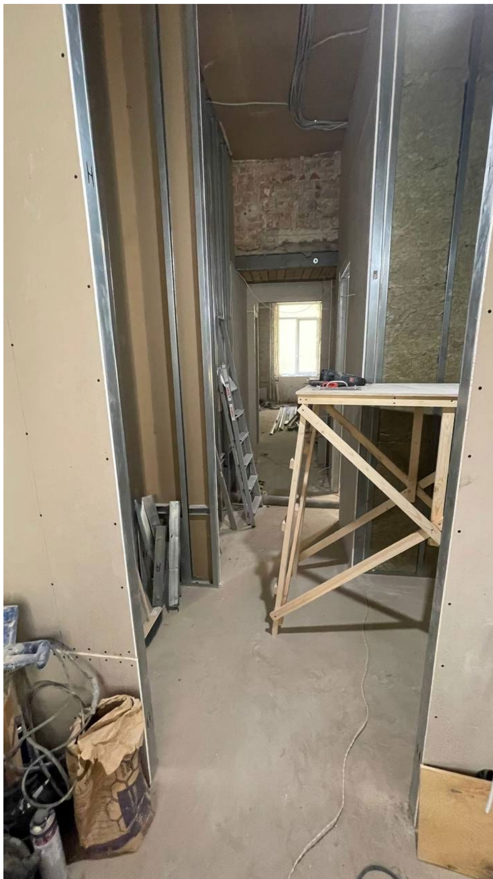
13. Фрагмент интеръера коридора (помещение №1);
