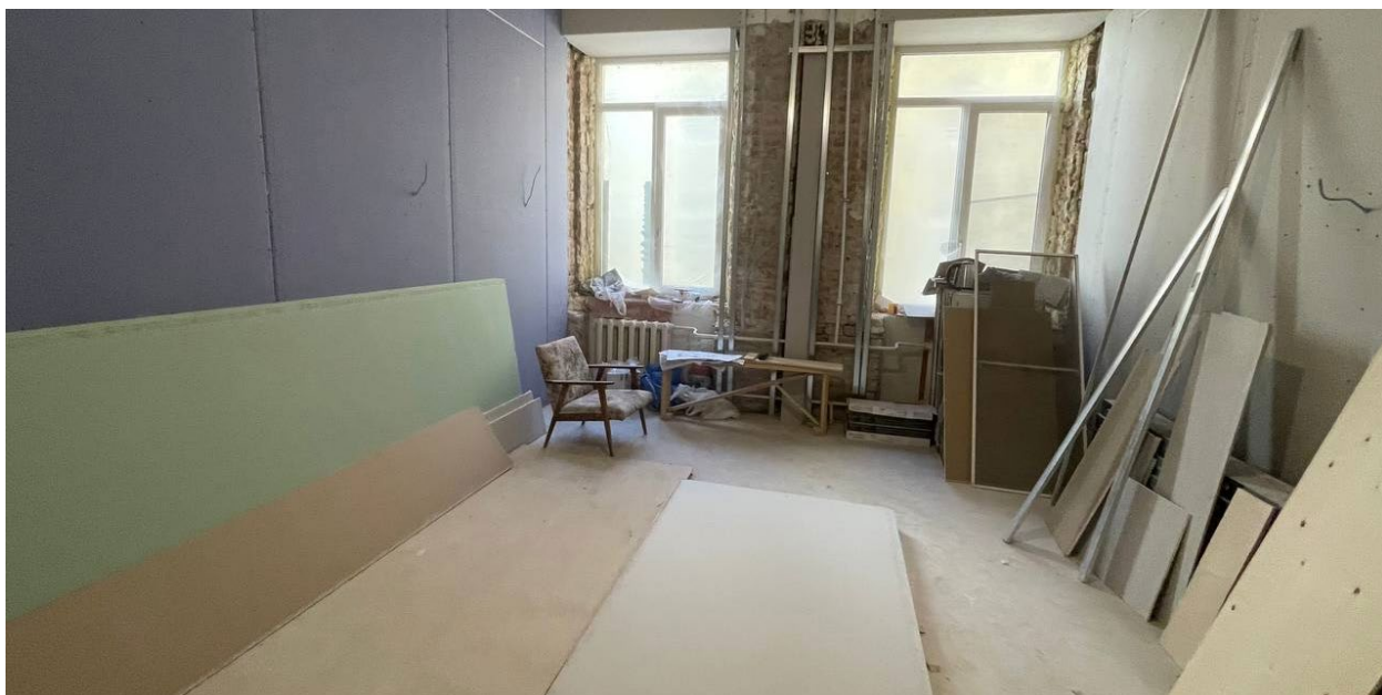
23.Фрагмент интерьера комнаты (помещение №9);
