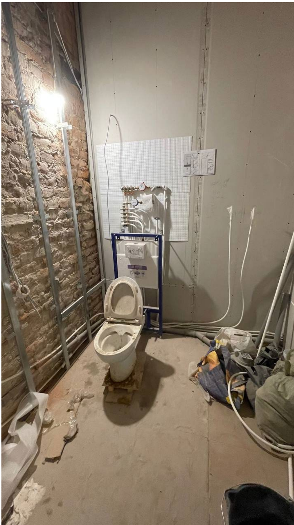
7. Фрагмент интерьера санузла (помещение №12);
