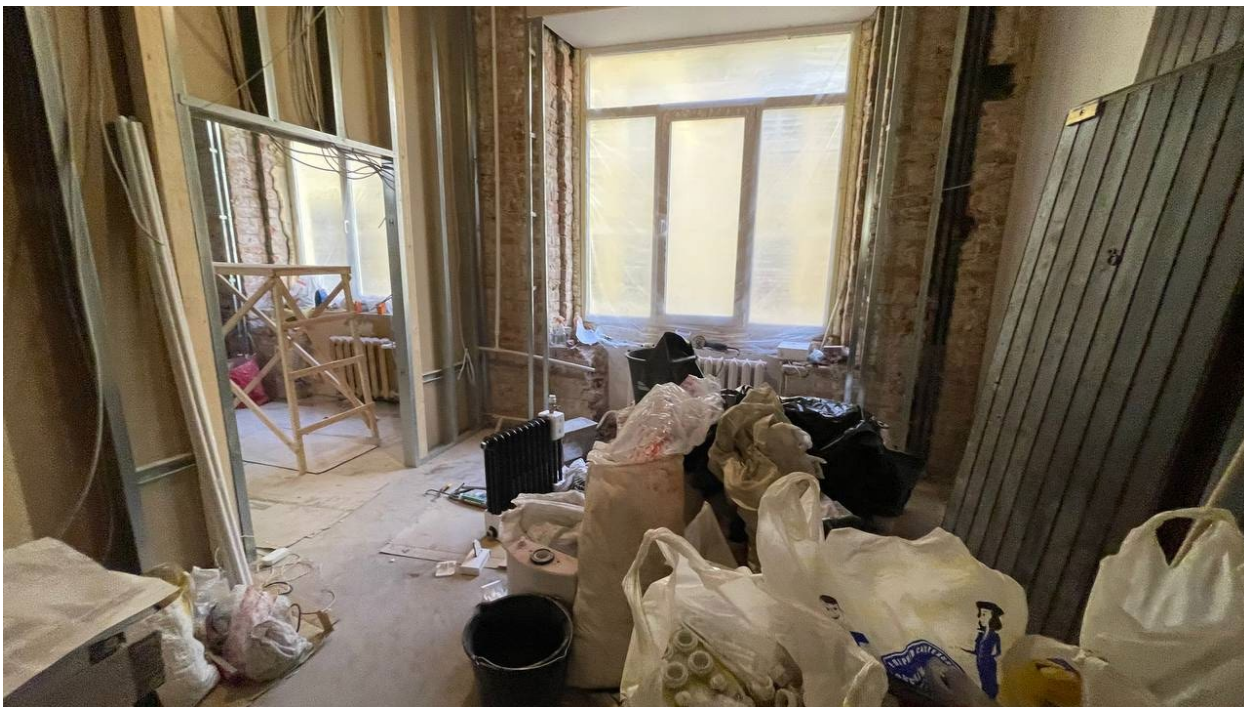
8. Фрагмент интерьера комнаты (помещение №11);
