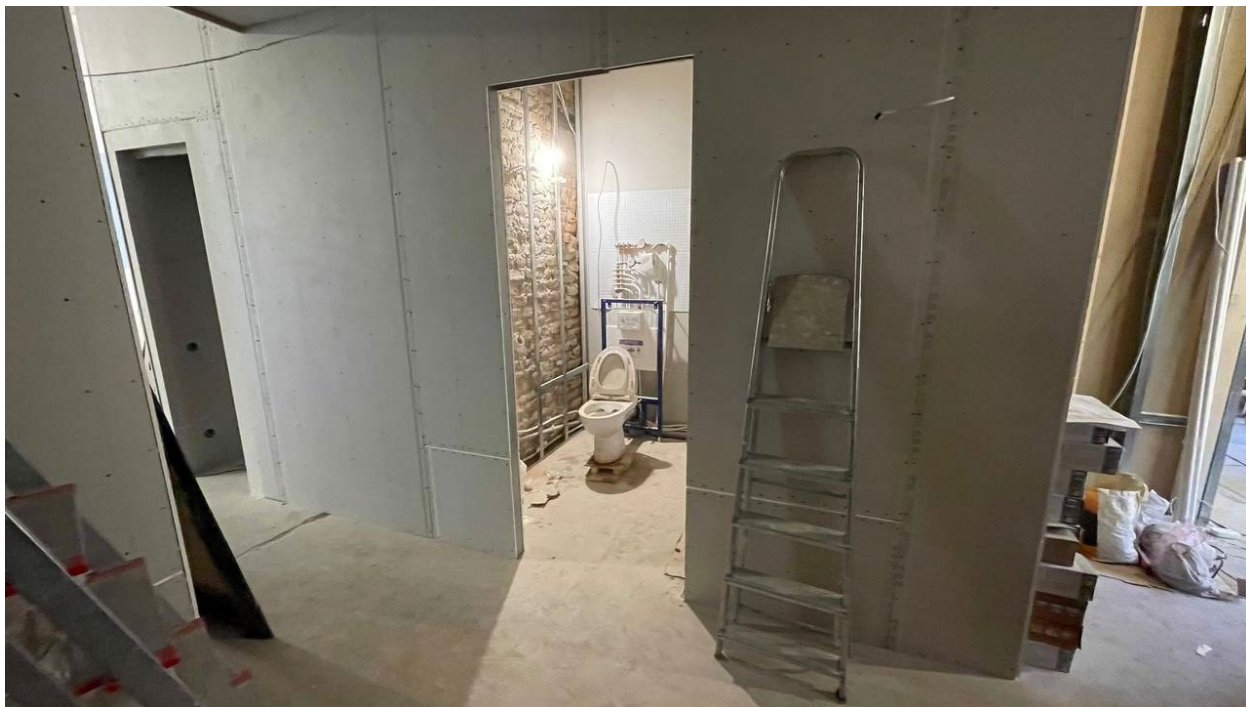
6. Фрагмент интеръера коридора и вид на санузел (помещение №10 и №12);
