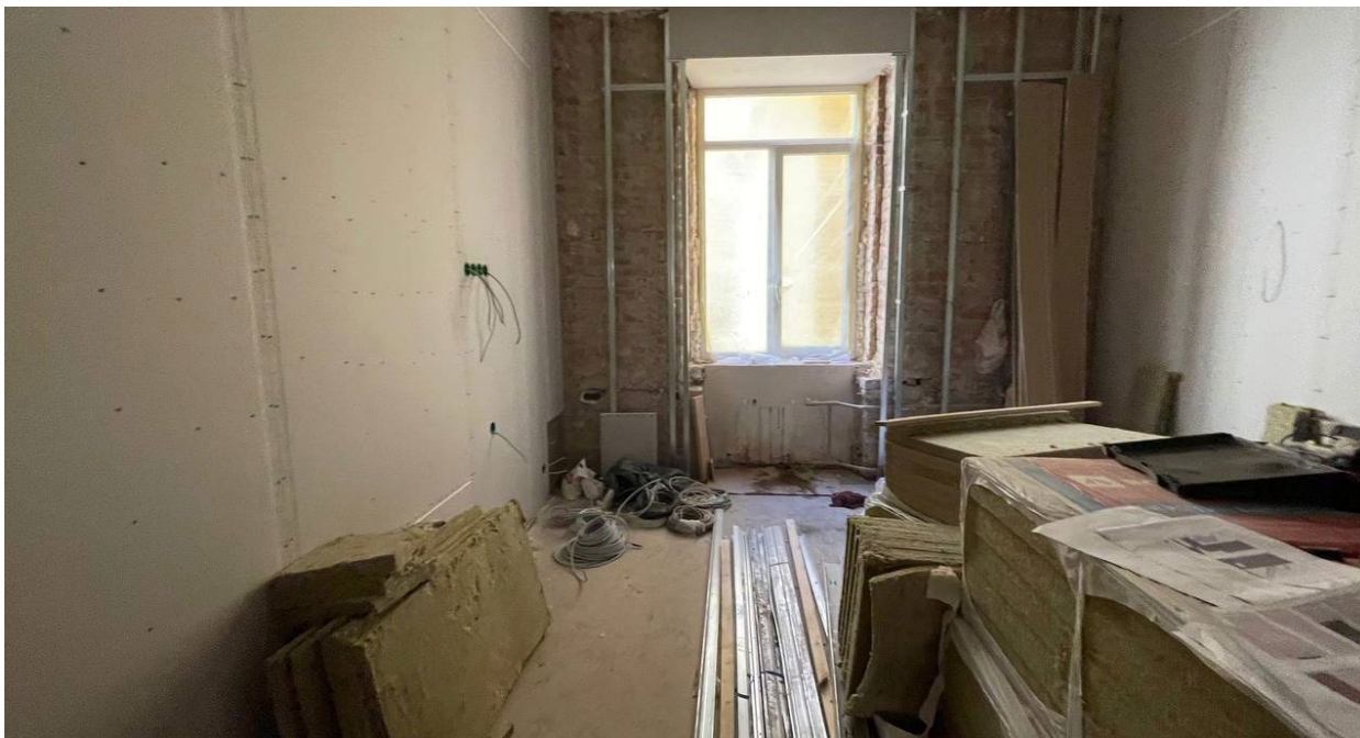
18. Фрагмент интерьера комнаты (помещение № 4);
