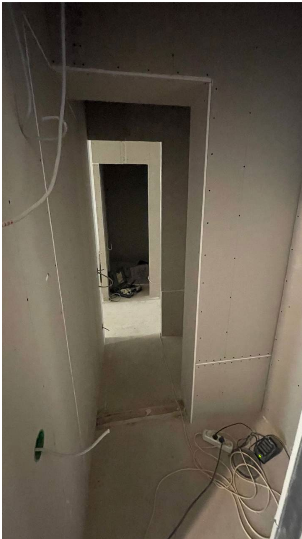
22. Фрагмент интерьера гардеробных (помещение №6 и №7);
