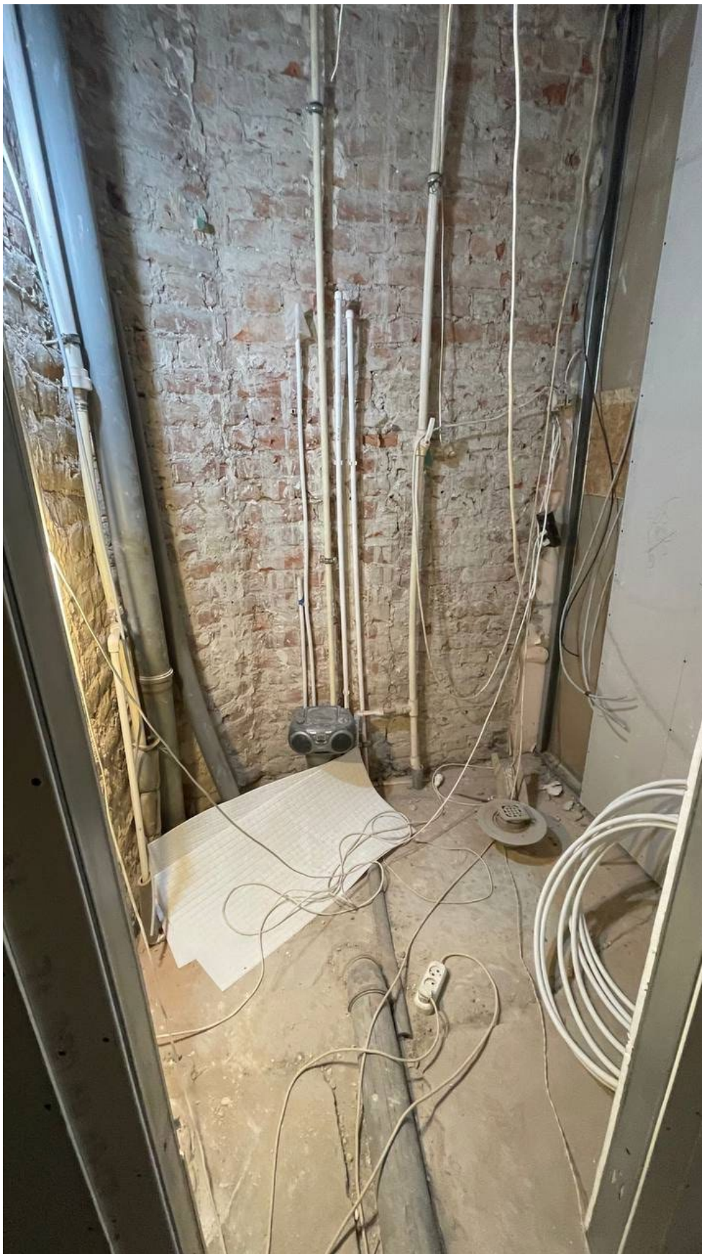
16. Фрагмент интерьера санузла (помещение №3);
