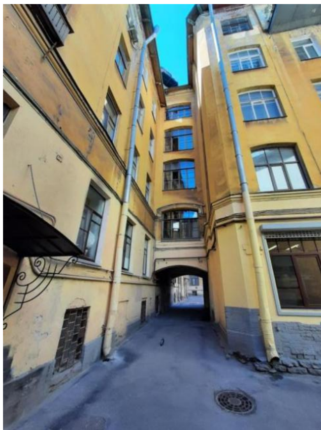
Фото 7 Фрагмент дворового фасада выявленного объекта культурного наследия «Дом Ф.Ф. Шпринга» расположенного по адресу: Санкт-Петербург, пер. Тучков, дом 11/5, литера А (Тучков пер., 11; Волховский пер., 5)
