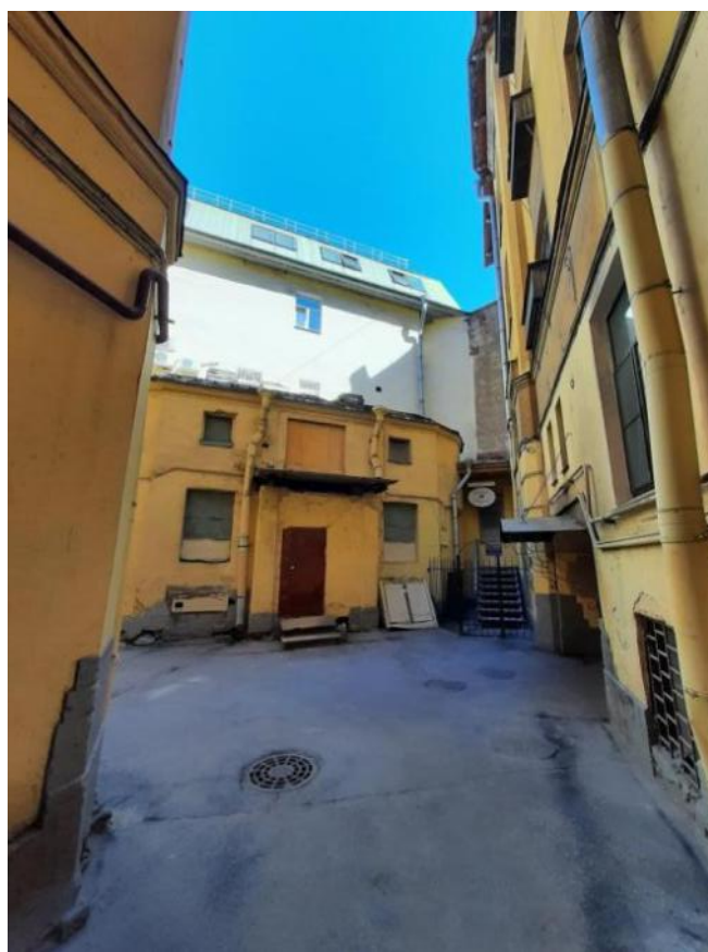
Фото 8 Фрагмент дворового фасада выявленного объекта культурного наследия «Дом Ф.Ф. Шпринга» расположенного по адресу: Санкт-Петербург, пер. Тучков, дом 11/5, литера А (Тучков пер., 11; Волховский пер., 5)
