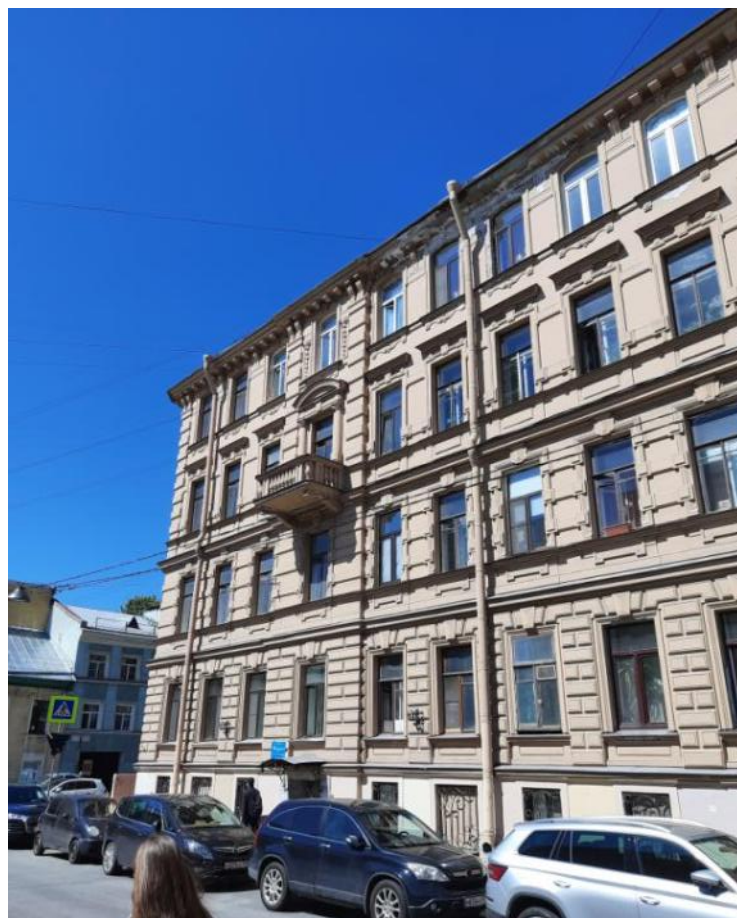
Фото 4 Фрагмент лицевого фасада выявленного объекта культурного наследия «Дом Ф.Ф. Шпринга» расположенного по адресу: Санкт-Петербург, пер. Тучков, дом 11/5, литера А (Тучков пер., 11; Волховский пер., 5)
