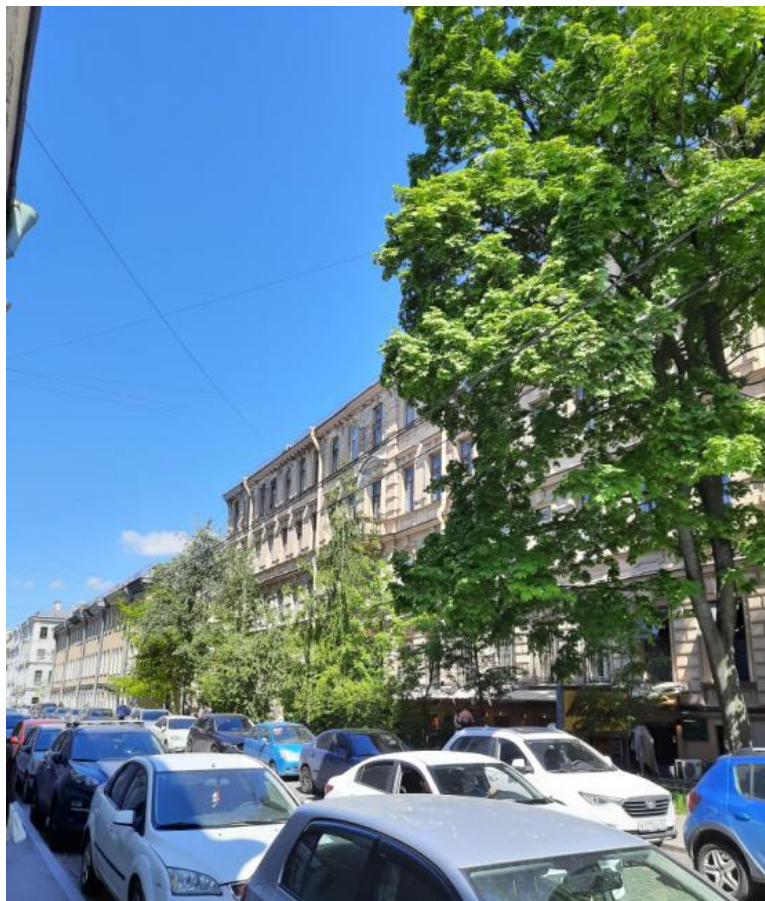
Фото 1 Фрагмент лицевого фасада выявленного объекта культурного наследия «Дом Ф.Ф. Шпринга» расположенного по адресу: Санкт-Петербург, пер. Тучков, дом 11/5, литера А (Тучков пер., 11; Волховский пер., 5)
