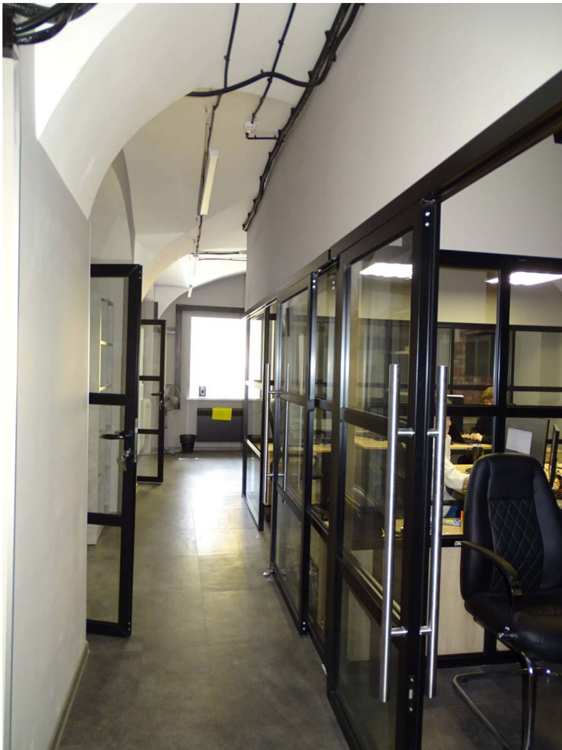
Фото 7. Помещение: 92/7,4; 93/18,8; 94/11,1; 95/13,9. Съемка 10.06.2022 г. Трушковский В.Э.
