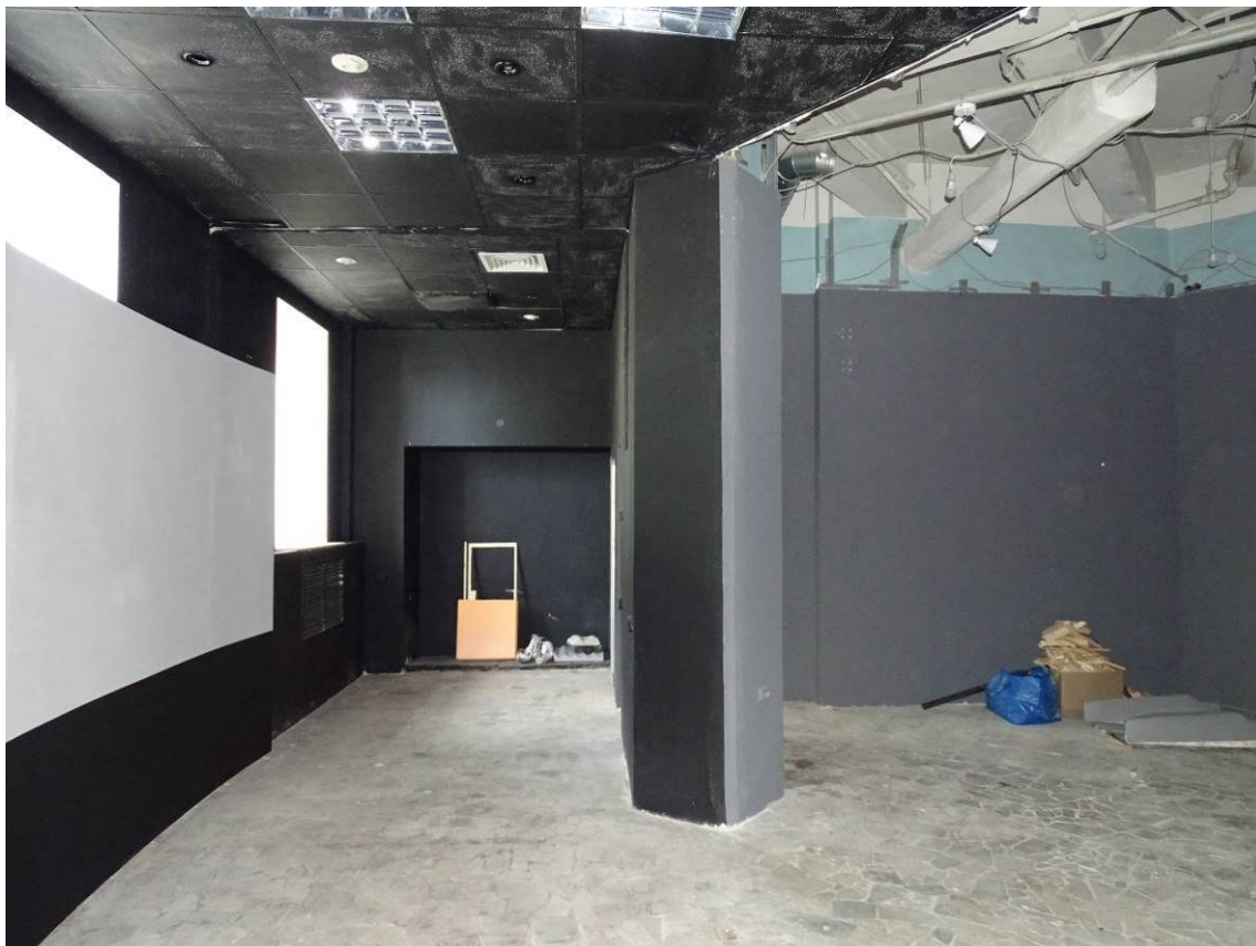
Фото 4. Помещение: 49/6,1; 50/34,0; 51/34,0. Съемка 10.06.2022 г. Трушковский В.Э.
