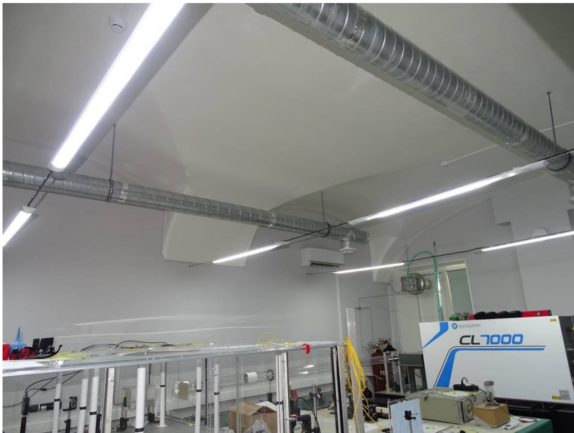
Фото 15. Помещение: 6/20,7. Съемка 10.06.2022 г. Трушковский В.Э.
