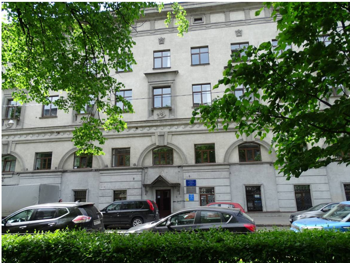
Фото 4. Выявленный объект культурного наследия «Склады торгового дома "Братья Елисеевы" (здание ГОИ им. С. И. Вавилова)». Восточный лицевой фасад. Фрагмент. Съемка 10.06.2022 г. Трушковский В.Э.
