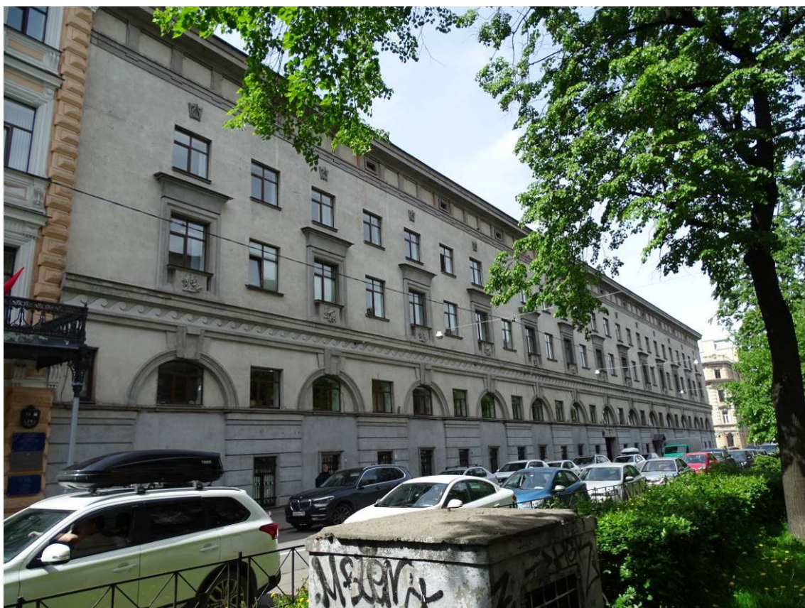
Фото 2. Выявленный объект культурного наследия «Склады торгового дома "Братья Елисеевы" (здание ГОИ им. С. И. Вавилова)». Восточный лицевой фасад. Съемка 10.06.2022 г. Трушковский В.Э.
