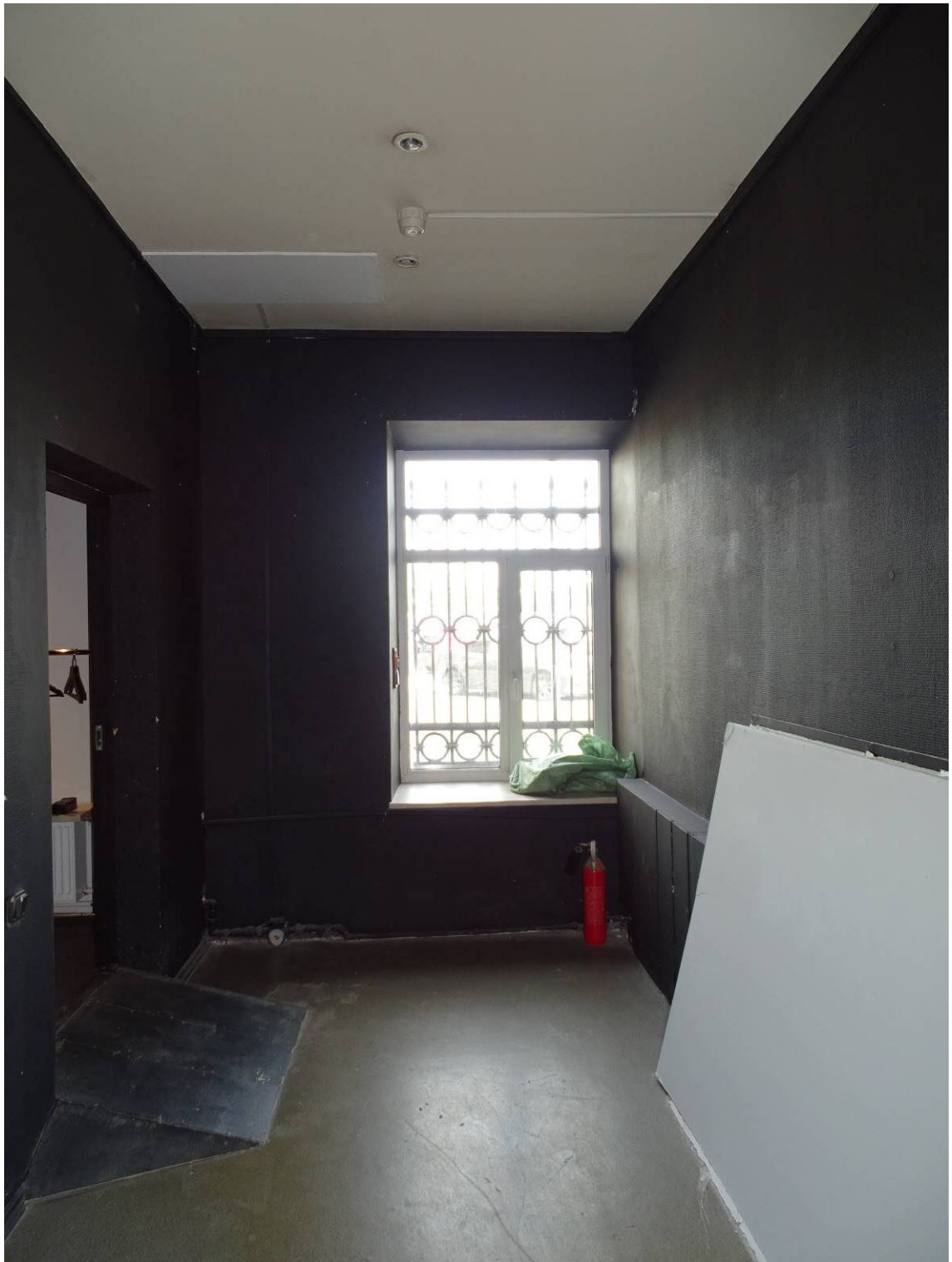
Фото 3. Помещение: 52/12,3. Съемка 10.06.2022 г. Трушковский В.Э.
