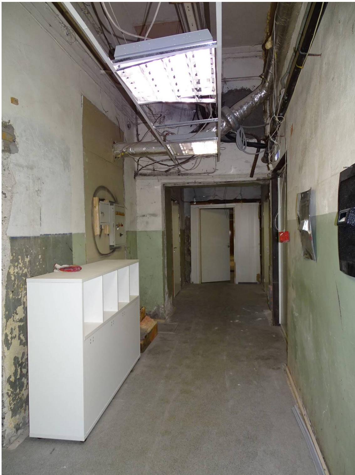
Фото 7. Помещение: 34/15,9. Съемка 10.06.2022 г. Трушковский В.Э.
