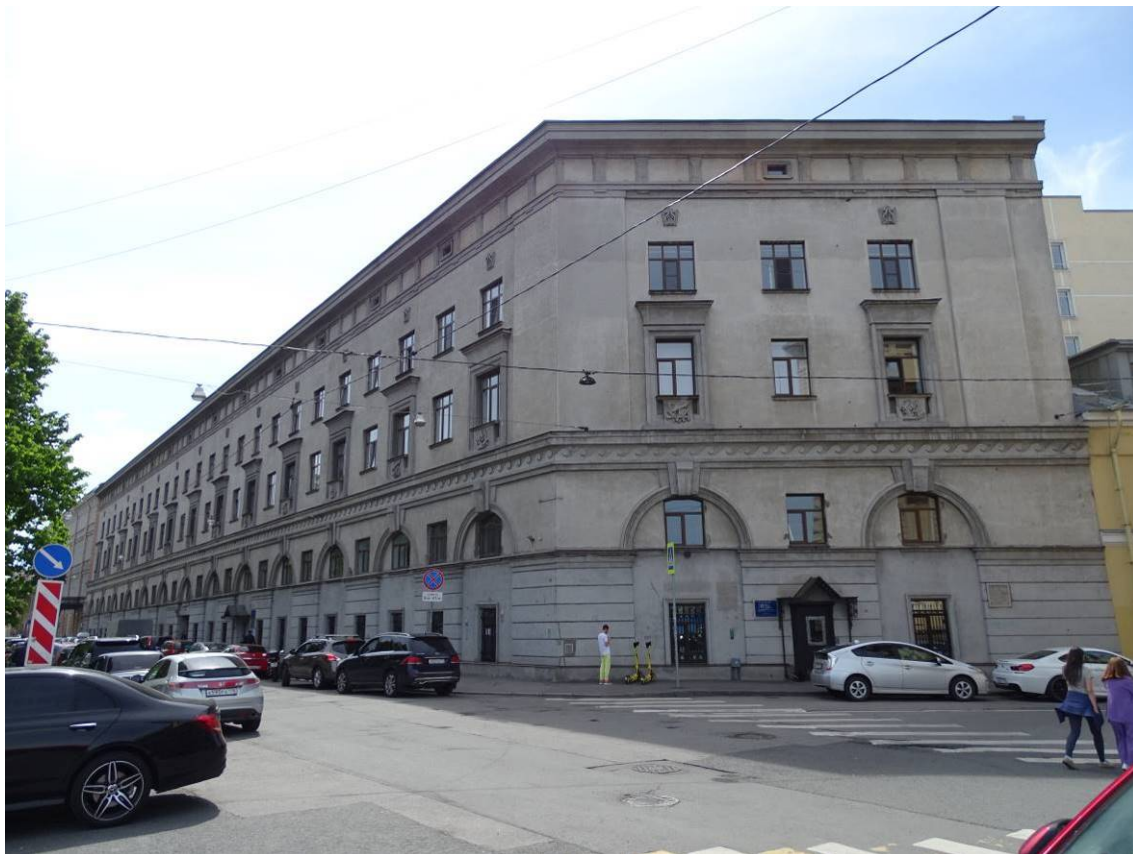
Фото 1. Выявленный объект культурного наследия «Склады торгового дома "Братья Елисеевы" (здание ГОИ им. С. И. Вавилова)». Общий вид. Северный и восточный фасады. Съемка 10.06.2022 г. Трушковский В.Э.
