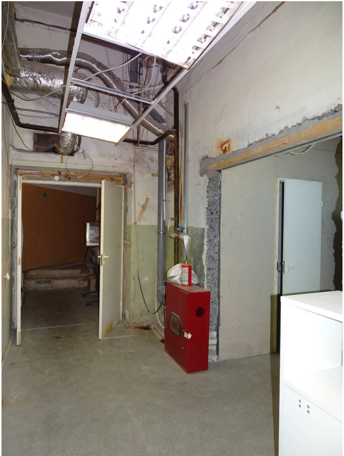
Фото 6. Помещение: 34/15,9; 48/6,0. Съемка 10.06.2022 г. Трушковский В.Э.
