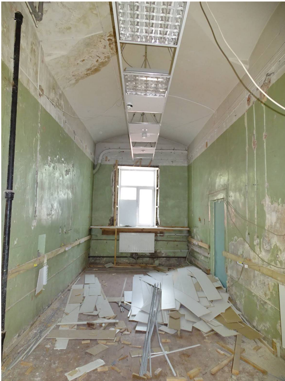
Фото 8. Помещение: 22/13,2. Съемка 10.06.2022 г. Трушковский В.Э.
