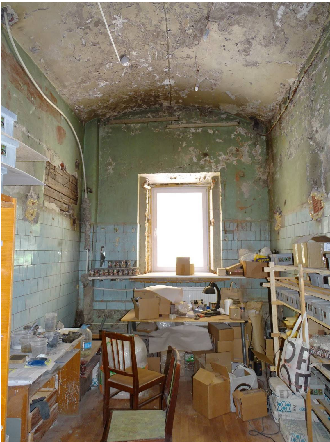
Фото 9. Помещение: 24/24,3. Съемка 10.06.2022 г. Трушковский В.Э.
