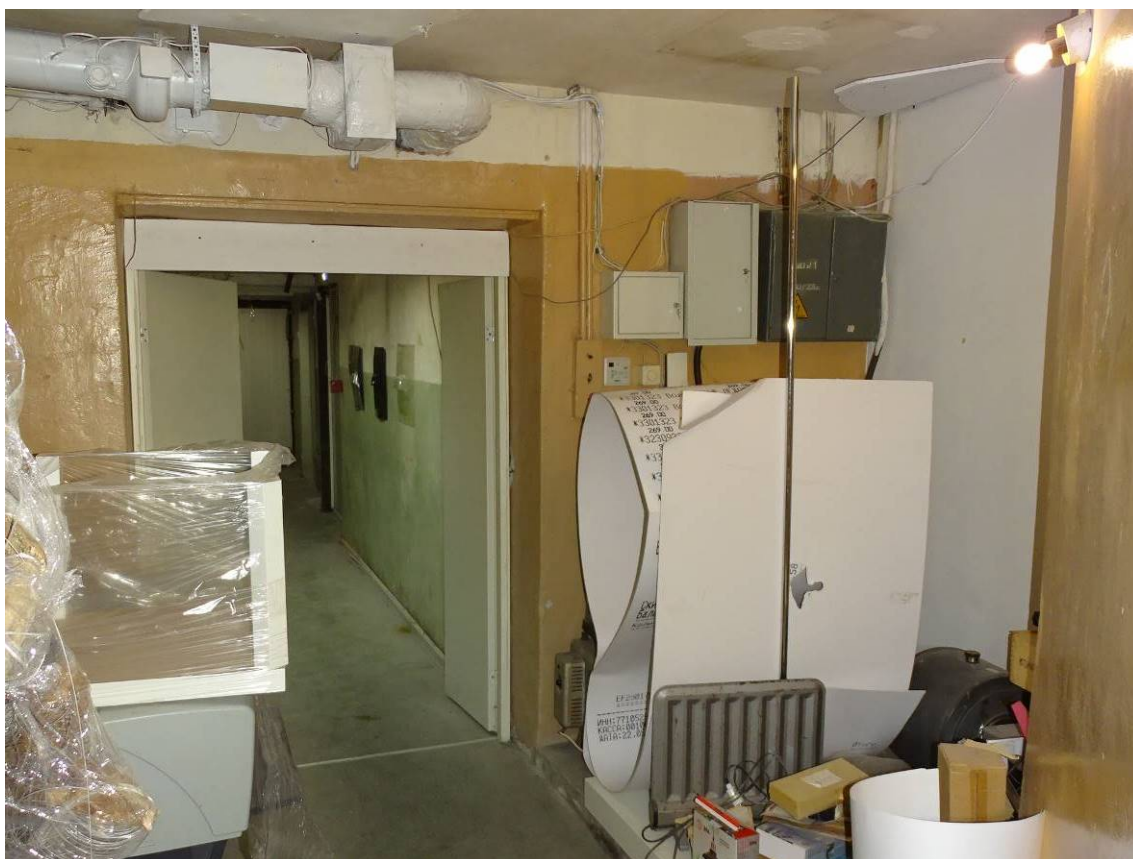
Фото 5. Помещение: 53/6,4. Съемка 10.06.2022 г. Трушковский В.Э.
