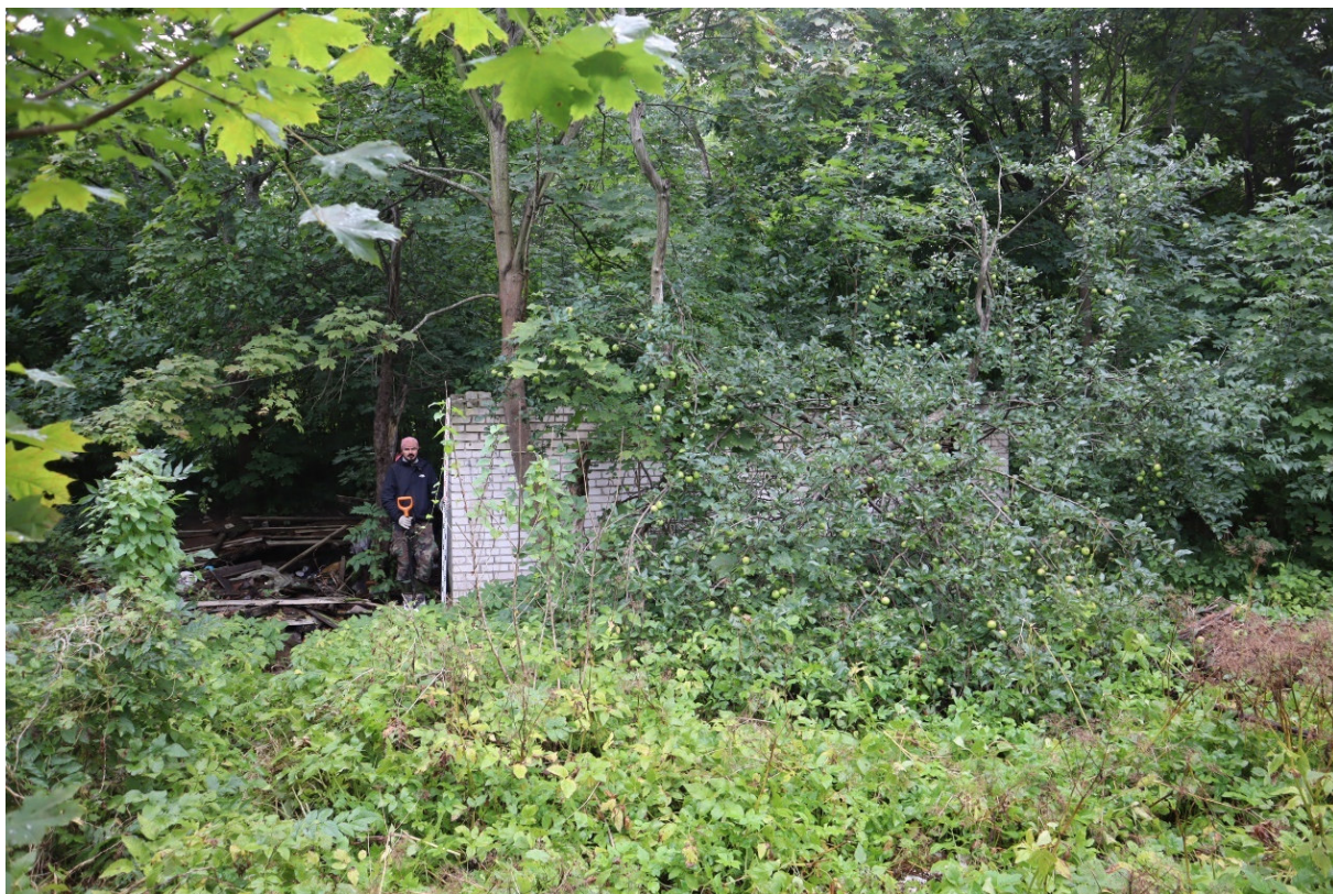
Рис. 11. СПб-2022. Пушкинский район, г. Пушкин, ул. Гражданская. Общий вид участка обследования. Точка съемки 1. Вид на разрушенную кирпичную постройку в южной части участка обследования. Вид на юг
