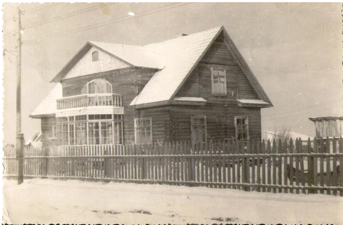
Рис. 7. СПб-2022. Пушкинский район, г. Пушкин, ул. Гражданская. Вид на деревянный дом по адресу: Новая ул., 20. ( в границах участка обследования) Фото из открытых источников ( https://www.citywalls.ru/house22562.html )
