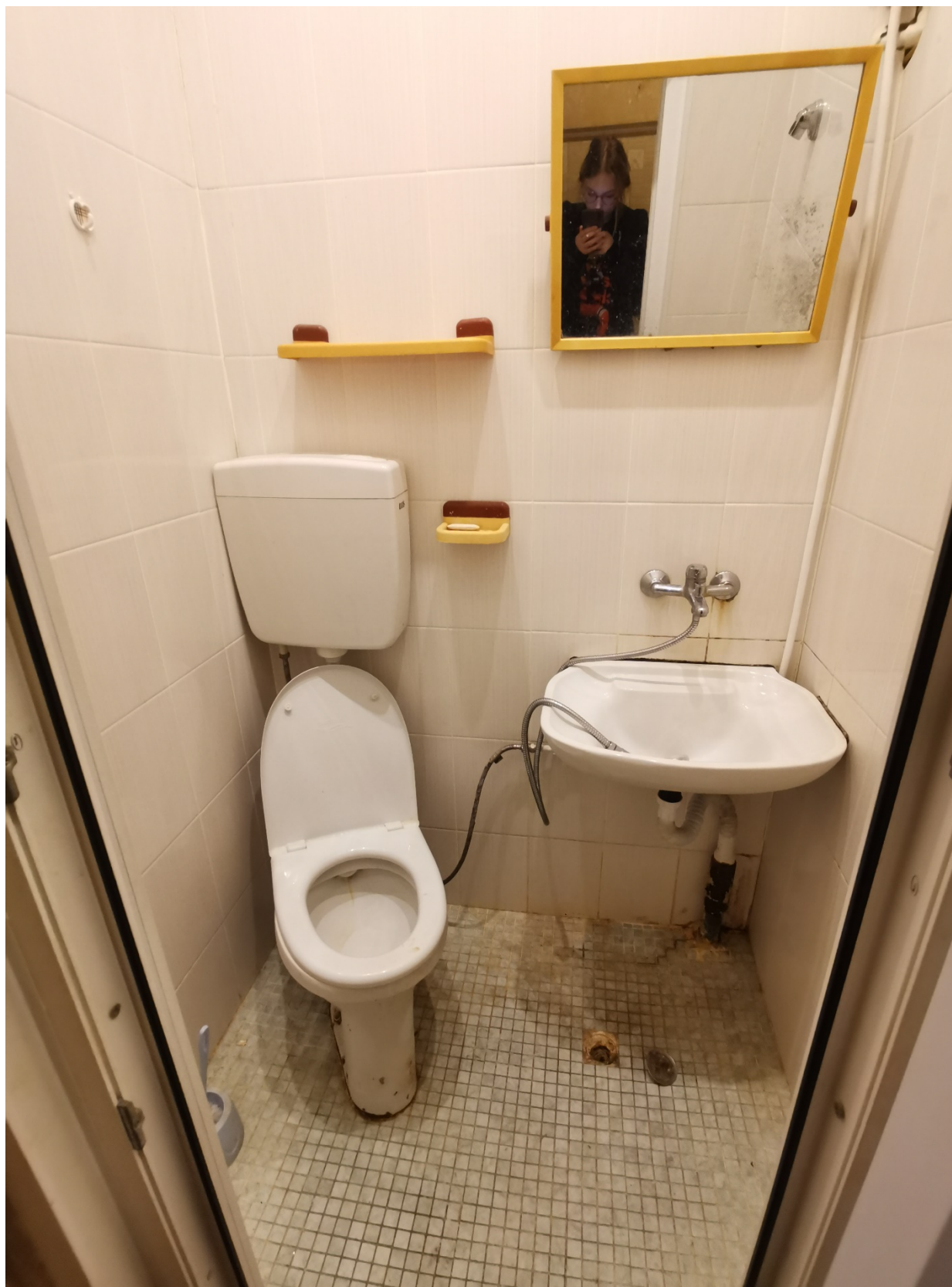
15. Фрагмент интеръера санузла (помещение №3);
