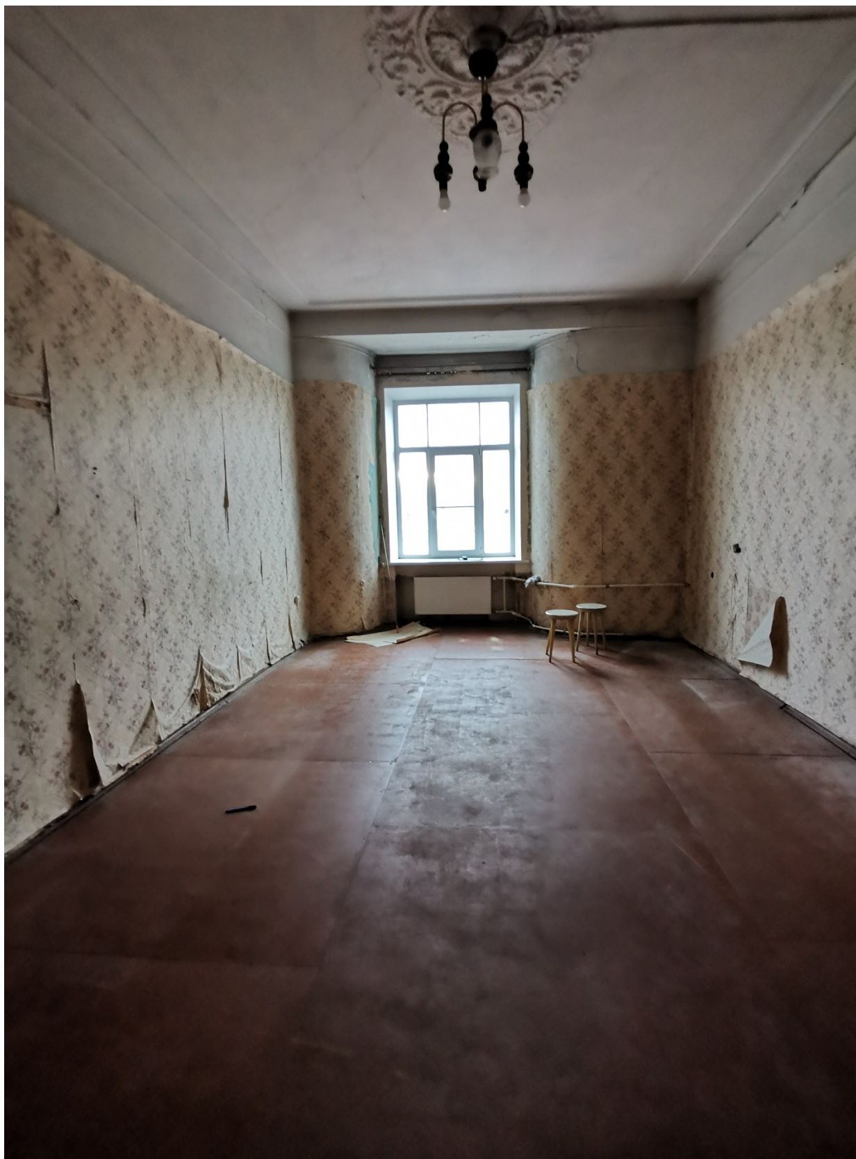
21. Фрагмент интерьера комнаты и декоративной лепнины на потолке (помещение №4);
