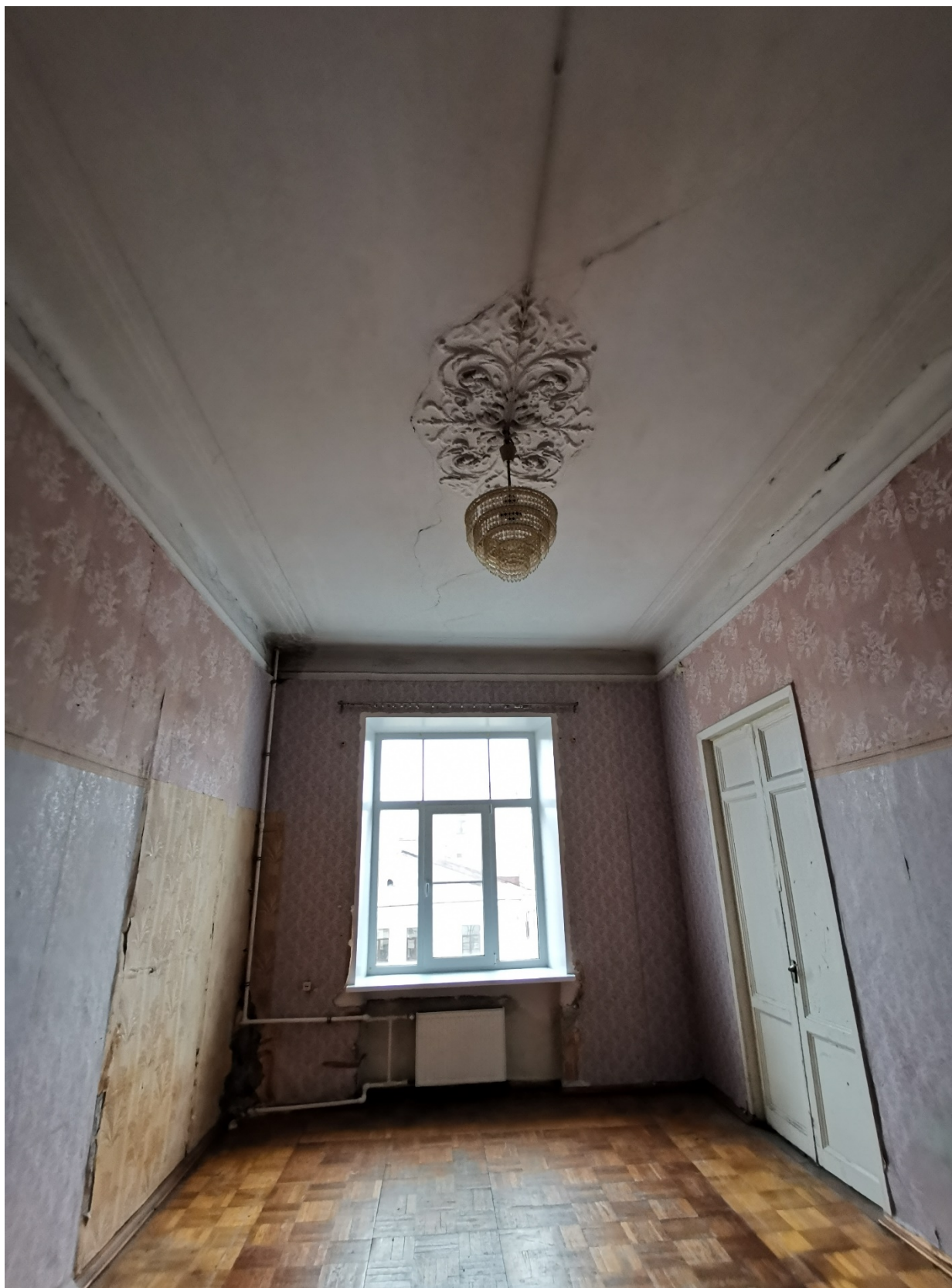
17. Фрагмент интерьера комнаты и декоративной лепнины на потолке (помещение №5) ;
