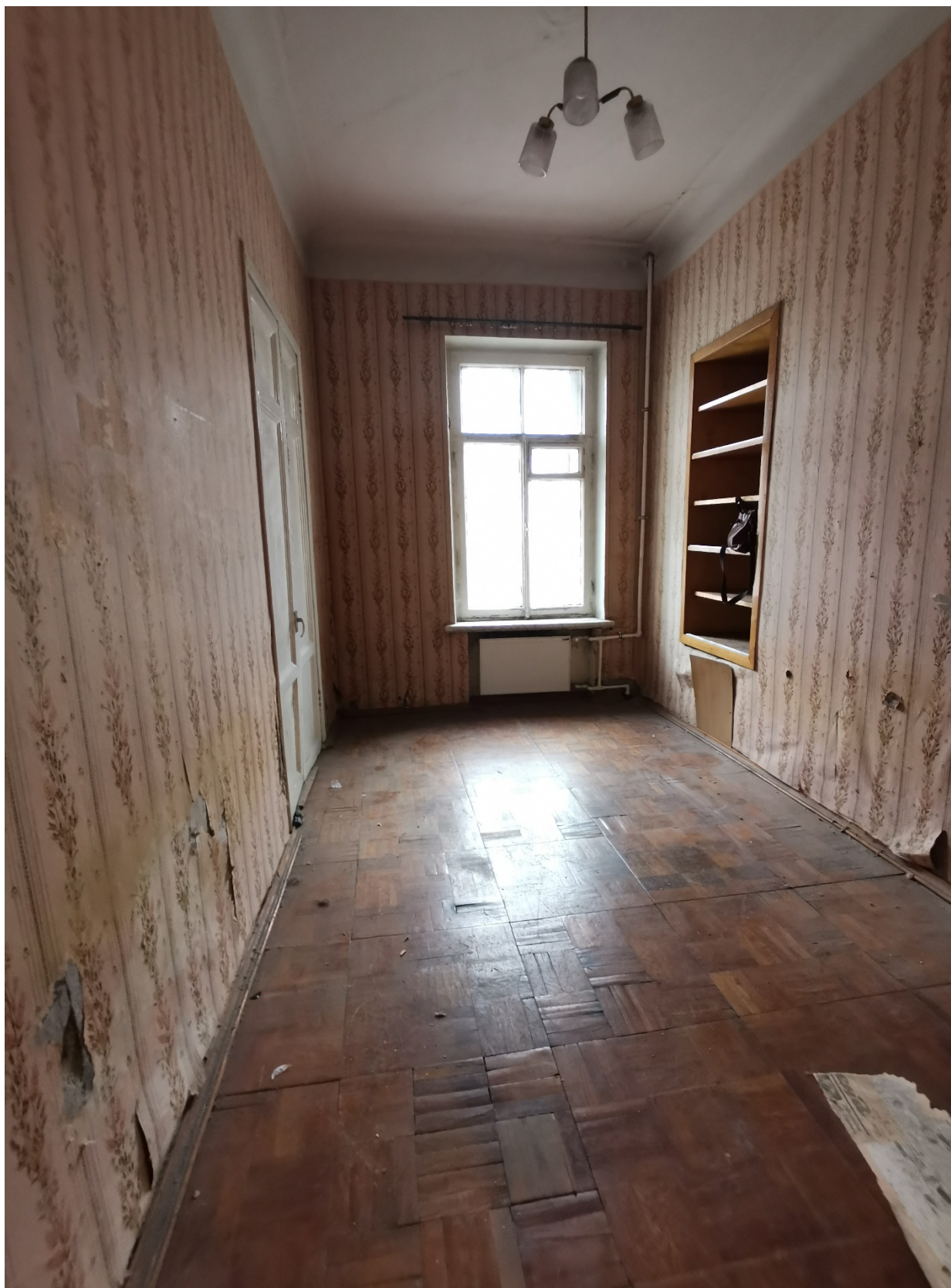
8. Фрагмент интерьера комнаты (помещение №6);
