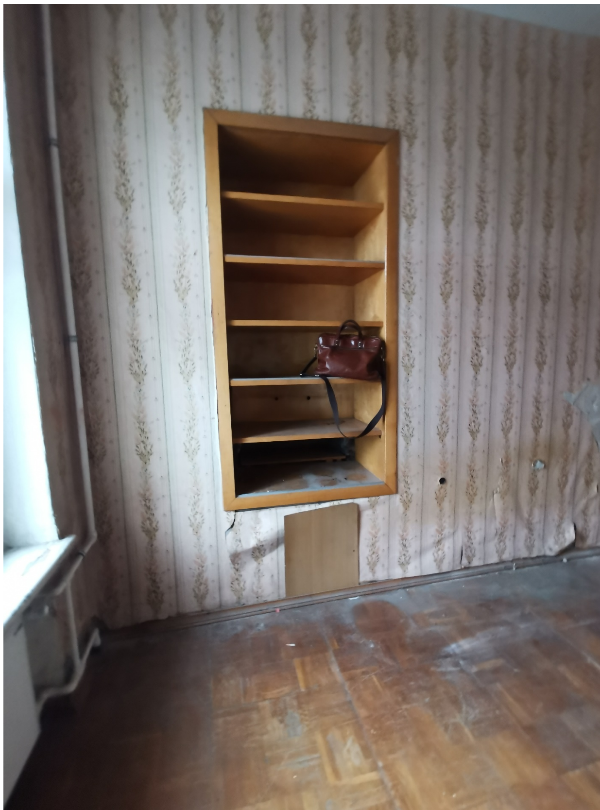
10. Фрагмент интерьера комнаты (помещение №6);
