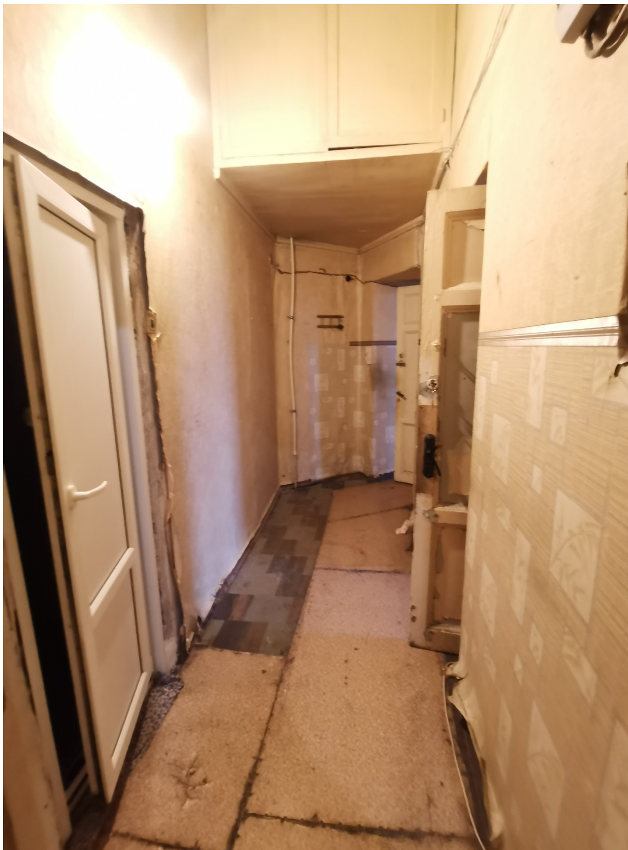
14. Фрагмент интерьера коридора (помещение №2);
