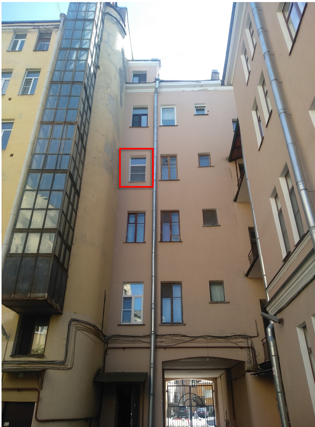
5. Вид на дворовой фасад здания и оконный проём квартиры 44;
