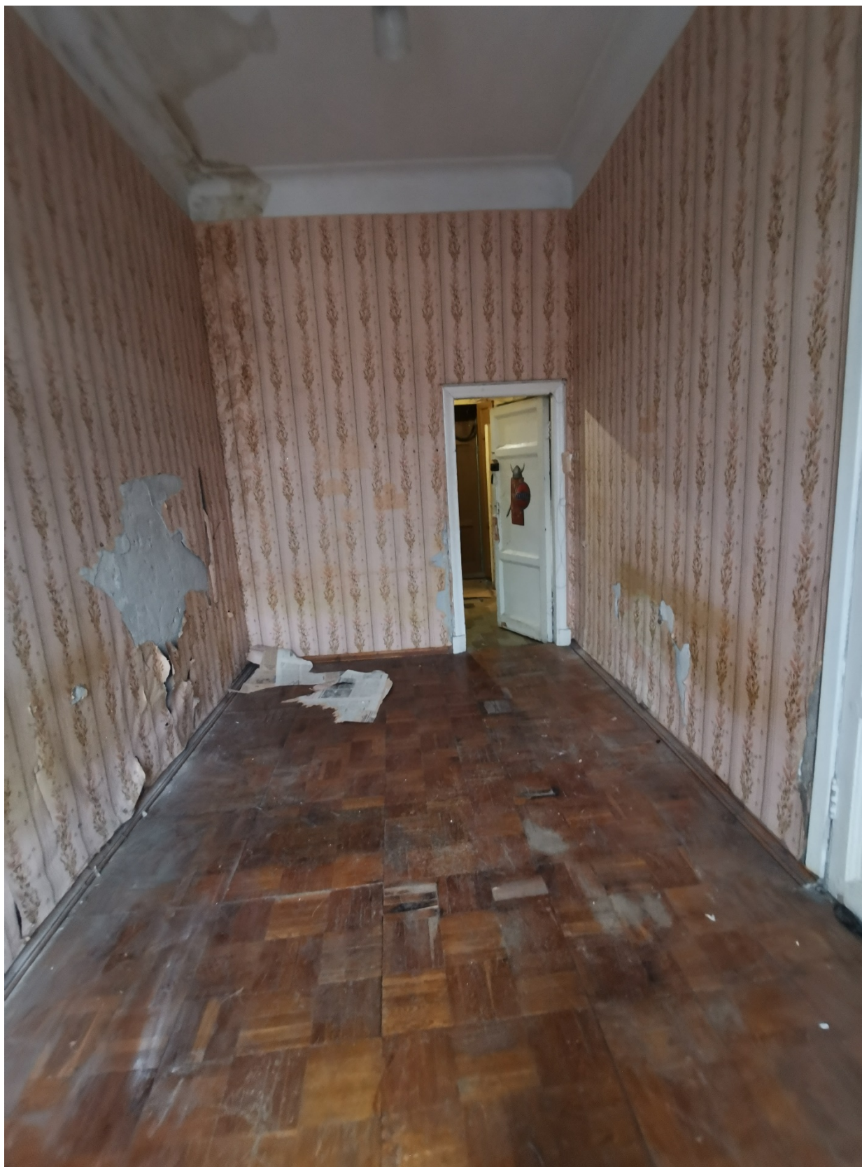
9. Фрагмент интерьера комнаты (помещение №6);
