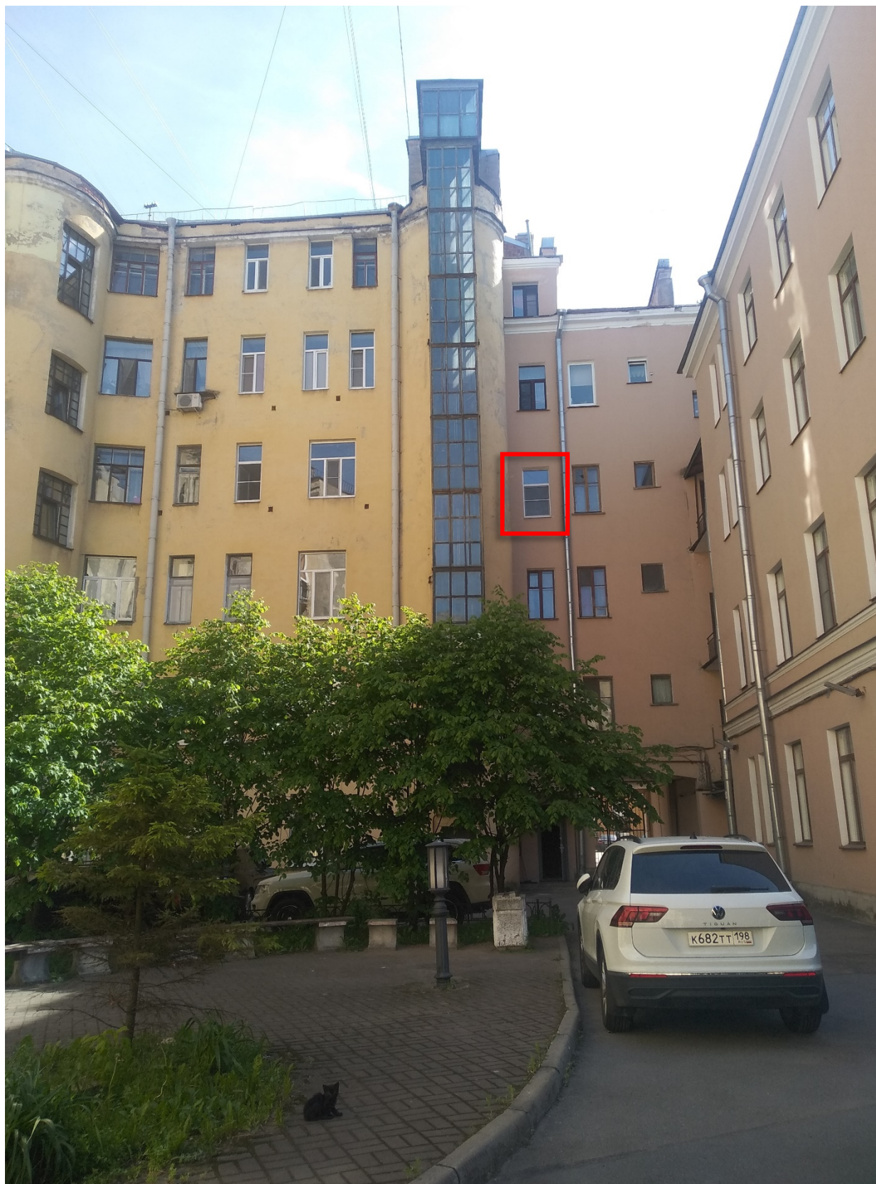
3. Вид на дворовой фасад здания и оконный проём квартиры 44;
