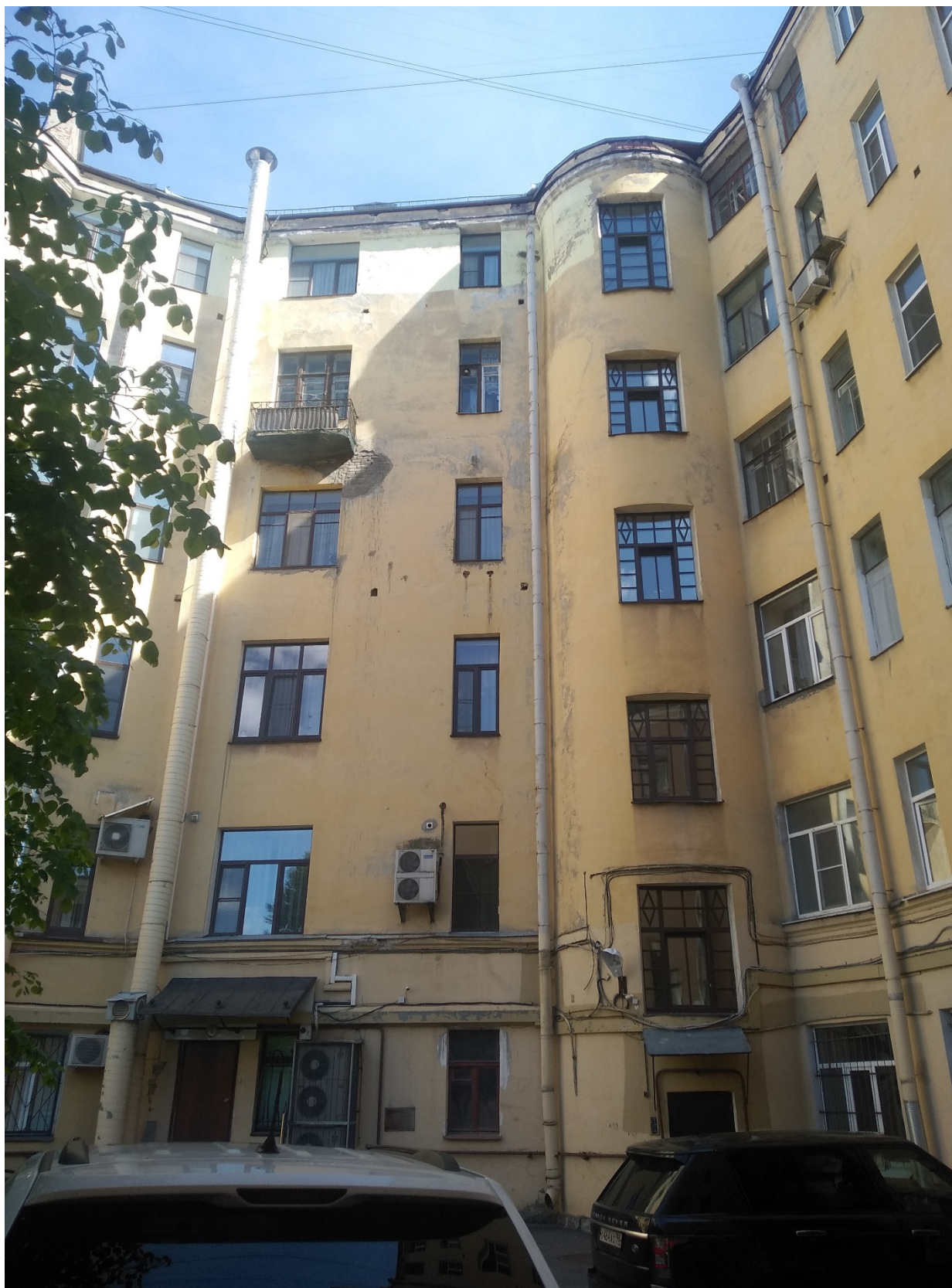
4. Вид на дворовой фасад здания;
