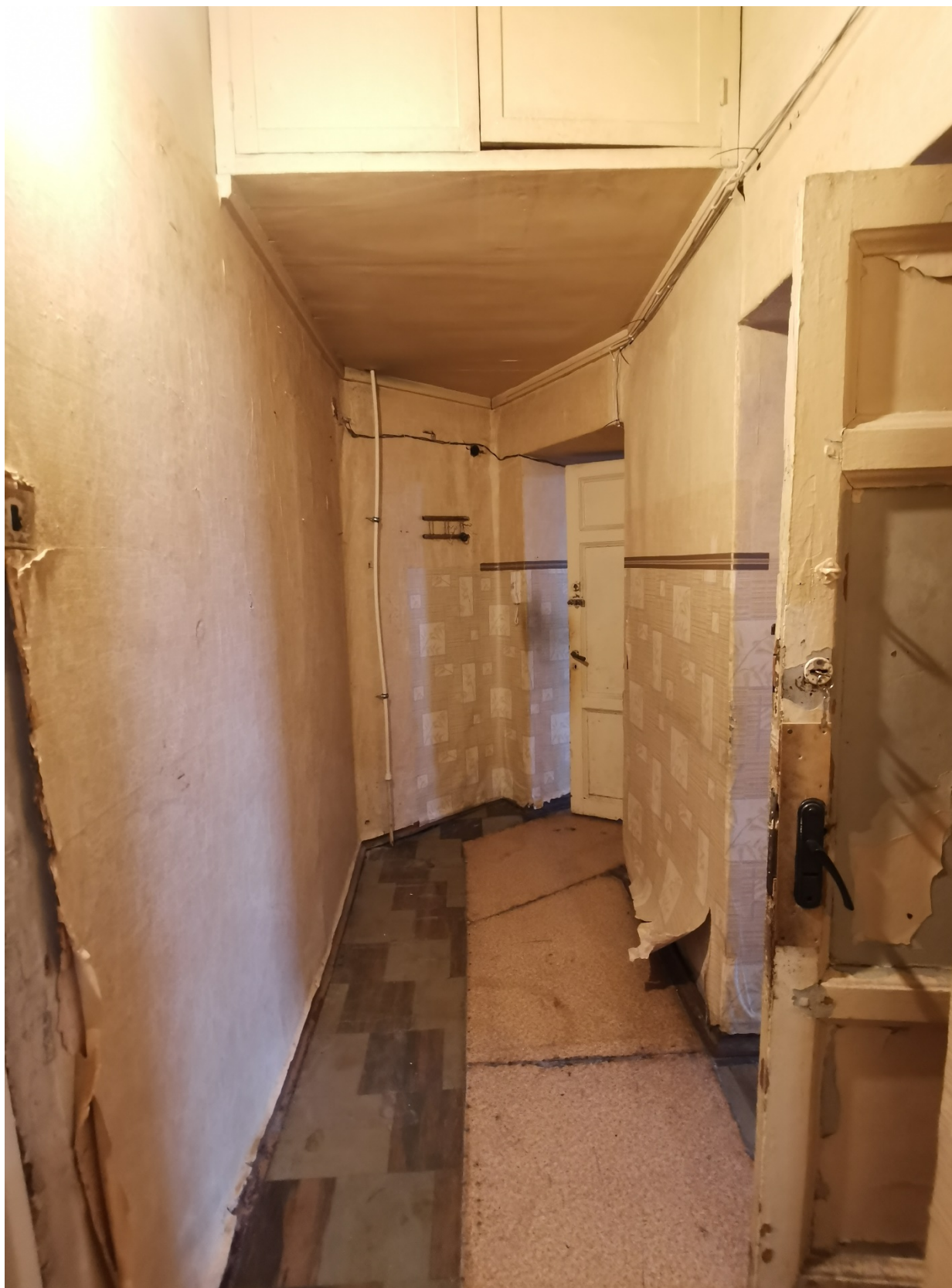
20. Фрагмент интерьера коридора (помещение №2);
