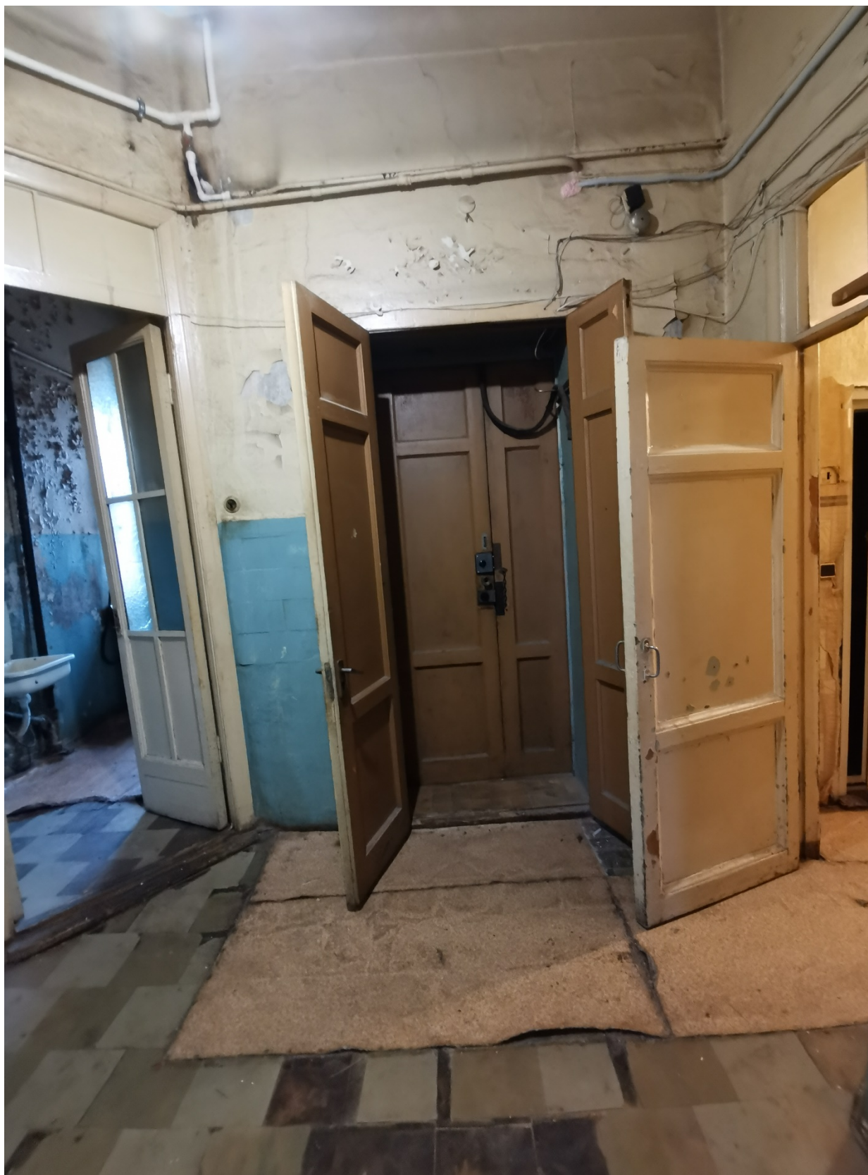
6. Вид на входную дверь в квартире;
