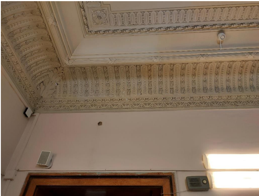
29. «Главный дом, ХУШв., 1-я пол. XIX в., 1886 г., арх. Гедике Р.А., 1907 г., арх. Мельцер Р.Ф.», входящий в состав объекта культурного наследия регионального значения: «Дом Утеман Ф.Ф., ХУШ-ХІХ в.в.», наб. Лейтенанта Шмидта д. 31, лит. А. Третий этаж. Помещение №58. Фрагмент. Фото 17.08.2022 г.
