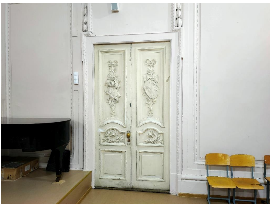
36. «Главный дом, ХУШв., 1-я пол. XIX в., 1886 г., арх. Гедике Р.А., 1907 г., арх. Мельцер Р.Ф.», входящий в состав объекта культурного наследия регионального значения: «Дом Уteman Ф.Ф., ХУШ-ХІХ в.в.», наб. Лейтенанта Шмидта д. 31, лит. А. Третий этаж. Помещение №57. Фрагмент. Фото 17.08.2022 г.
