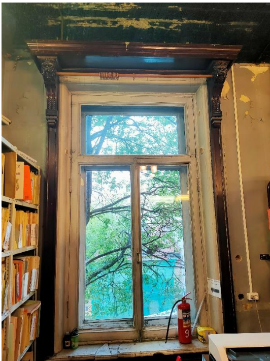
40. «Главный дом, ХУШв., 1-я пол. XIX в., 1886 г., арх. Гедике Р.А., 1907 г., арх. Мельцер Р.Ф.», входящий в состав объекта культурного наследия регионального значения: «Дом Утеман Ф.Ф., ХУШ-ХІХ в.в.», наб. Лейтенанта Шмидта д. 31, лит. А. Третий этаж. Помещение №56. Фрагмент. Фото 17.08.2022 г.
