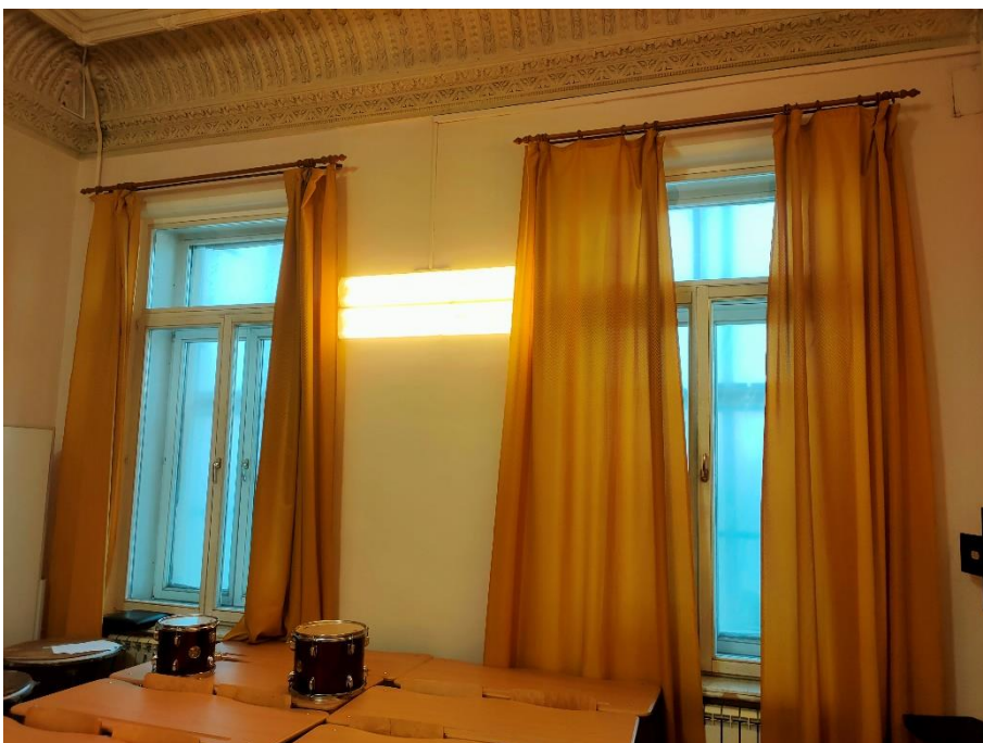
25. «Главный дом, ХУШв., 1-я пол. XIX в., 1886 г., арх. Гедике Р.А., 1907 г., арх. Мельцер Р.Ф.», входящий в состав объекта культурного наследия регионального значения: «Дом Утеман Ф.Ф., ХУШ-ХІХ в.в.», наб. Лейтенанта Шмидта д. 31, лит. А. Третий этаж. Помещение №58. Фрагмент. Фото 17.08.2022 г.
