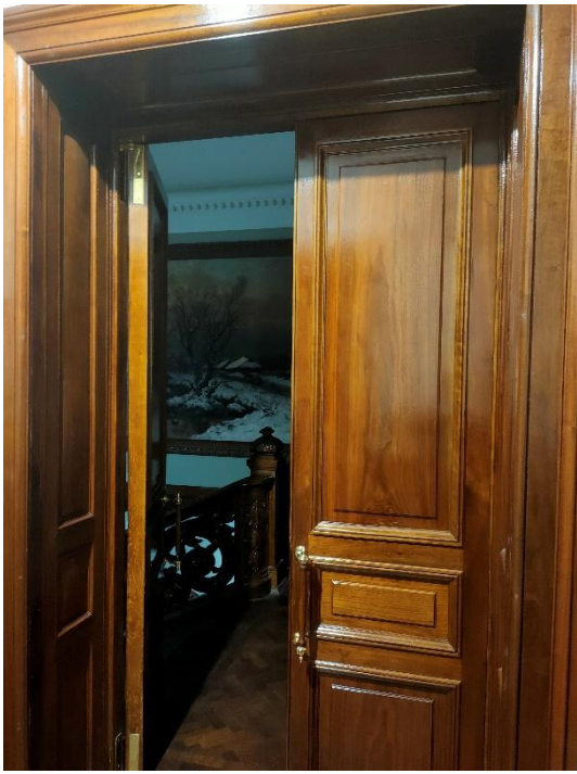
51. «Главный дом, ХУШв., 1-я пол. XIX в., 1886 г., арх. Гедике Р.А., 1907 г., арх. Мельцер Р.Ф.», входящий в состав объекта культурного наследия регионального значения: «Дом Утеман Ф.Ф., ХУШ-ХІХ в.в.», наб. Лейтенанта Шмидта д. 31, лит. А. Третий этаж. Помещение №62. Фрагмент. Фото 17.08.2022 г.
