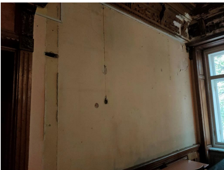
6. «Главный дом, ХУШв., 1-я пол. XIX в., 1886 г., арх. Гедике Р.А., 1907 г., арх. Мельцер Р.Ф.», входящий в состав объекта культурного наследия регионального значения: «Дом Утеман Ф.Ф., ХУШ-ХІХ в.в.», наб. Лейтенанта Шмидта д. 31, лит. А. Третий этаж. Помещение №65. Фрагмент. Фото 17.08.2022 г.
