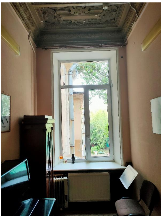
45. «Главный дом, ХУШв., 1-я пол. XIX в., 1886 г., арх. Гедике Р.А., 1907 г., арх. Мельцер Р.Ф.», входящий в состав объекта культурного наследия регионального значения: «Дом Утеман Ф.Ф., ХУШ-ХІХ в.в.», наб. Лейтенанта Шмидта д. 31, лит. А. Третий этаж. Помещение №63. Общий вид. Фото 17.08.2022 г.
