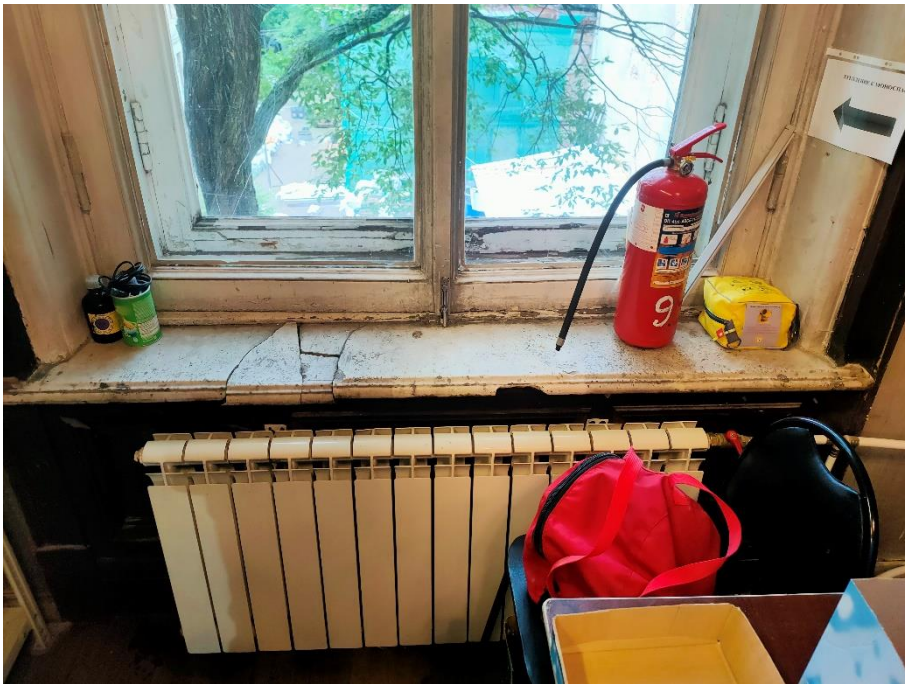
41. «Главный дом, ХУШв., 1-я пол. XIX в., 1886 г., арх. Гедике Р.А., 1907 г., арх. Мельцер Р.Ф.», входящий в состав объекта культурного наследия регионального значения: «Дом Утеман Ф.Ф., ХУШ-ХІХ в.в.», наб. Лейтенанта Шмидта д. 31, лит. А. Третий этаж. Помещение №56. Фрагмент. Фото 17.08.2022 г.
