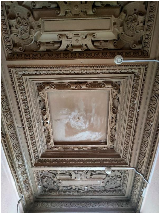
47. «Главный дом, ХУШв., 1-я пол. XIX в., 1886 г., арх. Гедике Р.А., 1907 г., арх. Мельцер Р.Ф.», входящий в состав объекта культурного наследия регионального значения: «Дом Утеман Ф.Ф., ХУШ-ХІХ в.в.», наб. Лейтенанта Шмидта д. 31, лит. А. Третий этаж. Помещение №63. Фрагмент. Фото 17.08.2022 г.
