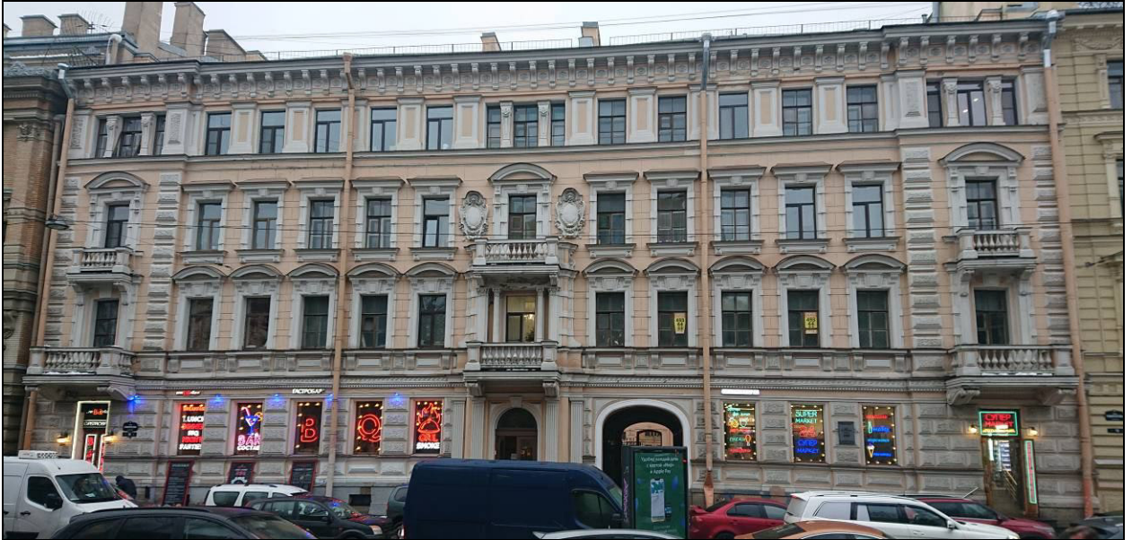
15. Общий на лицевой фасад Дом М.П.Кудрявцевой со стороны улицы Ломоносова. Дата съемки 11.11.2021 г.
