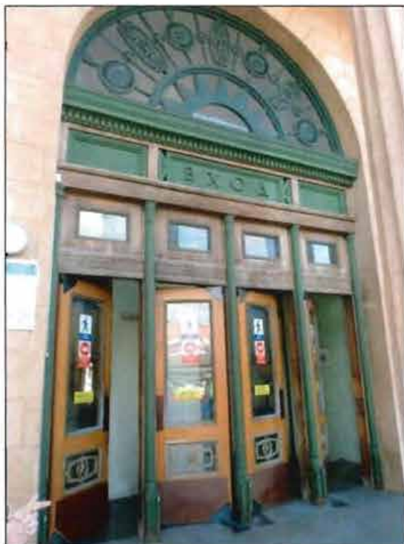
2. Объект культурного наследия. Западный фасад. Оформление южной входной группы. Фотофиксация от 10.12.2021.
