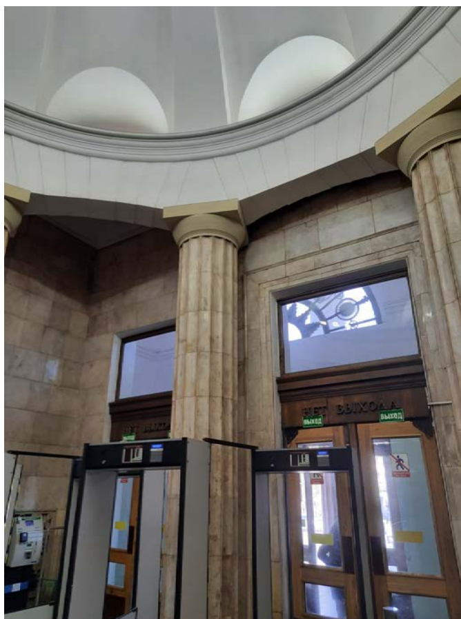
Фото 6 Фрагмент интерьера объекта культурного наследия регионального значения «Станция метро «Кировский завод», г. Санкт-Петербург, пр. Стачек, д. 70, литера А. (кассовый зал)
