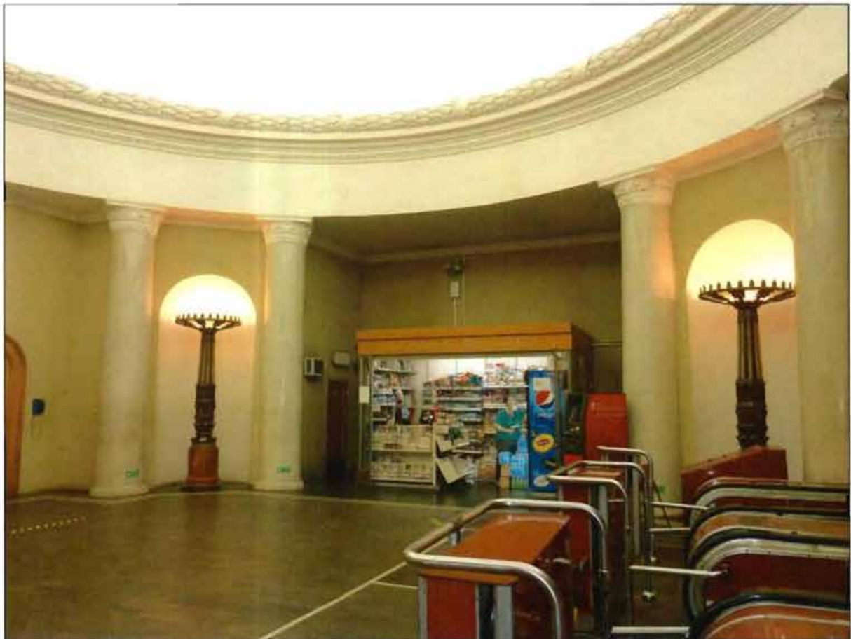
9. Эскалаторный вестибюль. Фотофиксация от 23.07.2021.
