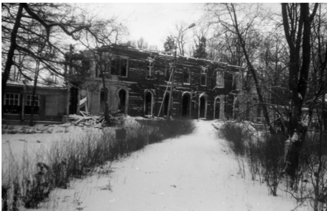
Илл. 26. Особняк в Осиновой роще после пожара 1991 г. Источник: https://pastvu.com/p/125789 .
