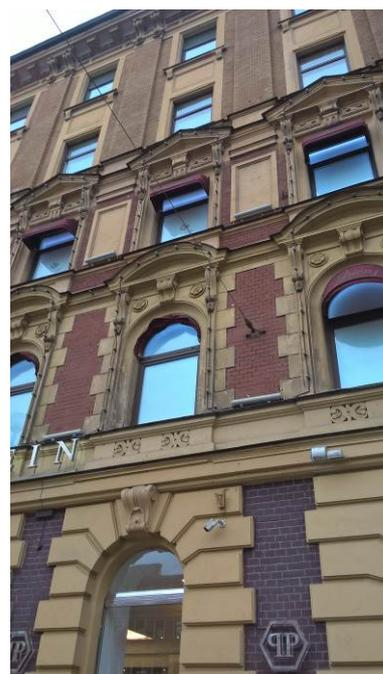
в уровне третьего этажа – обрамлены профилированными наличниками с волнотобразным замковым камнем, завершены треугольным сандриком с лепным декором, на кронштейнах; под оконными проемами – прямоугольные панели, в простенках – неглубокие ниши в профилированных рамках; оконные проемы четвертого и пятого этажей объединены наличниками простого профиля, в уровне пятого этажа – подоконные доски на лепных кронштейнах;
