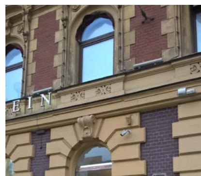
завершен профилированным карнизом с поясом иоников и сухариками, покоящимся на парных волутообразных кронштейнах с гуттами;
