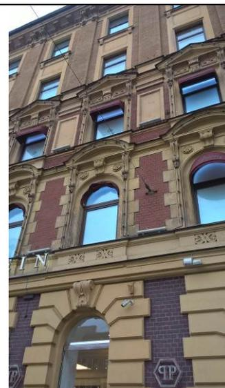
по горизонтали фасад разделен межэтажным карнизом в уровне первого-второго этажей и подоконным карнизом второго, третьего и четвертого этажей;
