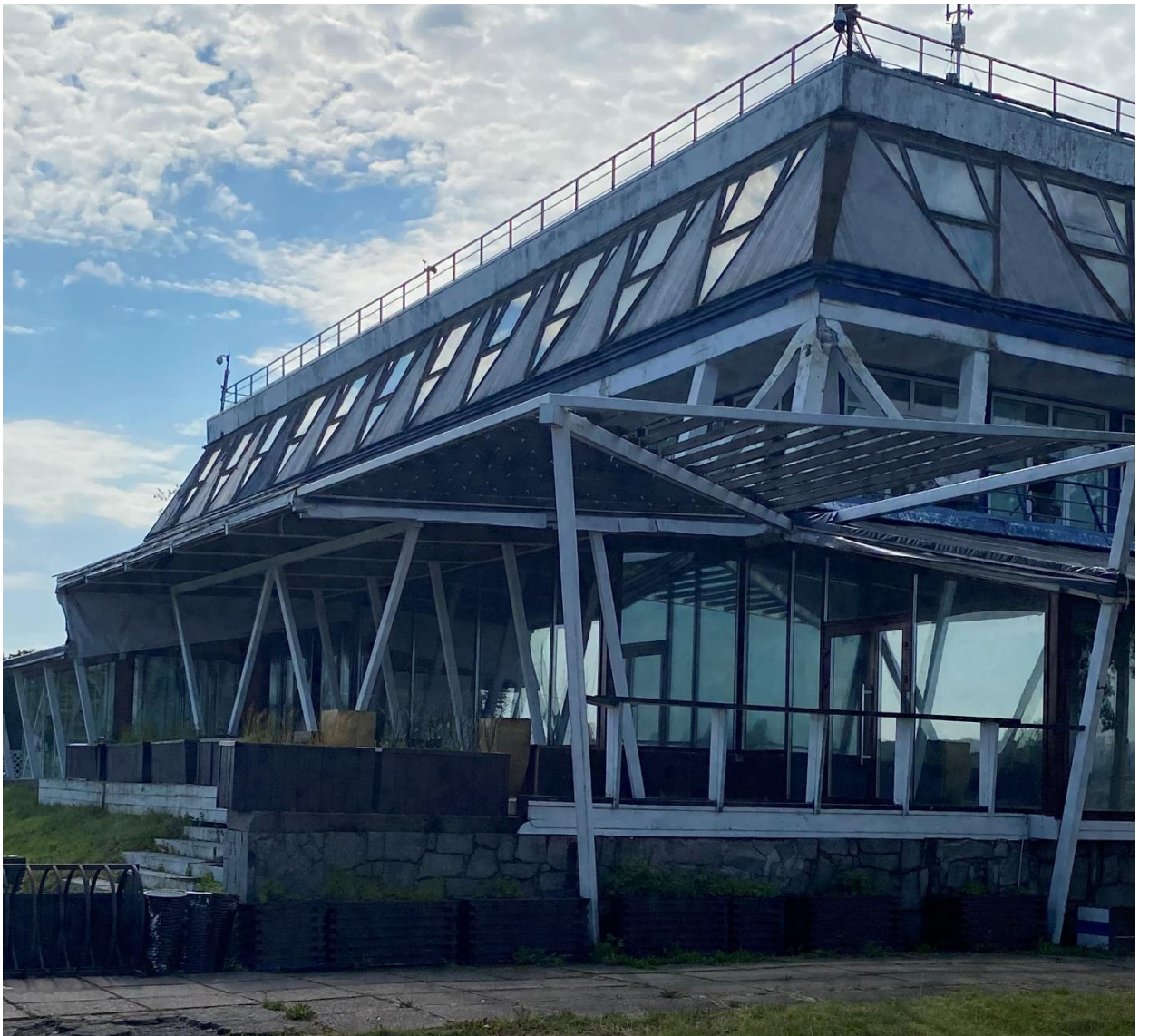
Фото 10. Северный фасад. Фрагмент. Поздние диссонирующие пристройки на террасе.
