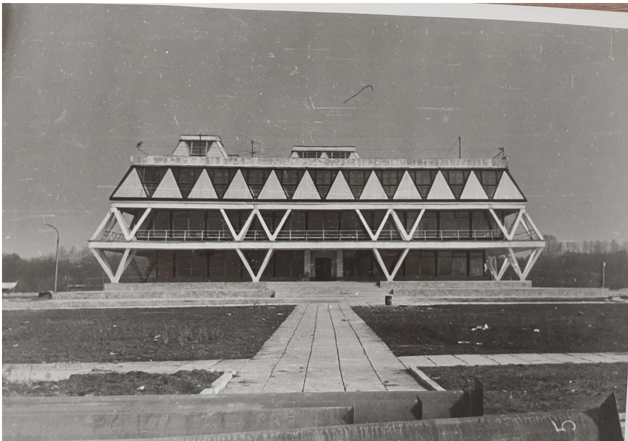
Илл. 35. Фотография. Южный фасад главного здания центрального яхт-клуба. ЦГАНТД СПб. Ф. Р-427. Оп. 1. Д. 33. Л. 5
