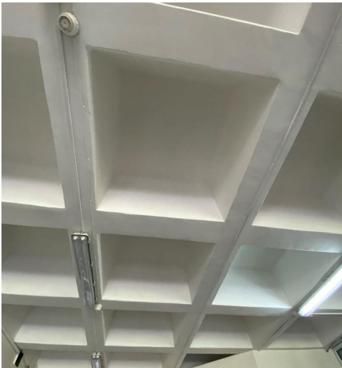
Фото 9. Фрагмент кессонированной плиты перекрытия.
