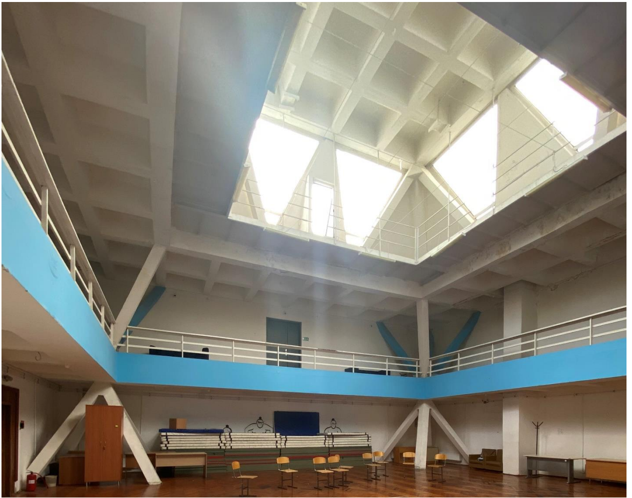
Фото 8. Пространственный каркас светового фонаря, кессонированные плиты перекрытия.
