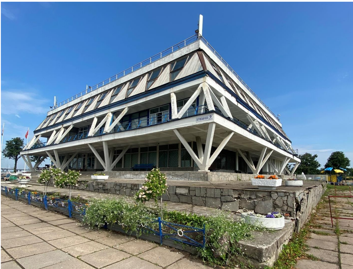
Фото 3. Вид на Главное здание яхт-клуба с юго-восточной стороны территории.
