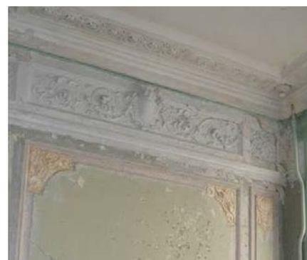
оформление потолка – по центру лепная розетка с расходящимися по стомам акантовыми листьями и лепной гирляндой из цветов с картушами, по периметру потолка лепной пояс из розеток, профилированный карниз в верхних частях стен;
