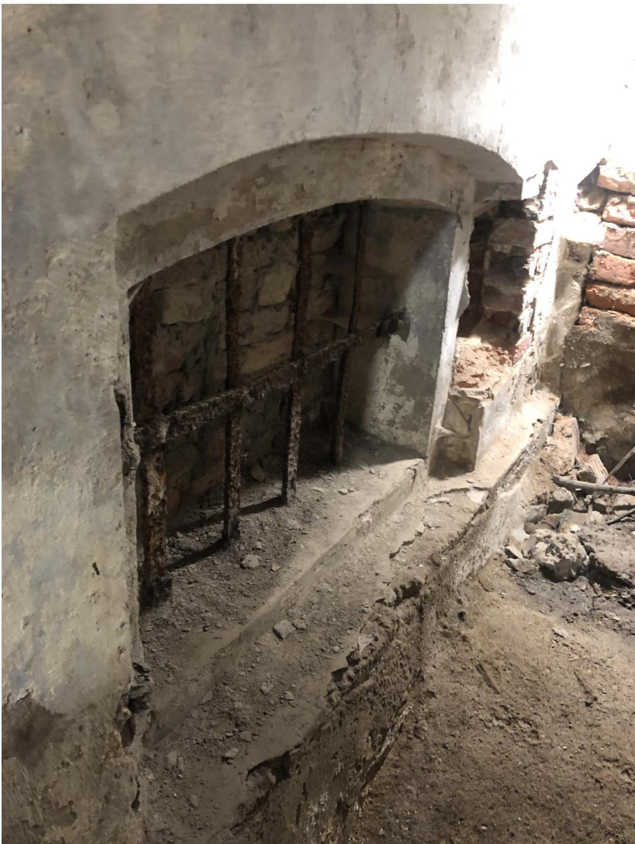
Фото 11. Заложённый внутренний оконный проем в подвале.
