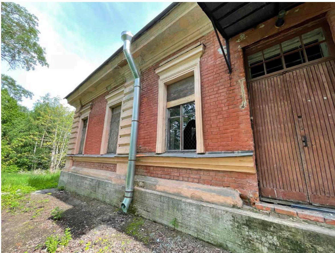
17. Фрагмент северного фасада
