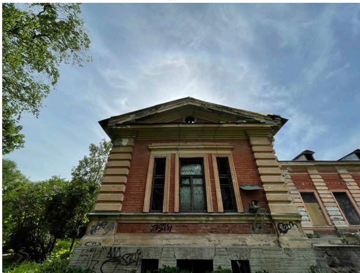
8. Фрагмент восточного фасада
