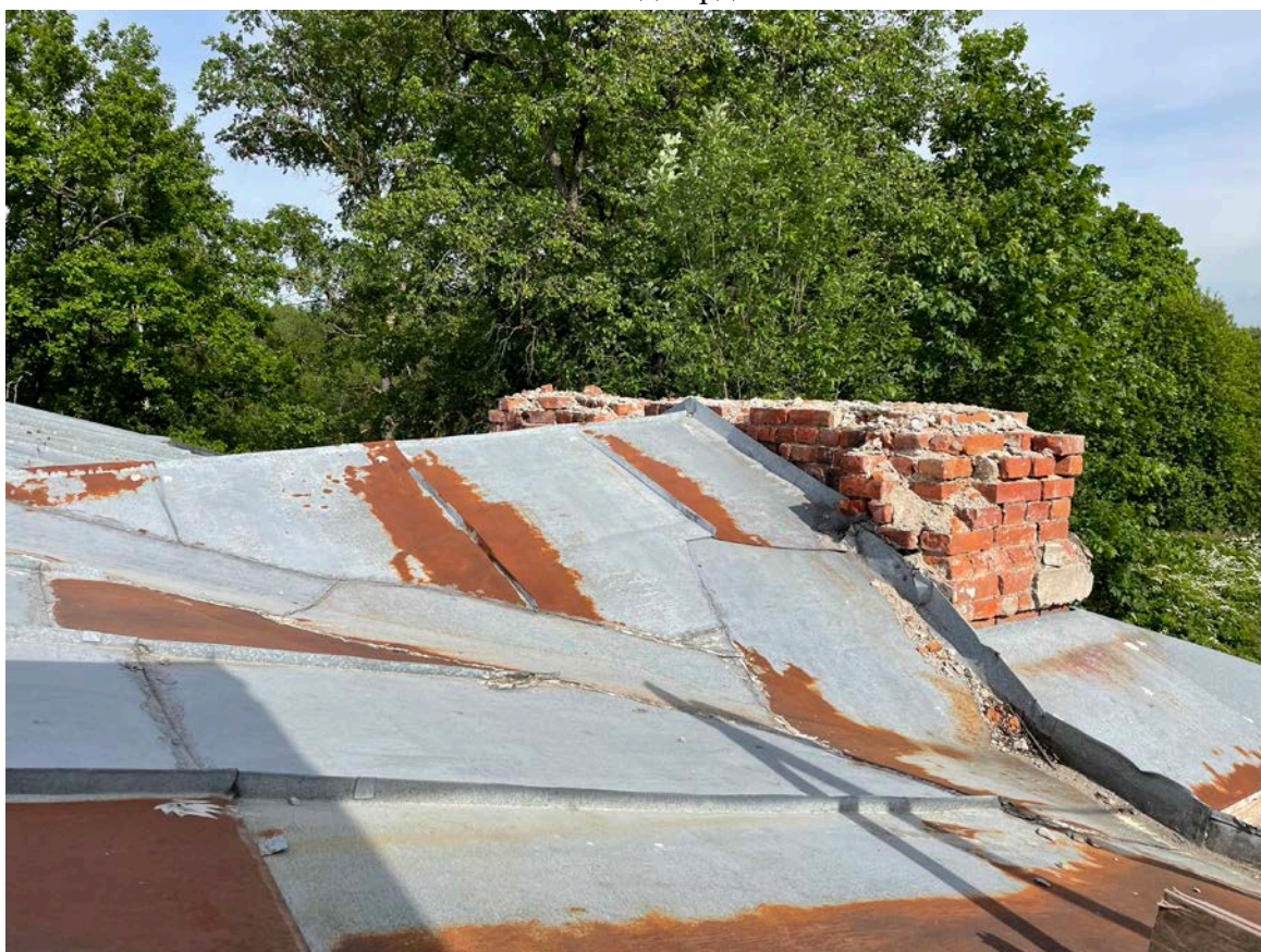
74. Вид на крышу
