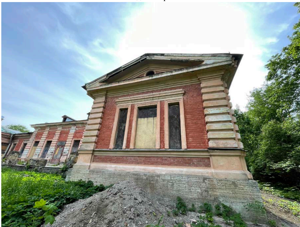
16. Фрагмент восточного фасада
