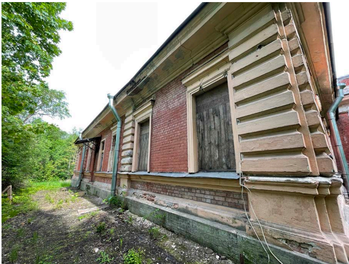
19. Вид северного фасада
