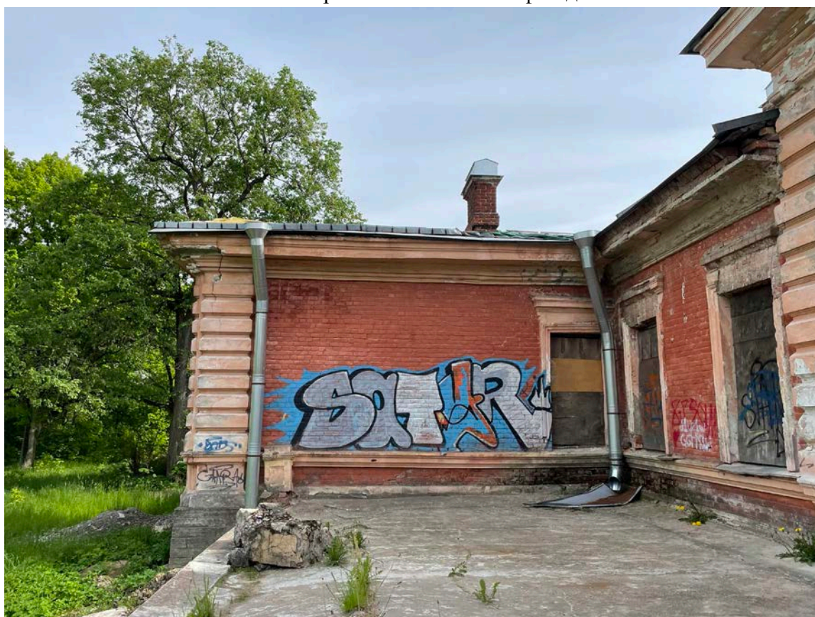
10. Фрагмент восточного фасада
