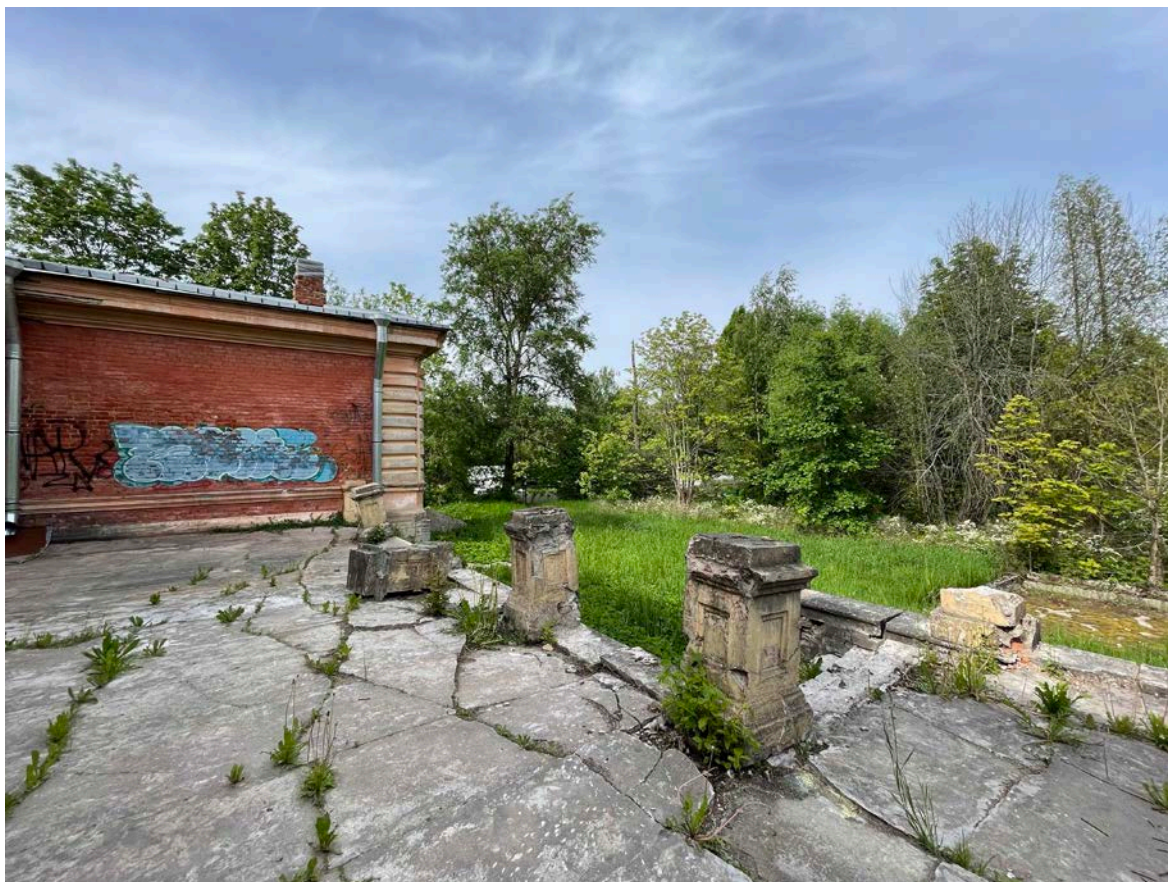
11. Фрагмент террасы и восточного фасада
