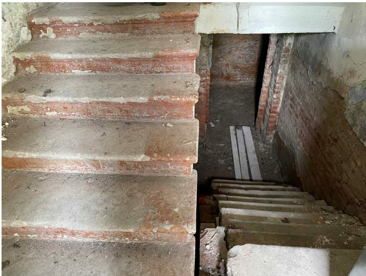
27. Лестница в подвал
