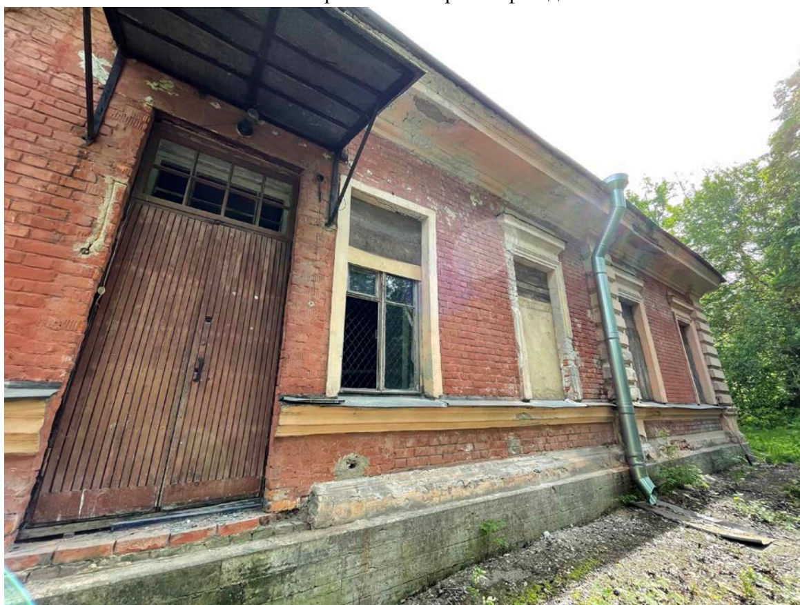
18. Фрагмент северного фасада
