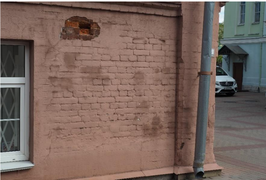
30. «Машинное отделение №3 с мастерскими и котельной и кладовые» в составе ансамбля «Комплекс главной станции Санкт-Петербургских городских водопроводов», ул. Шпалерная, д. 56, лит. АИ. Западный фасад. Фрагмент. Фото 08.08.2022г.
