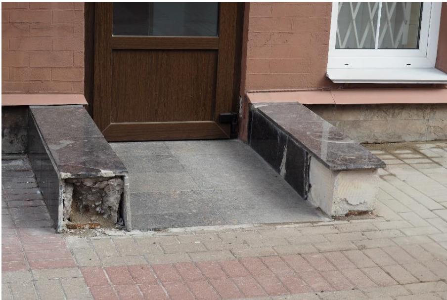
25. «Машинное отделение №3 с мастерскими и котельной и кладовые» в составе ансамбля «Комплекс главной станции Санкт-Петербургских городских водопроводов», ул. Шпалерная, д. 56, лит. АИ. Западный фасад. Фрагмент. Фото 08.08.2022г.
