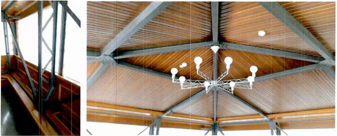
8, 9. Металлический клепаный каркас
