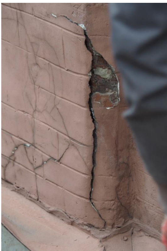
12. «Машинное отделение №3 с мастерскими и котельной и кладовые» в составе ансамбля «Комплекс главной станции Санкт-Петербургских городских водопроводов», ул. Шпалерная, д. 56, лит. АИ. Восточный фасад. Фрагмент. Фото 08.08.2022г.
