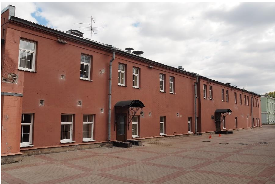
20. «Машинное отделение №3 с мастерскими и котельной и кладовые» в составе ансамбля «Комплекс главной станции Санкт-Петербургских городских водопроводов», ул. Шпалерная, д. 56, лит. АИ. Западный фасад. Общий вид. Фото 08.08.2022г.
