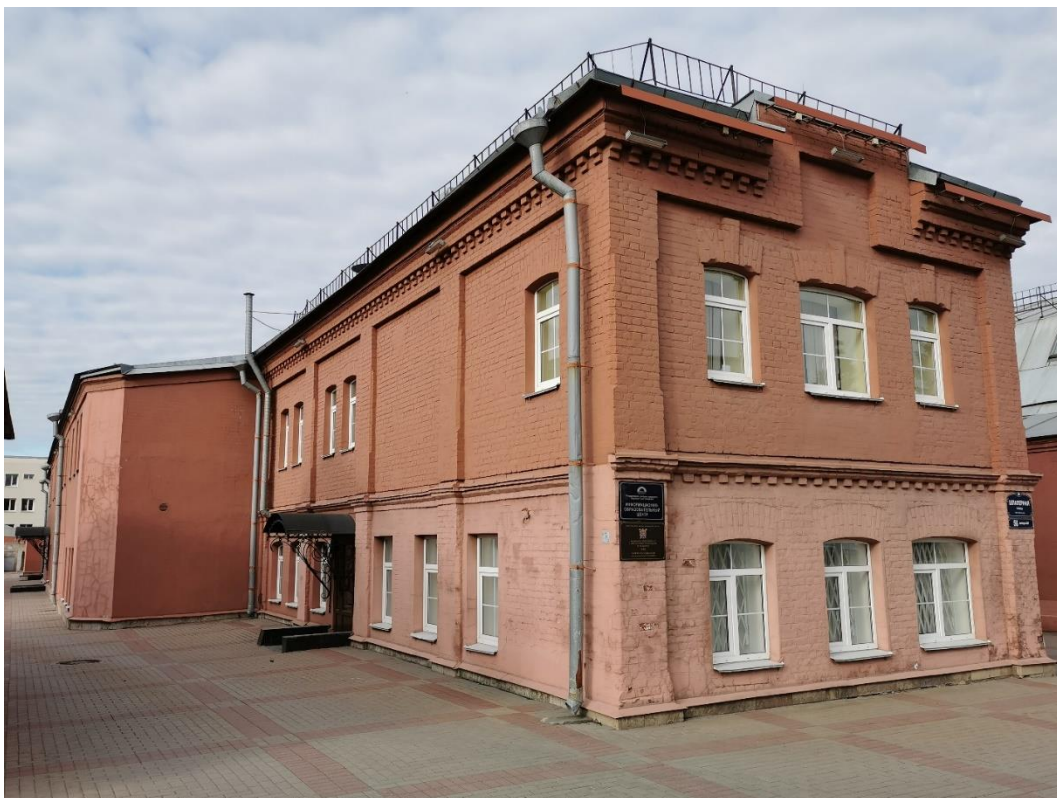
1. «Машинное отделение №3 с мастерскими и котельной и кладовые» в составе ансамбля «Комплекс главной станции Санкт-Петербургских городских водопроводов», ул. Шпалерная, д. 56, лит. АИ. Общий вид с юго-запада. Фото 08.08.2022г.
