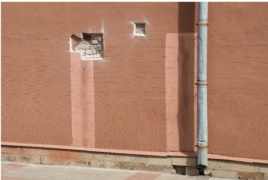
26. «Машинное отделение №3 с мастерскими и котельной и кладовые» в составе ансамбля «Комплекс главной станции Санкт-Петербургских городских водопроводов», ул. Шпалерная, д. 56, лит. АИ. Западный фасад. Фрагмент. Фото 08.08.2022г.
