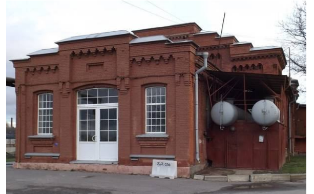
Ризалит западного фасада юго-западного корпуса
