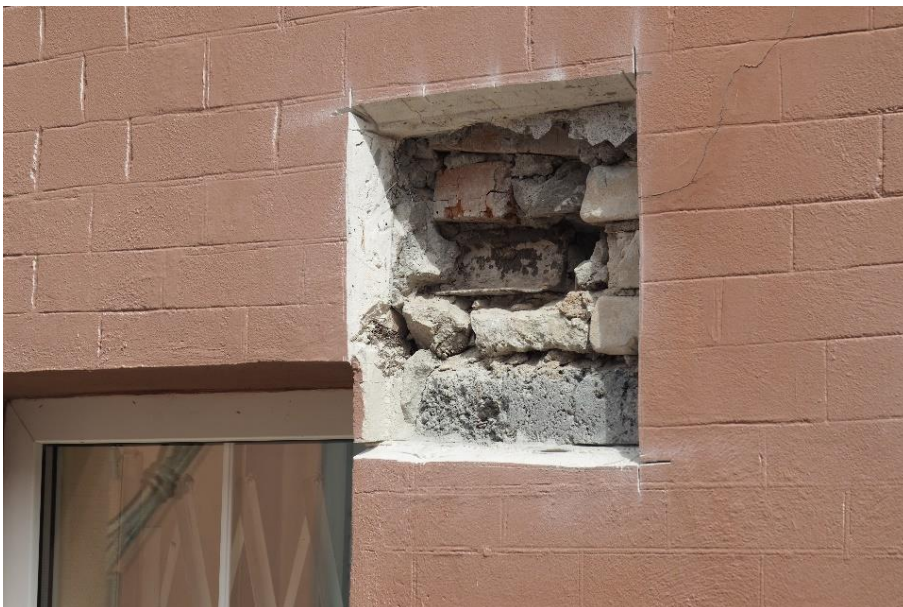
24. «Машинное отделение №3 с мастерскими и котельной и кладовые» в составе ансамбля «Комплекс главной станции Санкт-Петербургских городских водопроводов», ул. Шпалерная, д. 56, лит. АИ. Западный фасад. Фрагмент. Фото 08.08.2022г.
