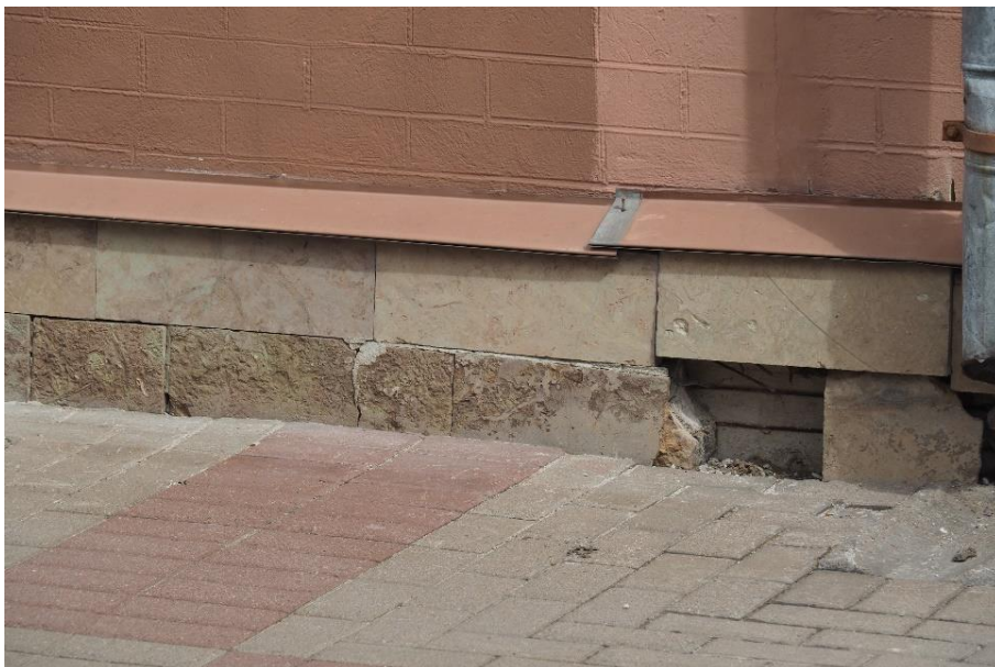
27. «Машинное отделение №3 с мастерскими и котельной и кладовые» в составе ансамбля «Комплекс главной станции Санкт-Петербургских городских водопроводов», ул. Шпалерная, д. 56, лит. АИ. Западный фасад. Фрагмент. Фото 08.08.2022г.
