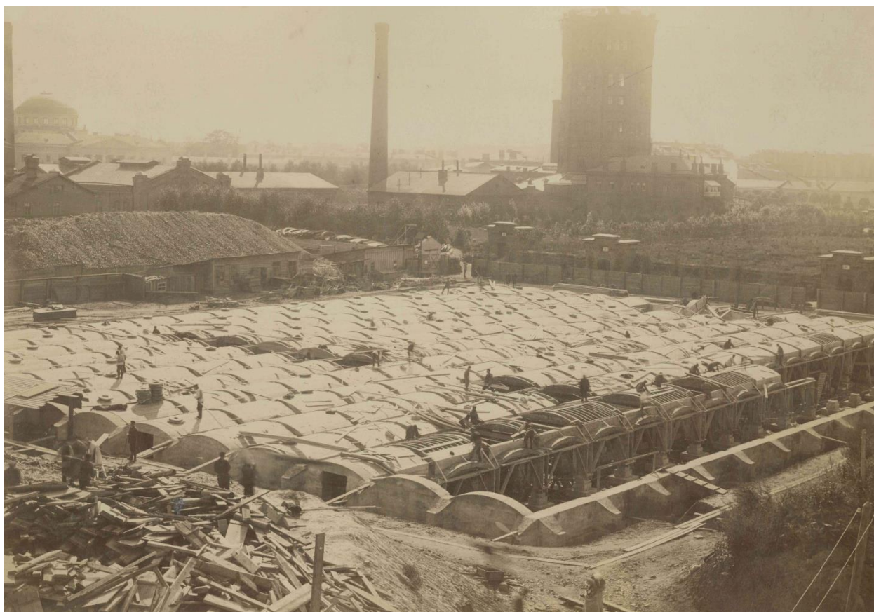
Илл. 6. Строительство фильтров. кон. 1880-х гг.
