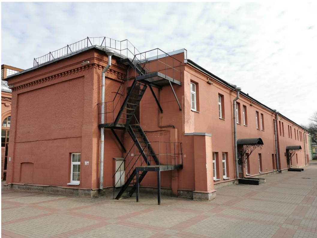
3. «Машинное отделение №3 с мастерскими и котельной и кладовые» в составе ансамбля «Комплекс главной станции Санкт-Петербургских городских водопроводов», ул. Шпалерная, д. 56, лит. АИ. Западный фасад. Общий вид. Фото 08.08.2022г.
