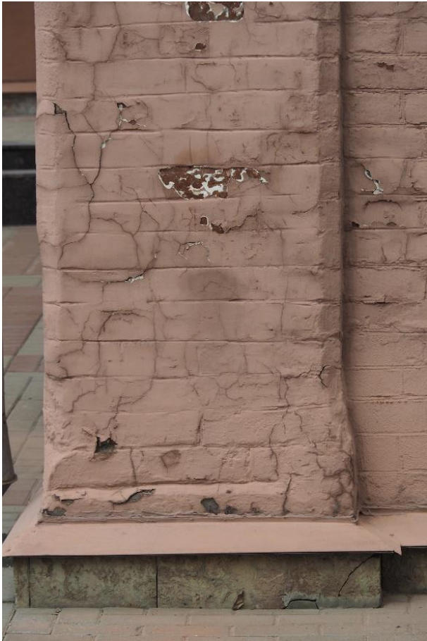
7. «Машинное отделение №3 с мастерскими и котельной и кладовые» в составе ансамбля «Комплекс главной станции Санкт-Петербургских городских водопроводов», ул. Шпалерная, д. 56, лит. АИ. Южный фасад. Фрагмент. Фото 08.08.2022г.
