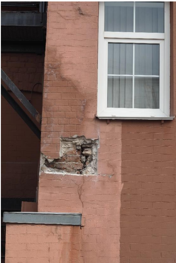
21. «Машинное отделение №3 с мастерскими и котельной и кладовые» в составе ансамбля «Комплекс главной станции Санкт-Петербургских городских водопроводов», ул. Шпалерная, д. 56, лит. АИ. Западный фасад. Фрагмент. Фото 08.08.2022г.
