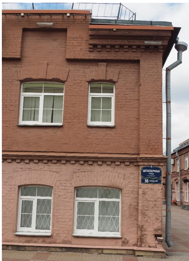
6. «Машинное отделение №3 с мастерскими и котельной и кладовые» в составе ансамбля «Комплекс главной станции Санкт-Петербургских городских водопроводов», ул. Шпалерная, д. 56, лит. АИ. Южный фасад. Фрагмент. Фото 08.08.2022г.
