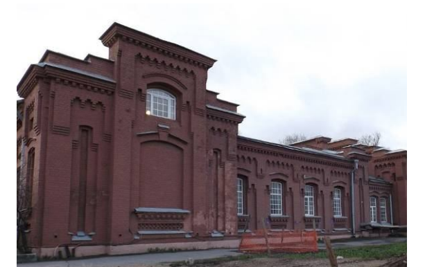
Северный фасад северо-восточного корпуса
