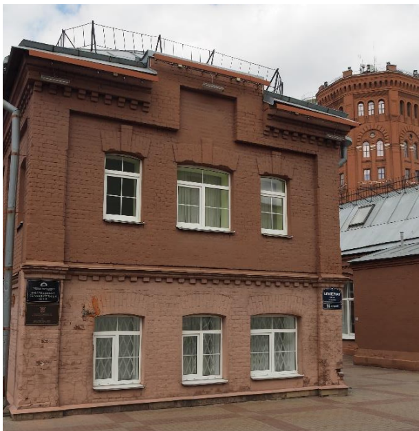
5. «Машинное отделение №3 с мастерскими и котельной и кладовые» в составе ансамбля «Комплекс главной станции Санкт-Петербургских городских водопроводов», ул. Шпалерная, д. 56, лит. АИ. Южный фасад. Общий вид. Фото 08.08.2022г.
