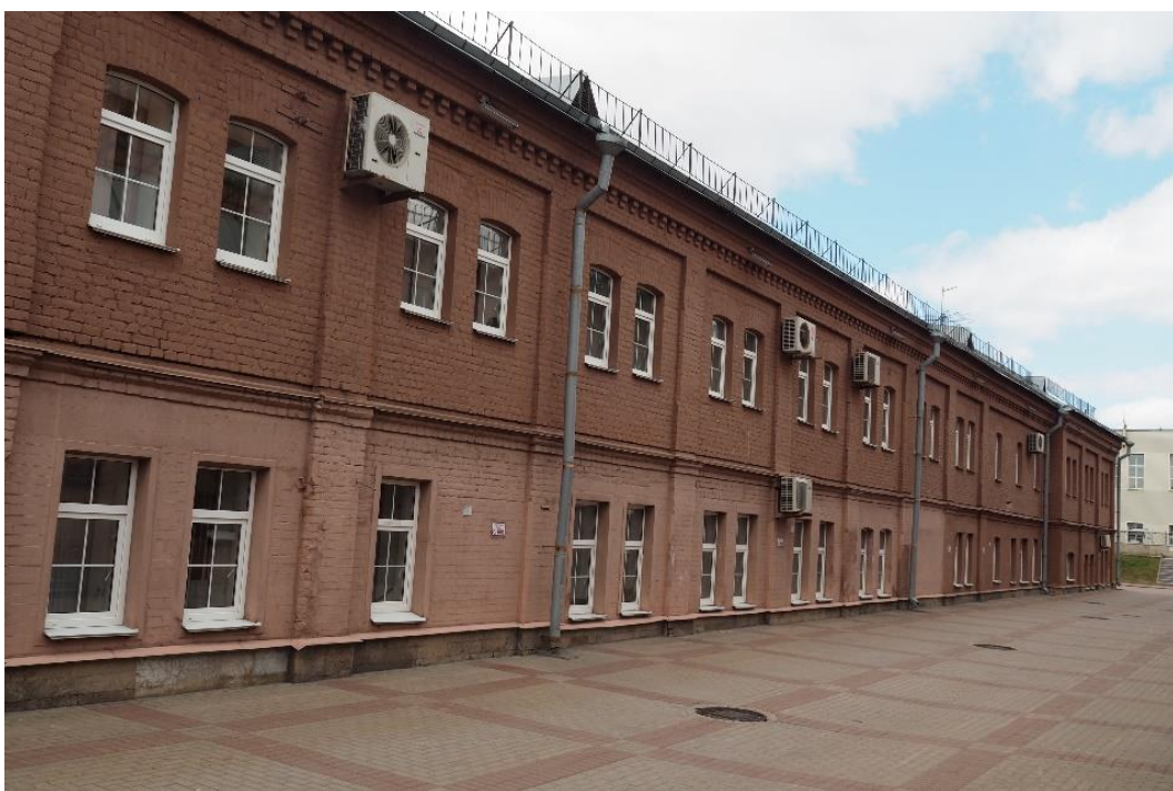
2. «Машинное отделение №3 с мастерскими и котельной и кладовые» в составе ансамбля «Комплекс главной станции Санкт-Петербургских городских водопроводов», ул. Шпалерная, д. 56, лит. АИ. Восточный фасад. Общий вид. Фото 08.08.2022г.
