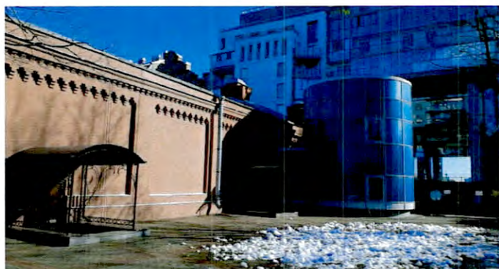
3. Южный фасад здания
