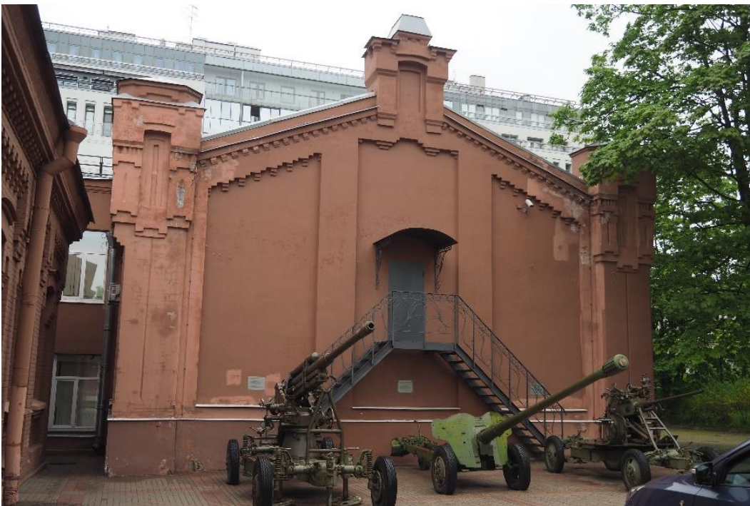
2. «Машинное отделение №6 с котельной» в составе ансамбля «Комплекс главной станции Санкт-Петербургских городских водопроводов», ул. Таврическая, д. 10, лит. А. Западный фасад. Общий вид. Фото 08.08.2022г.
