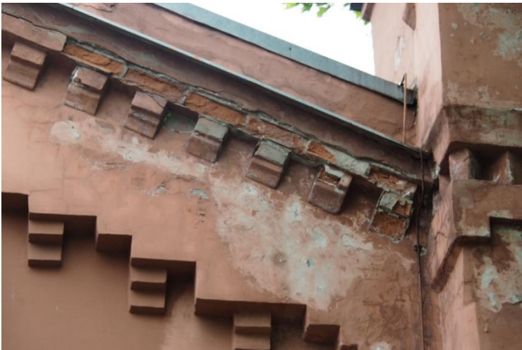
17. «Машинное отделение №6 с котельной» в составе ансамбля «Комплекс главной станции Санкт-Петербургских городских водопроводов», ул. Таврическая, д. 10, лит. А. Западный фасад. Фрагмент. Фото 08.08.2022г.
