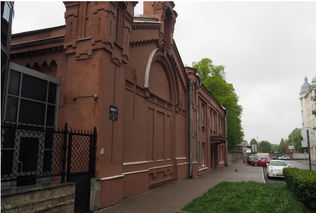
1. «Машинное отделение №6 с котельной» в составе ансамбля «Комплекс главной станции Санкт-Петербургских городских водопроводов», ул. Таврическая, д. 10, лит. А. Восточный фасад. Общий вид. Фото 08.08.2022г.
