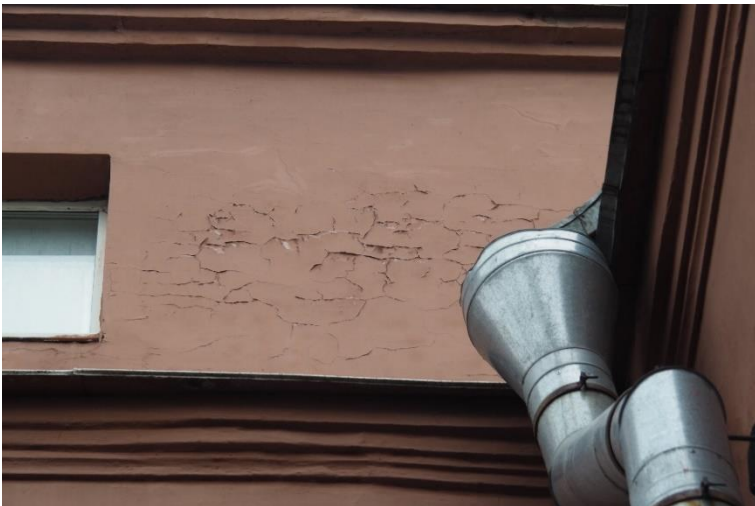
26. «Машинное отделение №6 с котельной» в составе ансамбля «Комплекс главной станции Санкт-Петербургских городских водопроводов», ул. Таврическая, д. 10, лит. А. Южный фасад. Фрагмент. Фото 08.08.2022г.
