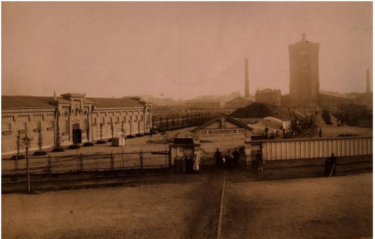
Илл. 7. Общий вид на станцию. кон. 1890-х гг.
