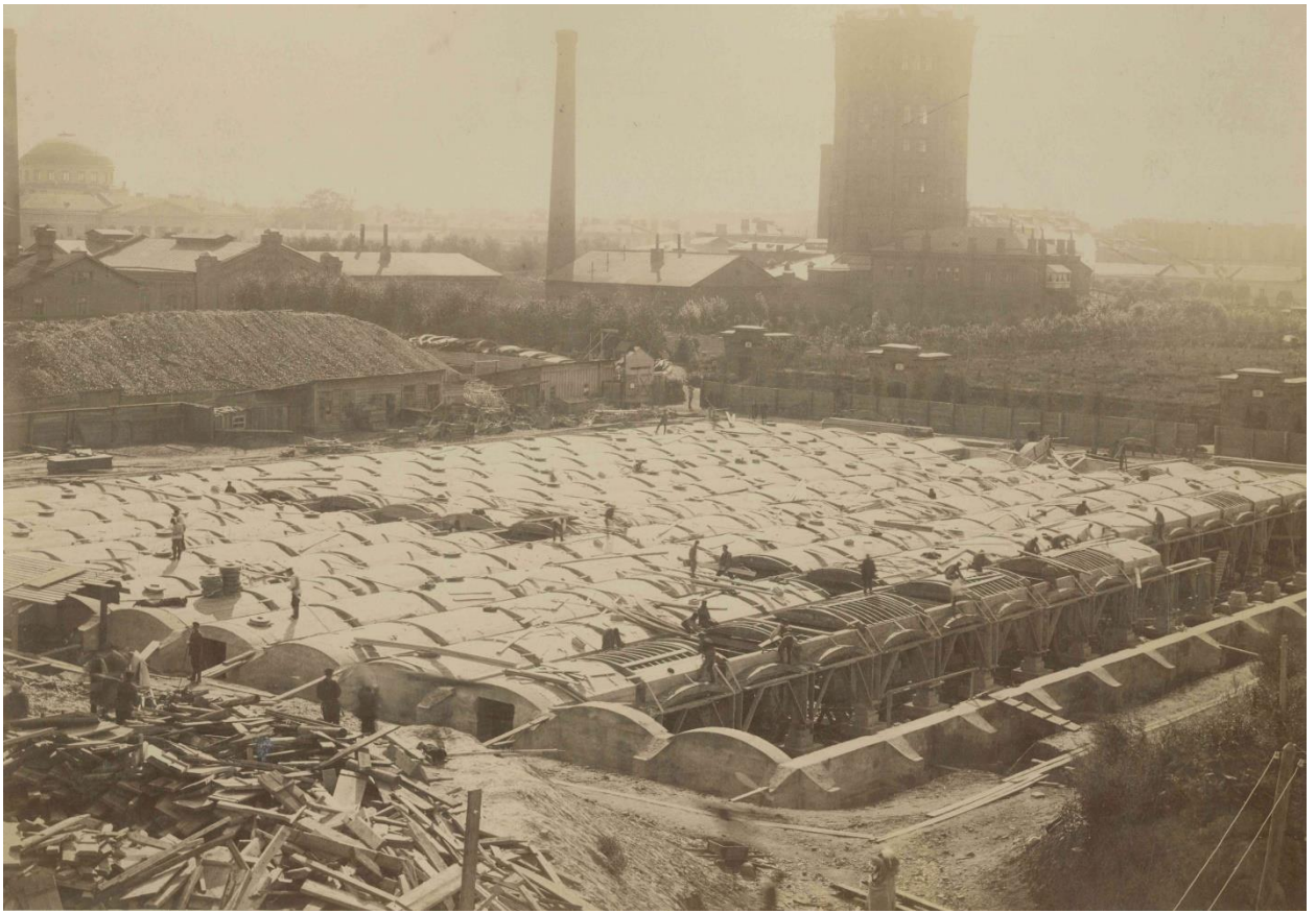
Илл. 5. Строительство фильтров. кон. 1880-х гг.
