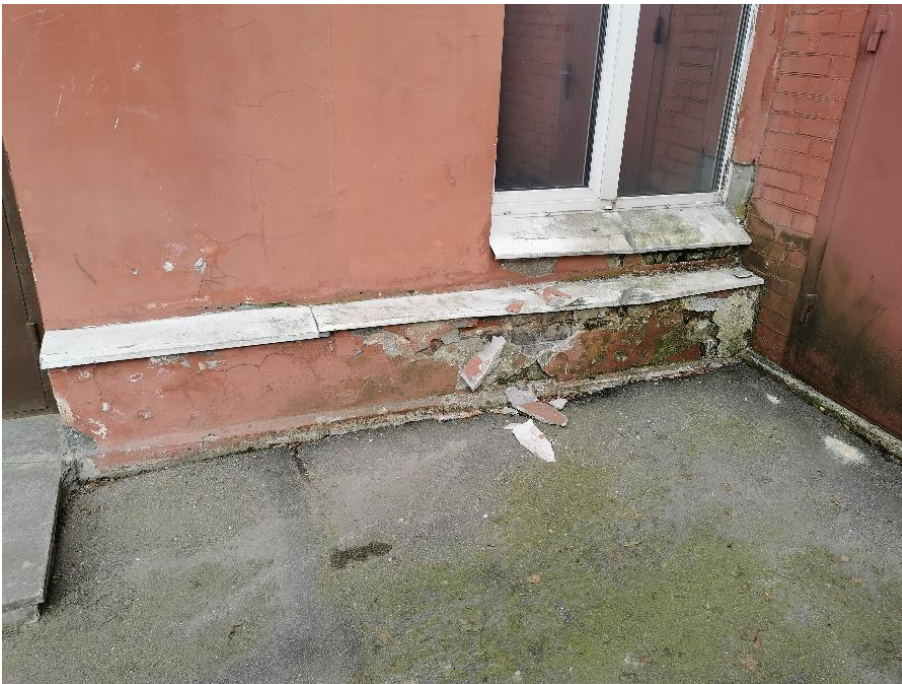
34. «Машинное отделение №6 с котельной» в составе ансамбля «Комплекс главной станции Санкт-Петербургских городских водопроводов», ул. Таврическая, д. 10, лит. А. Северный фасад. Фрагмент. Фото 08.08.2022г.
