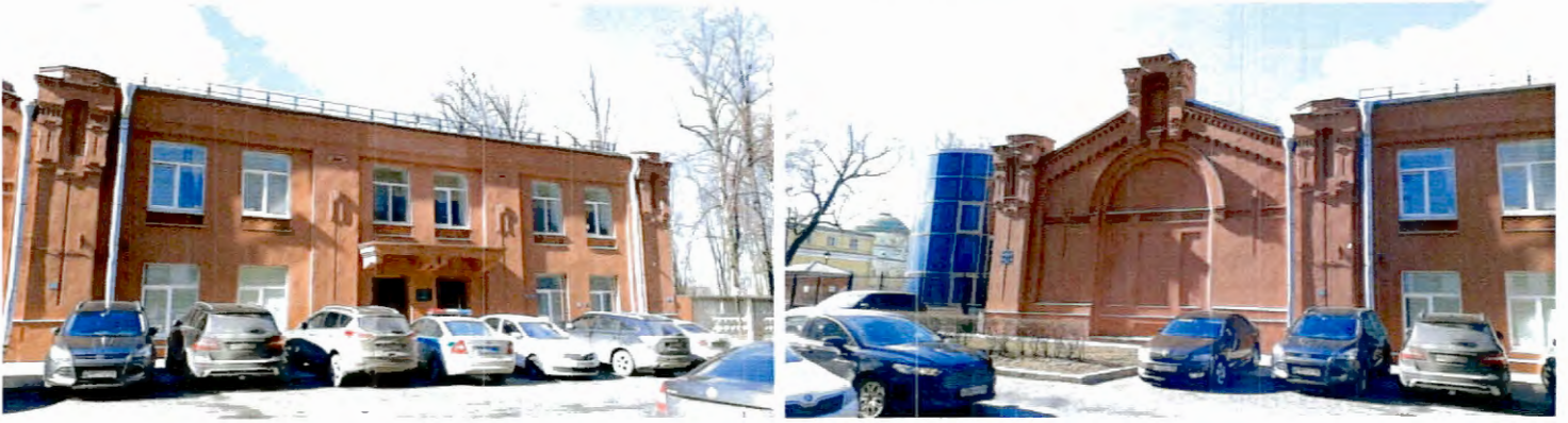
8, 9. Восточный фасад здания
