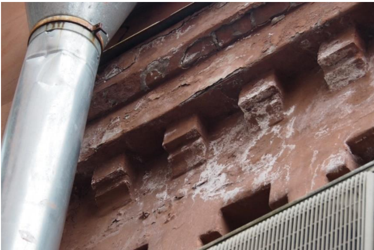
21. «Машинное отделение №6 с котельной» в составе ансамбля «Комплекс главной станции Санкт-Петербургских городских водопроводов», ул. Таврическая, д. 10, лит. А. Западный фасад. Фрагмент. Фото 08.08.2022г.
