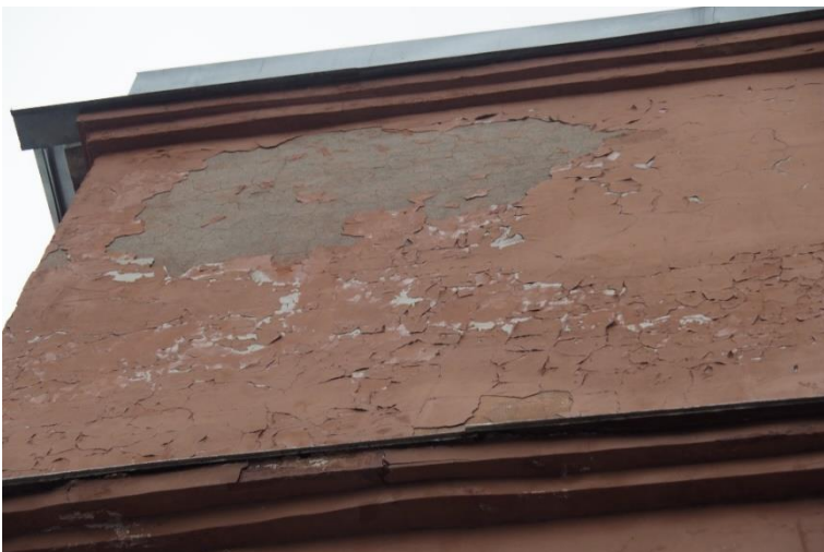
24. «Машинное отделение №6 с котельной» в составе ансамбля «Комплекс главной станции Санкт-Петербургских городских водопроводов», ул. Таврическая, д. 10, лит. А. Западный фасад. Фрагмент. Фото 08.08.2022г.
