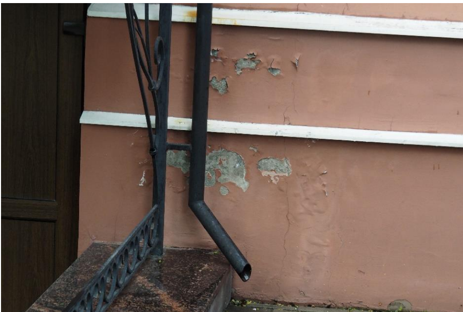
31. «Машинное отделение №6 с котельной» в составе ансамбля «Комплекс главной станции Санкт-Петербургских городских водопроводов», ул. Таврическая, д. 10, лит. А. Южный фасад. Фрагмент. Фото 08.08.2022г.
