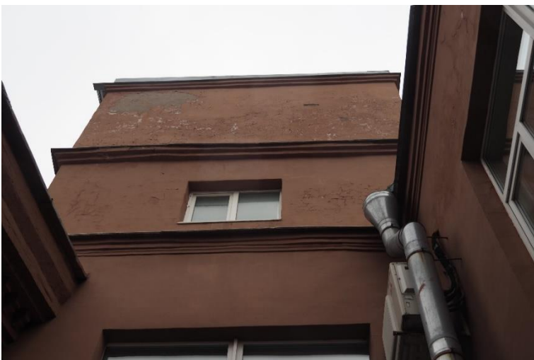
18. «Машинное отделение №6 с котельной» в составе ансамбля «Комплекс главной станции Санкт-Петербургских городских водопроводов», ул. Таврическая, д. 10, лит. А. Западный фасад. Фрагмент. Фото 08.08.2022г.
