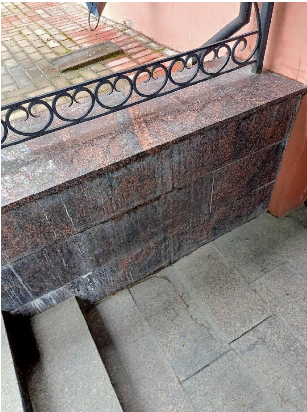
28. «Машинное отделение №6 с котельной» в составе ансамбля «Комплекс главной станции Санкт-Петербургских городских водопроводов», ул. Таврическая, д. 10, лит. А. Южный фасад. Фрагмент. Фото 08.08.2022г.
