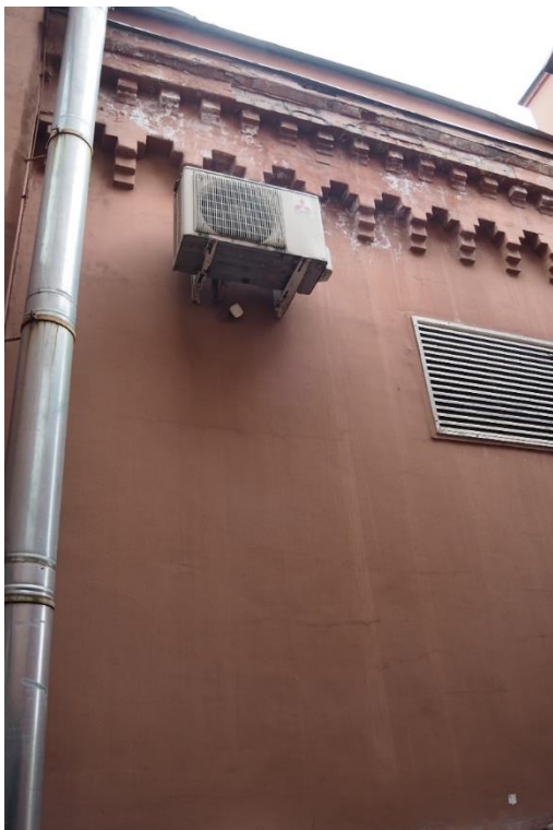
22. «Машинное отделение №6 с котельной» в составе ансамбля «Комплекс главной станции Санкт-Петербургских городских водопроводов», ул. Таврическая, д. 10, лит. А. Западный фасад. Фрагмент. Фото 08.08.2022г.
