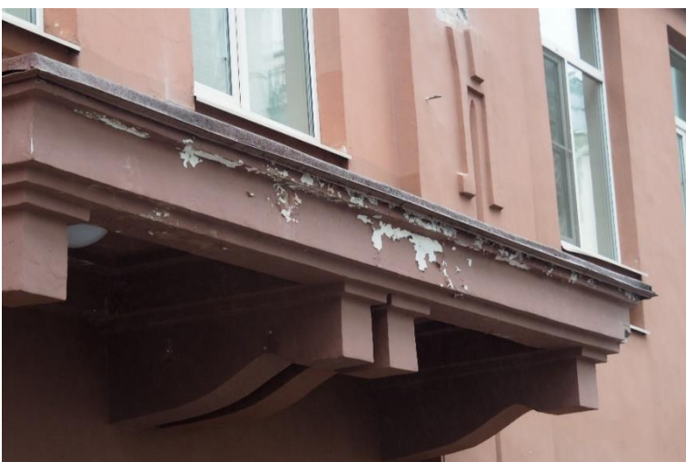
10. «Машинное отделение №6 с котельной» в составе ансамбля «Комплекс главной станции Санкт-Петербургских городских водопроводов», ул. Таврическая, д. 10, лит. А. Восточный фасад. Фрагмент. Фото 08.08.2022г.
