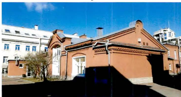
2. Восточный фасад здания
