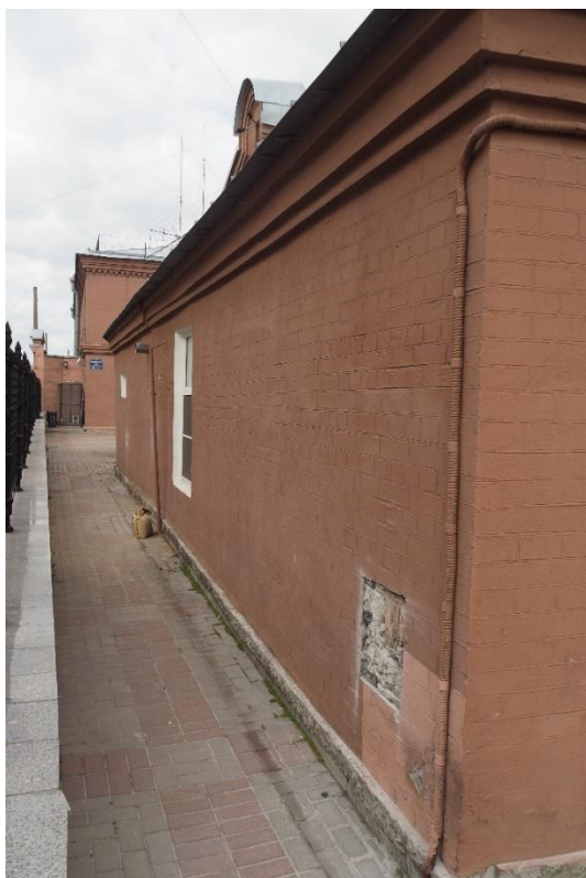
33. "Служебное здание" в составе ансамбля "Комплекс главной станции Санкт-Петербургских городских водопроводов", ул. Шпалерная, д. 56, лит. Р. Западный фасад. Фрагмент. Фото 08.08.2022г.
