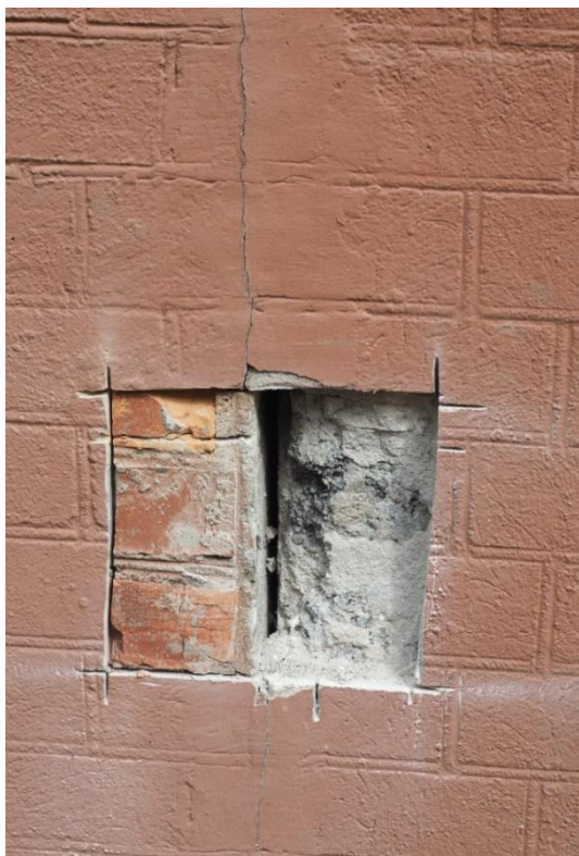
35. "Служебное здание" в составе ансамбля "Комплекс главной станции Санкт-Петербургских городских водопроводов", ул. Шпалерная, д. 56, лит. Р. Западный фасад. Фрагмент. Фото 08.08.2022г.
