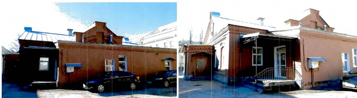
4,5. Северный фасад здания, металлические козырьки над крыльцами
