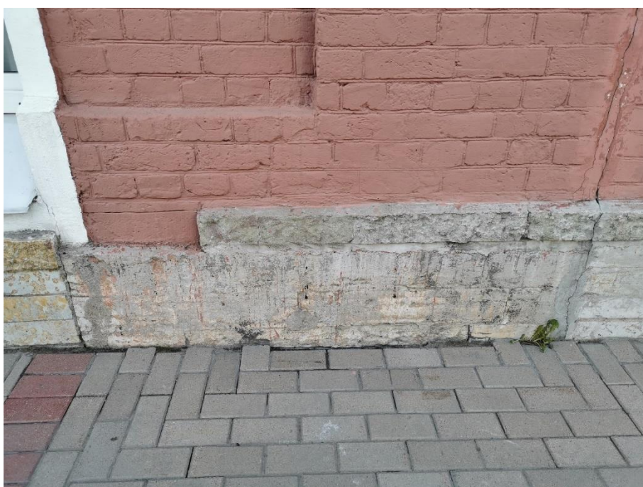
20. "Служебное здание" в составе ансамбля "Комплекс главной станции Санкт-Петербургских городских водопроводов", ул. Шпалерная, д. 56, лит. Р. Северный фасад. Фрагмент. Фото 08.08.2022г.
