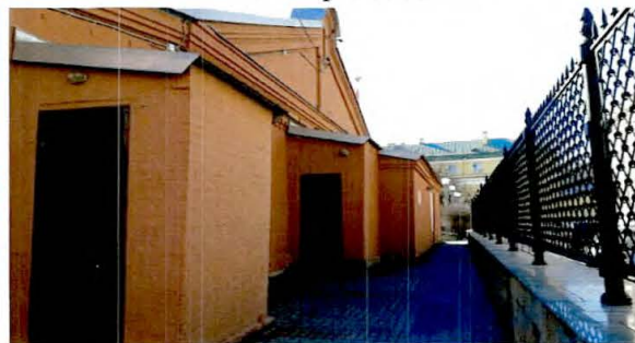
3. Западный фасад здания
