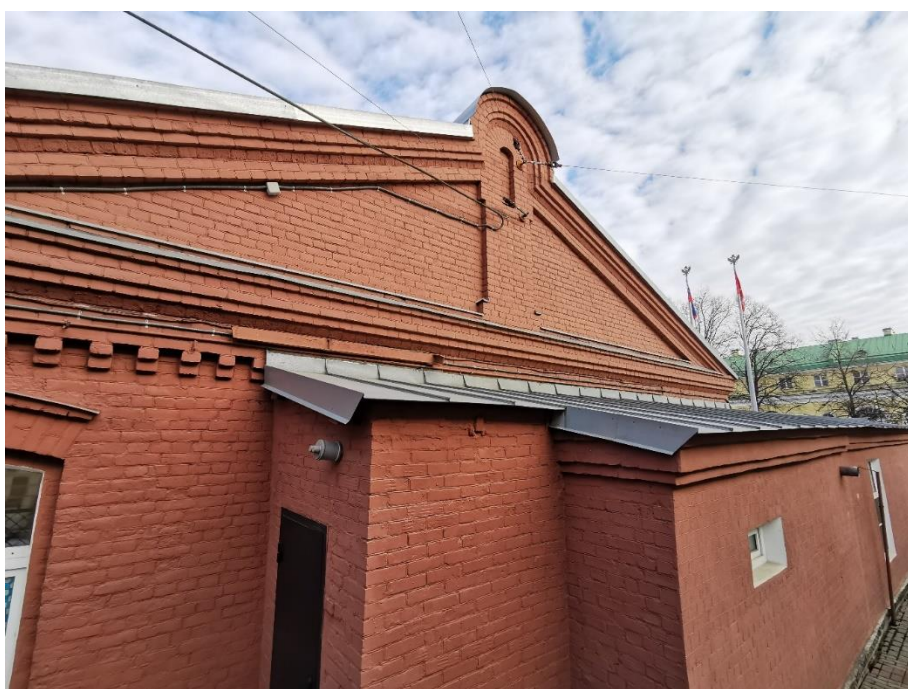
28. "Служебное здание" в составе ансамбля "Комплекс главной станции Санкт-Петербургских городских водопроводов", ул. Шпалерная, д. 56, лит. Р. Западный фасад. Фрагмент. Фото 08.08.2022г.
