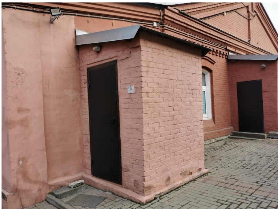
27. "Служебное здание" в составе ансамбля "Комплекс главной станции Санкт-Петербургских городских водопроводов", ул. Шпалерная, д. 56, лит. Р. Западный фасад. Фрагмент. Фото 08.08.2022г.
