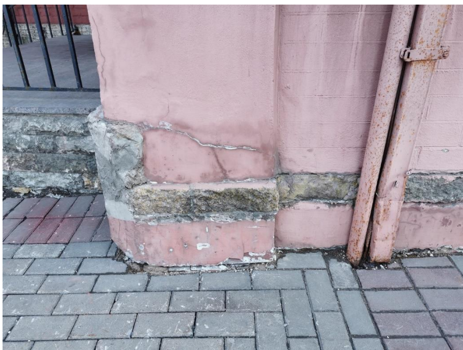
12. "Служебное здание" в составе ансамбля "Комплекс главной станции Санкт-Петербургских городских водопроводов", ул. Шпалерная, д. 56, лит. Р. Северный фасад. Фрагмент. Фото 08.08.2022г.
