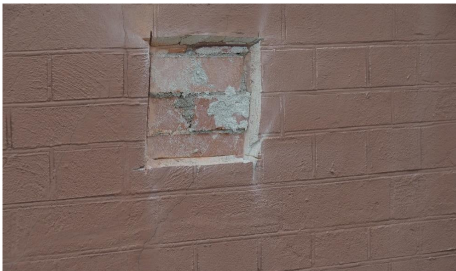
32. "Служебное здание" в составе ансамбля "Комплекс главной станции Санкт-Петербургских городских водопроводов", ул. Шпалерная, д. 56, лит. Р. Западный фасад. Фрагмент. Фото 08.08.2022г.
