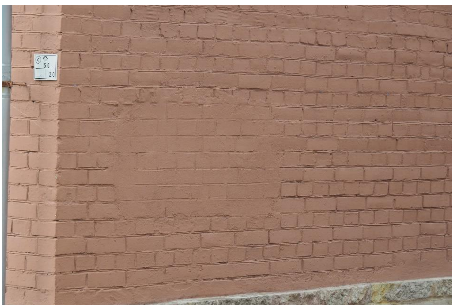
10. "Служебное здание" в составе ансамбля "Комплекс главной станции Санкт-Петербургских городских водопроводов", ул. Шпалерная, д. 56, лит. Р. Северный фасад. Фрагмент. Фото 08.08.2022г.
