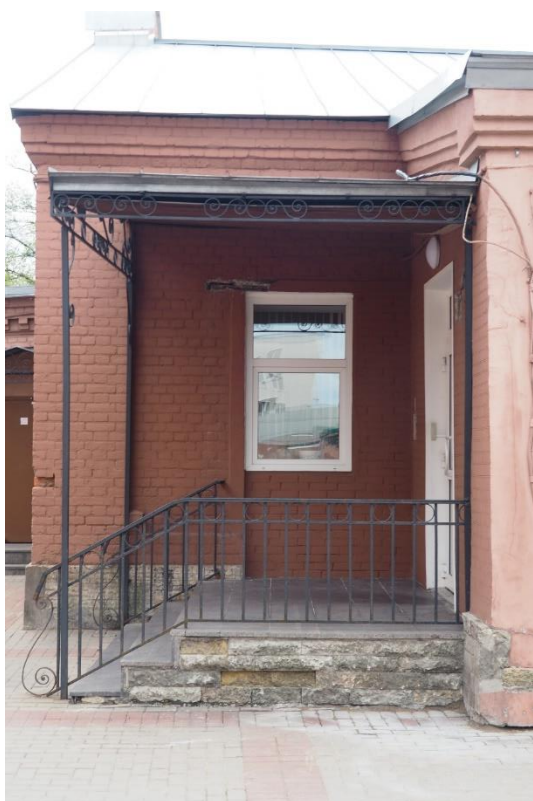
8. "Служебное здание" в составе ансамбля "Комплекс главной станции Санкт-Петербургских городских водопроводов", ул. Шпалерная, д. 56, лит. Р. Северный фасад. Фрагмент. Фото 08.08.2022г.
