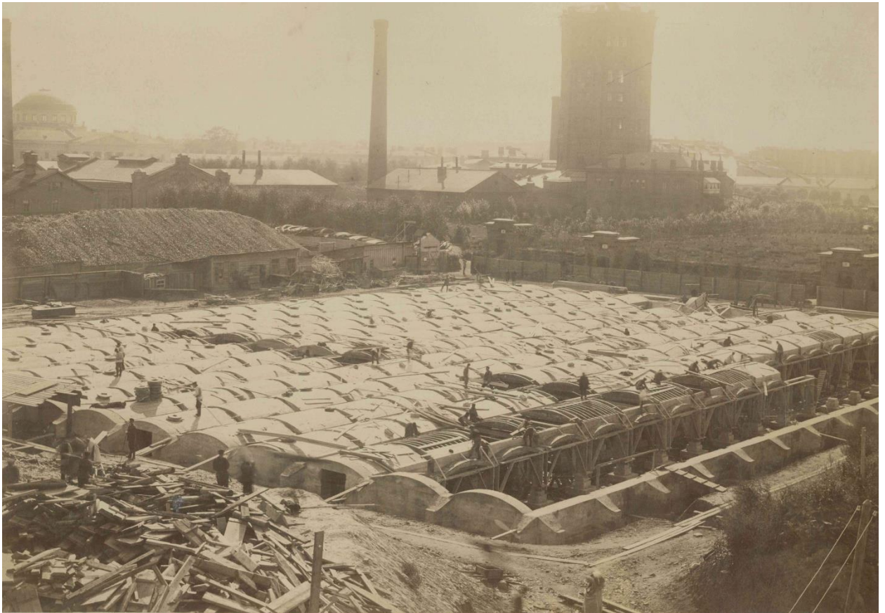
Илл. 7. Строительство фильтров. кон. 1880-х гг.
