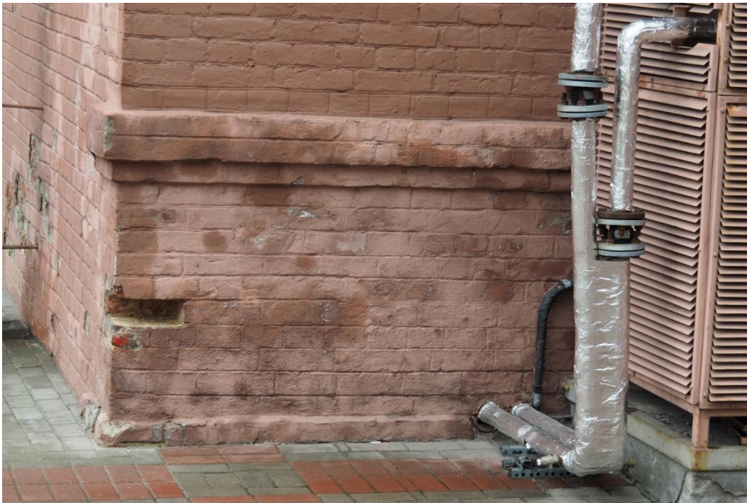
27. «Машинное отделение №3 с мастерскими и котельной и кладовые» в составе ансамбля «Комплекс главной станции Санкт-Петербургских городских водопроводов», ул. Шпалерная, д. 56, лит. АК. Западный фасад. Фрагмент. Фото 08.08.2022г.
