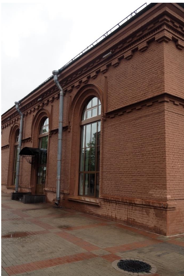
18. «Машинное отделение №3 с мастерскими и котельной и кладовые» в составе ансамбля «Комплекс главной станции Санкт-Петербургских городских водопроводов», ул. Шпалерная, д. 56, лит. АК. Восточный фасад. Фрагмент. Фото 08.08.2022г.
