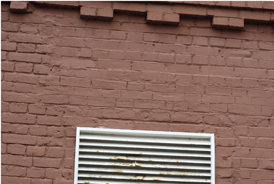
12. «Машинное отделение №3 с мастерскими и котельной и кладовые» в составе ансамбля «Комплекс главной станции Санкт-Петербургских городских водопроводов», ул. Шпалерная, д. 56, лит. АК. Восточный фасад. Фрагмент. Фото 08.08.2022г.
