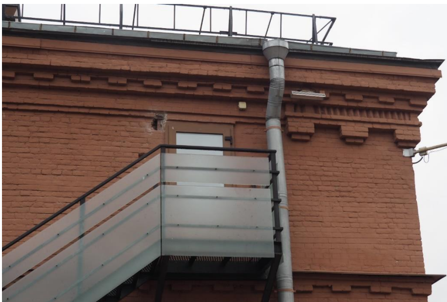
25. «Машинное отделение №3 с мастерскими и котельной и кладовые» в составе ансамбля «Комплекс главной станции Санкт-Петербургских городских водопроводов», ул. Шпалерная, д. 56, лит. АК. Северный фасад. Фрагмент. Фото 08.08.2022г.
