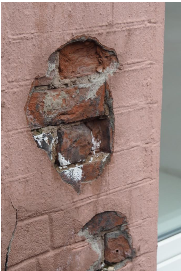
35. «Машинное отделение №3 с мастерскими и котельной и кладовые» в составе ансамбля «Комплекс главной станции Санкт-Петербургских городских водопроводов», ул. Шпалерная, д. 56, лит. АК. Западный фасад. Фрагмент. Фото 08.08.2022г.
