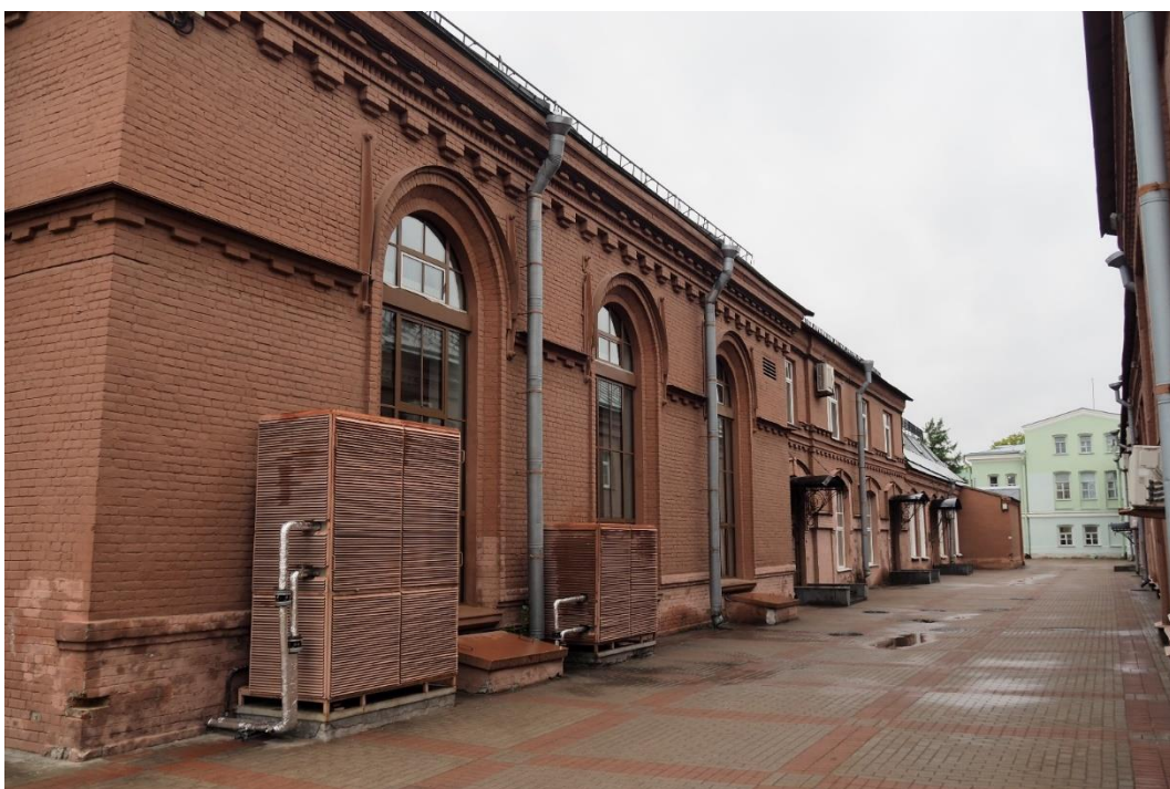
4. «Машинное отделение №3 с мастерскими и котельной и кладовые» в составе ансамбля «Комплекс главной станции Санкт-Петербургских городских водопроводов», ул. Шпалерная, д. 56, лит. АК. Западный фасад. Общий вид. Фото 08.08.2022г.
