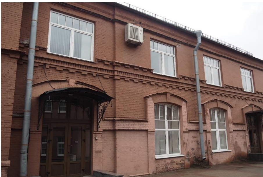
31. «Машинное отделение №3 с мастерскими и котельной и кладовые» в составе ансамбля «Комплекс главной станции Санкт-Петербургских городских водопроводов», ул. Шпалерная, д. 56, лит. АК. Западный фасад. Фрагмент. Фото 08.08.2022г.
