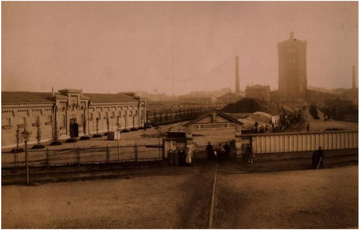
Илл. 8. Общий вид на станцию. кон. 1890-х гг.
