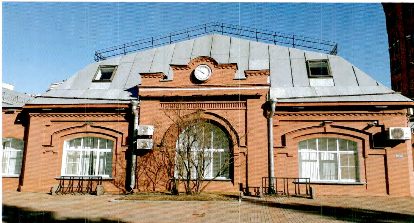
3. Южный фасад здания
