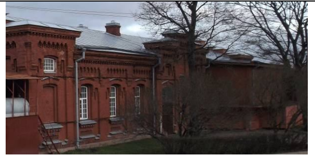
Южный фасад юго-западного корпуса
