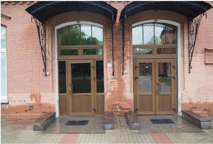
11. «Машинное отделение №3 с мастерскими и котельной и кладовые» в составе ансамбля «Комплекс главной станции Санкт-Петербургских городских водопроводов», ул. Шпалерная, д. 56, лит. АК. Восточный фасад. Фрагмент. Фото 08.08.2022г.
