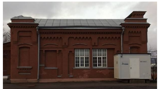
Восточный фасад северо-восточного корпуса
