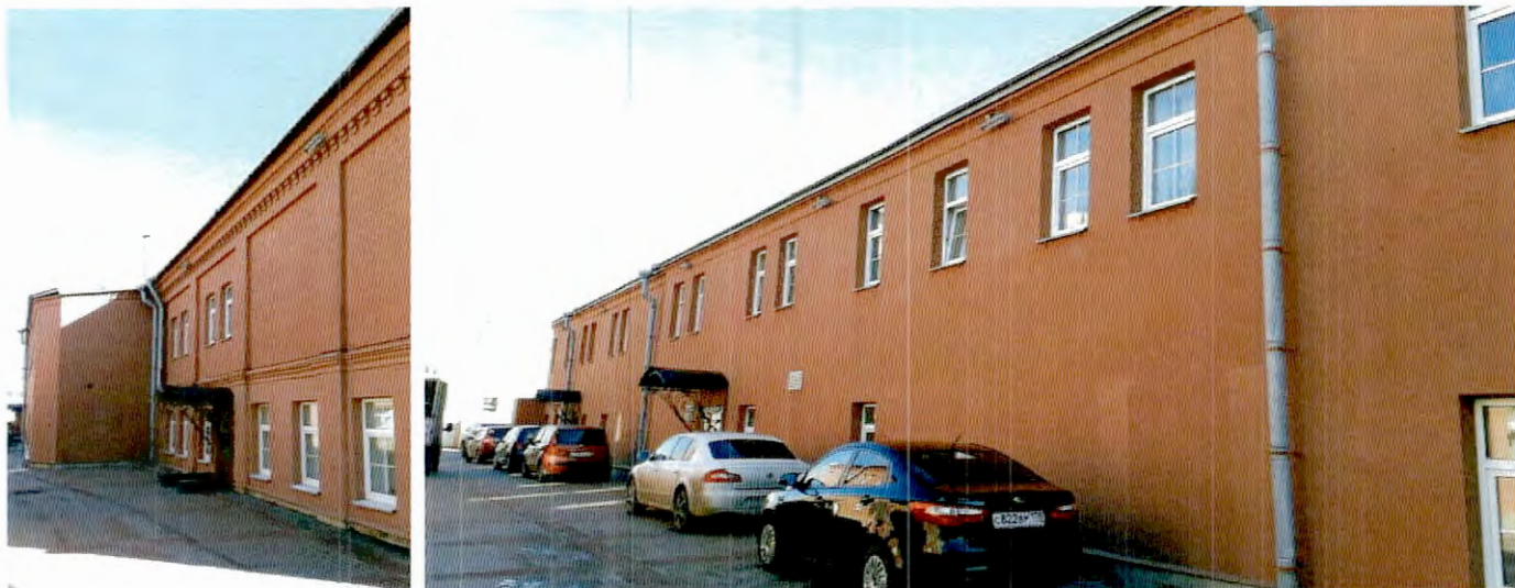
3,4. Западный фасад здания
