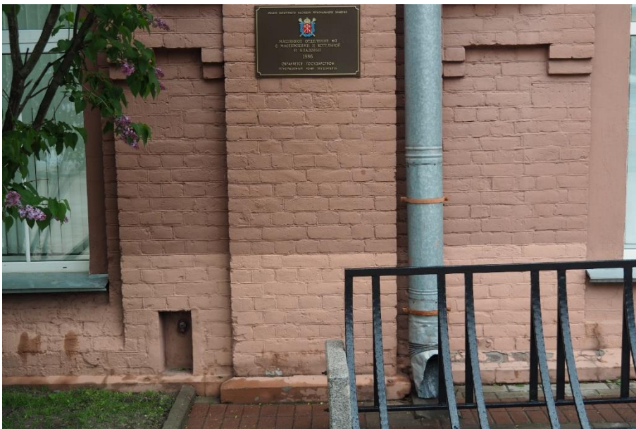
44. «Машинное отделение №3 с мастерскими и котельной и кладовые» в составе ансамбля «Комплекс главной станции Санкт-Петербургских городских водопроводов», ул. Шпалерная, д. 56, лит. АК. Южный фасад. Фрагмент. Фото 08.08.2022г.
