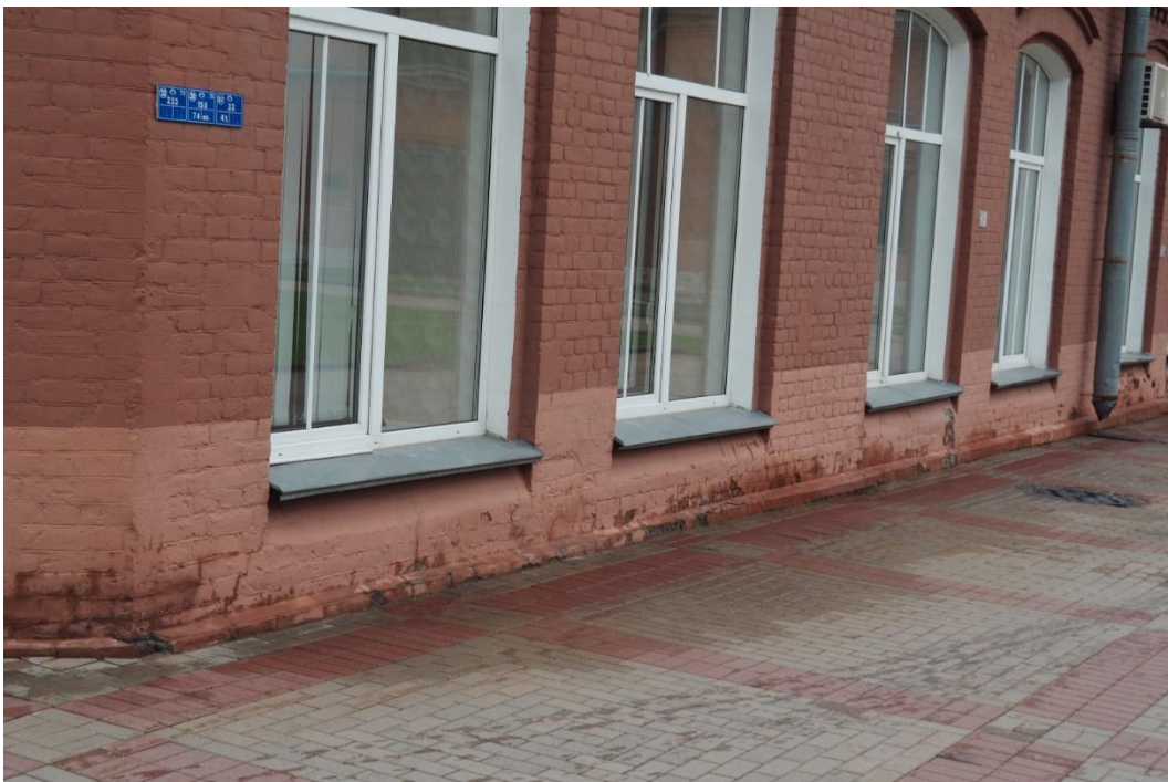
46. «Машинное отделение №3 с мастерскими и котельной и кладовые» в составе ансамбля «Комплекс главной станции Санкт-Петербургских городских водопроводов», ул. Шпалерная, д. 56, лит. АК. Южный фасад. Фрагмент. Фото 08.08.2022г.
