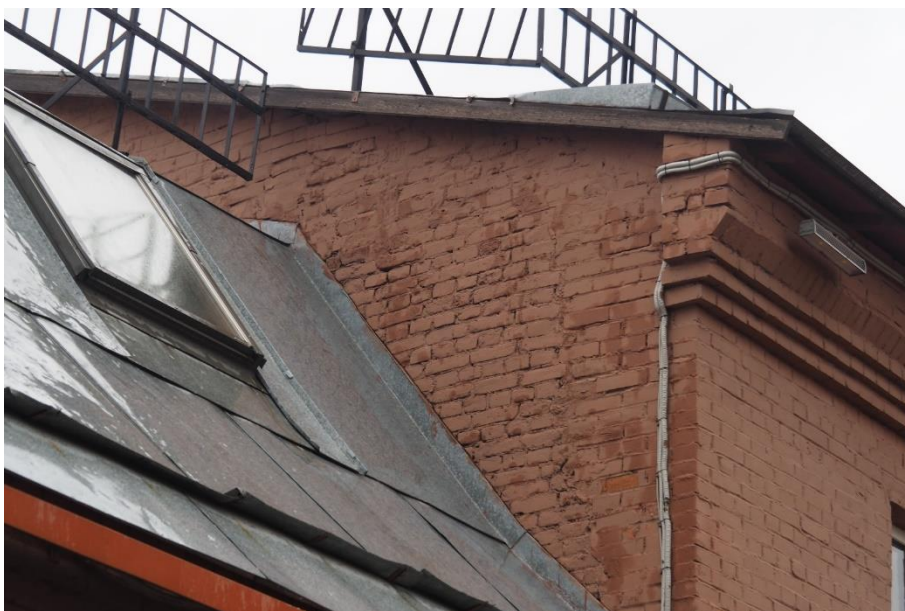
10. «Машинное отделение №3 с мастерскими и котельной и кладовые» в составе ансамбля «Комплекс главной станции Санкт-Петербургских городских водопроводов», ул. Шпалерная, д. 56, лит. АК. Восточный фасад. Фрагмент. Фото 08.08.2022г.
