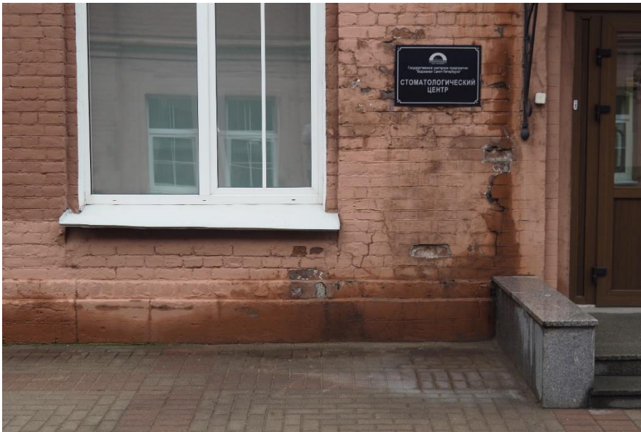
37. «Машинное отделение №3 с мастерскими и котельной и кладовые» в составе ансамбля «Комплекс главной станции Санкт-Петербургских городских водопроводов», ул. Шпалерная, д. 56, лит. АК. Западный фасад. Фрагмент. Фото 08.08.2022г.
