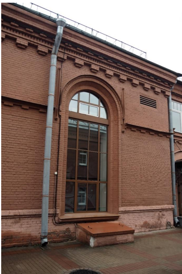
29. «Машинное отделение №3 с мастерскими и котельной и кладовые» в составе ансамбля «Комплекс главной станции Санкт-Петербургских городских водопроводов», ул. Шпалерная, д. 56, лит. АК. Западный фасад. Фрагмент. Фото 08.08.2022г.
