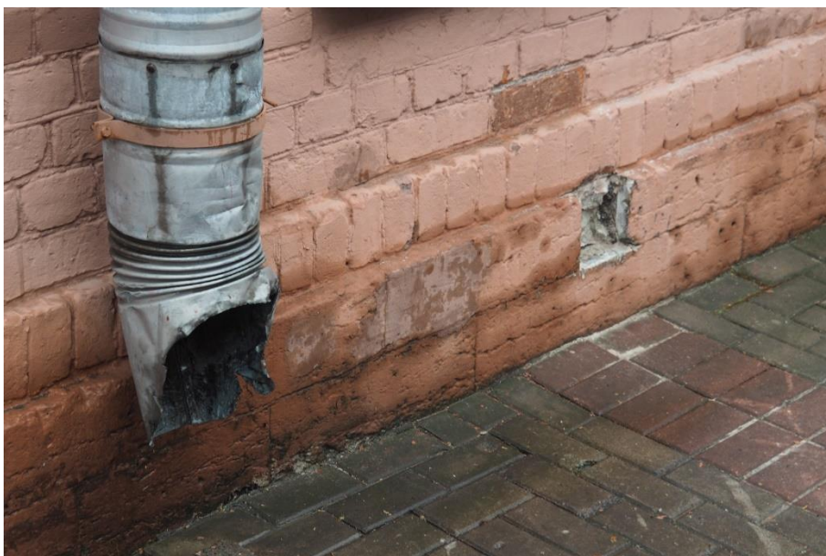
40. «Машинное отделение №3 с мастерскими и котельной и кладовые» в составе ансамбля «Комплекс главной станции Санкт-Петербургских городских водопроводов», ул. Шпалерная, д. 56, лит. АК. Западный фасад. Фрагмент. Фото 08.08.2022г.
