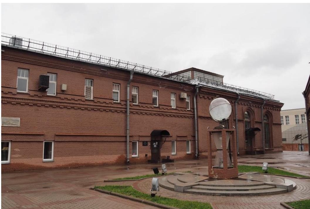
2. «Машинное отделение №3 с мастерскими и котельной и кладовые» в составе ансамбля «Комплекс главной станции Санкт-Петербургских городских водопроводов», ул. Шпалерная, д. 56, лит. АК. Восточный фасад. Общий вид. Фото 08.08.2022г.
