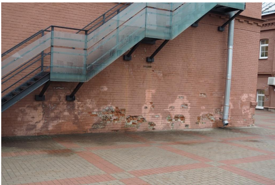
23. «Машинное отделение №3 с мастерскими и котельной и кладовые» в составе ансамбля «Комплекс главной станции Санкт-Петербургских городских водопроводов», ул. Шпалерная, д. 56, лит. АК. Северный фасад. Фрагмент. Фото 08.08.2022г.
