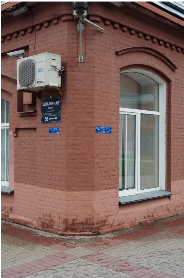
45. «Машинное отделение №3 с мастерскими и котельной и кладовые» в составе ансамбля «Комплекс главной станции Санкт-Петербургских городских водопроводов», ул. Шпалерная, д. 56, лит. АК. Южный фасад. Фрагмент. Фото 08.08.2022г.
