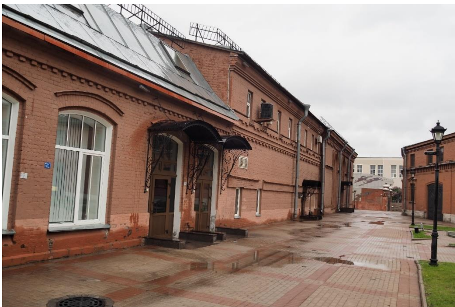
9. «Машинное отделение №3 с мастерскими и котельной и кладовые» в составе ансамбля «Комплекс главной станции Санкт-Петербургских городских водопроводов», ул. Шпалерная, д. 56, лит. АК. Восточный фасад. Фрагмент. Фото 08.08.2022г.
