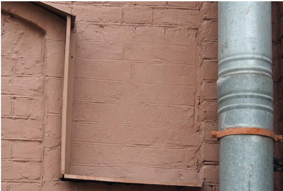
43. «Машинное отделение №3 с мастерскими и котельной и кладовые» в составе ансамбля «Комплекс главной станции Санкт-Петербургских городских водопроводов», ул. Шпалерная, д. 56, лит. АК. Южный фасад. Фрагмент. Фото 08.08.2022г.
