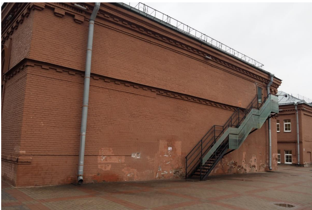
3. «Машинное отделение №3 с мастерскими и котельной и кладовые» в составе ансамбля «Комплекс главной станции Санкт-Петербургских городских водопроводов», ул. Шпалерная, д. 56, лит. АК. Северный фасад. Общий вид. Фото 08.08.2022г.
