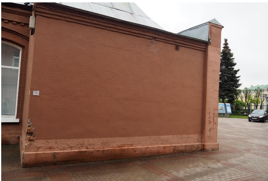
41. «Машинное отделение №3 с мастерскими и котельной и кладовые» в составе ансамбля «Комплекс главной станции Санкт-Петербургских городских водопроводов», ул. Шпалерная, д. 56, лит. АК. Западный фасад. Фрагмент. Фото 08.08.2022г.
