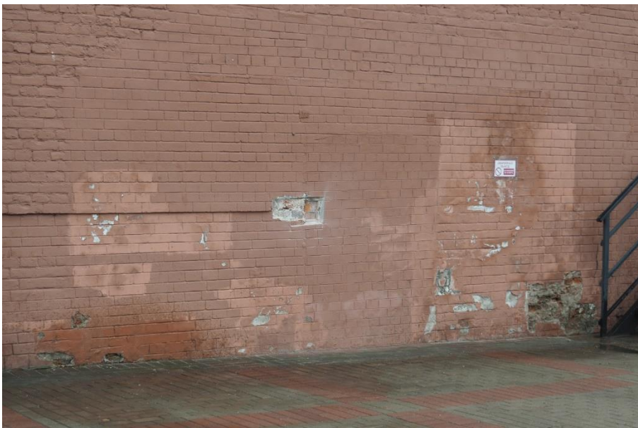
20. «Машинное отделение №3 с мастерскими и котельной и кладовые» в составе ансамбля «Комплекс главной станции Санкт-Петербургских городских водопроводов», ул. Шпалерная, д. 56, лит. АК. Северный фасад. Фрагмент. Фото 08.08.2022г.
