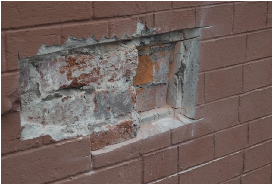
21. «Машинное отделение №3 с мастерскими и котельной и кладовые» в составе ансамбля «Комплекс главной станции Санкт-Петербургских городских водопроводов», ул. Шпалерная, д. 56, лит. АК. Северный фасад. Фрагмент. Фото 08.08.2022г.
