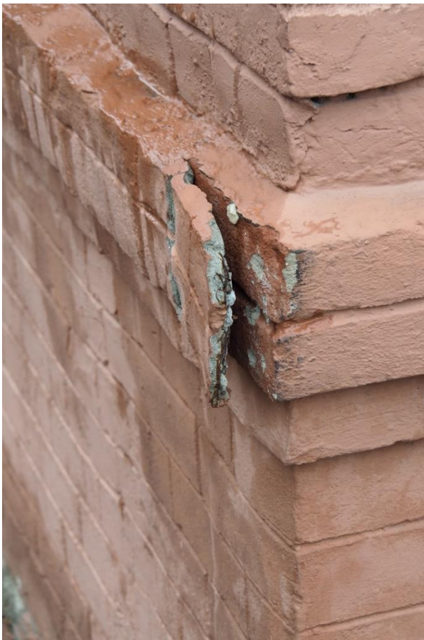
19. «Машинное отделение №3 с мастерскими и котельной и кладовые» в составе ансамбля «Комплекс главной станции Санкт-Петербургских городских водопроводов», ул. Шпалерная, д. 56, лит. АК. Восточный фасад. Фрагмент. Фото 08.08.2022г.
