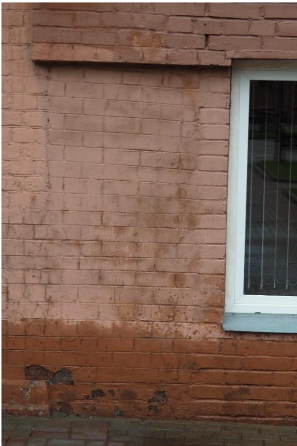
8. «Машинное отделение №3 с мастерскими и котельной и кладовые» в составе ансамбля «Комплекс главной станции Санкт-Петербургских городских водопроводов», ул. Шпалерная, д. 56, лит. АК. Восточный фасад. Фрагмент. Фото 08.08.2022г.
