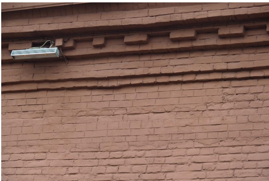
26. «Машинное отделение №3 с мастерскими и котельной и кладовые» в составе ансамбля «Комплекс главной станции Санкт-Петербургских городских водопроводов», ул. Шпалерная, д. 56, лит. АК. Северный фасад. Фрагмент. Фото 08.08.2022г.
