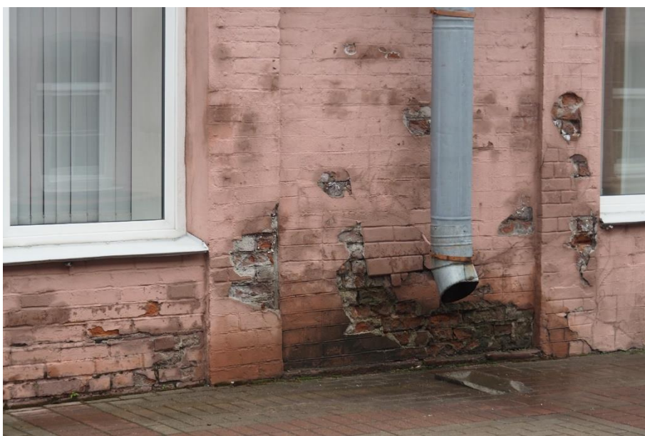
32. «Машинное отделение №3 с мастерскими и котельной и кладовые» в составе ансамбля «Комплекс главной станции Санкт-Петербургских городских водопроводов», ул. Шпалерная, д. 56, лит. АК. Западный фасад. Фрагмент. Фото 08.08.2022г.
