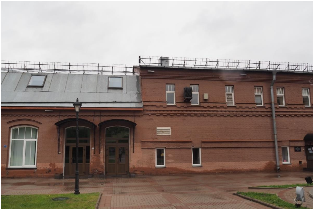
6. «Машинное отделение №3 с мастерскими и котельной и кладовые» в составе ансамбля «Комплекс главной станции Санкт-Петербургских городских водопроводов», ул. Шпалерная, д. 56, лит. АК. Восточный фасад. Фрагмент. Фото 08.08.2022г.
