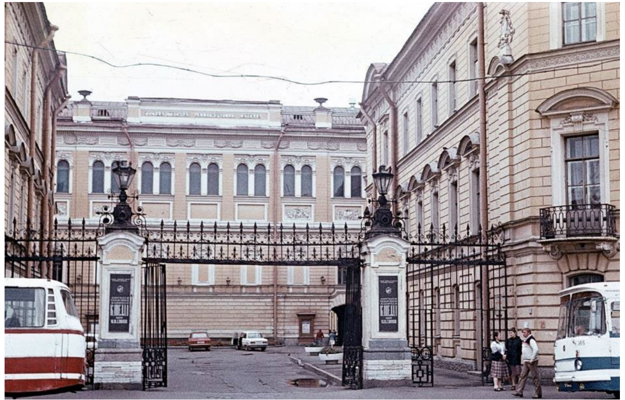
14. Вид на главный фасад капеллы, 1985 г.
