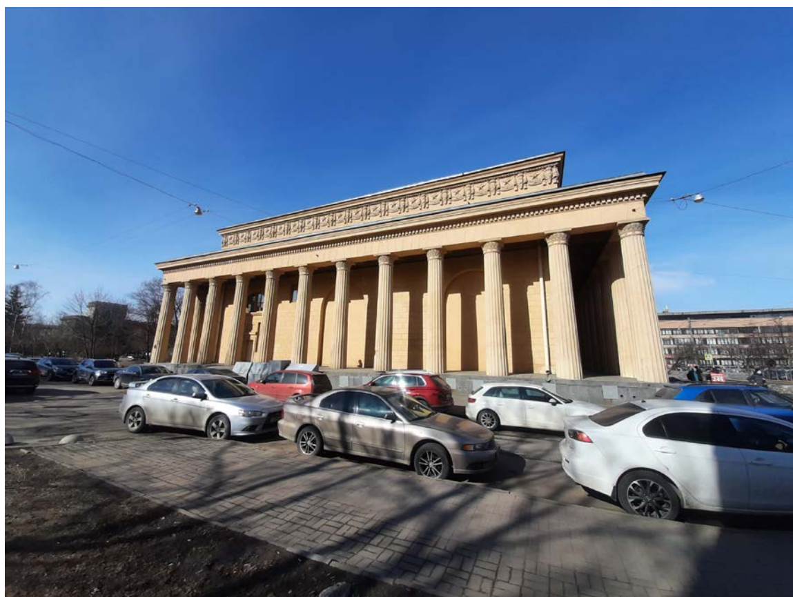
Фото 2 Задний фасад объекта культурного наследия регионального значения «Станция метро «Кировский завод», г. Санкт-Петербург, пр. Стачек, д. 70, литера А.
