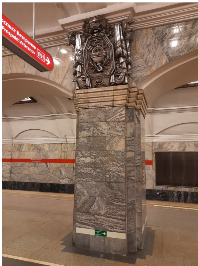
Фото 27 Фрагмент интерьера объекта культурного наследия регионального значения «Станция метро «Кировский завод», г. Санкт-Петербург, пр. Стачек, д. 70, литера А. (перронный зал)
