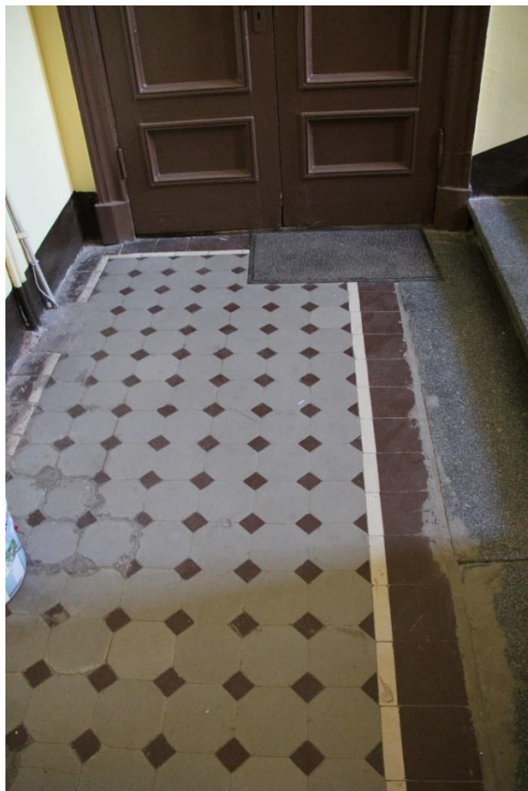
Фото 19. Покрытие пола лестничной площадки парадной лестницы
