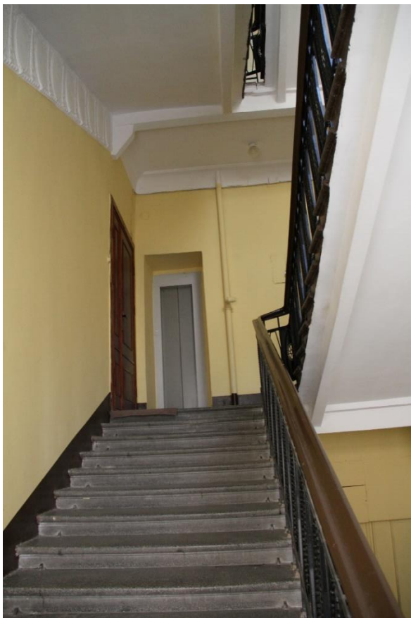
Фото 14. Интерьер парадной лестницы со стороны ул. Графтио.
