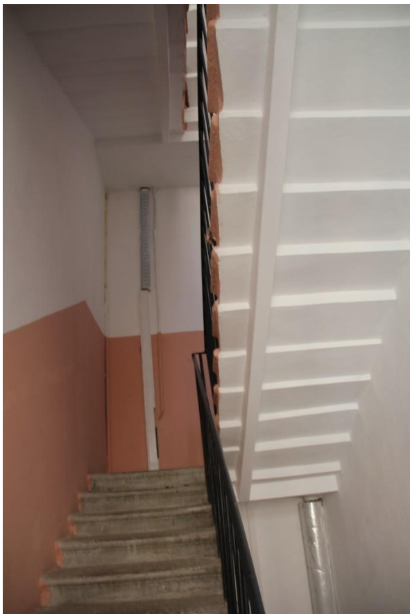
Фото 59. Интерьер служебной лестницы 4 ЛК.
