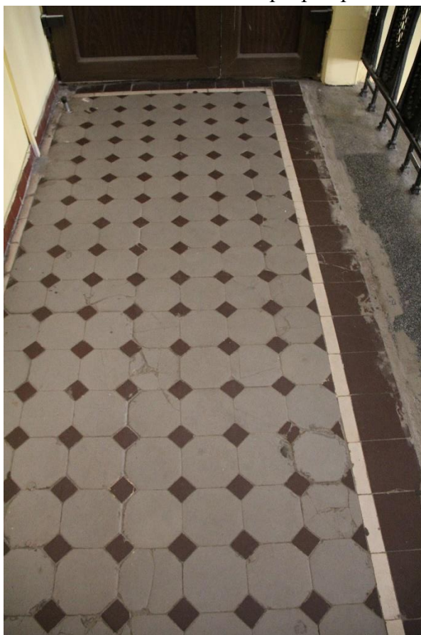
Фото 22. Покрытие пола лестничной площадки парадной лестницы
