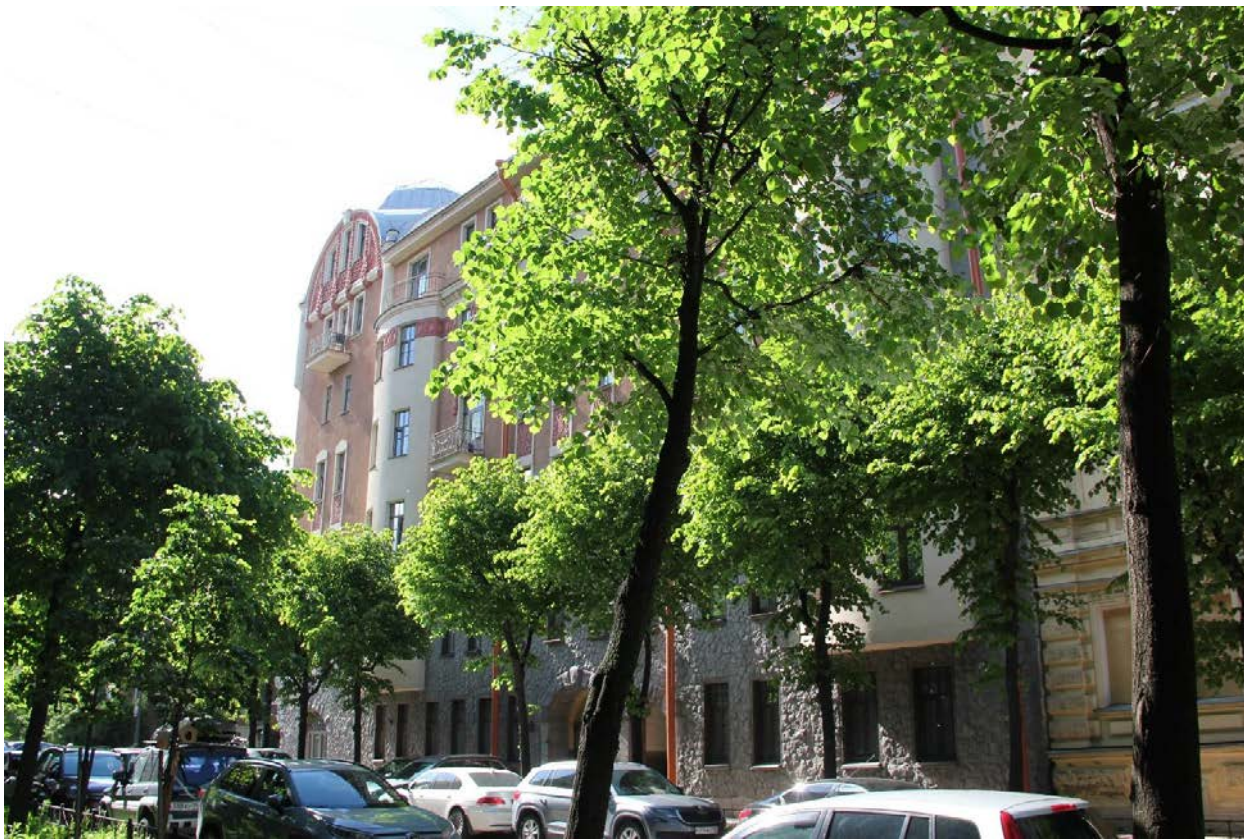
Фото 5. Южный фасад исследуемого объекта со стороны ул. Графтио.
