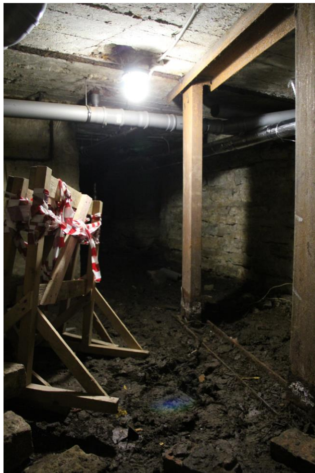
Фото 2. Вид на подвальное помещение в юго-западной части здания.
