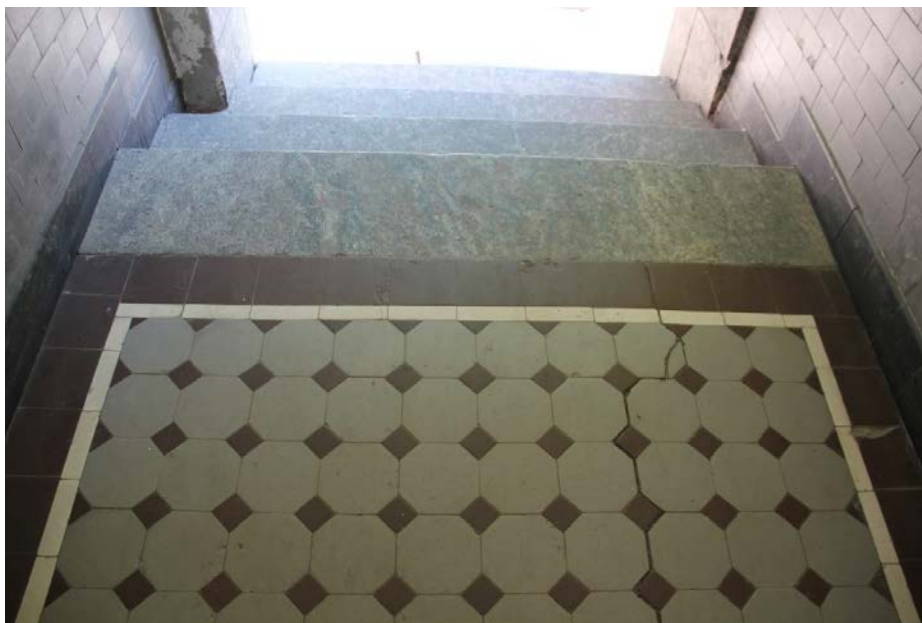
Фото 24. Покрытие пола входной группы со стороны Каменноостровского пр.
