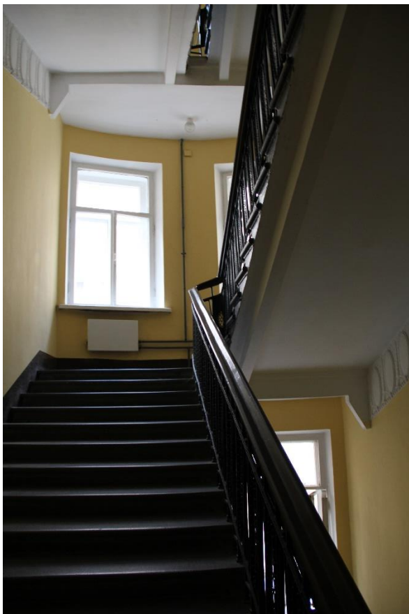
Фото 10. Интерьер парадной лестницы со стороны ул. Графтио.
