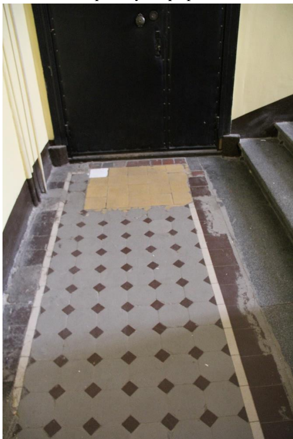
Фото 12. Покрытие пола лестничной площадки парадной лестницы
