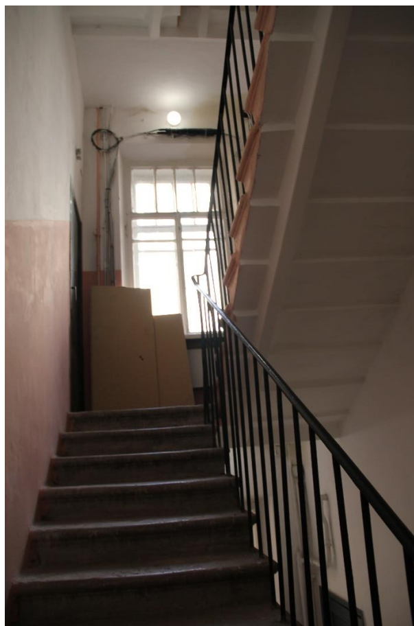
Фото 56. Интерьер служебной лестницы 4 ЛК.
