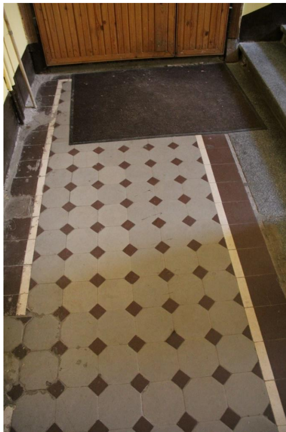
Фото 15. Покрытие пола лестничной площадки парадной лестницы
