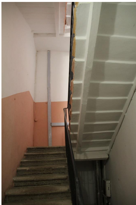
Фото 52. Интерьер служебной лестницы 4 ЛК.
