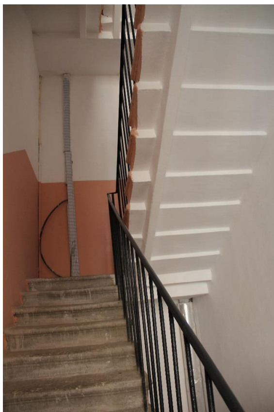
Фото 57. Интерьер служебной лестницы 4 ЛК.
