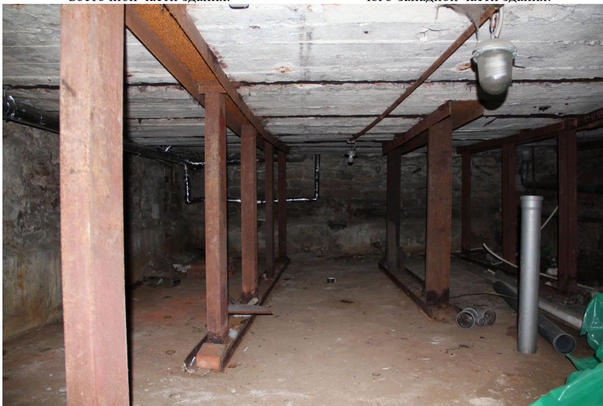
Фото 3. Вид на подвальное помещение в юго-западной части здания.
