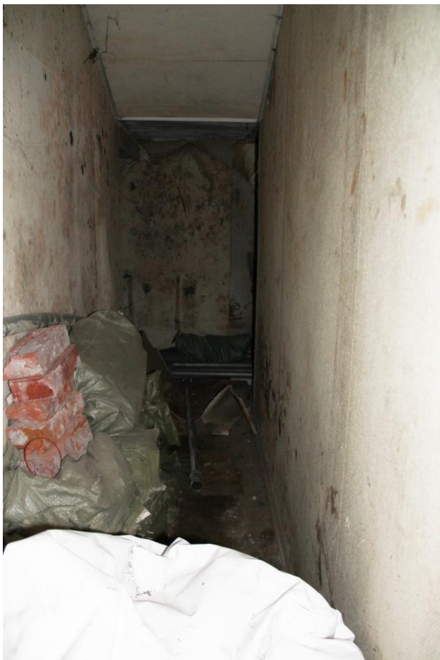
Фото 1. Вид на коридор в подвале в северо-восточной части здания.
