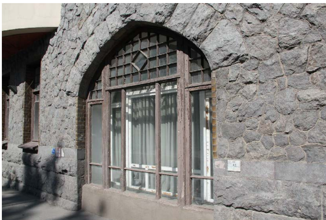
Фото 8. Фрагмент лицевого фасада со стороны Каменноостровского пр.
