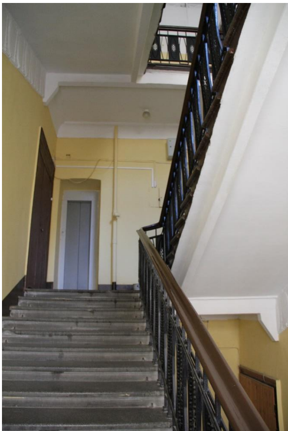
Фото 18. Интерьер парадной лестницы со стороны ул. Графтио.
