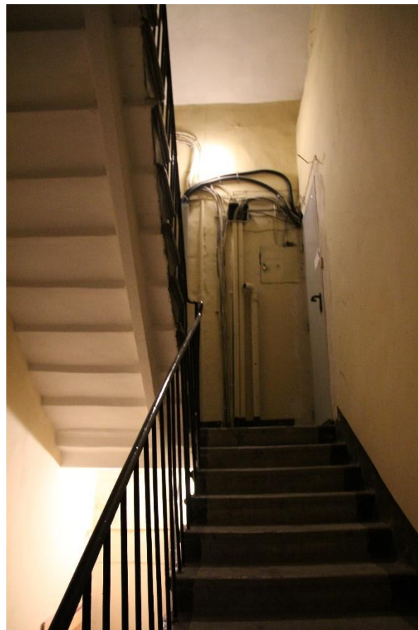
Фото 49. Интерьер служебной лестницы 3 ЛК.
