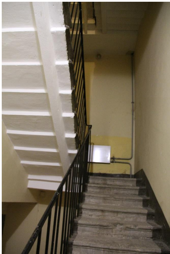
Фото 44. Интерьер служебной лестницы 3 ЛК.
