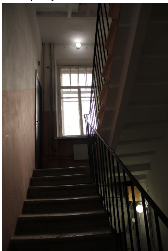
Фото 53. Интерьер служебной лестницы 4 ЛК.
