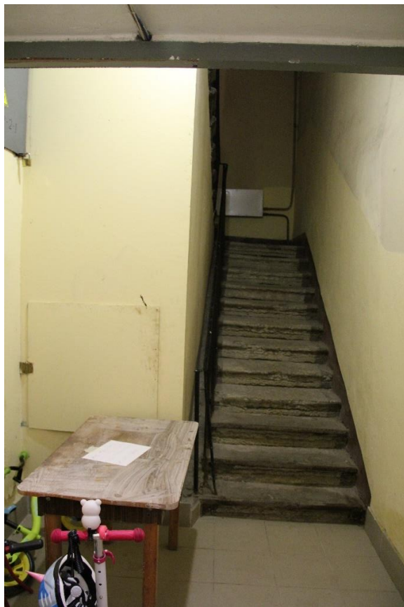
Фото 40. Интерьер служебной лестницы 3 ЛК.
