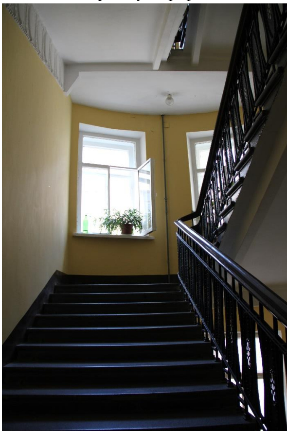
Фото 16. Интерьер парадной лестницы со стороны ул. Графтио.
