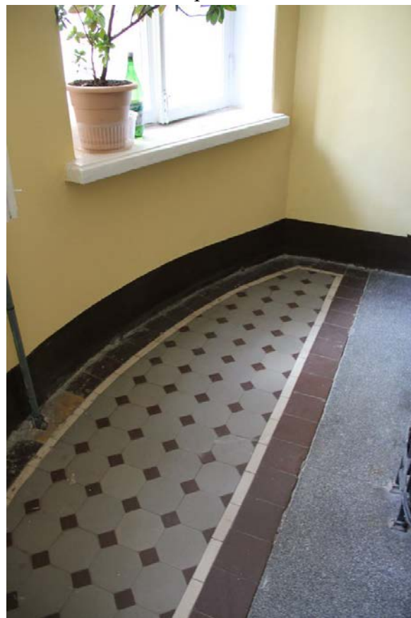
Фото 17. Покрытие пола лестничной площадки парадной лестницы
