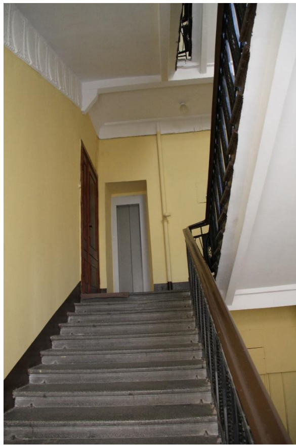
Фото 11. Интерьер парадной лестницы со стороны ул. Графтио.
