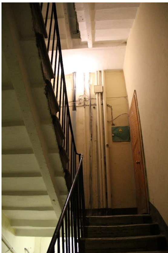
Фото 42. Интерьер служебной лестницы 3 ЛК.
