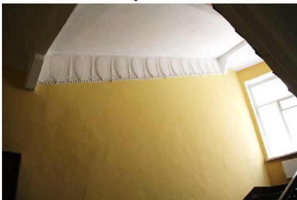
Фото 8. Интерьер парадной лестницы со стороны ул. Графтио.
