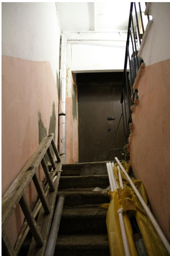
Фото 51. Спуск в подвал и вид на входную дверь служебной лестницы 4 ЛК.
