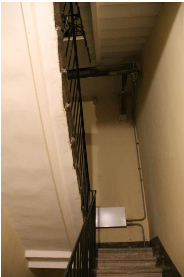
Фото 48. Интерьер служебной лестницы 3 ЛК.
