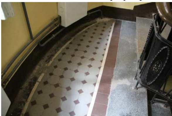
Фото 6. Покрытие пола лестничной площадки парадной лестницы
