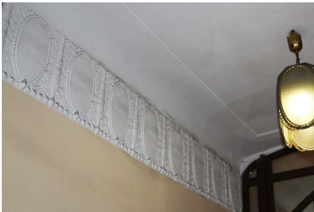
Фото 26. Оформление стен и потолка в пространстве парадной лестницы со стороны Каменноостровского пр.
