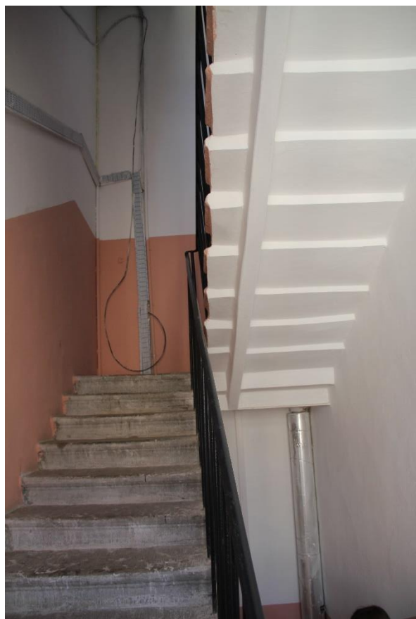
Фото 61. Интерьер служебной лестницы 4 ЛК.
