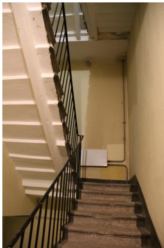
Фото 43. Интерьер служебной лестницы 3 ЛК.
