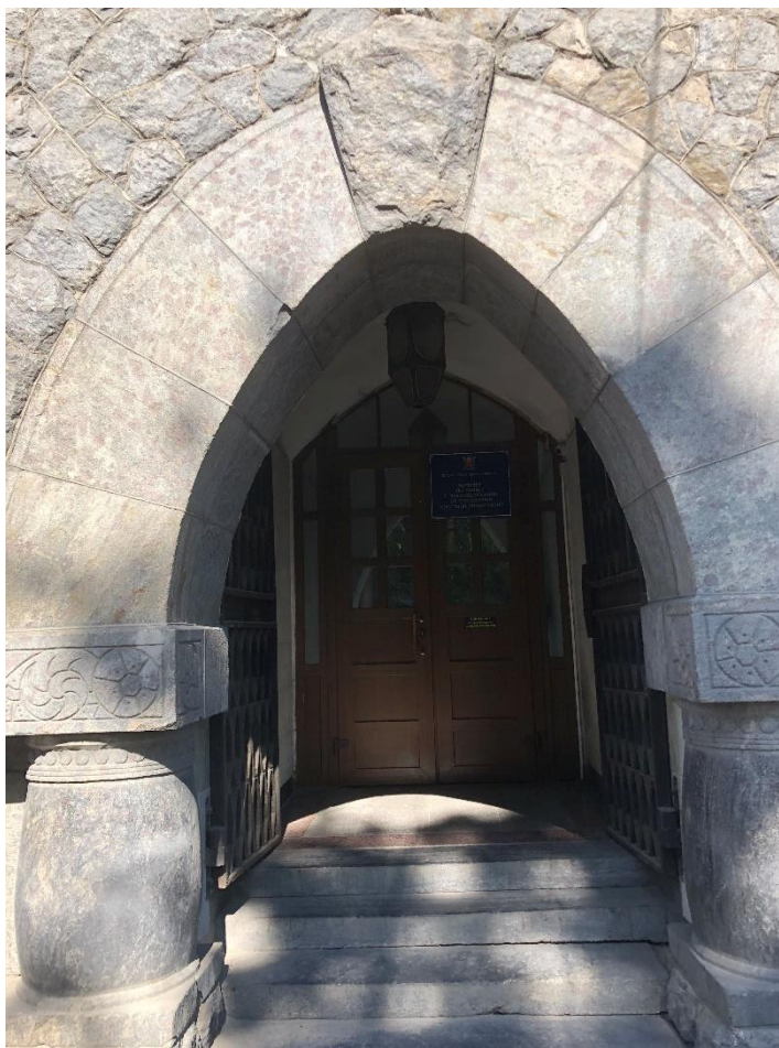
Фото 6. Портал входной группы со стороны Каменноостровского пр.
