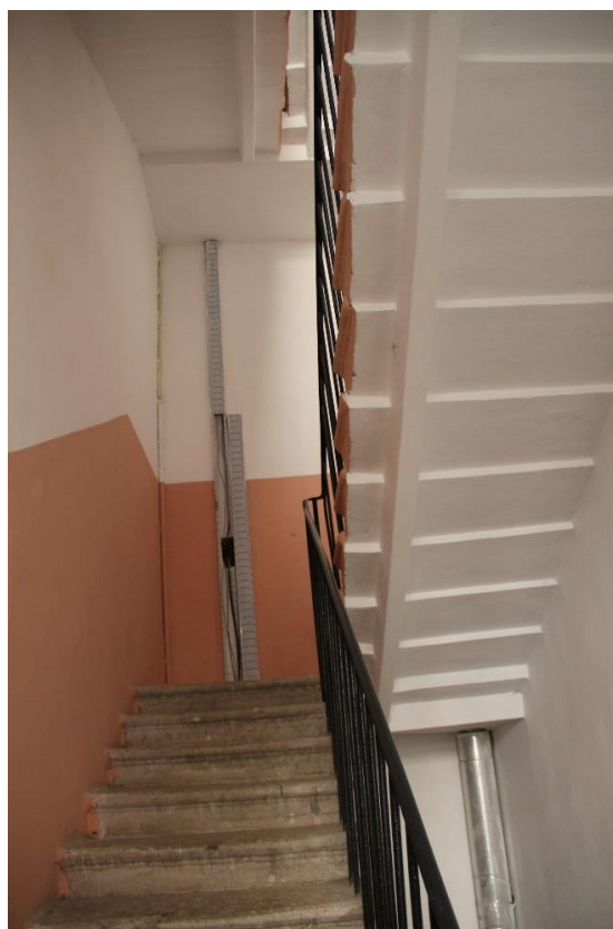
Фото 54. Интерьер служебной лестницы 4 ЛК.
