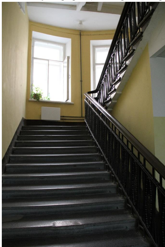
Фото 3. Интерьер парадной лестницы со стороны ул. Графтио.
