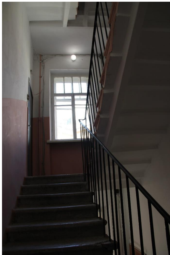
Фото 60. Интерьер служебной лестницы 4 ЛК.
