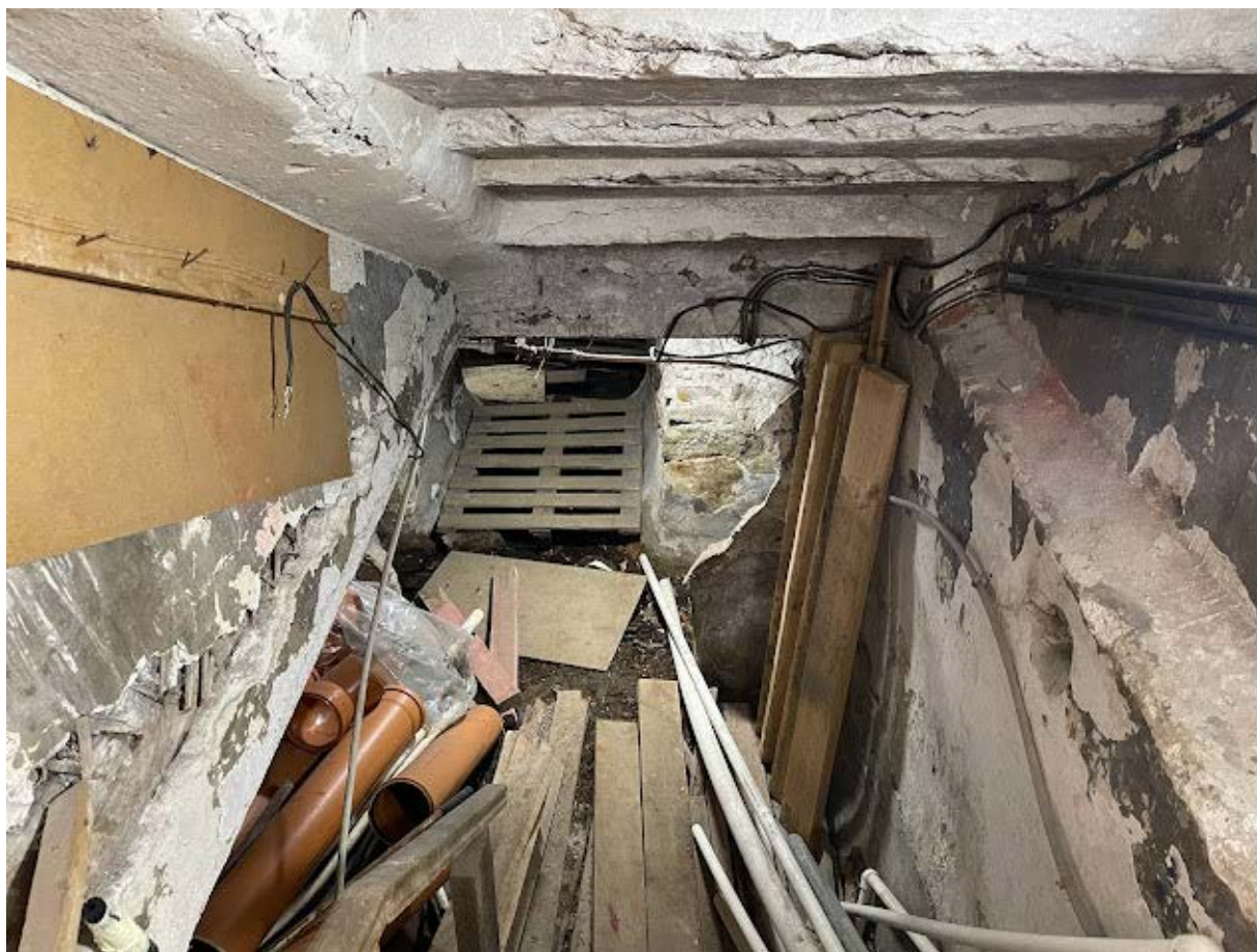
24. Фрагмент интерьера подвала
