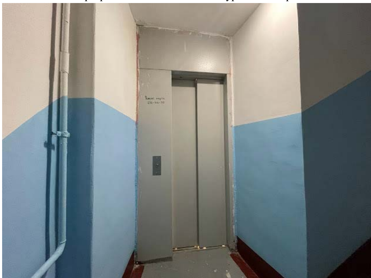
59. Интерьер лестничной клетки №6 в уровне третьего этажа
