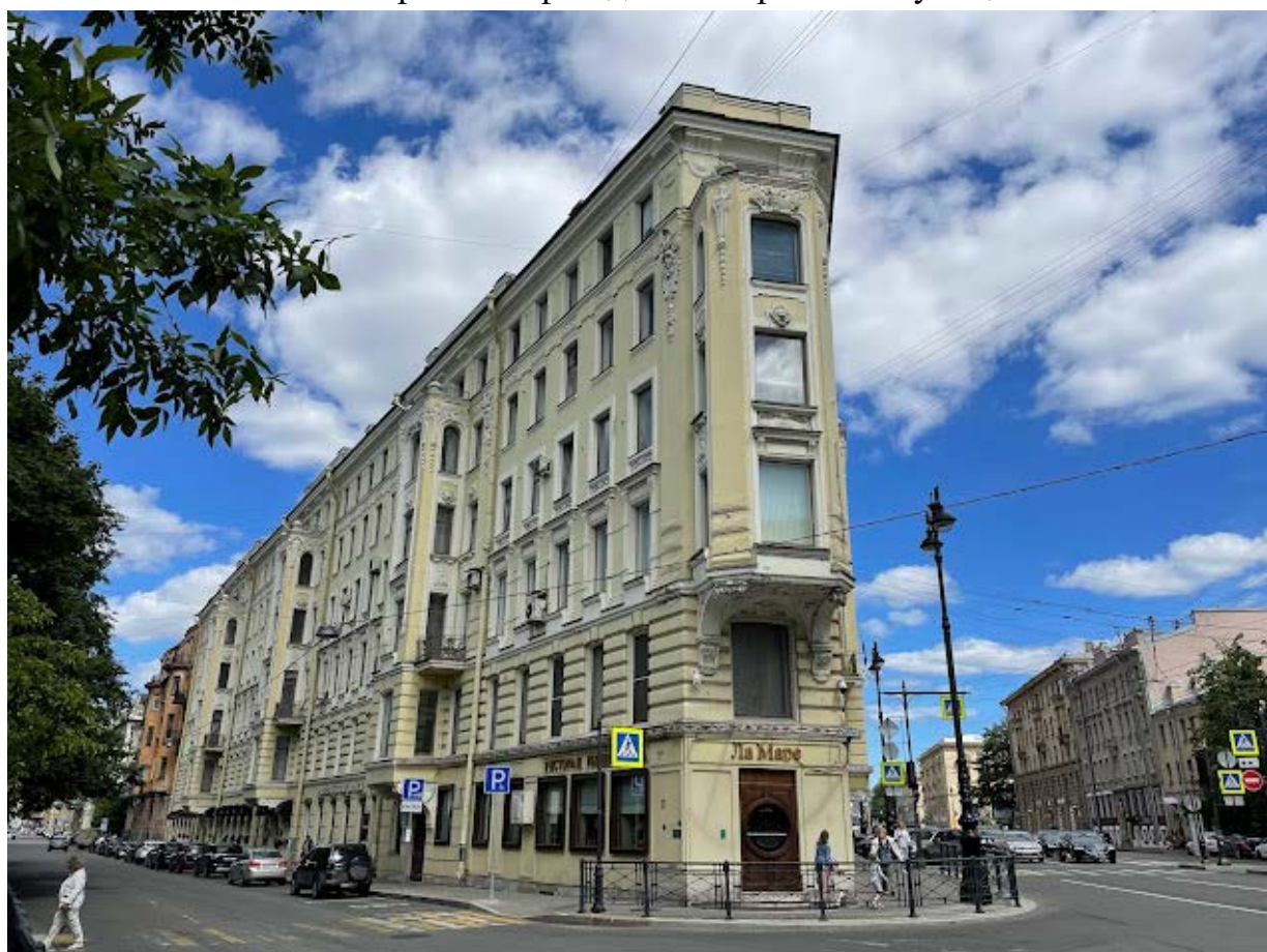
10. Вид на угол здания со стороны Таврической улицы
