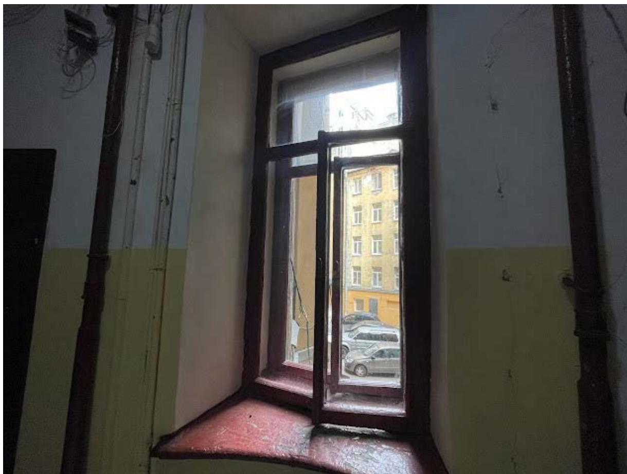
70.Интерьер лестничной клетки №5 в уровне второго этажа
