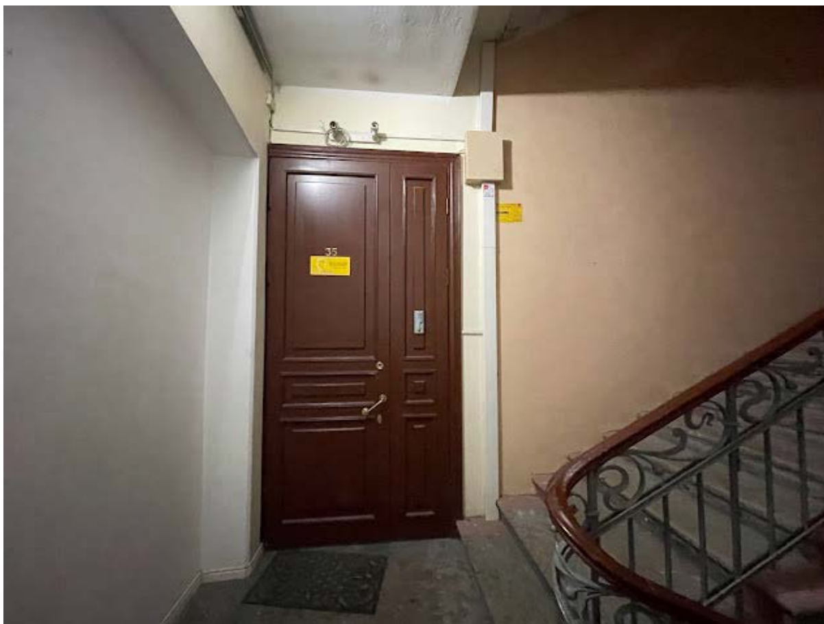
95. Интерьер лестничной клетки №4 в уровне второго этажа
