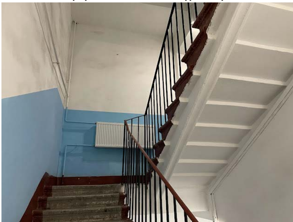
55. Интерьер лестничной клетки №6 в уровне второго этажа
