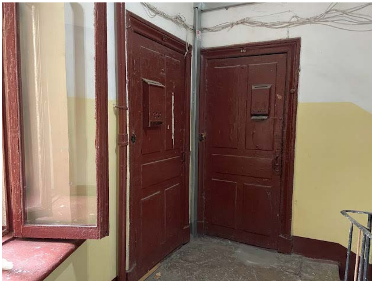
78. Интерьер лестничной клетки №5 в уровне третьего этажа
