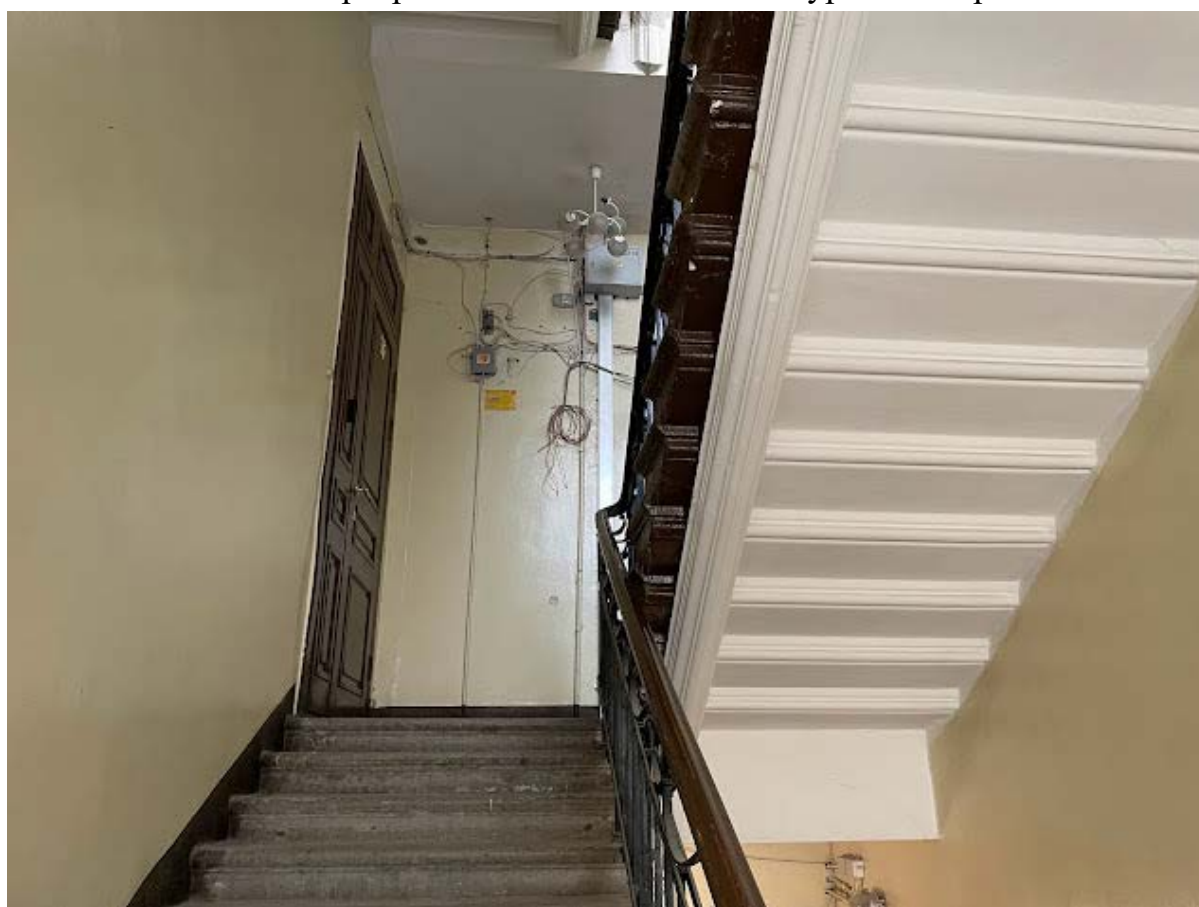
116. Интерьер лестничной клетки №3 в уровне третьего этажа
