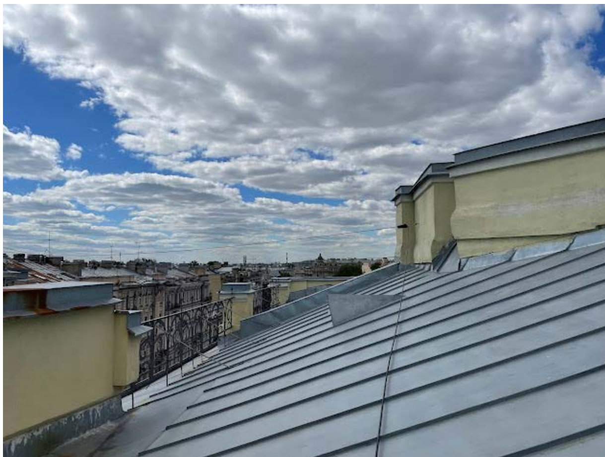
50. Вид на крышу здания
