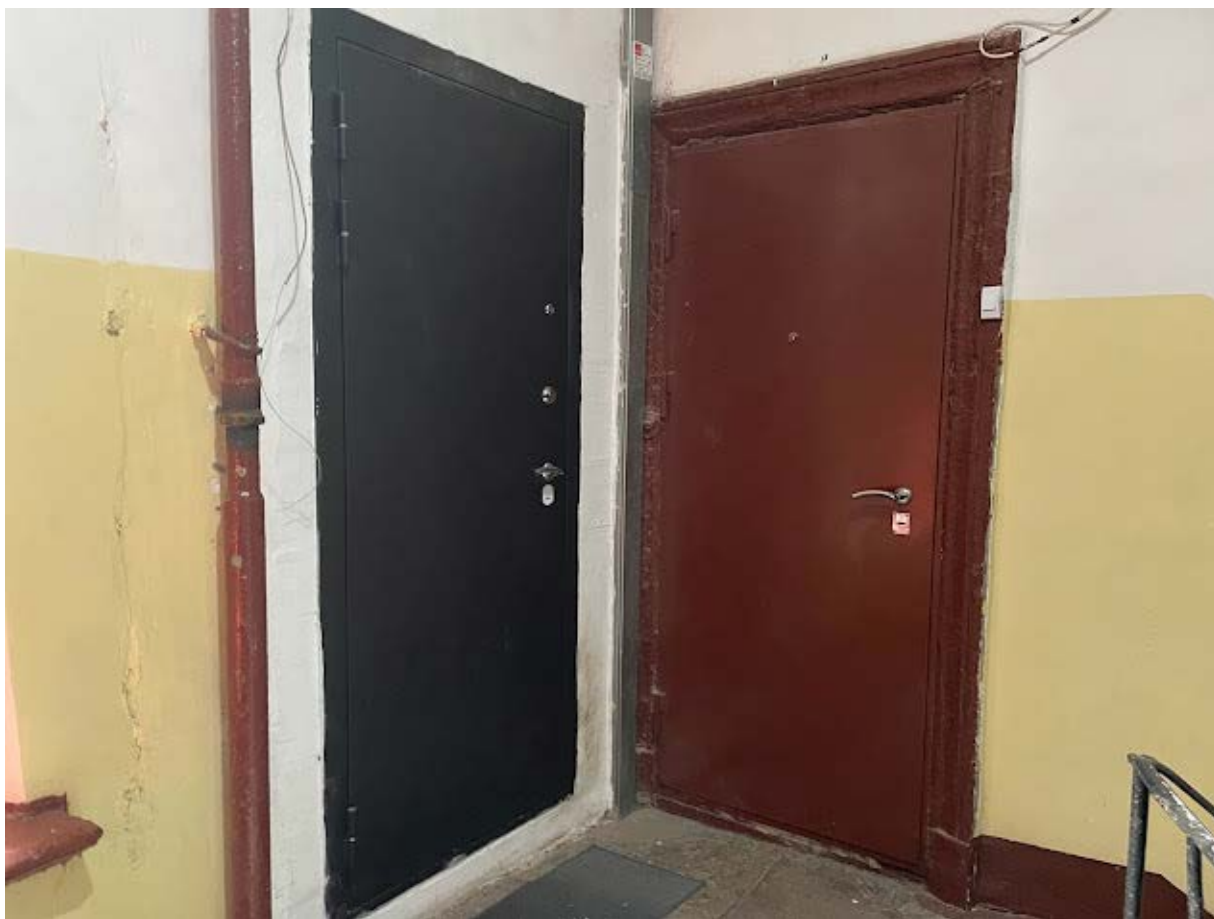
72. Интерьер лестничной клетки №5 в уровне второго этажа
