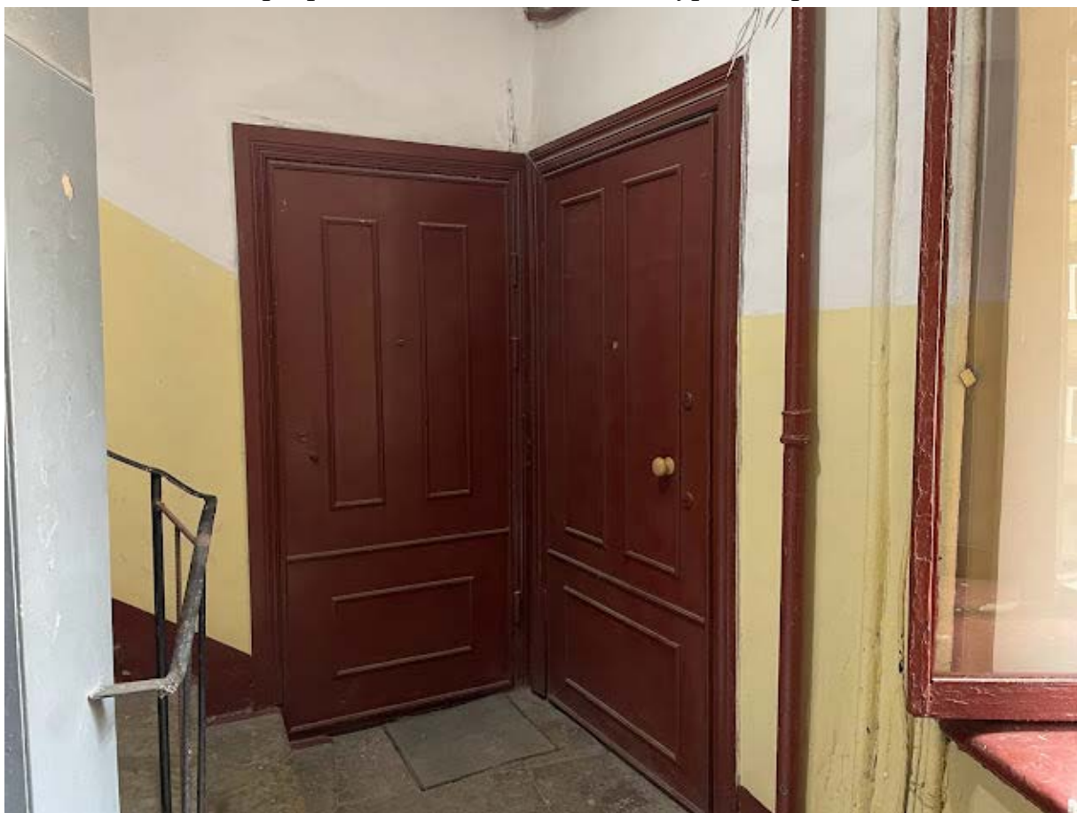
77. Интерьер лестничной клетки №5 в уровне третьего этажа
