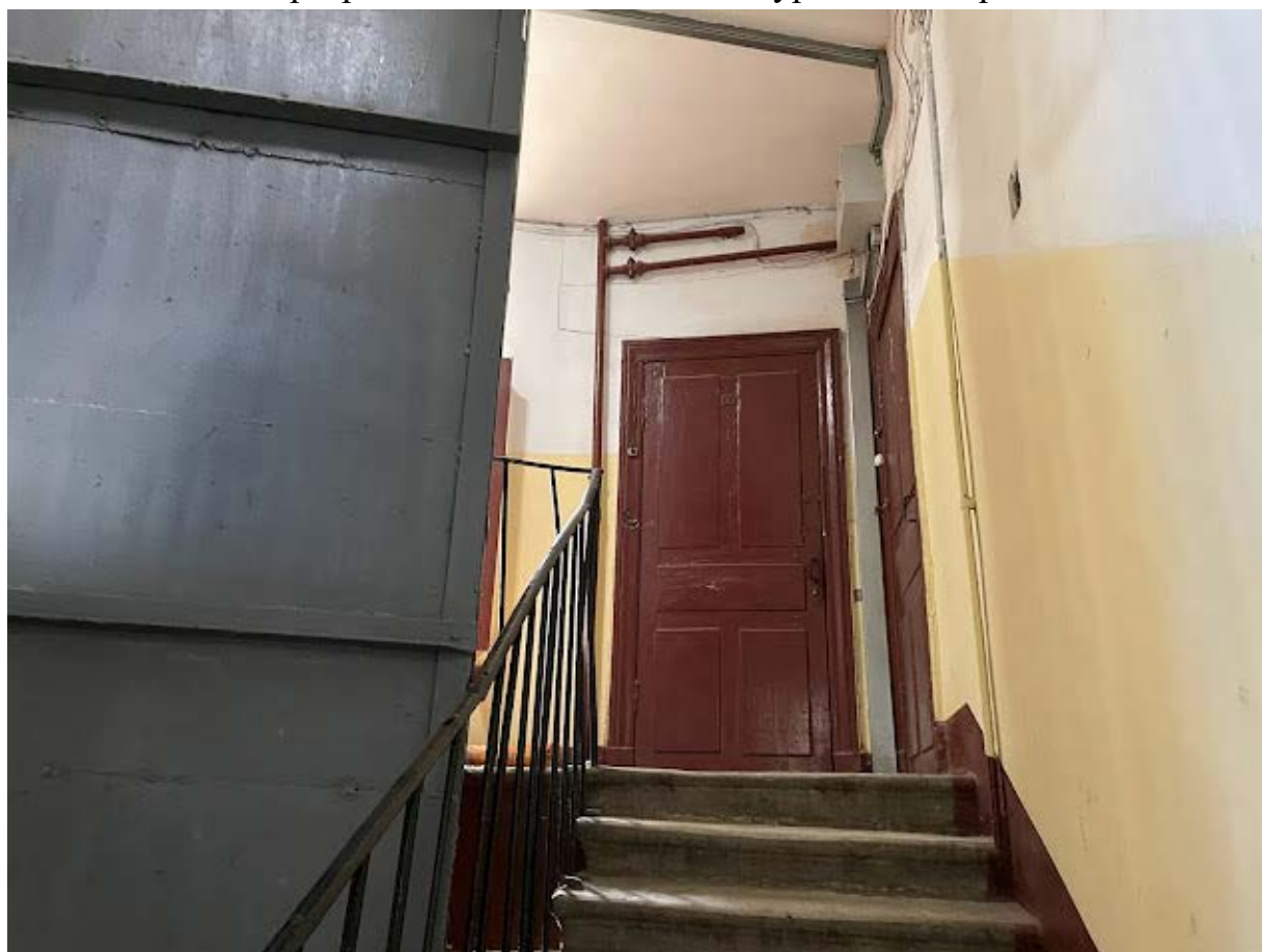
83. Интерьер лестничной клетки №5 в уровне пятого этажа
