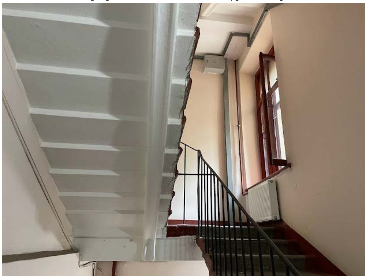
33. Интерьер лестничной клетки №7 в уровне третьего этажа
