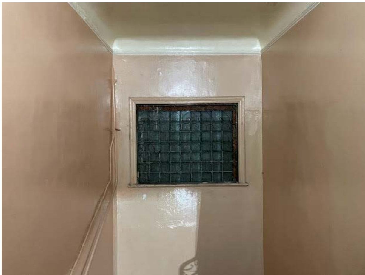
105. Интерьер лестничной клетки №4 в уровне пятого этажа
