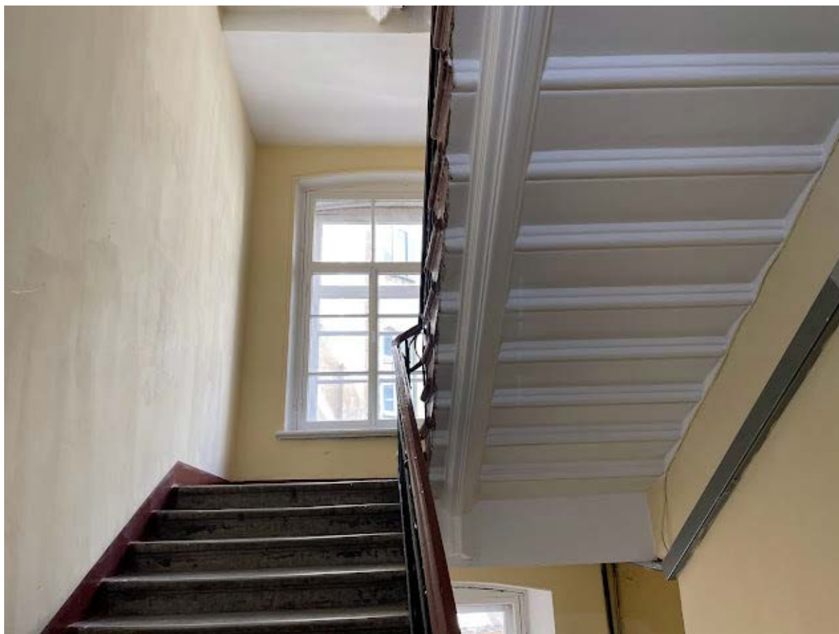
159. Интерьер лестничной клетки №1 в уровне второго этажа
