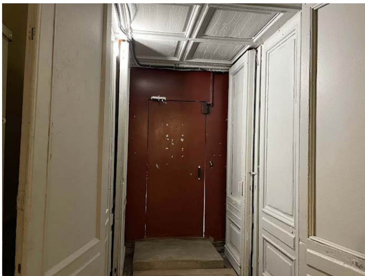
154. Тамбур лестничной клетки №1
