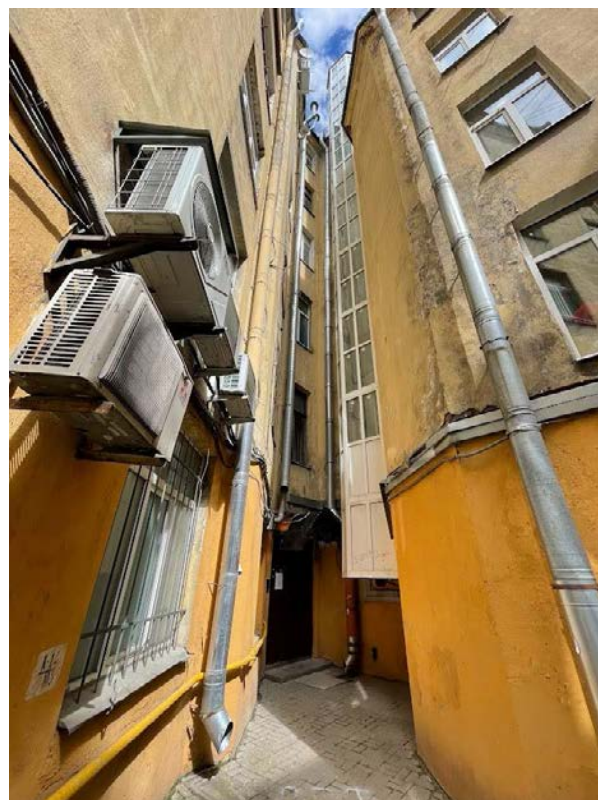
17. Фрагмент дворового фасада
