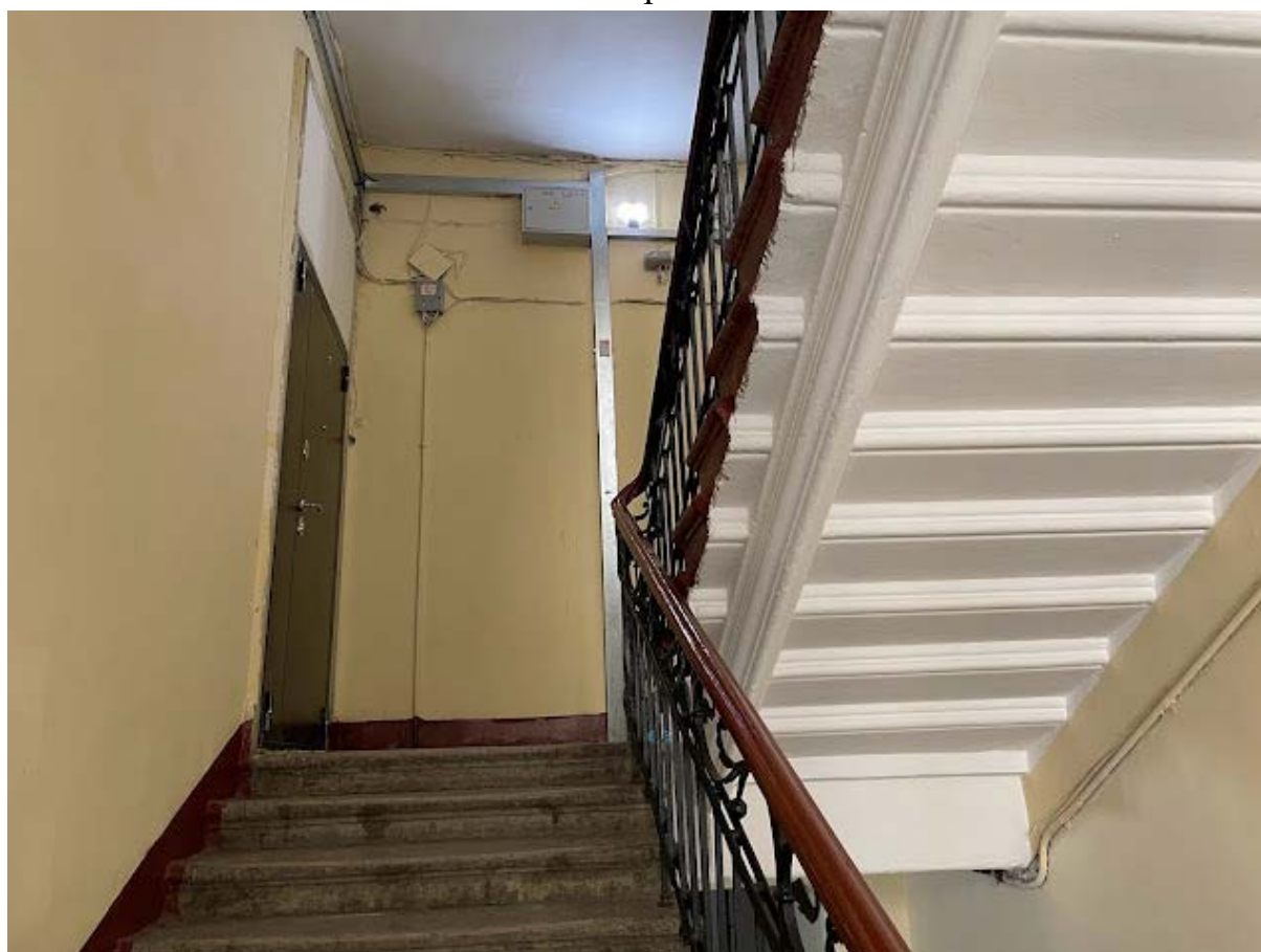
158. Интерьер лестничной клетки №1 в уровне второго этажа
