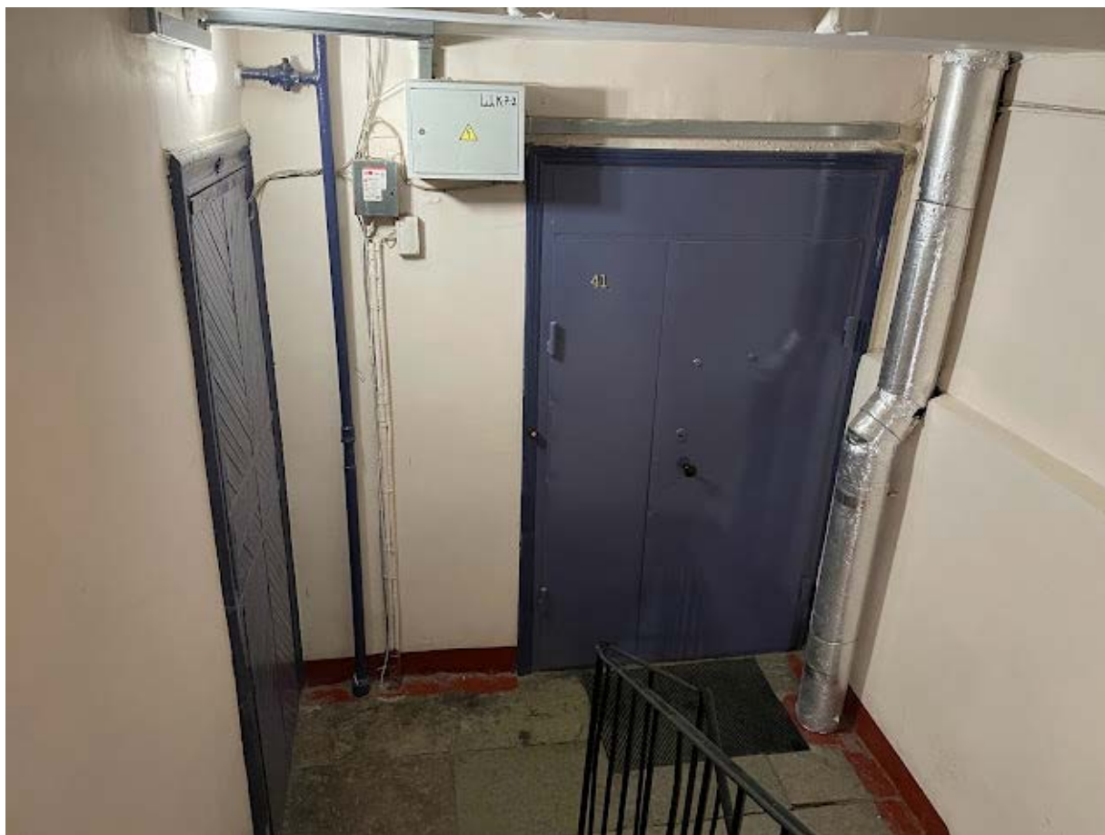
34. Интерьер лестничной клетки №7 в уровне третьего этажа
