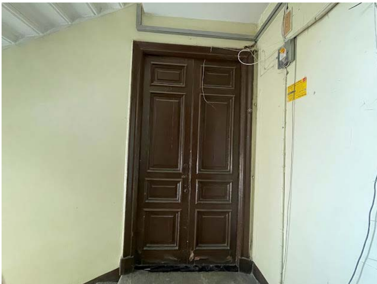
125. Интерьер лестничной клетки №3 в уровне пятого этажа
