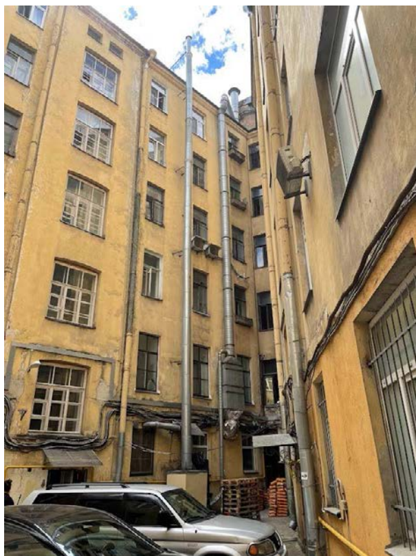
16. Фрагмент дворового фасада
