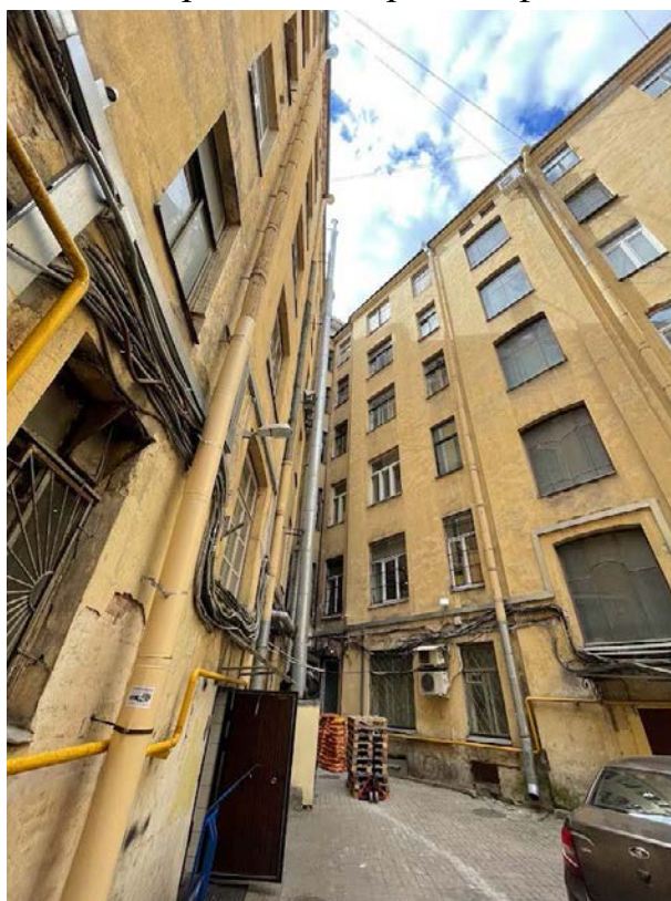
22. Фрагмент дворового фасада
