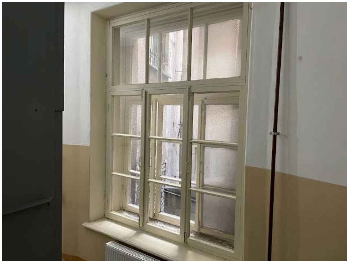
137. Интерьер лестничной клетки №2 в уровне третьего этажа
