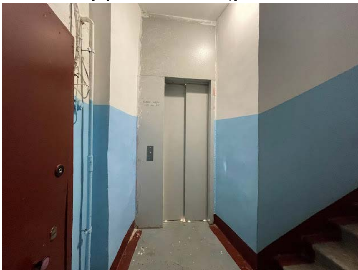
61. Интерьер лестничной клетки №6 в уровне пятого этажа
