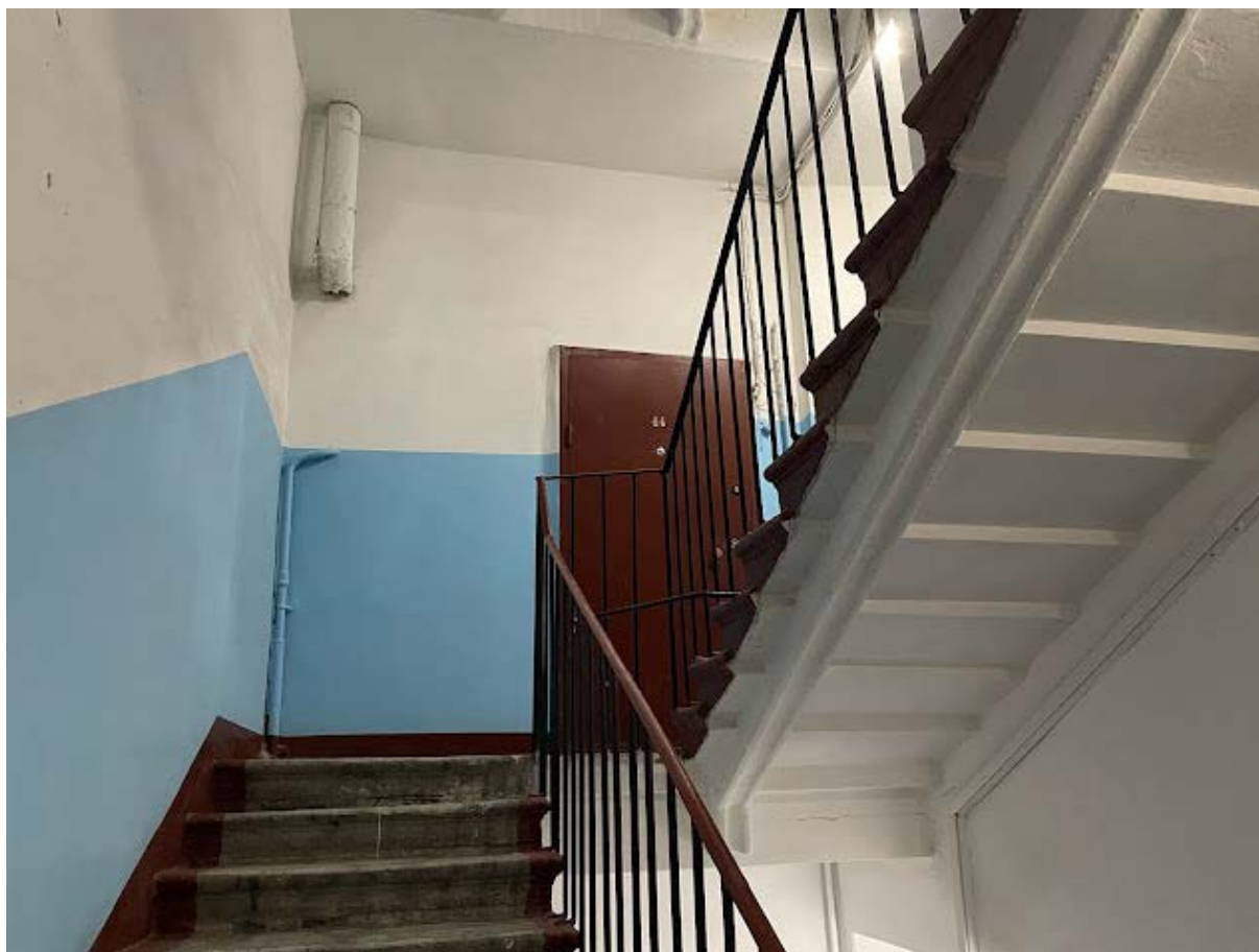
60. Интерьер лестничной клетки №6 в уровне пятого этажа
