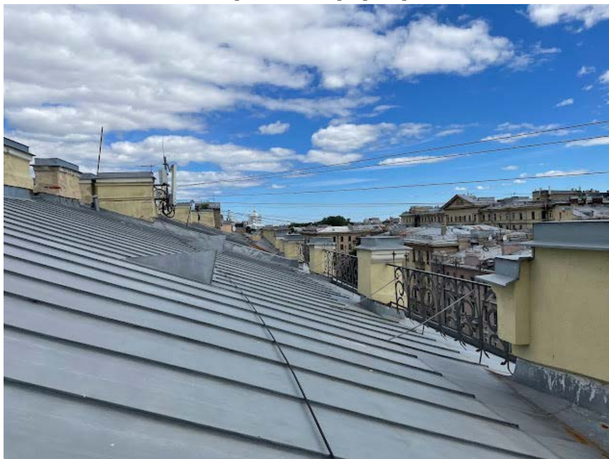
49. Вид на крышу здания
