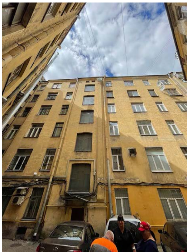
21. Фрагмент дворового фасада
