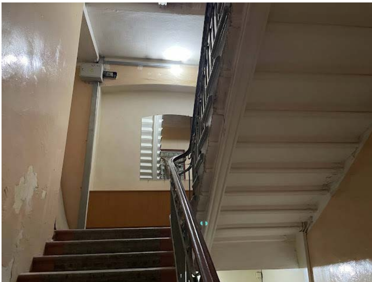
97. Интерьер лестничной клетки №4 в уровне третьего этажа
