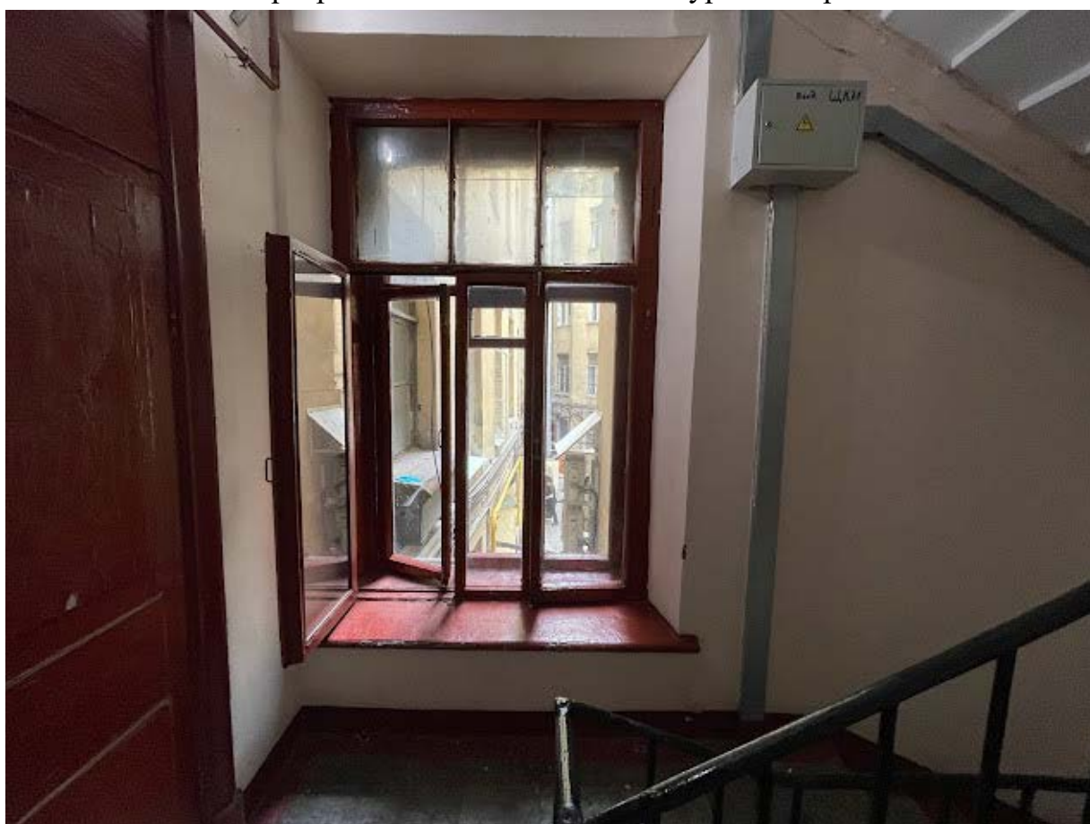
31. Интерьер лестничной клетки №7 в уровне второго этажа
