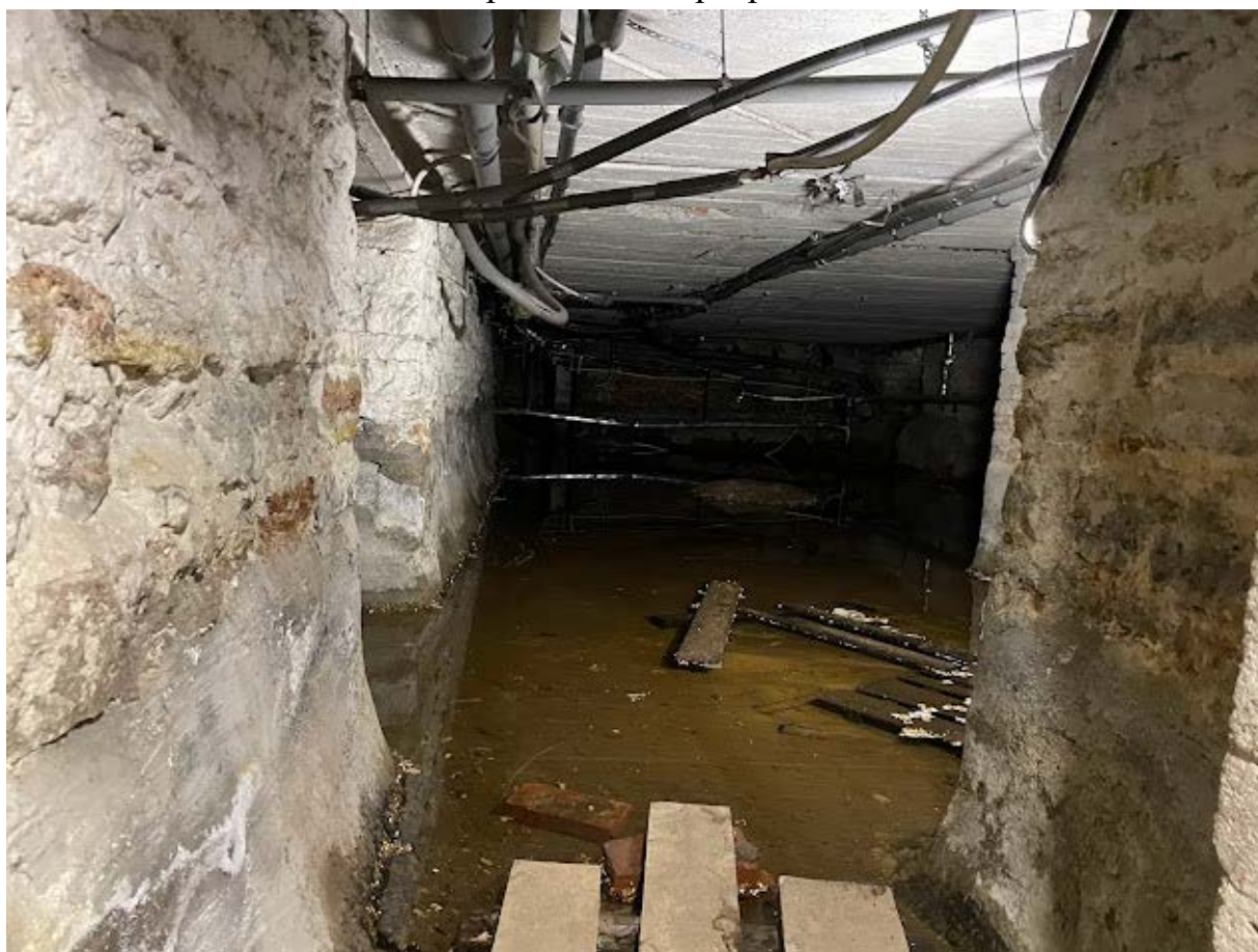
27. Фрагмент интеръера подвала
