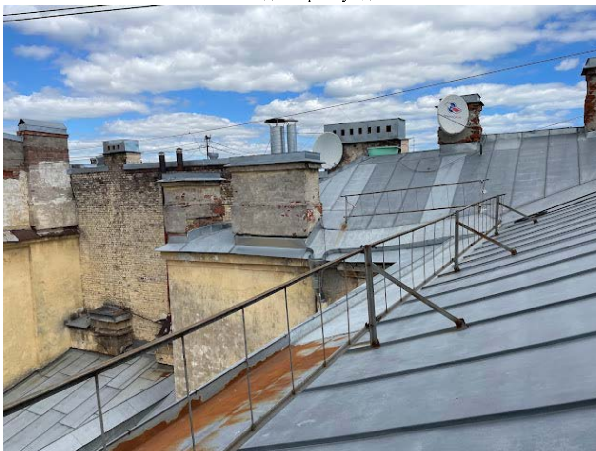
47. Вид на крышу здания
