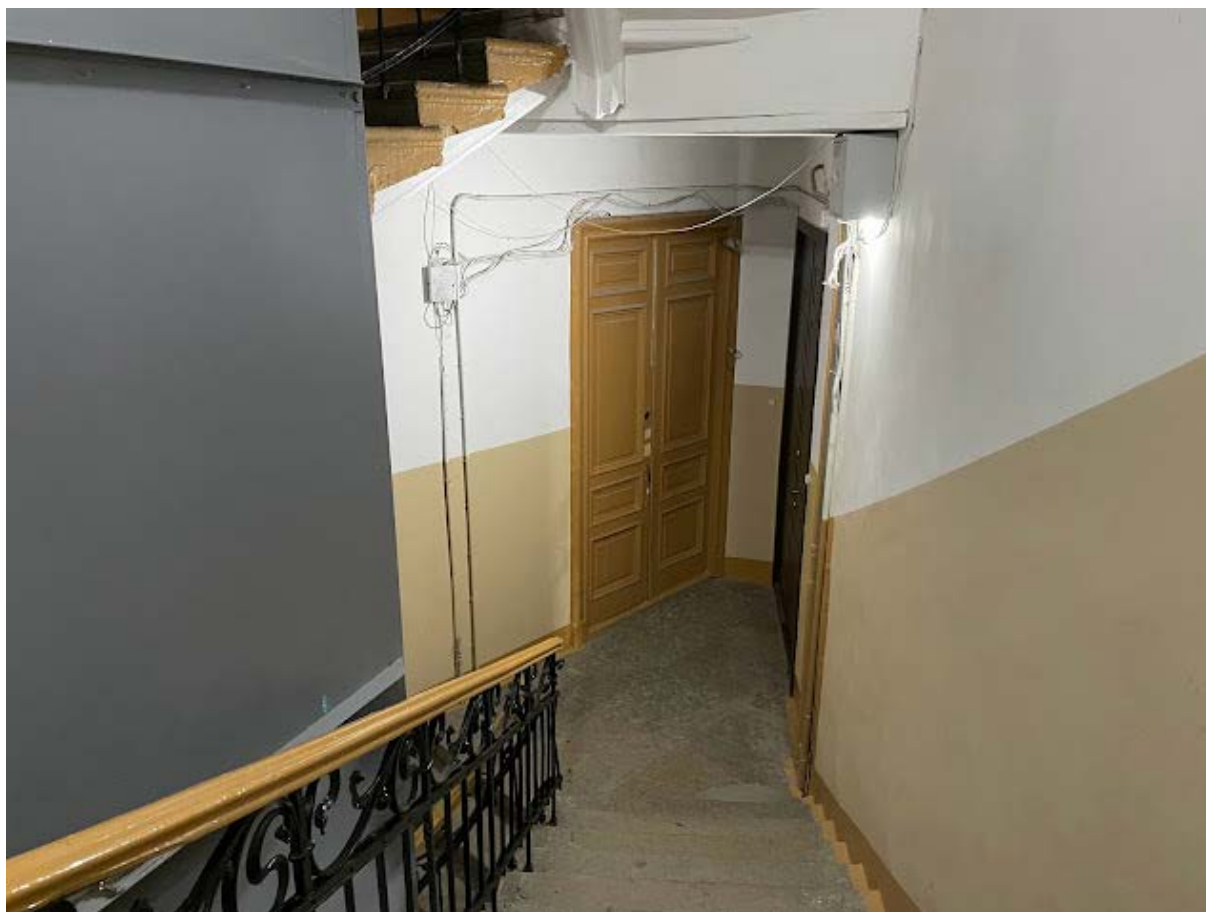
139. Интерьер лестничной клетки №2 в уровне третьего этажа
