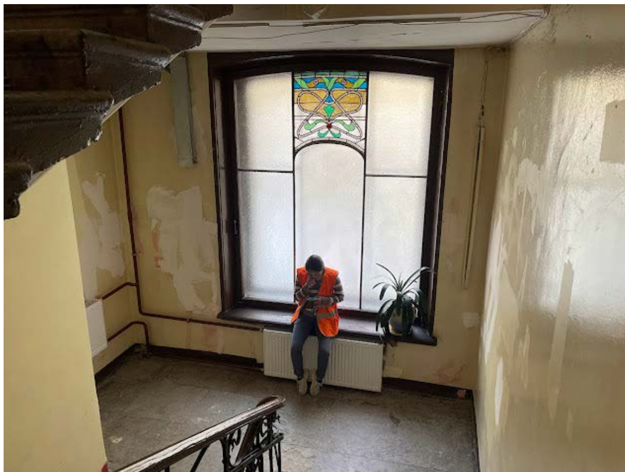
113. Интерьер лестничной клетки №3 в уровне второго этажа
