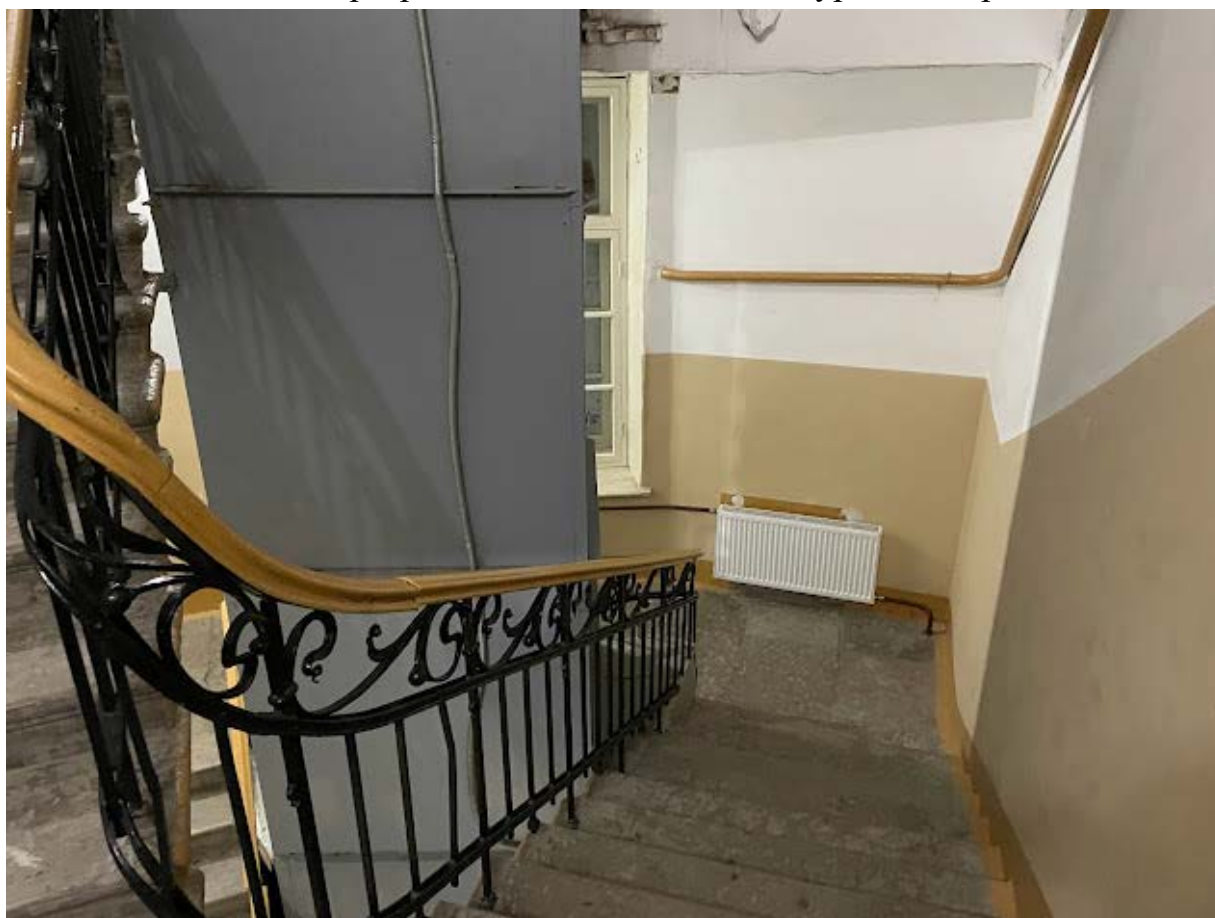
134. Интерьер лестничной клетки №2 в уровне второго этажа
