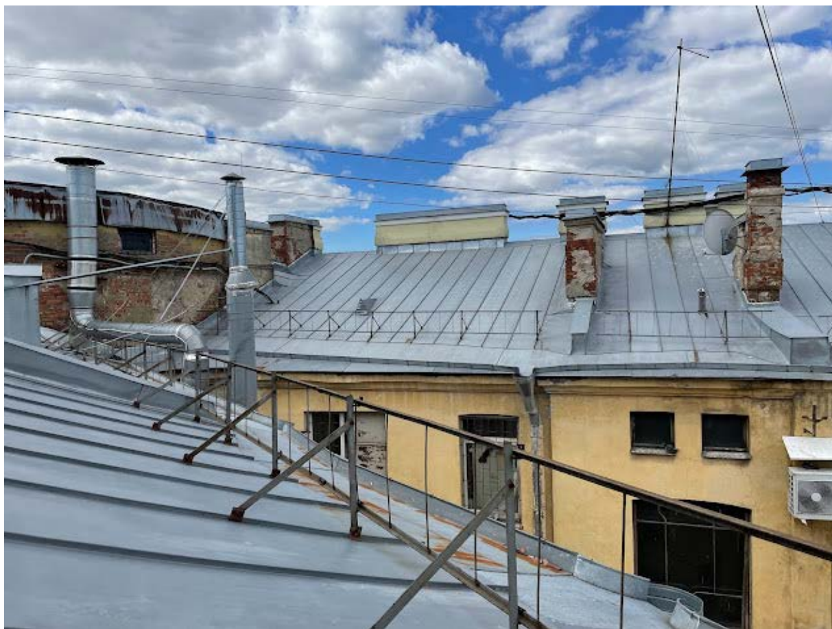
46. Вид на крышу здания
