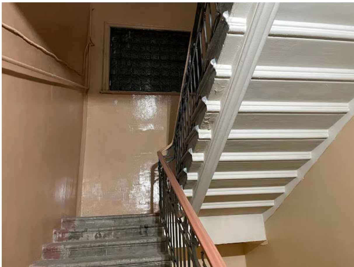
103. Интерьер лестничной клетки №4 в уровне пятого этажа
