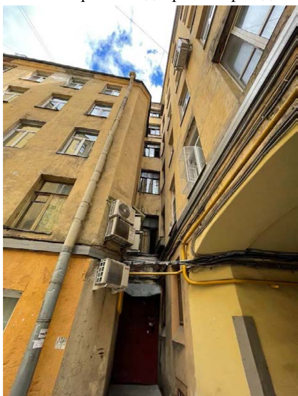
18. Фрагмент дворового фасада
