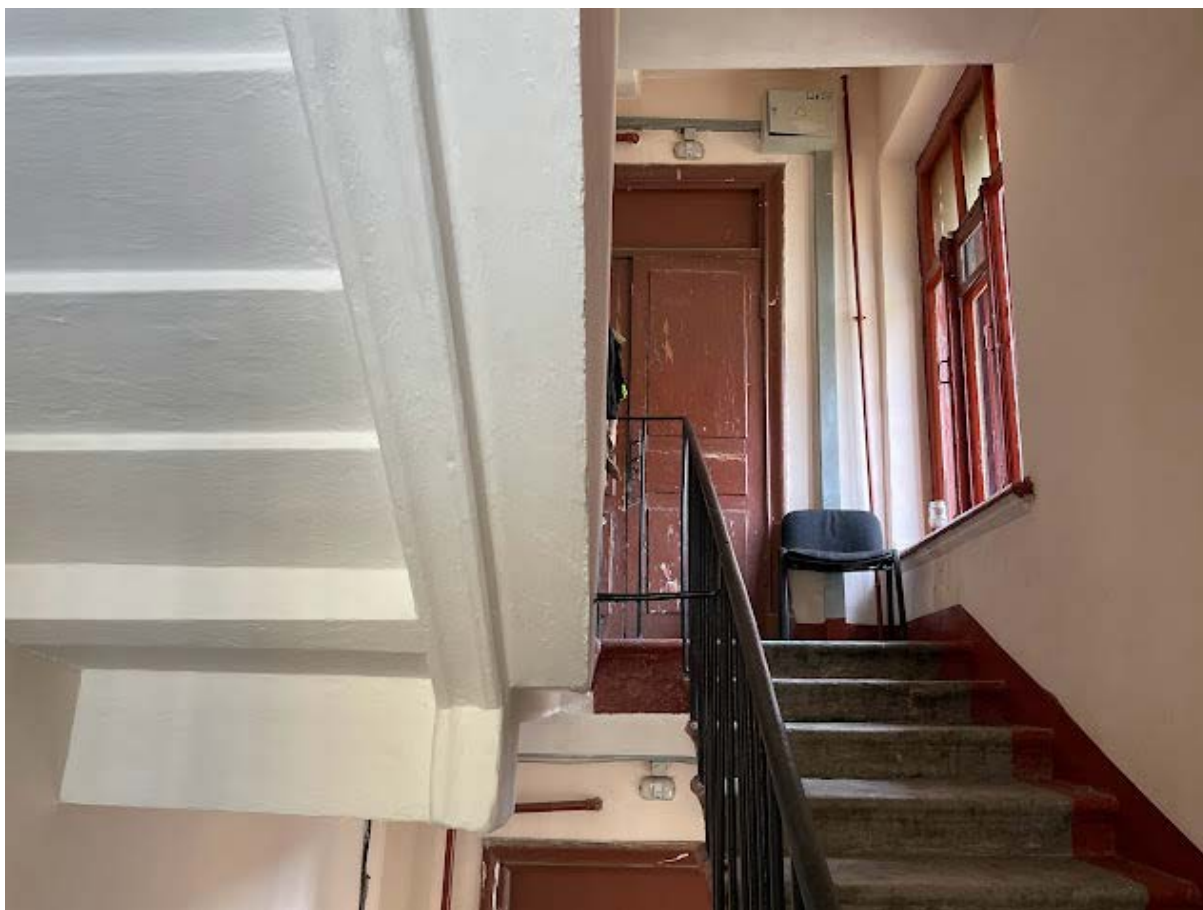
40. Интерьер лестничной клетки №7 в уровне шестого этажа
