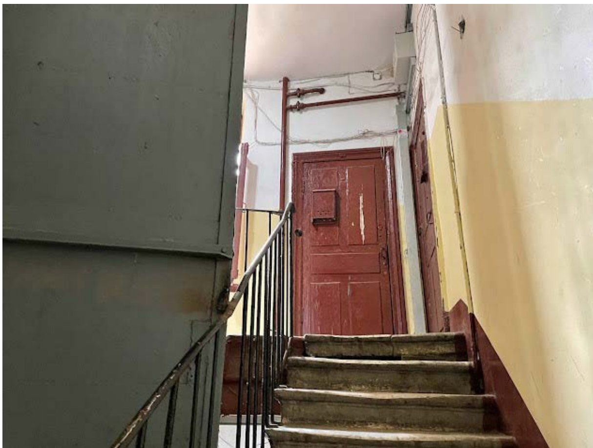
76. Интерьер лестничной клетки №5 в уровне третьего этажа
