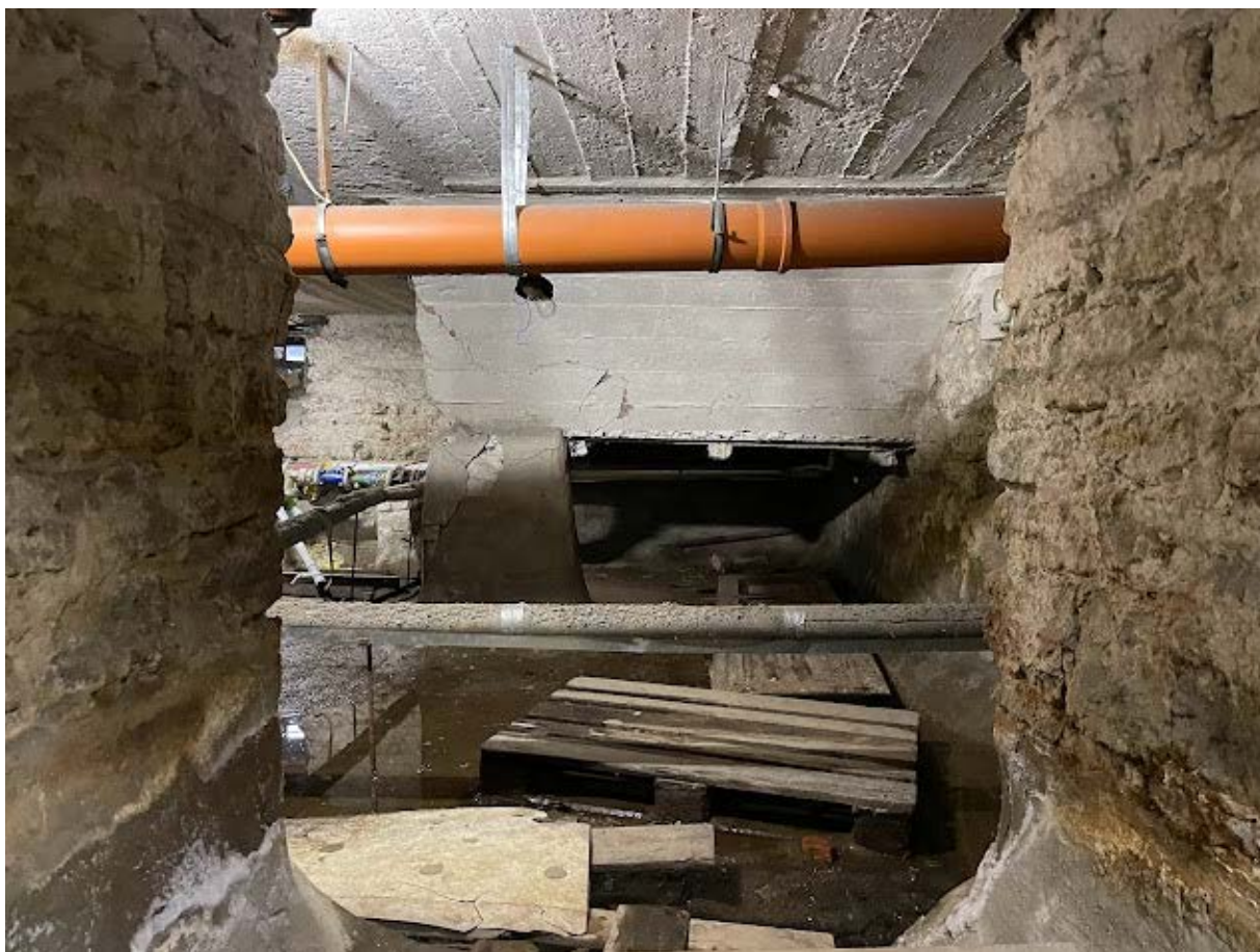
26. Фрагмент интеръера подвала
