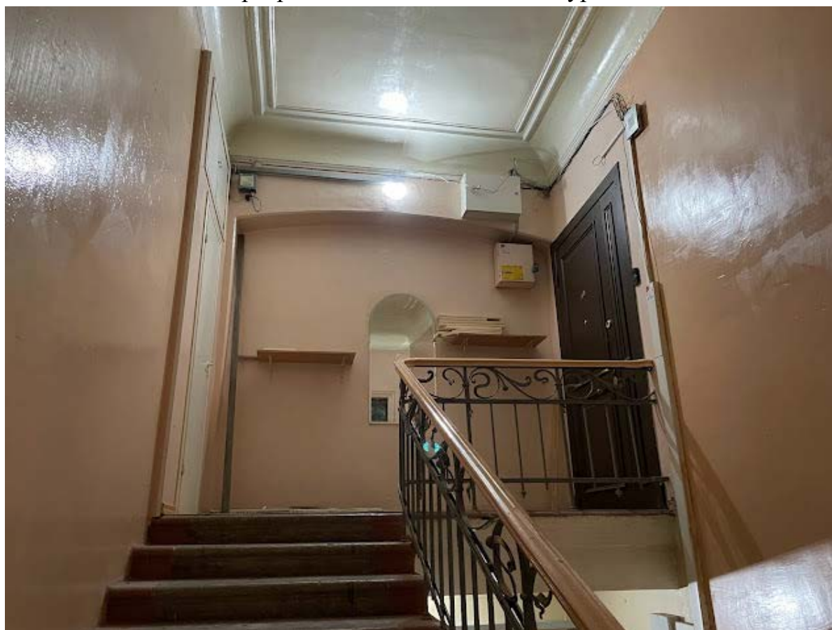
104. Интерьер лестничной клетки №4 в уровне пятого этажа
