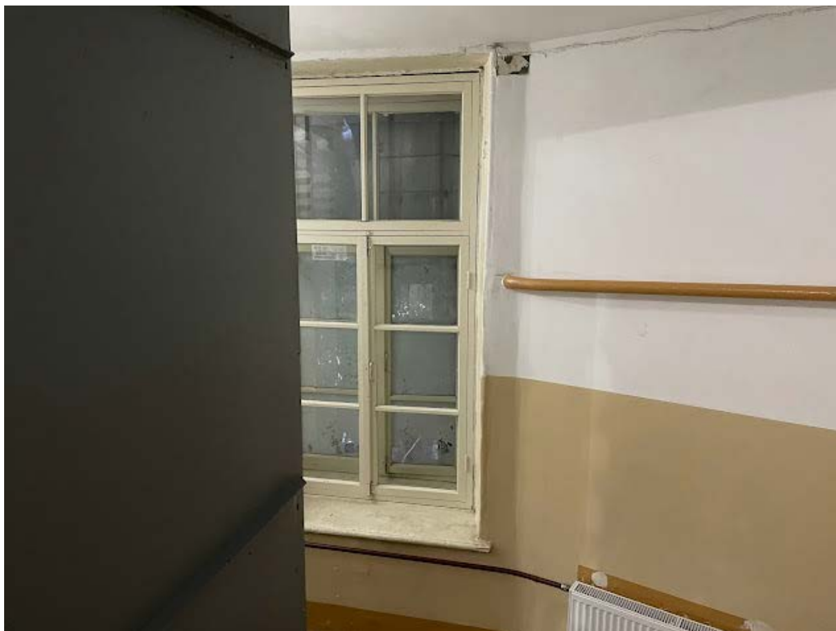
133. Интерьер лестничной клетки №2 в уровне второго этажа
