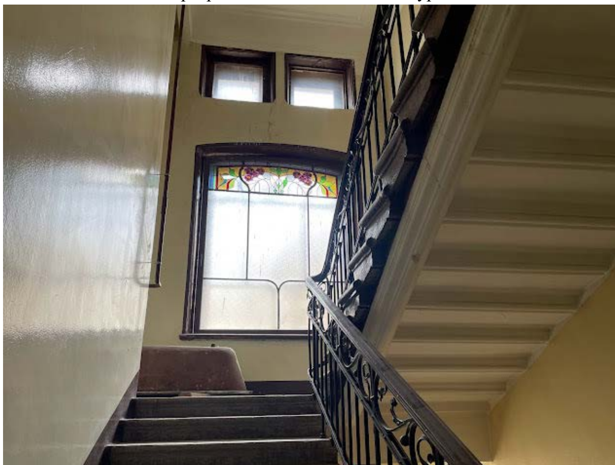
126. Интерьер лестничной клетки №3 в уровне пятого этажа
