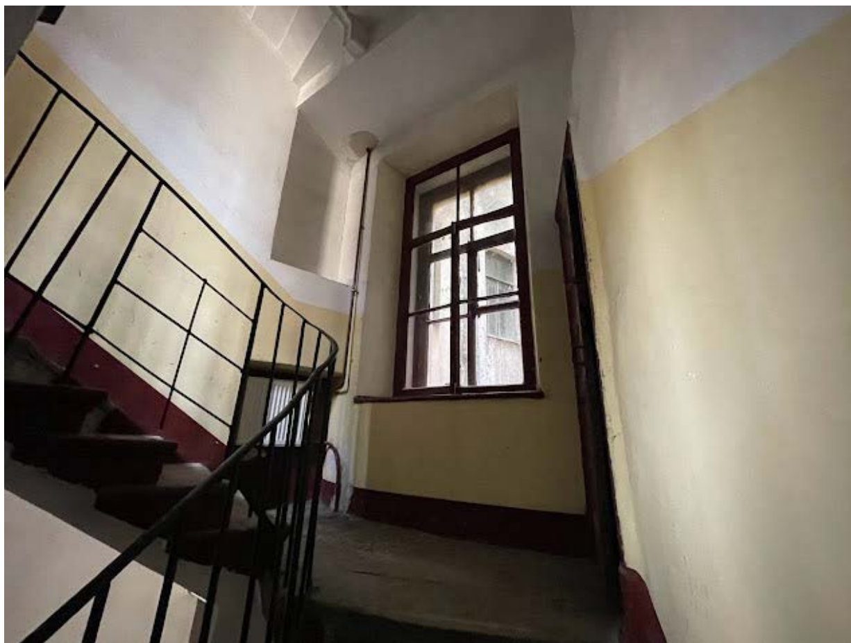
74. Интерьер лестничной клетки №5 в уровне второго этажа
