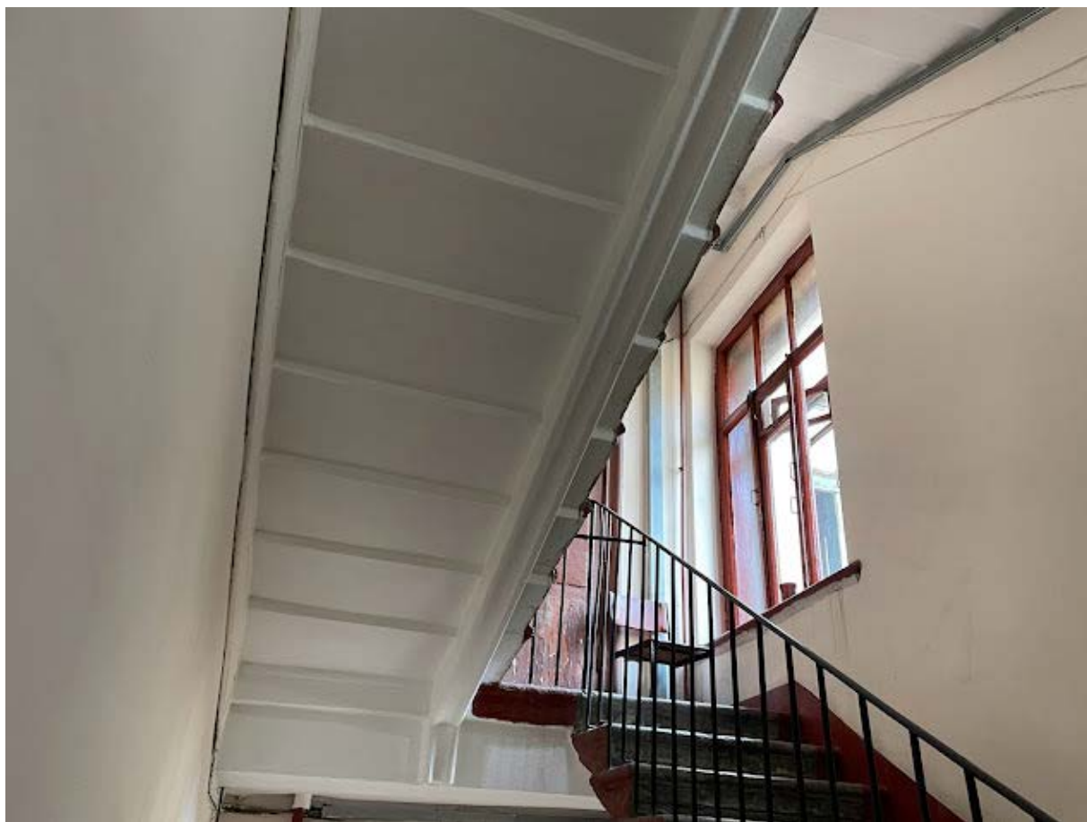
38. Интерьер лестничной клетки №7 в уровне пятого этажа
