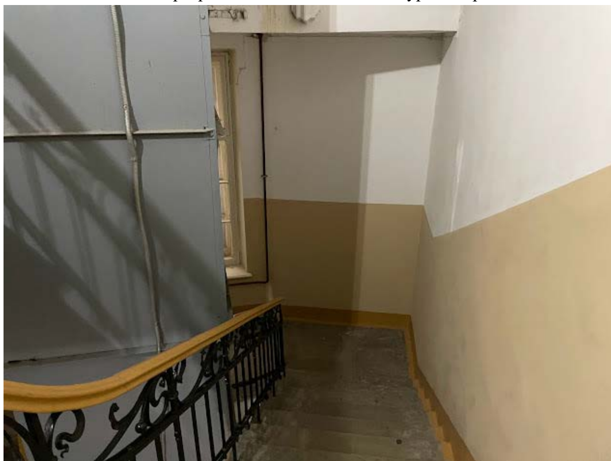
138. Интерьер лестничной клетки №2 в уровне третьего этажа
