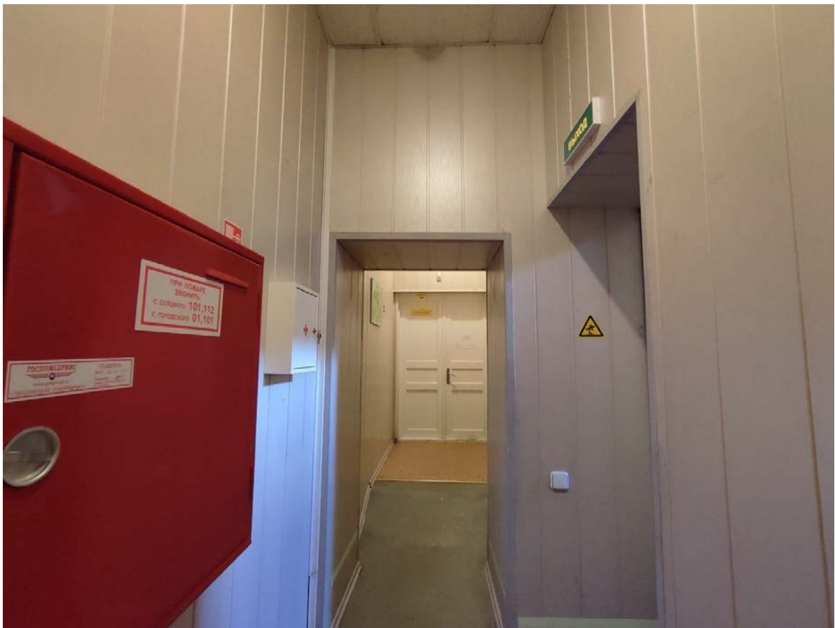
36. Общий вид пом. 27-Н (1, 2) в уровне 2-го этажа.
