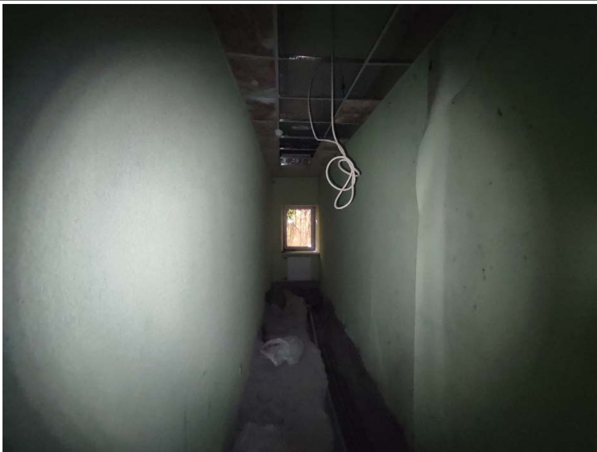
19. Общий вид пом. 13-Н (7) в уровне 1-го этажа.
