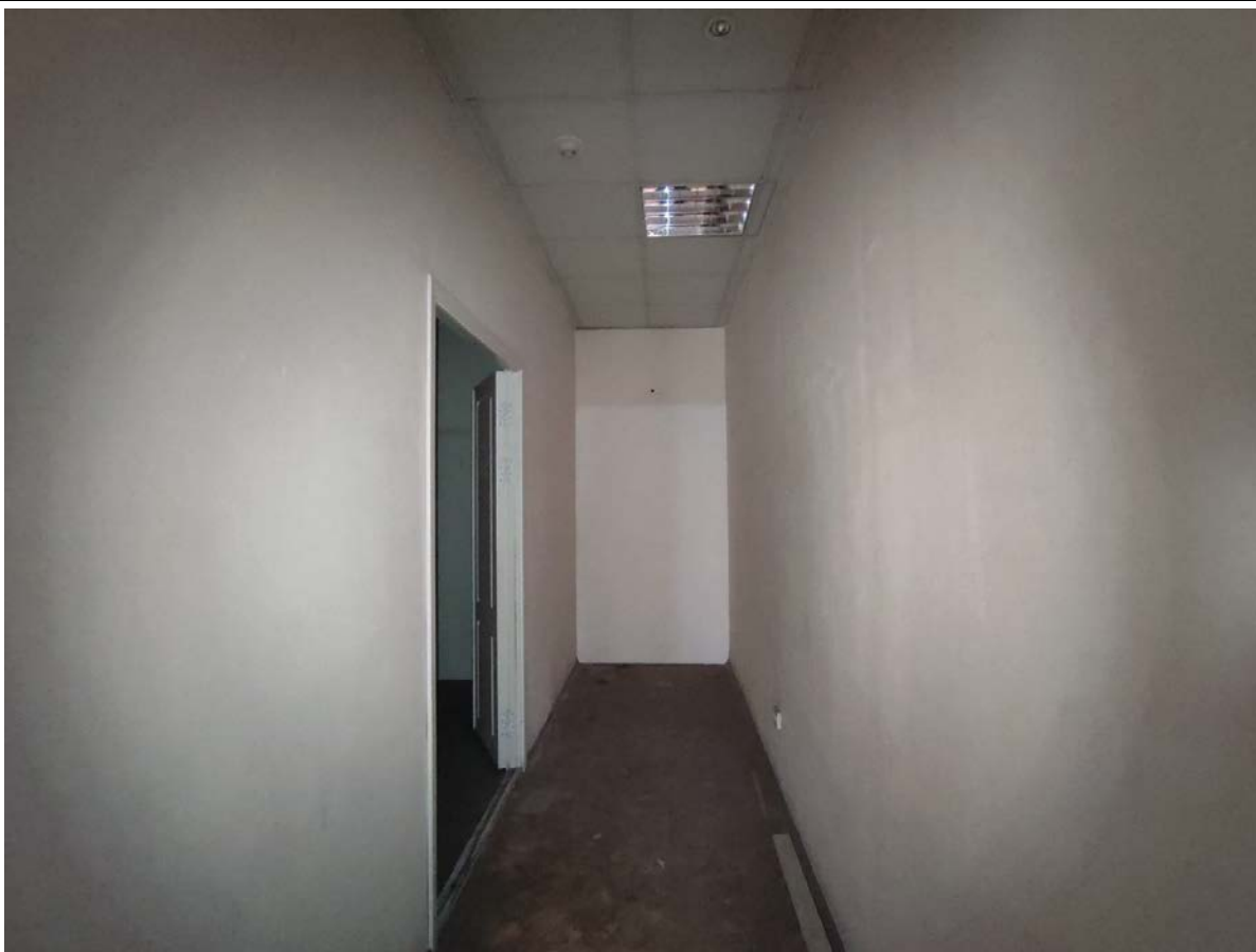
50. Общий вид пом. 31-Н (5) в уровне 2-го этажа.
