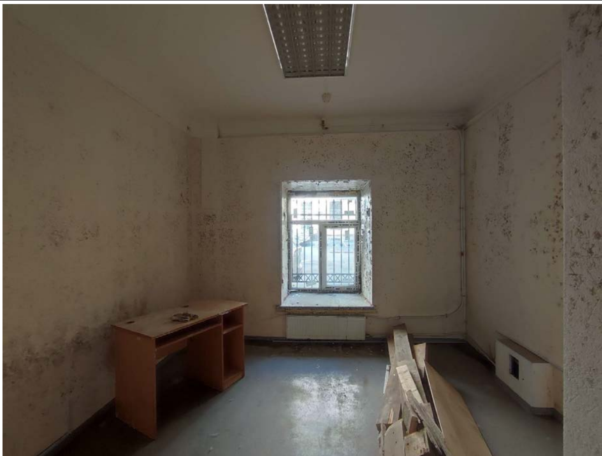
21. Общий вид пом. 13-Н (10) в уровне 1-го этажа.
