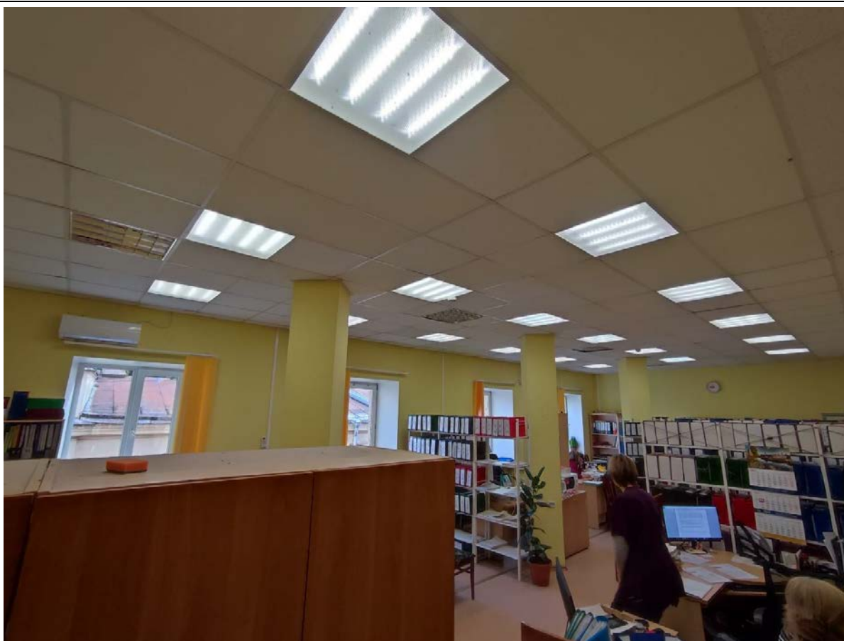
65. Общий вид пом. 20-Н (1) в уровне 3-го этажа.
