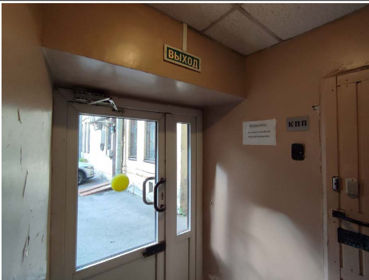
10. Фрагмент тамбура лестницы 2ЛК в уровне 1-го этажа.
