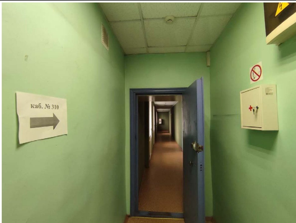
54. Общий вид пом. 20-Н (12) в уровне 3-го этажа.
