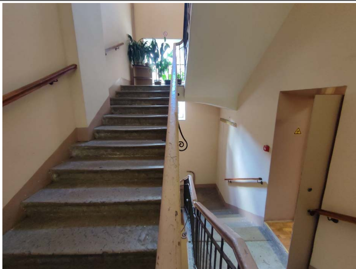
45. Общий вид лестничной клетки 2ЛК в уровне 2-го этажа.
