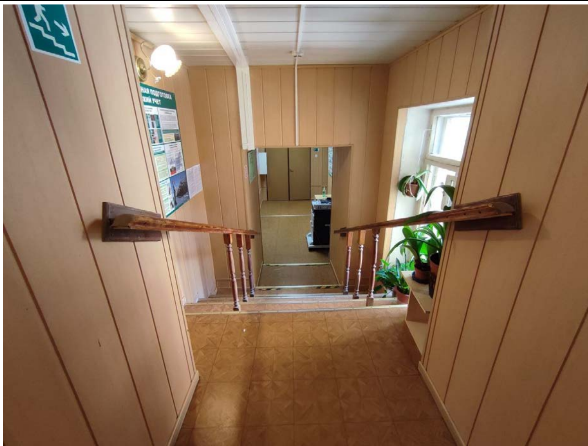
31. Общий вид пом. 17-Н (6) в уровне 2-го этажа.
