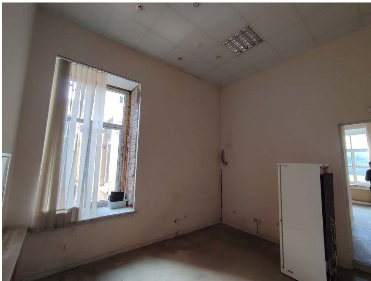
46. Общий вид пом. 31-Н (1) в уровне 2-го этажа.
