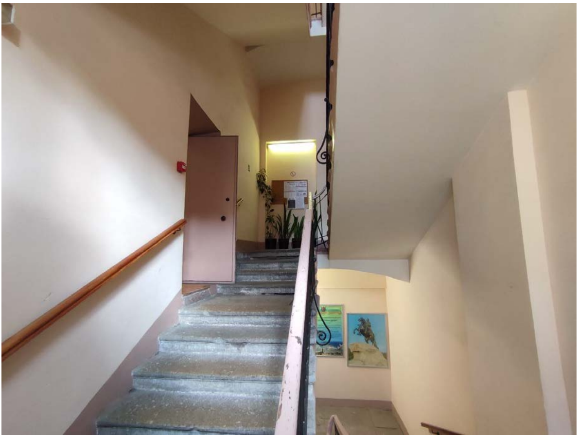
24. Общий вид лестничной клетки 2ЛК с междуэтажной площадки между 1-м и 2-м этажами.
