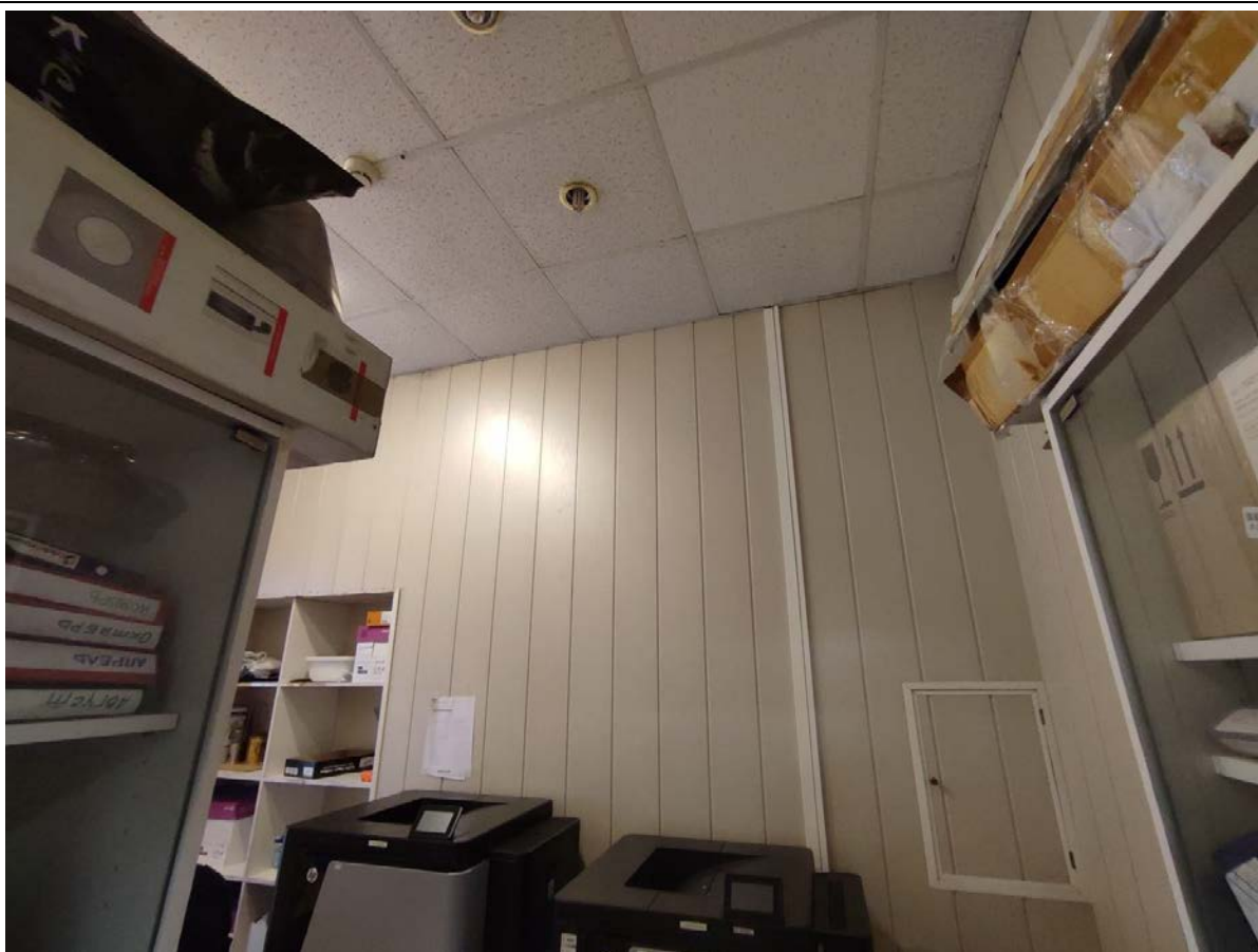
39. Фрагмент пом. 27-Н (5) в уровне 2-го этажа.
