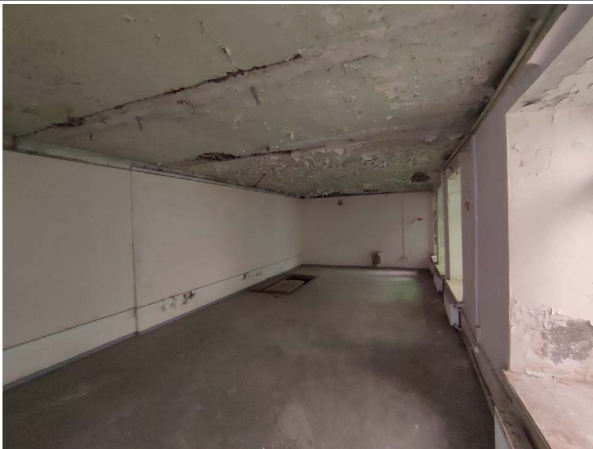
23. Общий вид пом. 13-Н (14) в уровне 1-го этажа.
