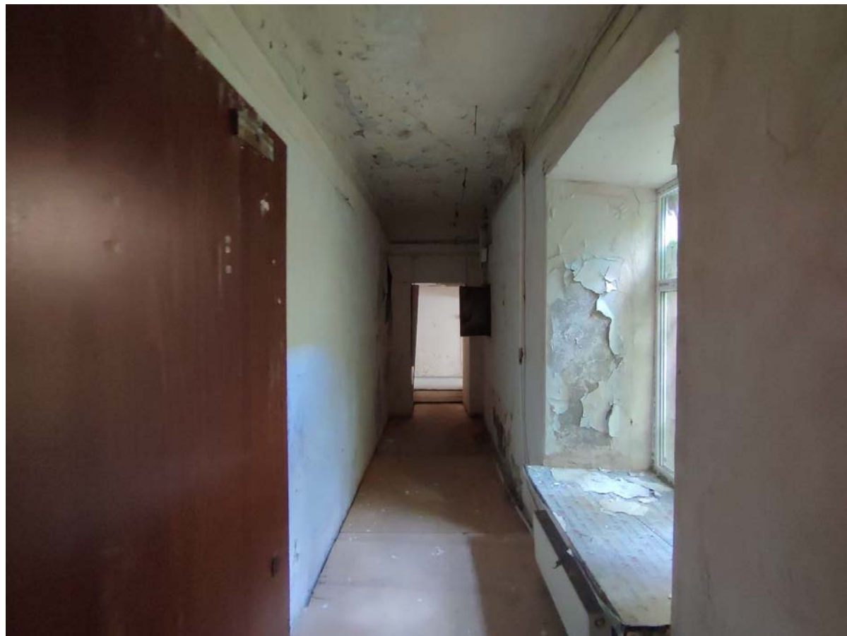
20. Общий вид пом. 13-Н (9) в уровне 1-го этажа.
