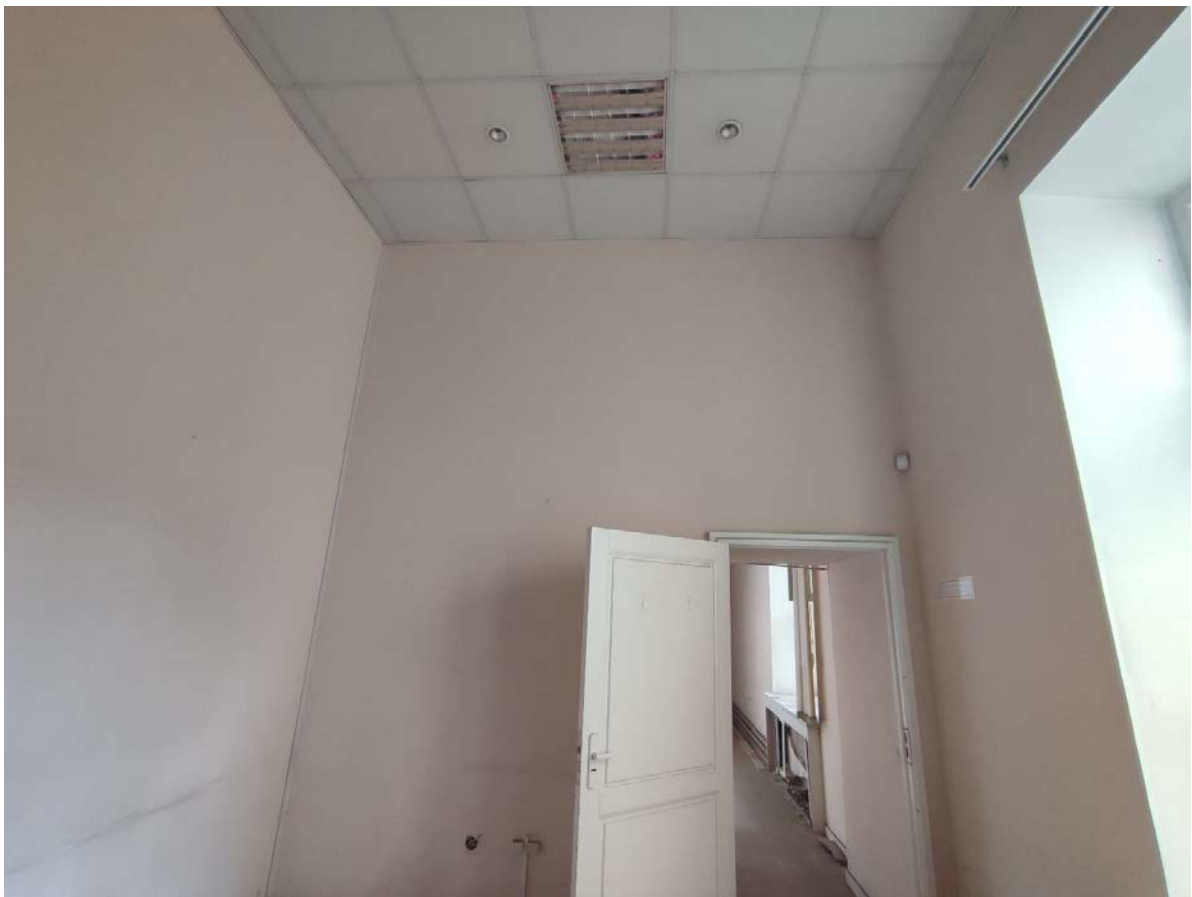
48. Фрагмент пом. 31-Н (3) в уровне 2-го этажа.
