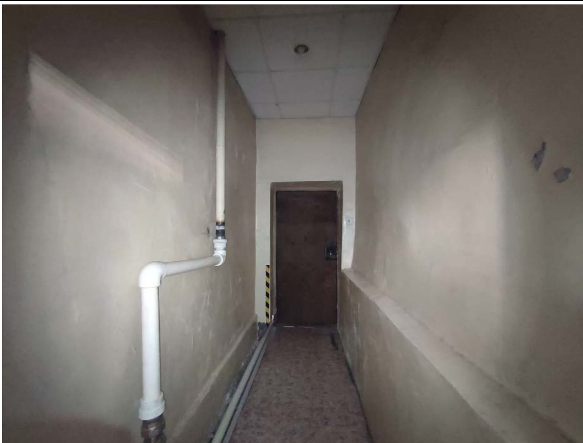
13. Общий вид пом. 55-Н (2) в уровне 1-го этажа.
