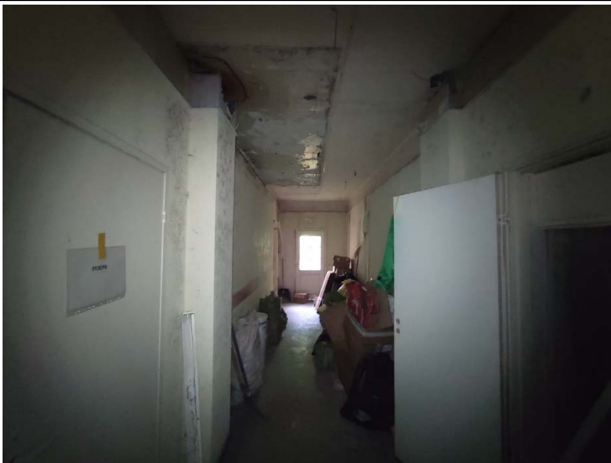
18. Общий вид пом. 13-Н (3) в уровне 1-го этажа.
