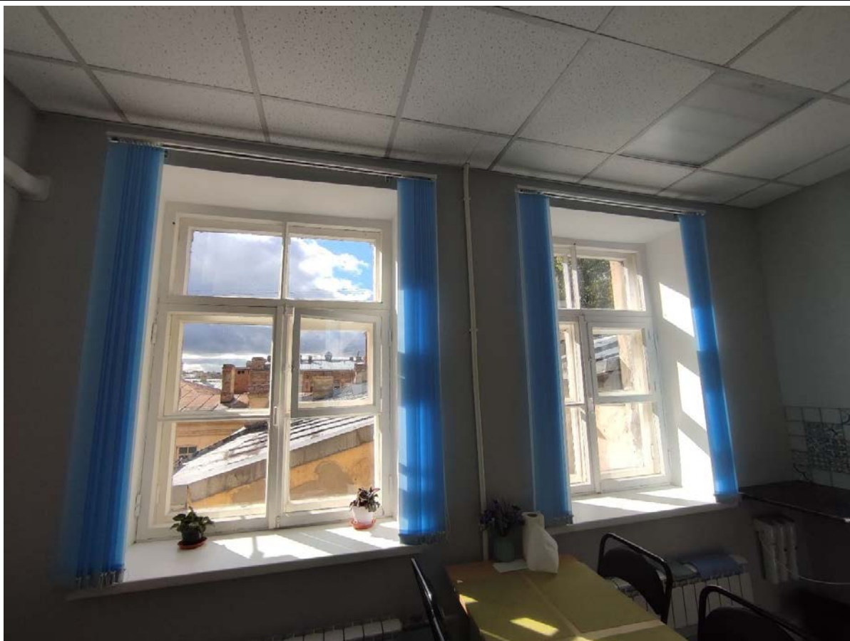
70. Общий вид пом. 25-Н (3) в уровне 4-го этажа.
