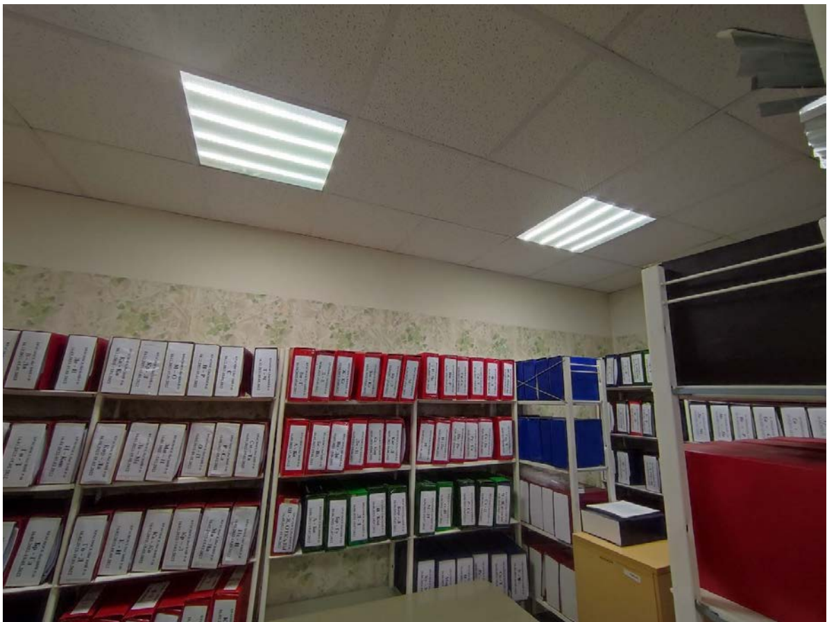
34. Фрагмент пом. 17-Н (15) в уровне 2-го этажа.
