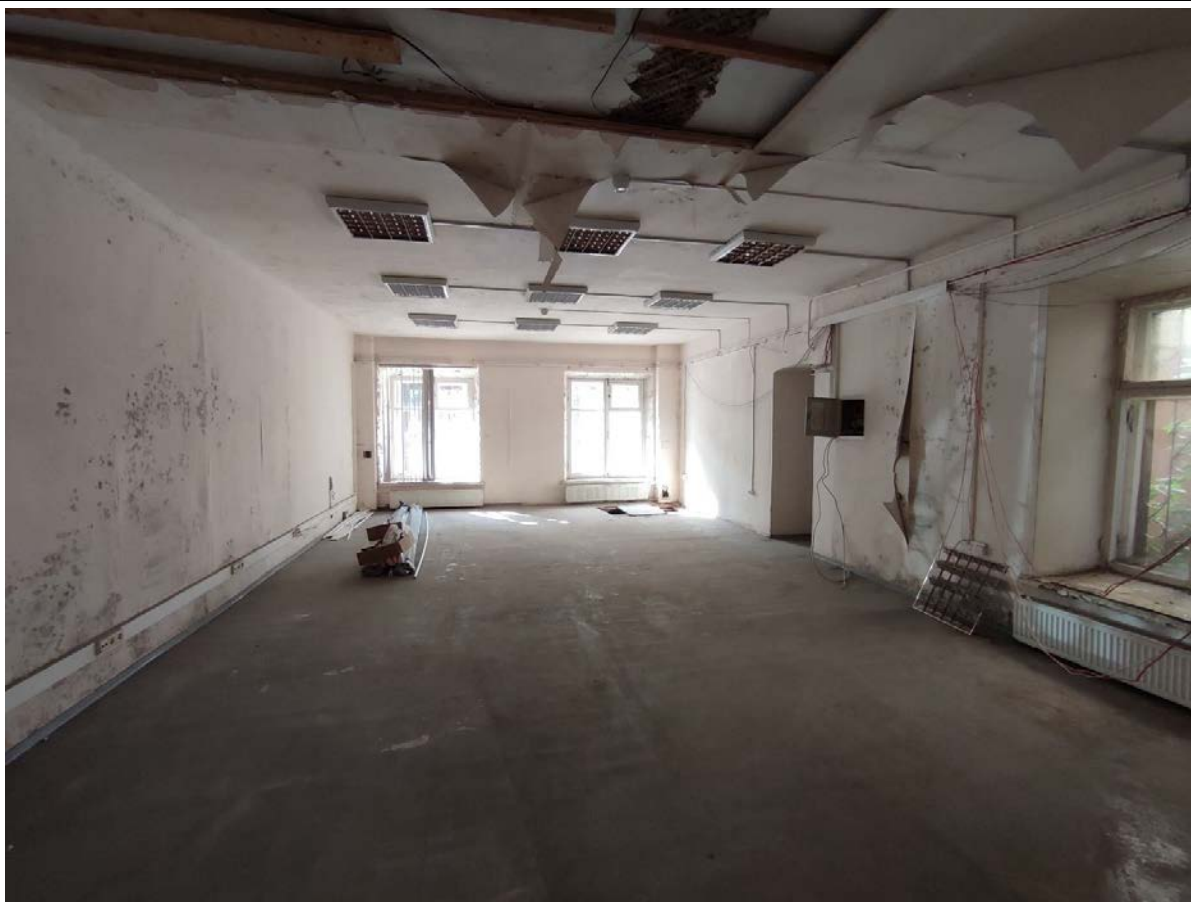
22. Общий вид пом. 13-Н (13) в уровне 1-го этажа.
