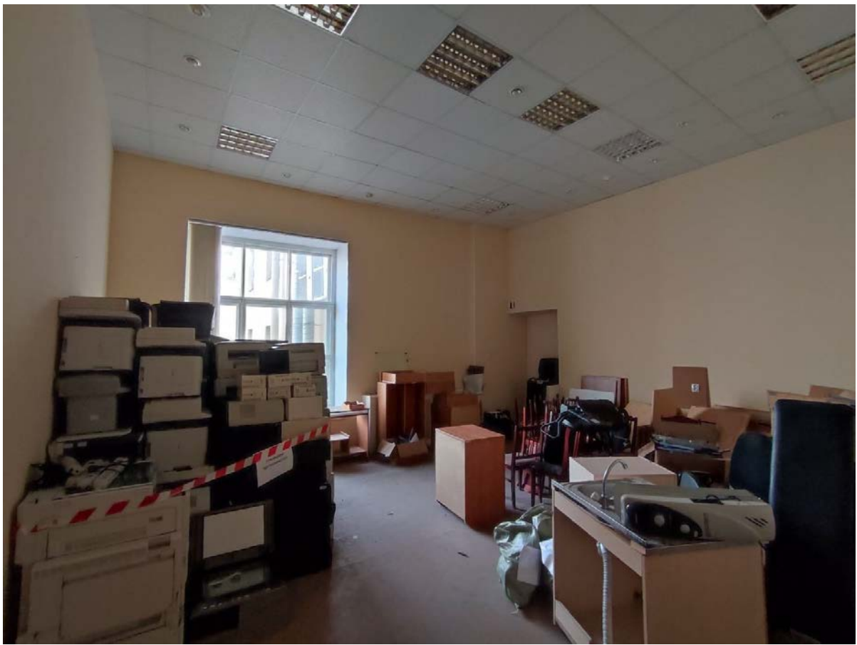
52. Общий вид пом. 31-Н (8) в уровне 2-го этажа.
