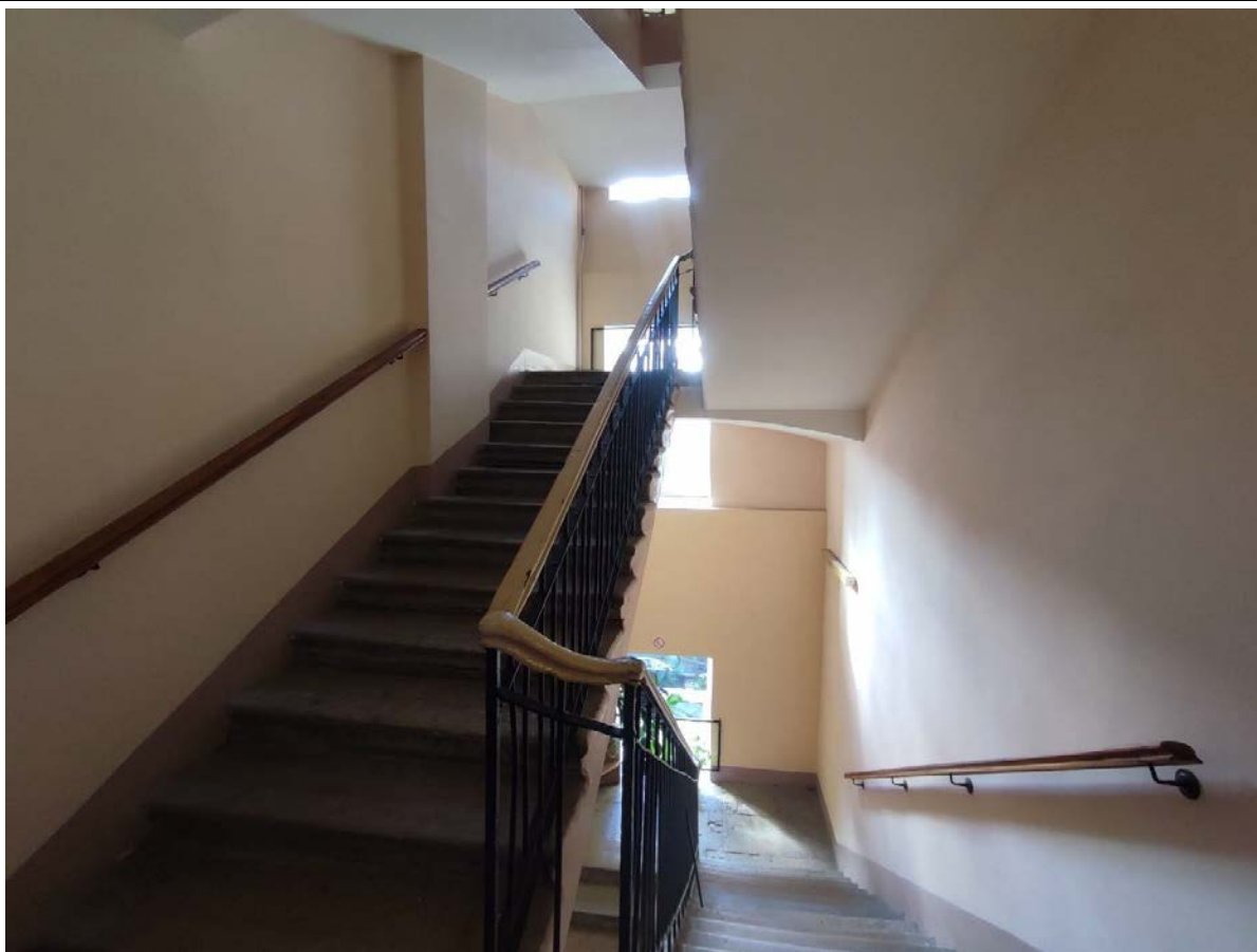
53. Общий вид лестничной клетки 2ЛК в уровне 3-го этажа.
