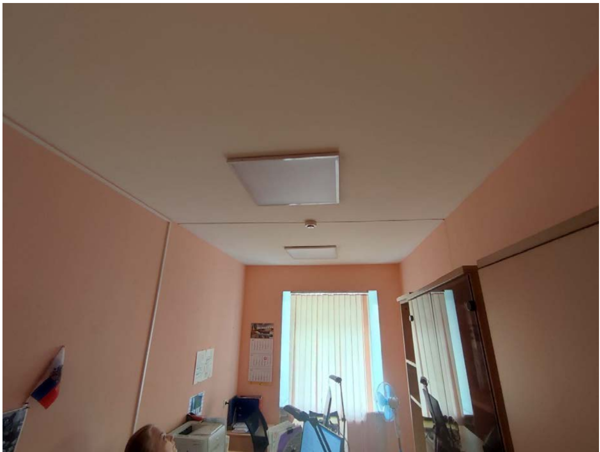
61. Общий вид пом. 20-Н (10) в уровне 3-го этажа.
