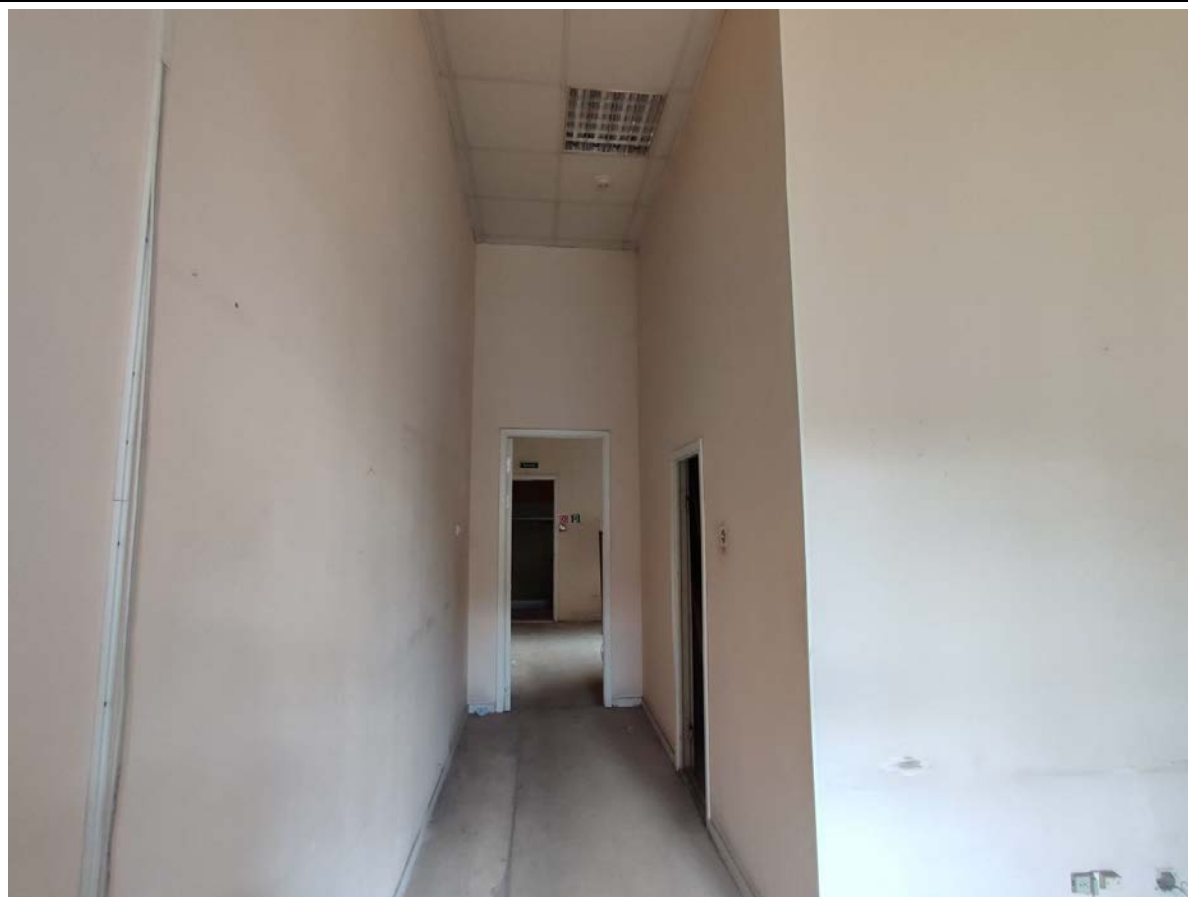
47. Фрагмент пом. 31-Н (3) в уровне 2-го этажа.
