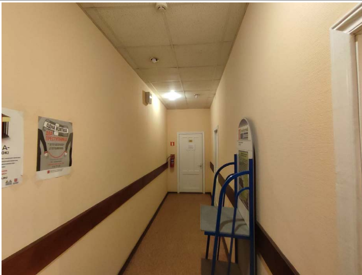
14. Общий вид пом. 55-Н (3) в уровне 1-го этажа.
