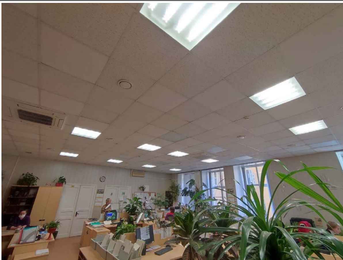
38. Общий вид пом. 27-Н (3) в уровне 2-го этажа.
