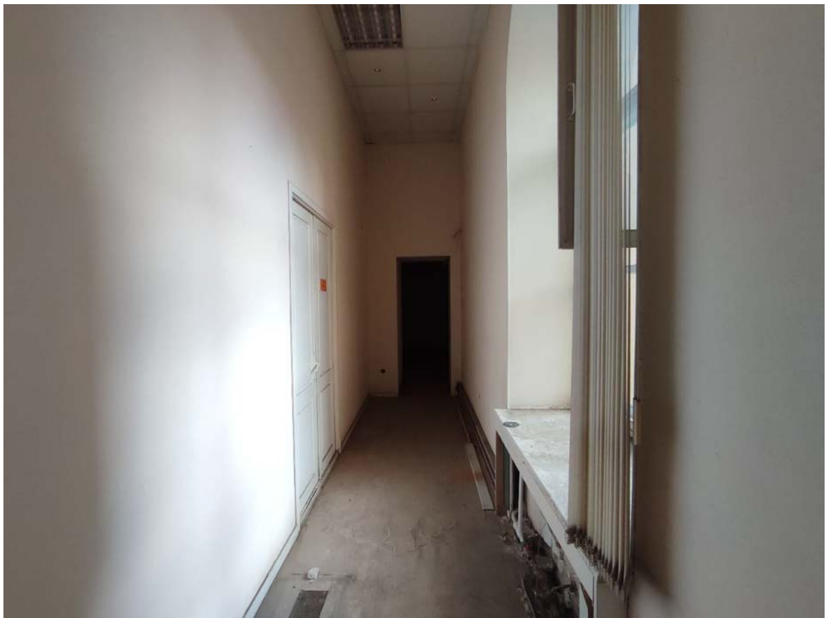
49. Общий вид пом. 31-Н (5) в уровне 2-го этажа.
