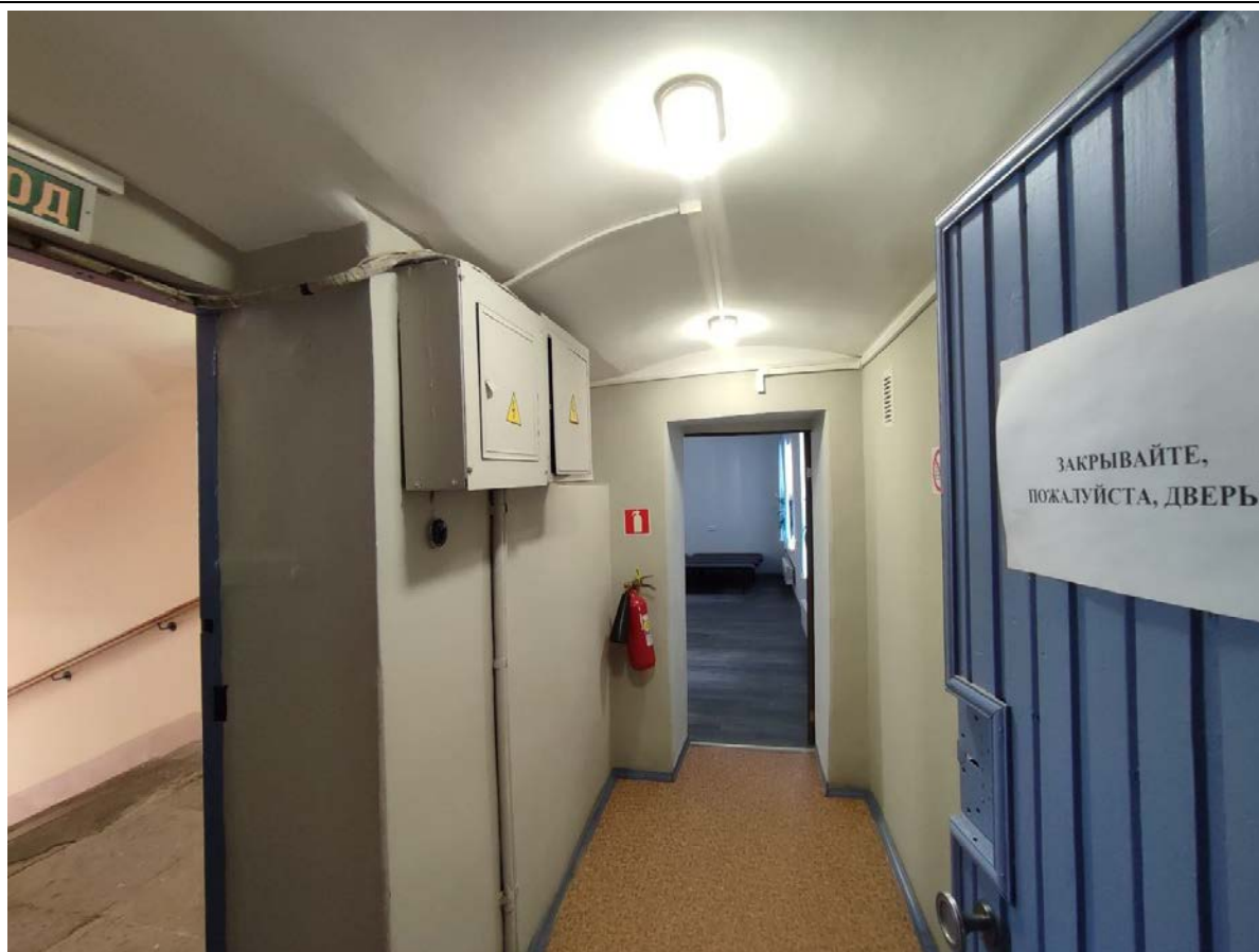
68. Общий вид пом. 25-Н (1) в уровне 4-го этажа.
