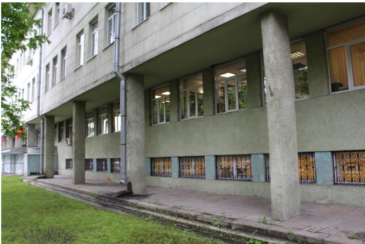
Фото 3. Вид на двенадцатипролетную галерею с северо-востока.
