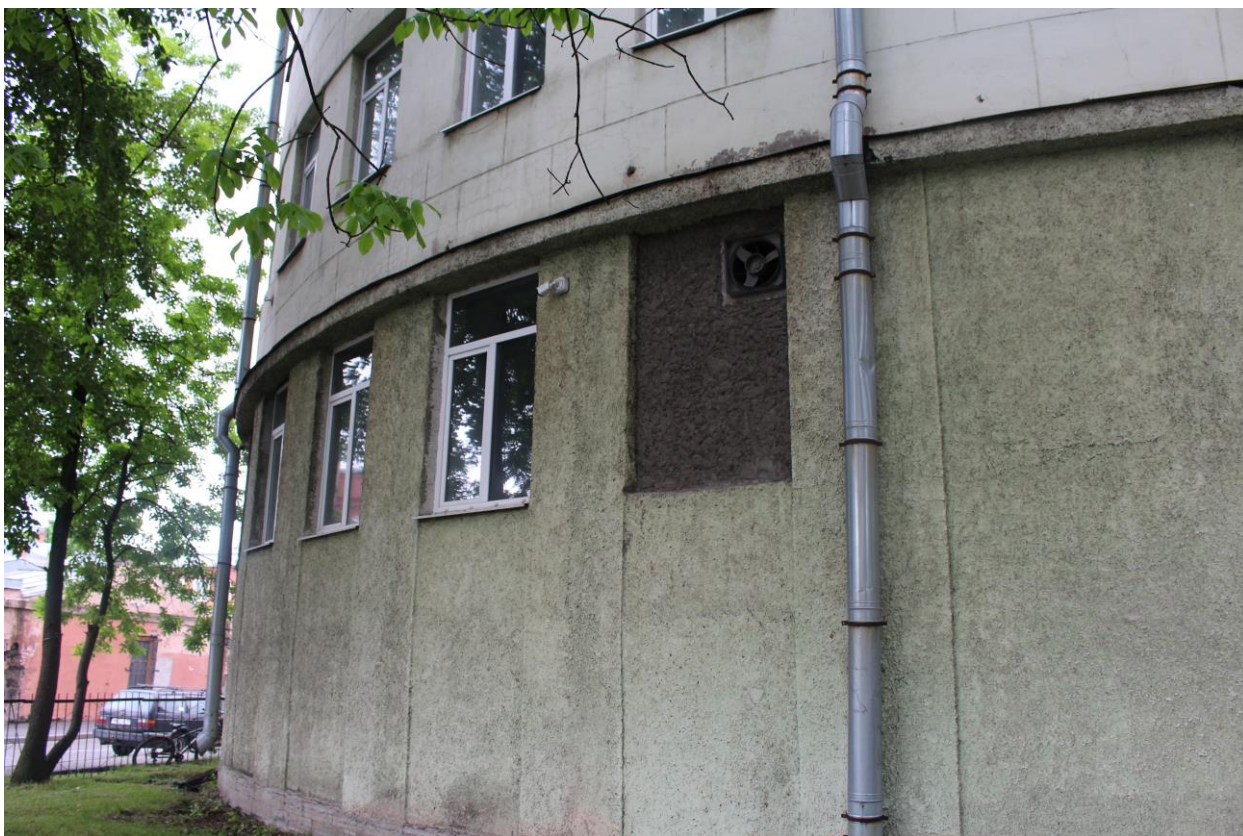
Фото 21. Вид на южный полукруглый ризалит объекта культурного наследия.
