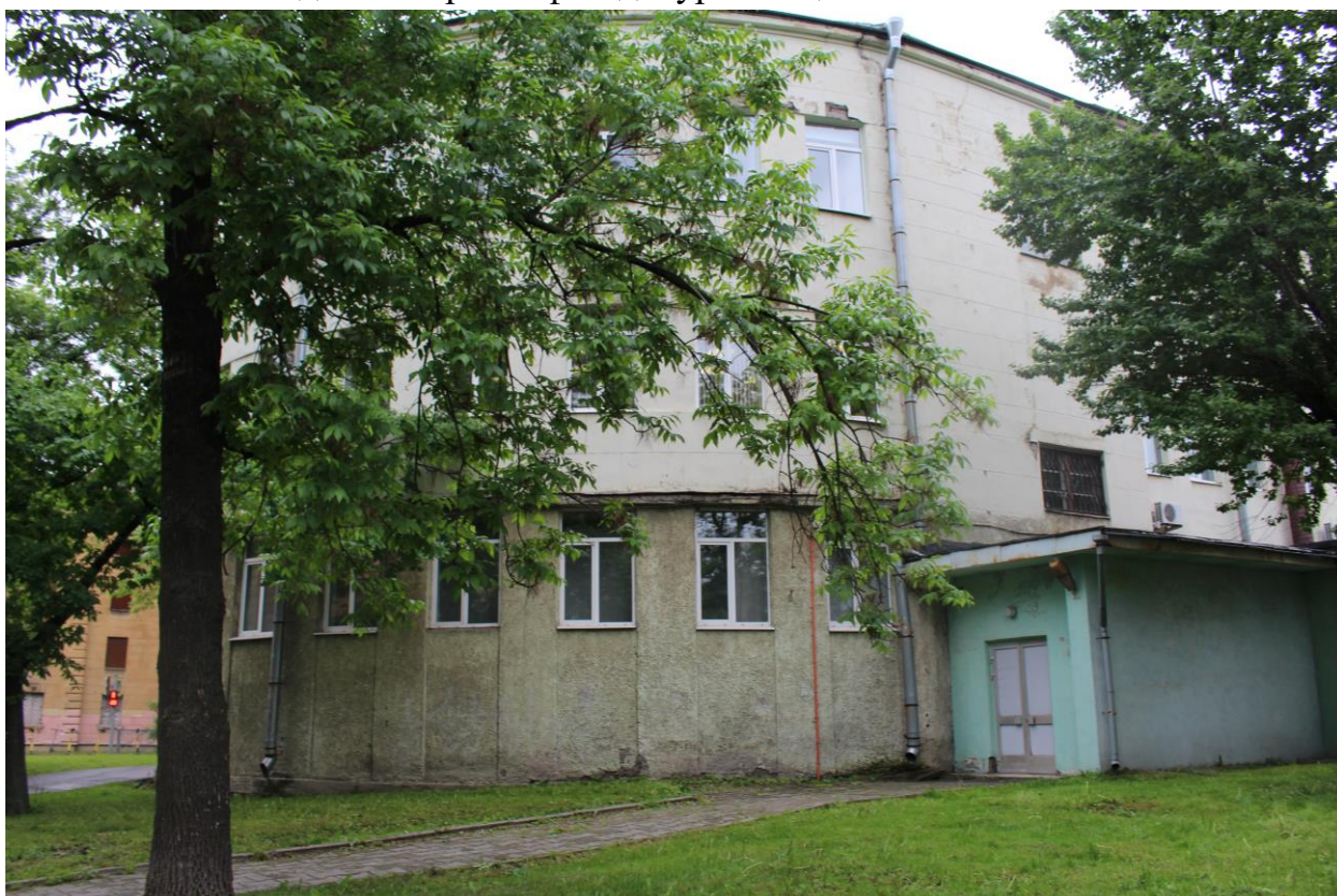
Фото 6. Вид на северо-западный угол основного объема здания.
