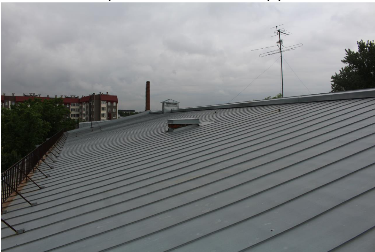
Фото 111. Вид на кровлю основного корпуса, вид на север.
