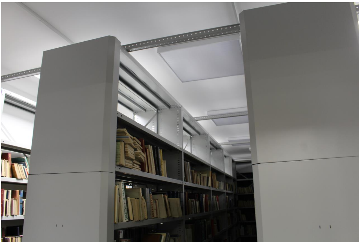
Фото 59. Вид на внутренние помещения 1-го этажа в северной части здания. Помещения библиотеки.
