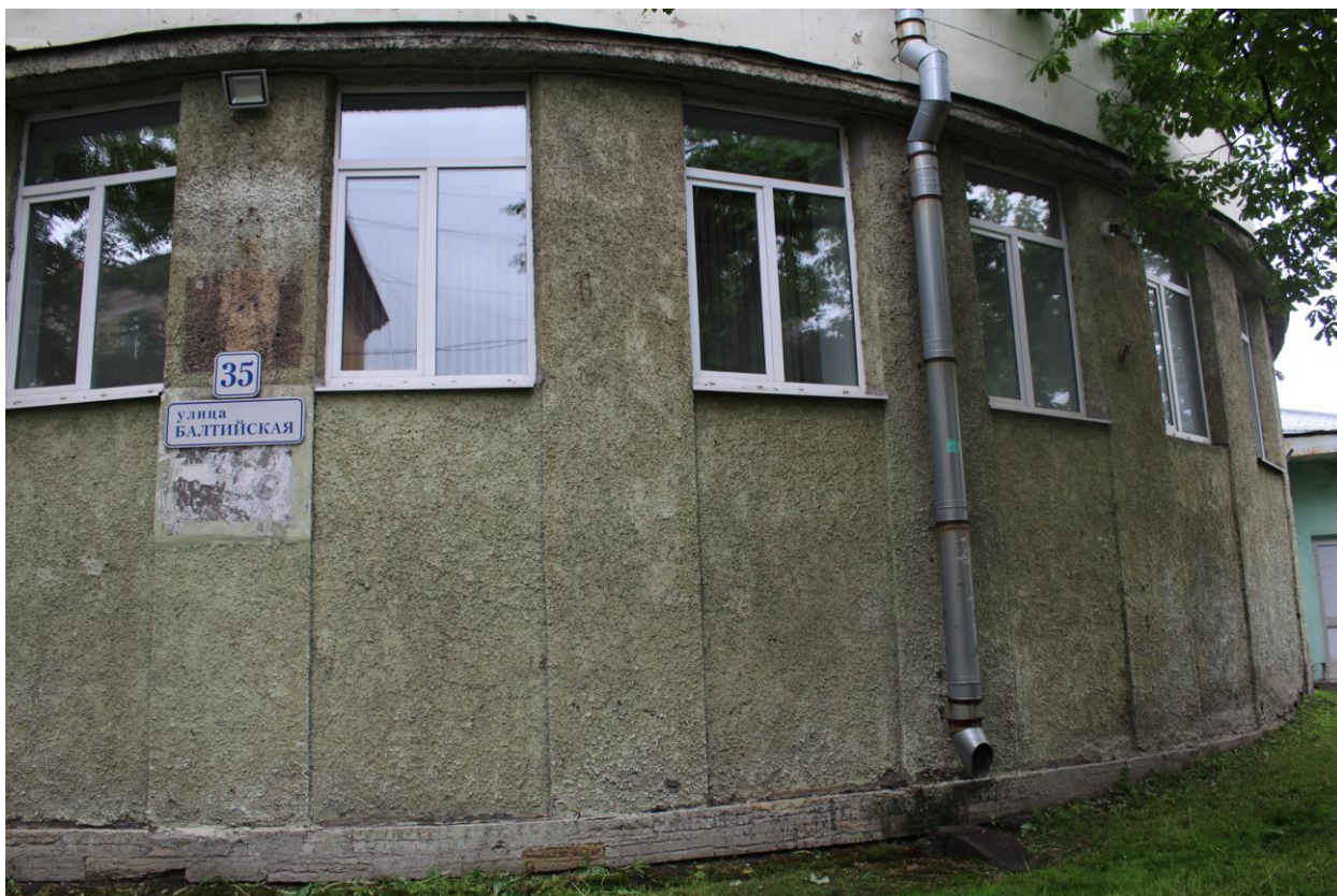
Фото 5. Вид на северный фасад в уровне цокольного и 1-го этажей.
