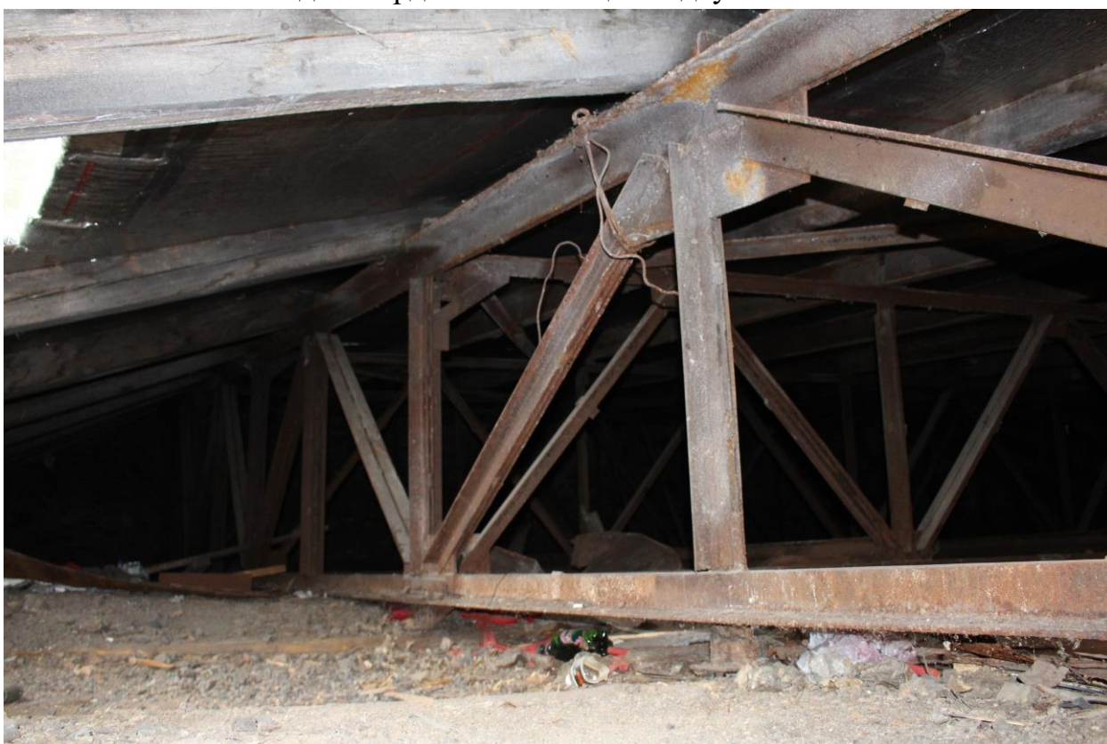
Фото 79. Вид на чердачные помещения двухэтажного объема.
