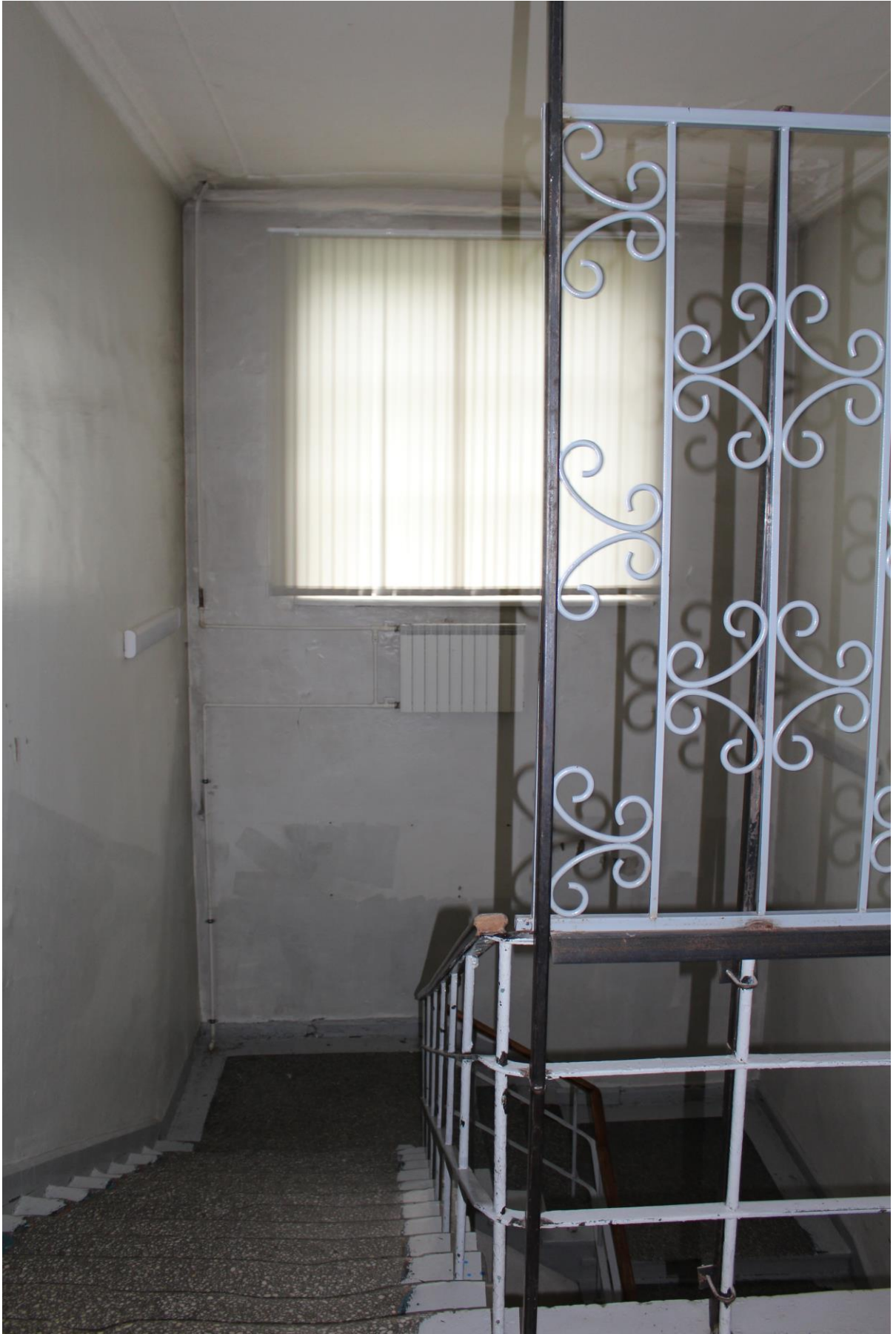
Фото 99. Вид на северную лестницу в уровне 3-го этажа.
