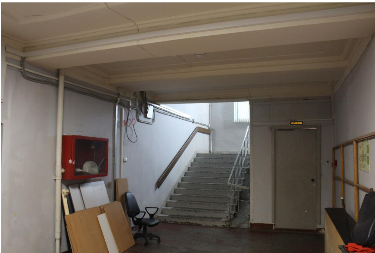
Фото 35. Вид на южную лестницу из помещений цокольного этажа.
