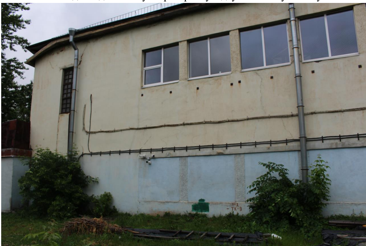
Фото 14. Вид на двухэтажный объем с юга.
