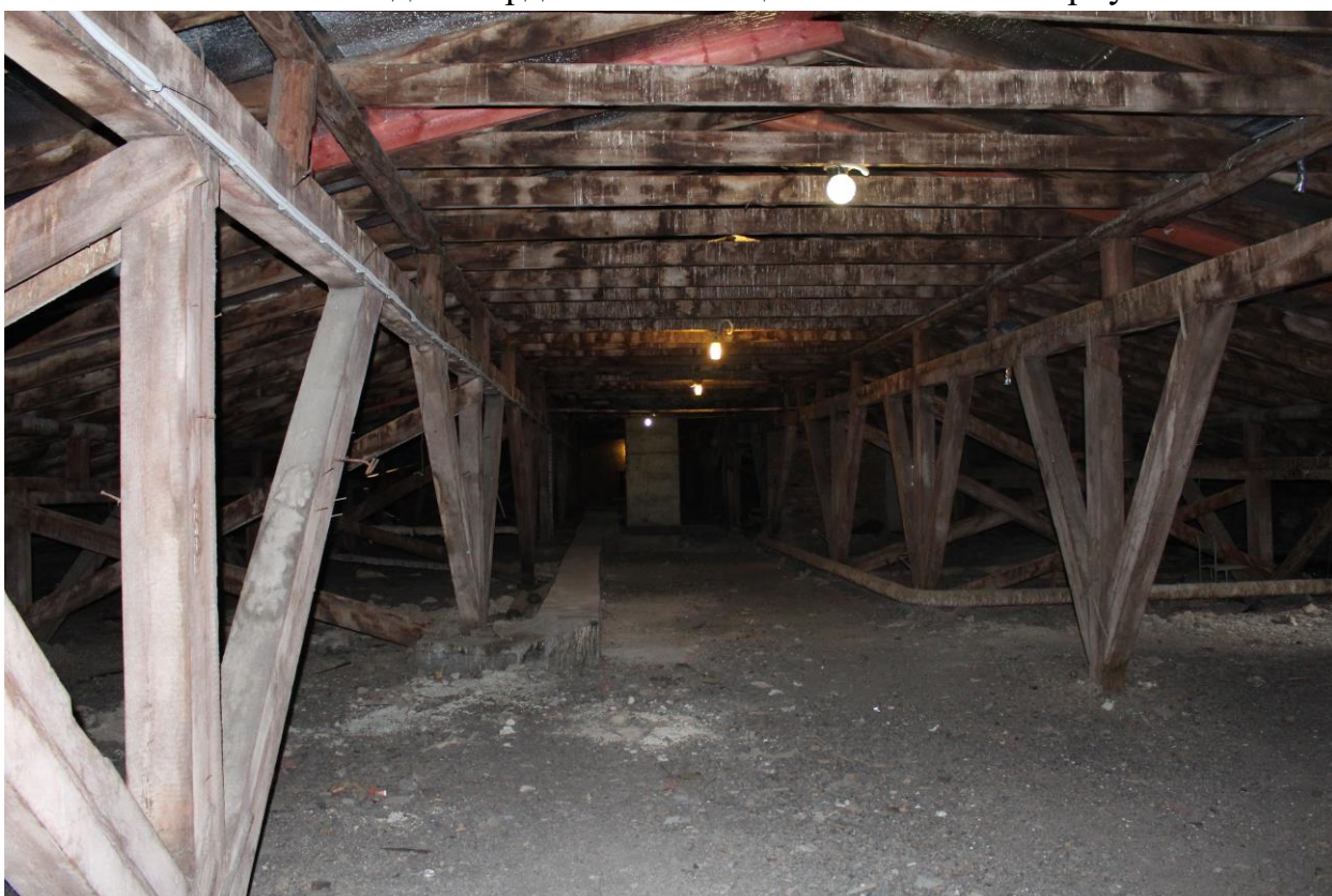
Фото 107. Вид на чердачные помещения основного корпуса.
