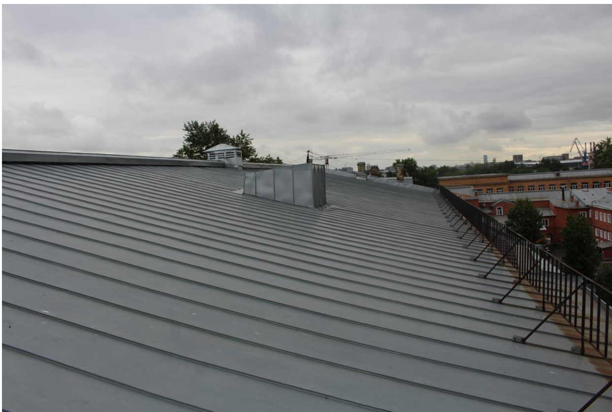
Фото 112. Вид на кровлю основного корпуса, вид на юг.
