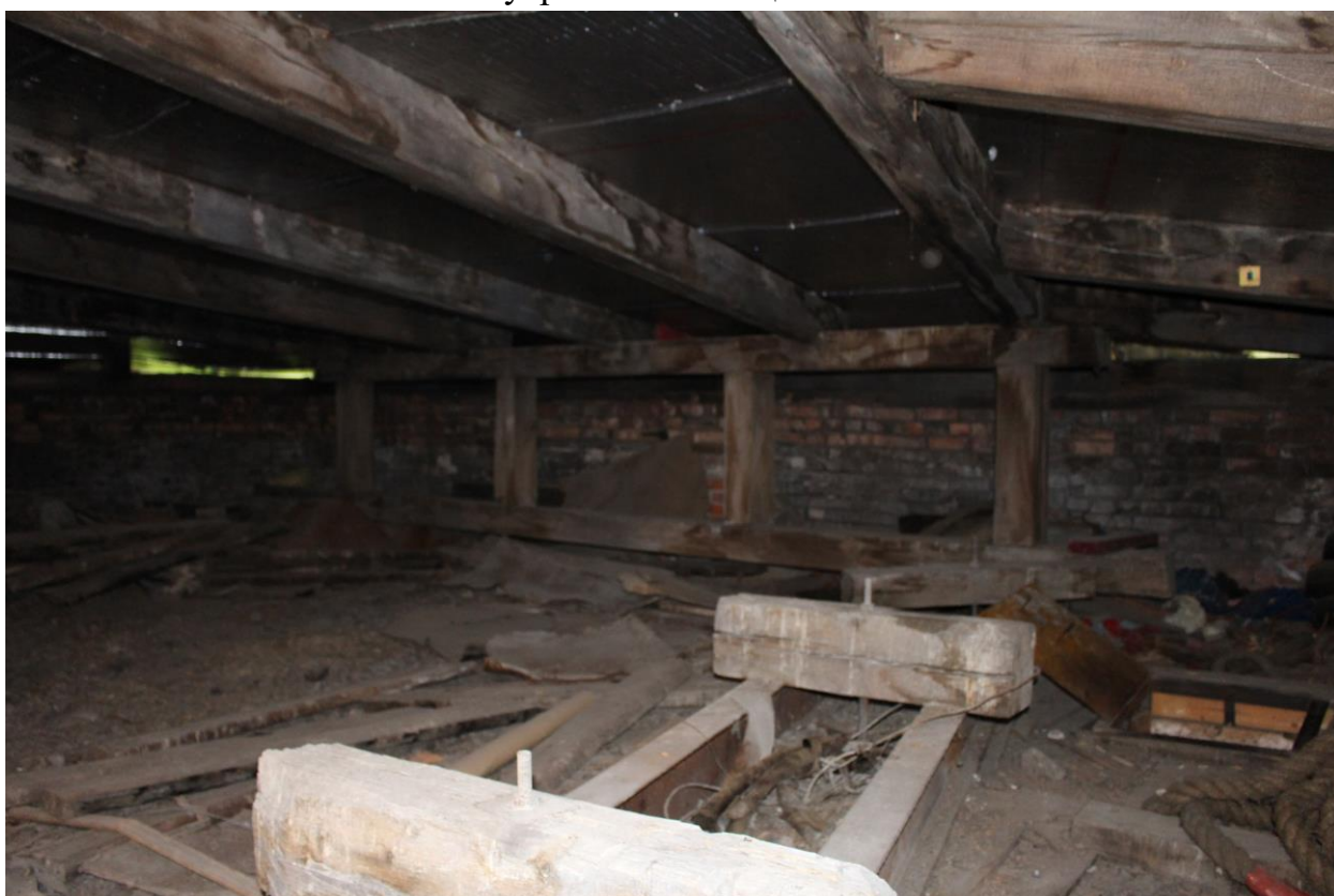
Фото 77. Вид на чердачные помещения двухэтажного объема.
