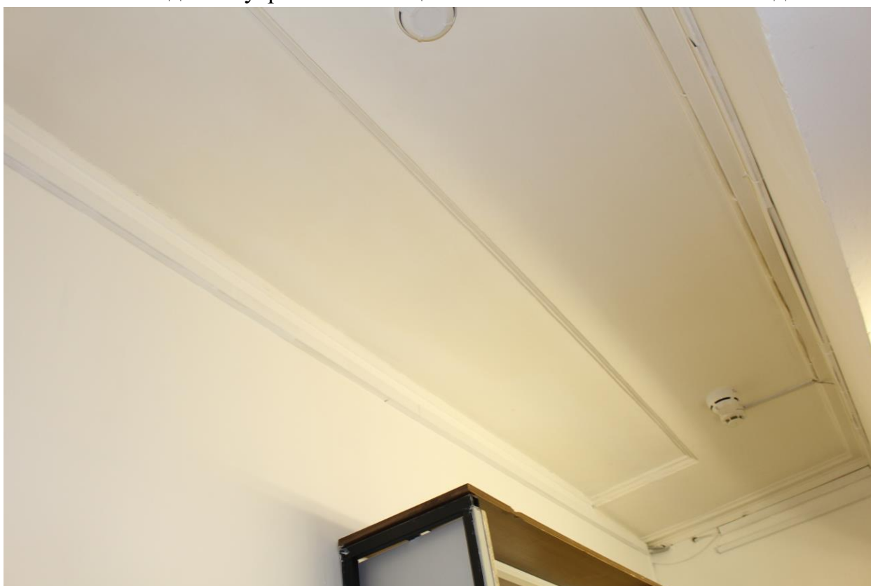
Фото 50. Вид на внутренние помещения 1-го этажа в южной части здания.
