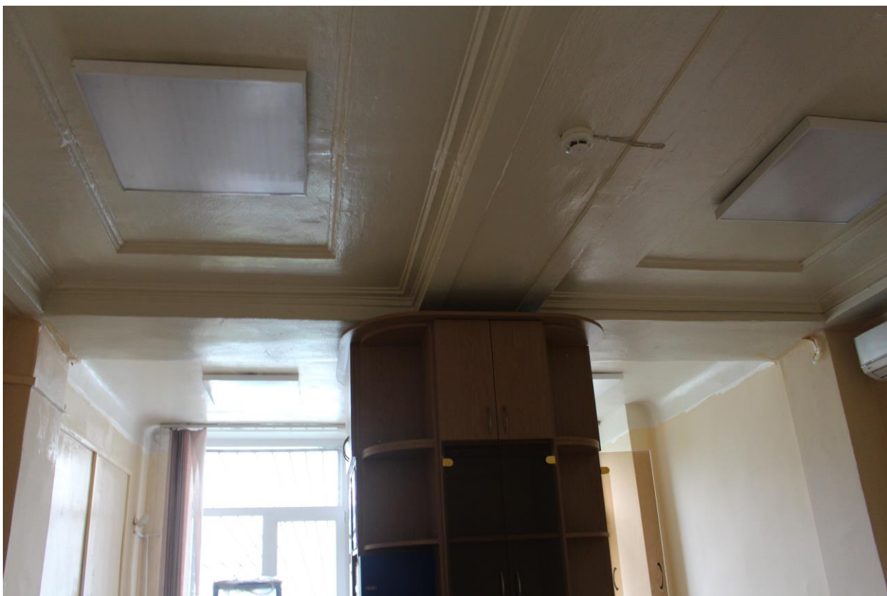
Фото 47. Вид на внутренние помещения 1-го этажа в южной части здания.
