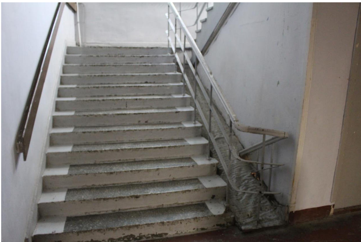
Фото 95. Вид на южную лестницу в уровне 1-го этажа.
