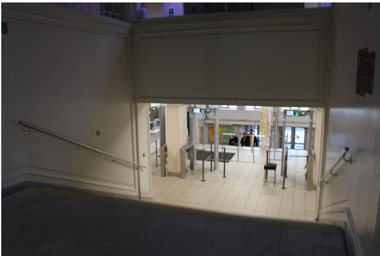
Фото 66. Вид на вестибюль из главной лестницы.
