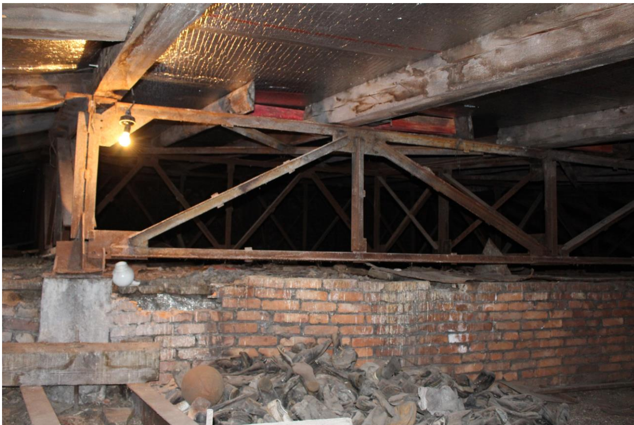
Фото 78. Вид на чердачные помещения двухэтажного объема.
