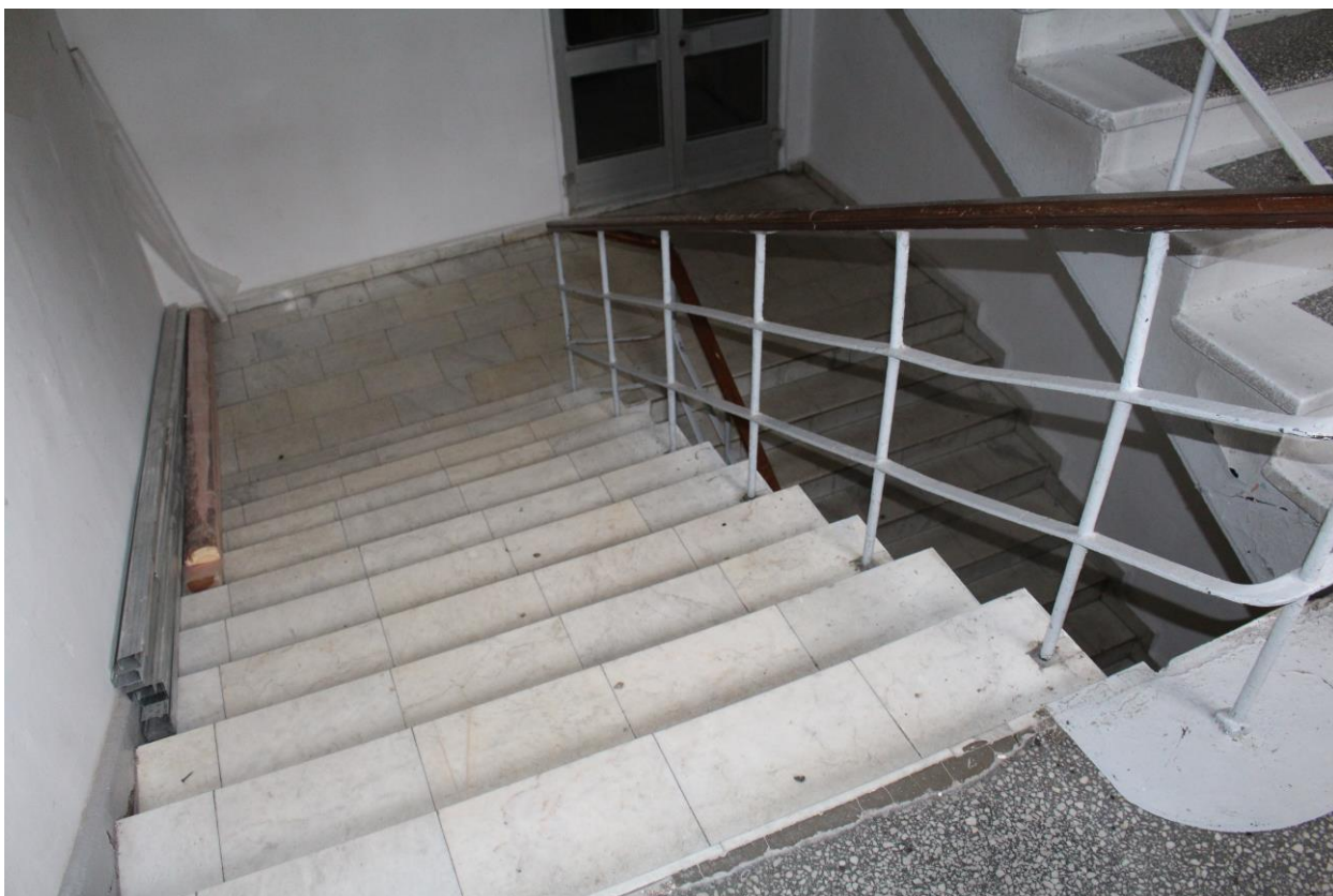
Фото 102. Вид на северную лестницу в уровне 1-го этажа.
