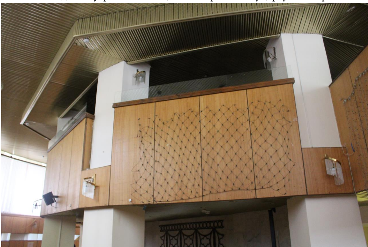
Фото 31. Вид на внутреннее помещение северного полуциркульного ризалита.
