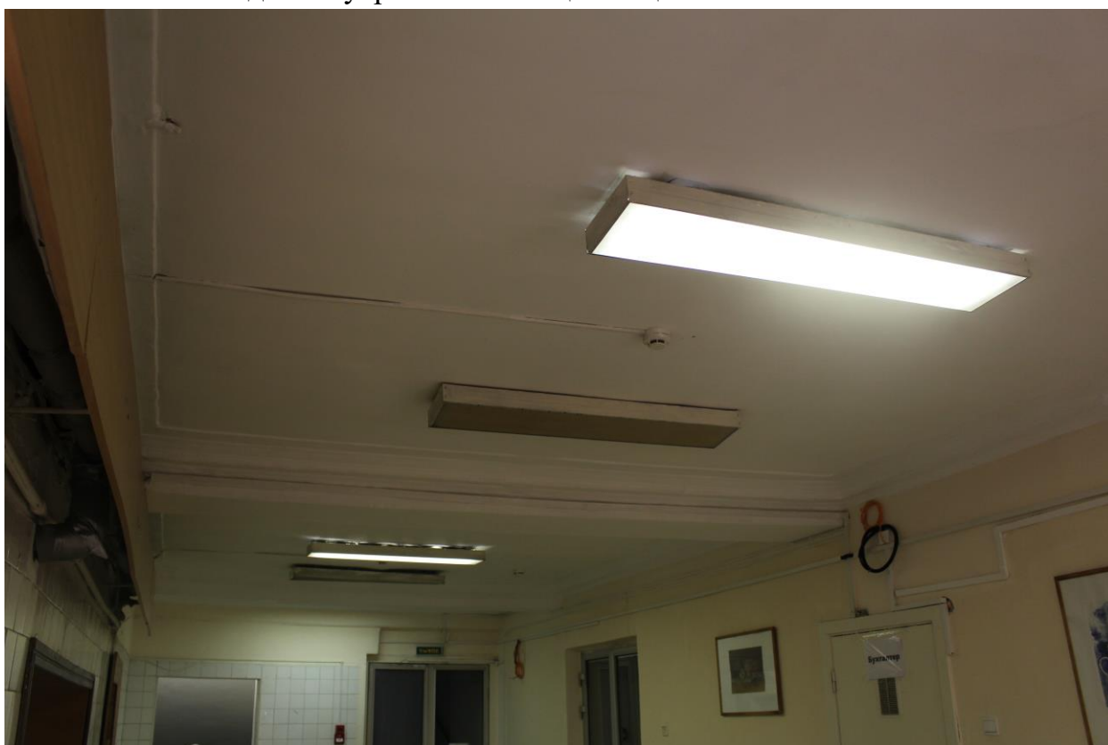
Фото 29. Вид на южное помещение в северном ризалите.
