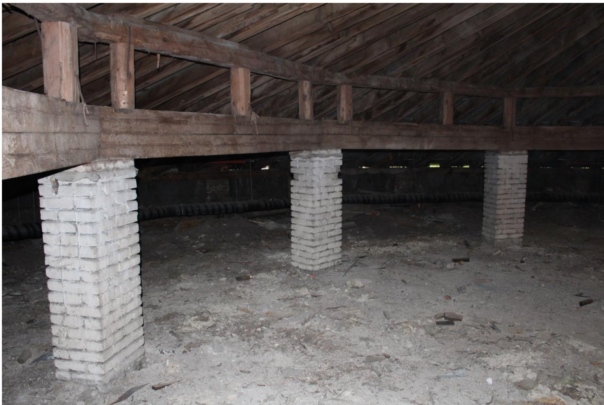
Фото 104. Вид на чердачные помещения основного корпуса. Северная часть.
