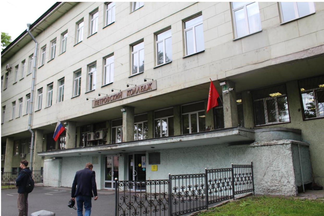
Фото 2. Вид на центральную часть восточного (лицевого) фасада объекта культурного наследия.
