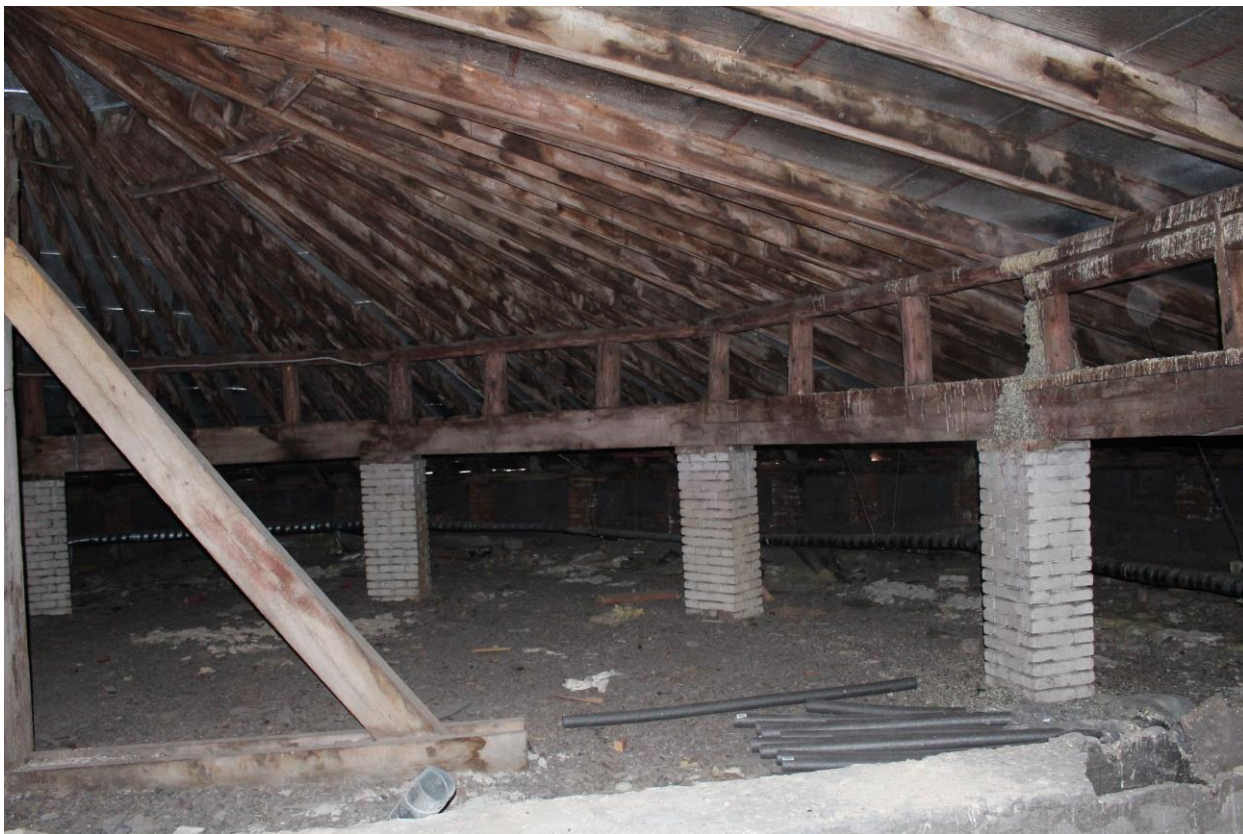
Фото 110. Вид на чердачные помещения основного корпуса. Южная часть.
