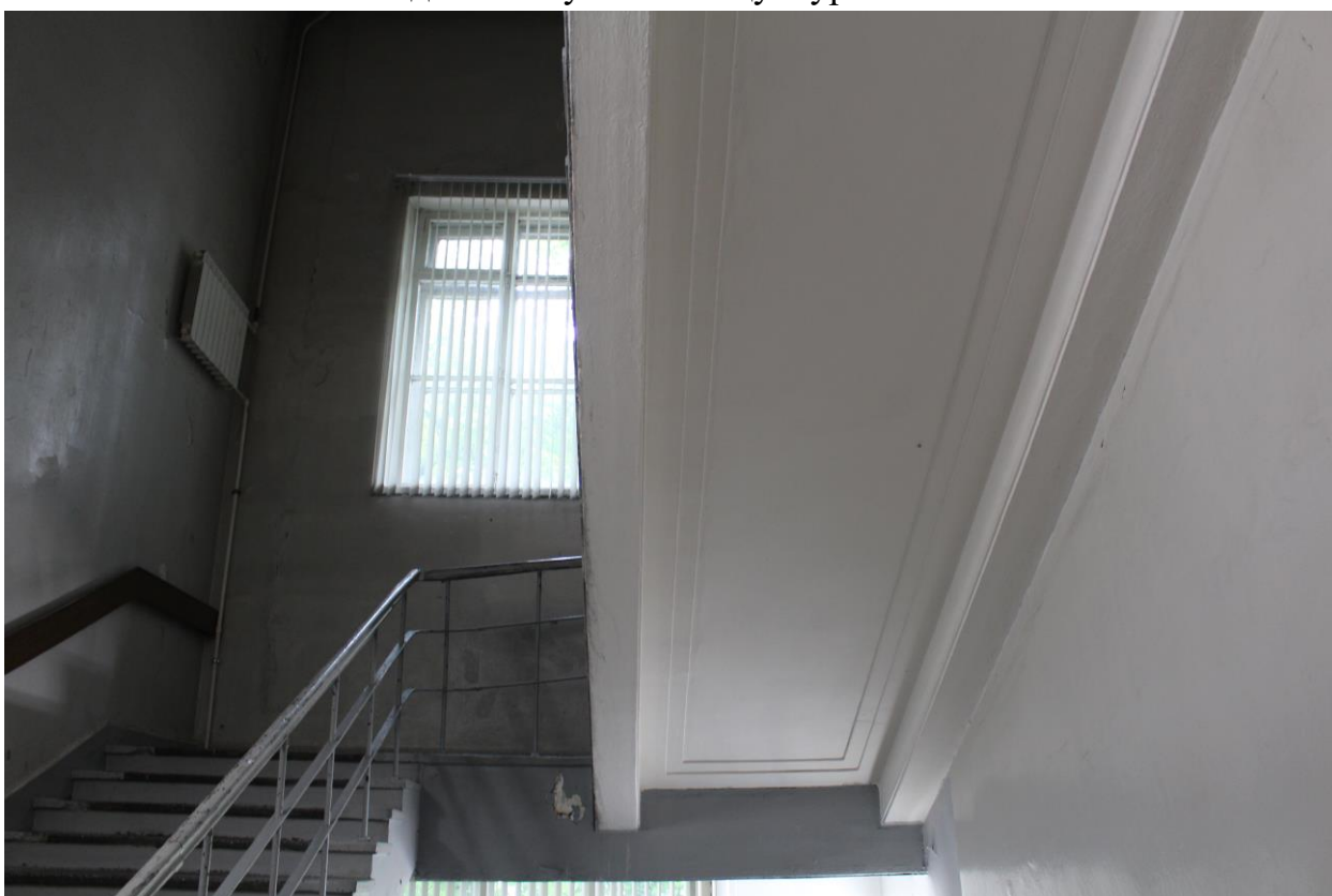
Фото 96. Вид на южную лестницу в уровне 2-го – 3-го этажей.
