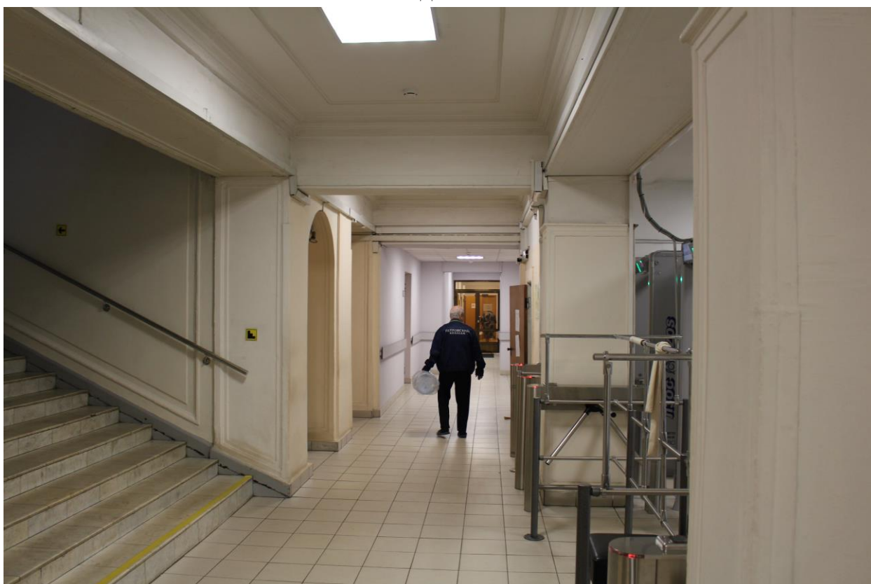
Фото 38. Вид на внутренние помещения 1-го этажа. Северный коридор.
