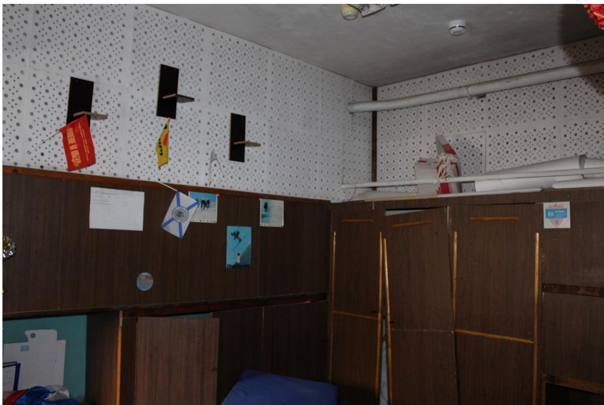
Фото 76. Внутренние помещения 2-го этажа.
