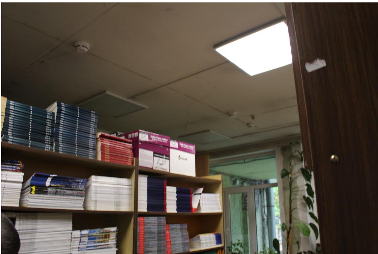
Фото 58. Вид на внутренние помещения 1-го этажа в северной части здания. Помещения библиотеки.
