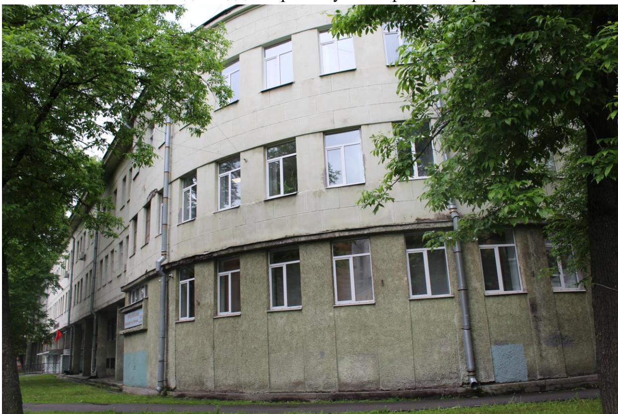
Фото 4. Вид на северный фасад объекта культурного наследия.
