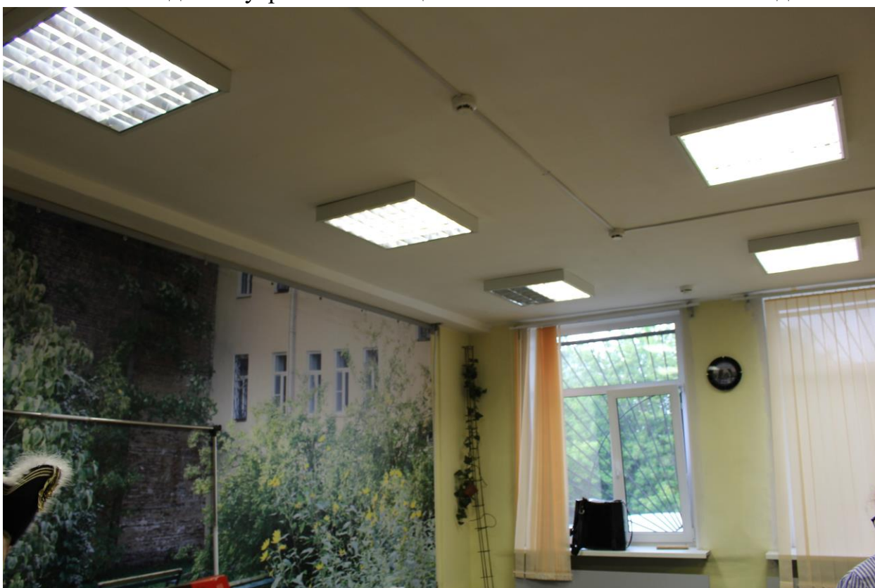
Фото 42. Вид на внутренние помещения 1-го этажа в южной части здания.
