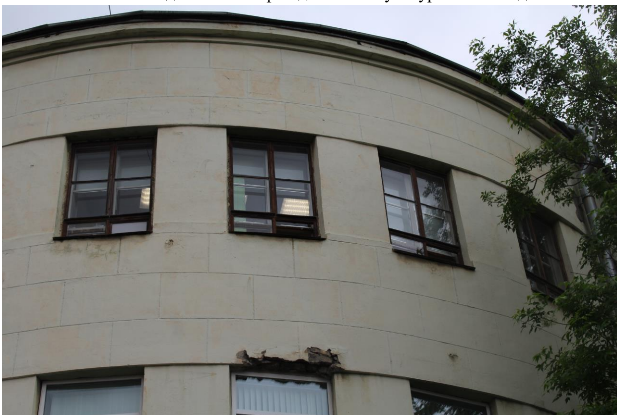
Фото 20. Вид на оконные проемы в уровне 3-го этажа на южном фасаде объекта культурного наследия.
