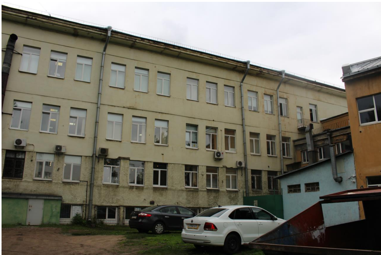
Фото 9. Вид на западный фасад объекта культурного наследия (северная часть).
