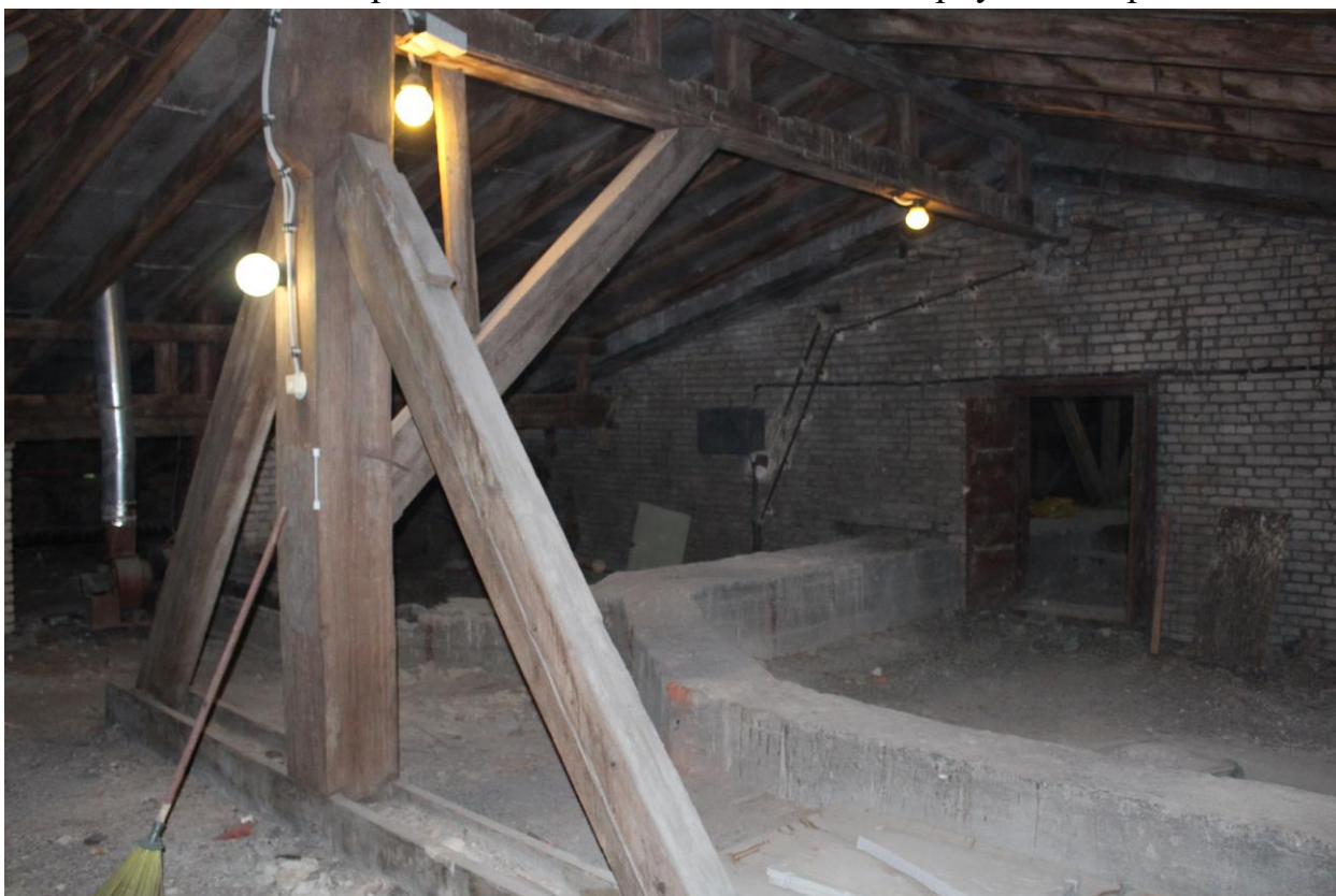
Фото 105. Вид на чердачные помещения основного корпуса. Северная часть.
