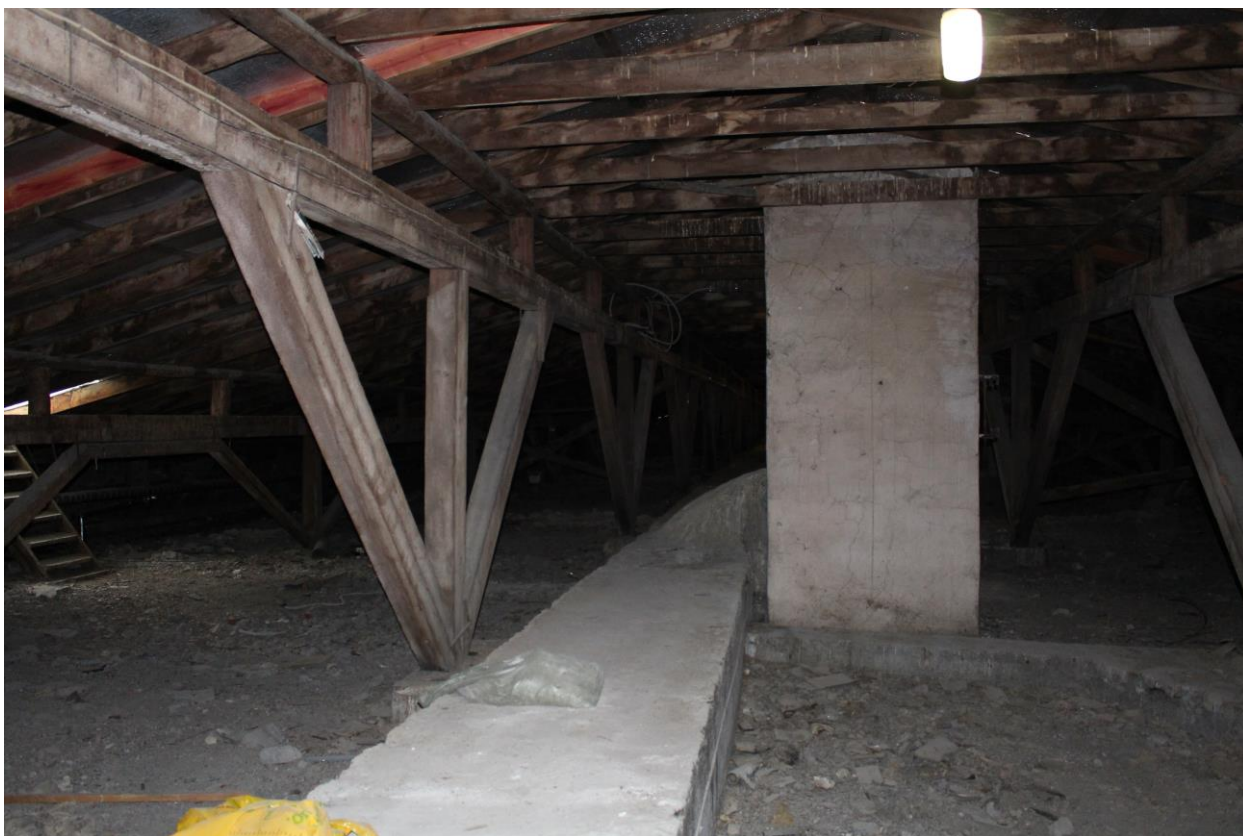
Фото 106. Вид на чердачные помещения основного корпуса.
