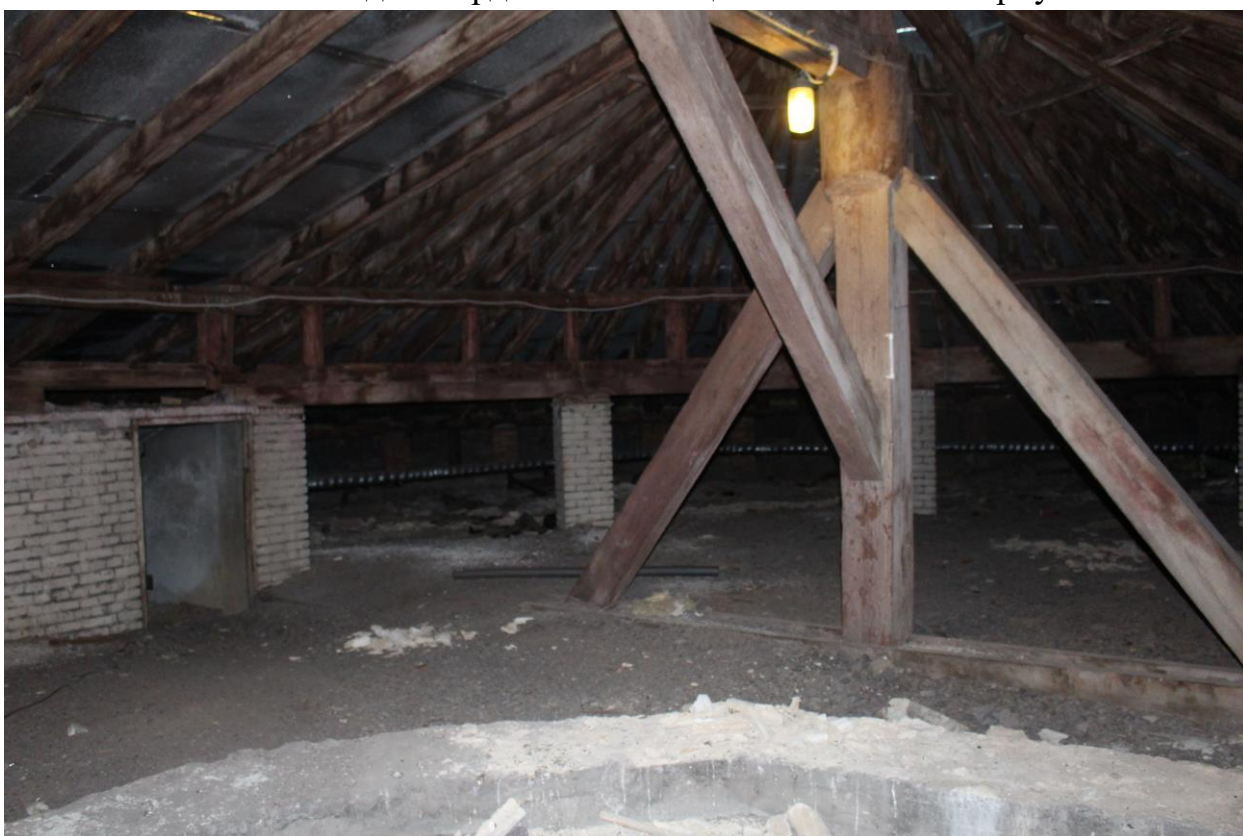
Фото 109. Вид на чердачные помещения основного корпуса. Южная часть.
