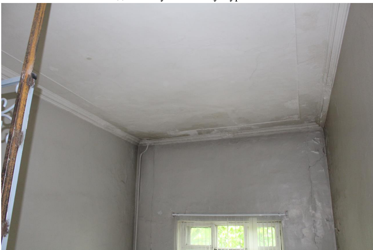
Фото 98. Вид на южную лестницу в уровне 3-го этажа.
