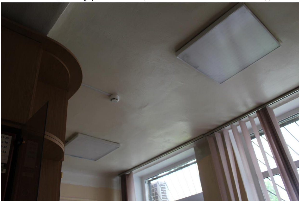
Фото 48. Вид на внутренние помещения 1-го этажа в южной части здания.
