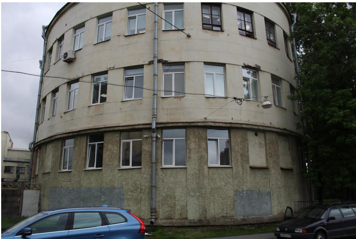
Фото 19. Вид на южный фасад объекта культурного наследия.
