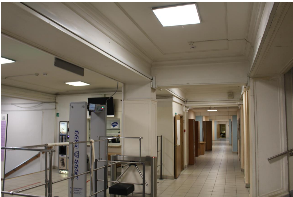
Фото 39. Вид на внутренние помещения 1-го этажа. Южный коридор.
