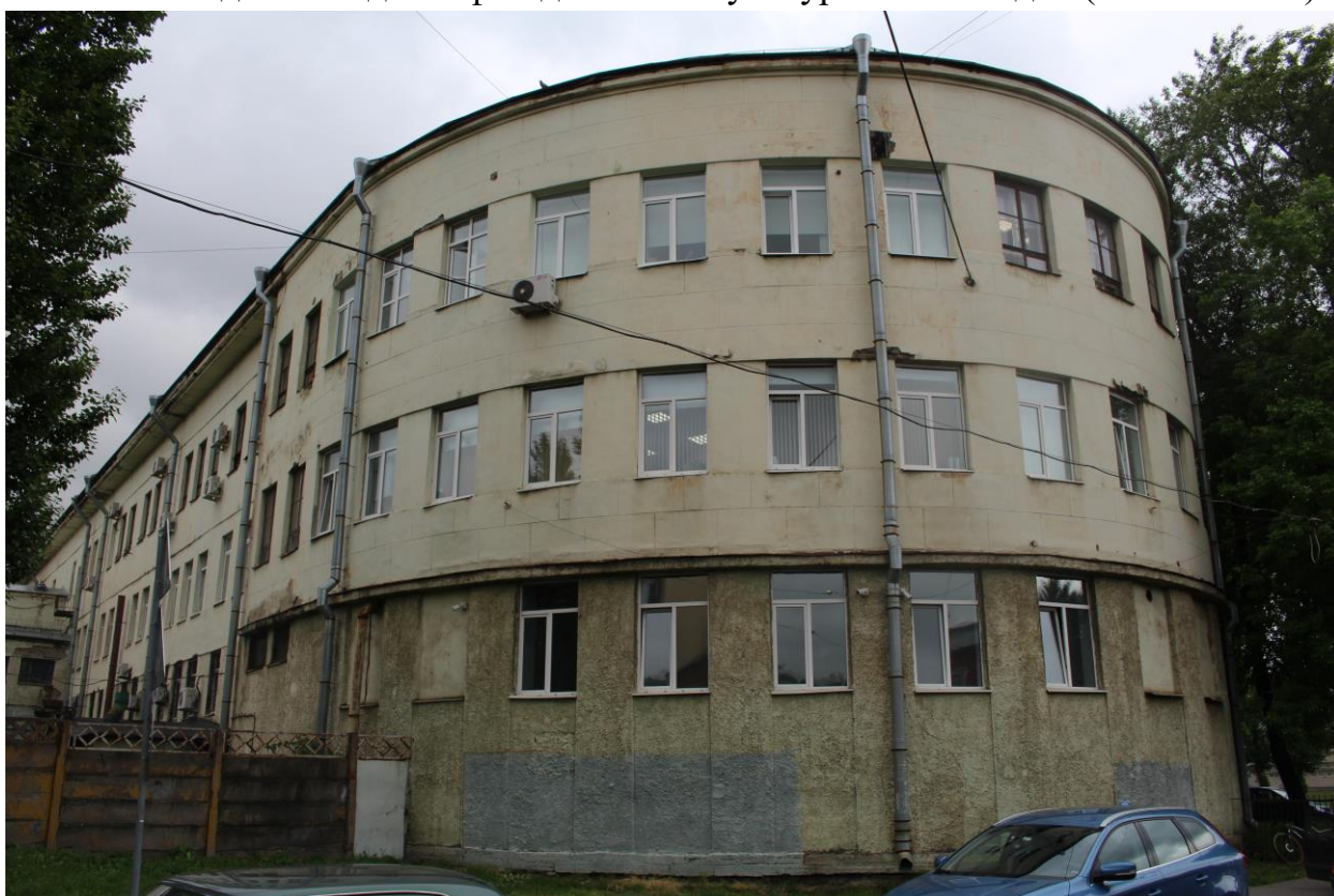
Фото 18. Вид на южный фасад объекта культурного наследия.
