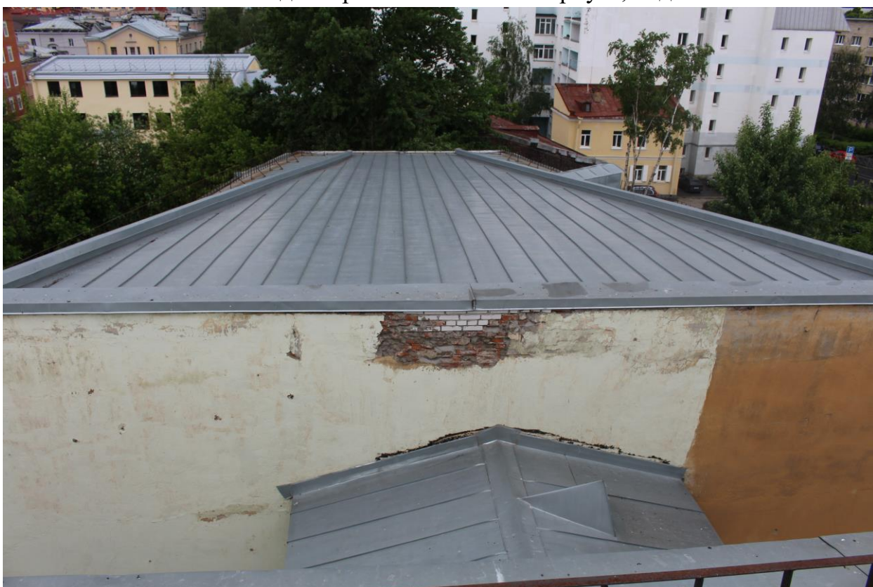
Фото 113. Вид на кровлю двухэтажного корпуса.
