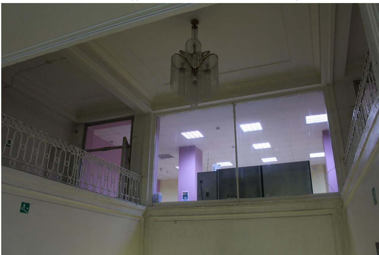
Фото 67. Вид на потолок главной лестницы.
