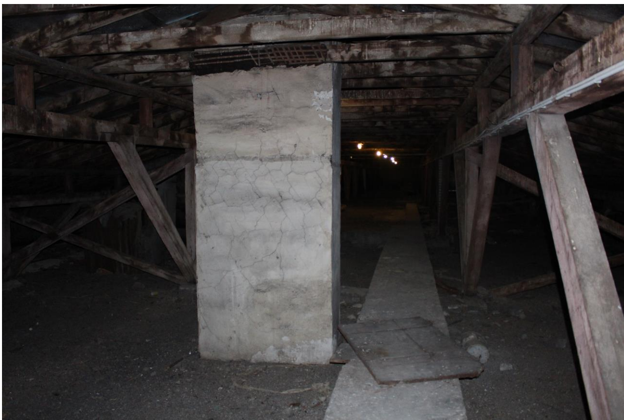
Фото 108. Вид на чердачные помещения основного корпуса.
