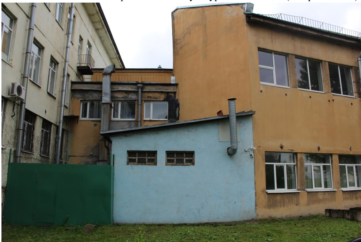
Фото 10. Вид на примыкающий к основному корпусу двухэтажный объем с севера.
