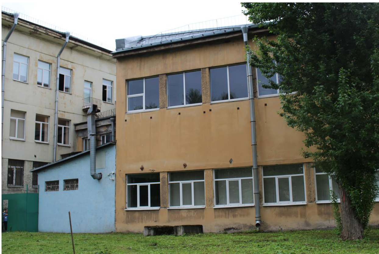
Фото 11. Вид на примыкающий к основному корпусу двухэтажный объем с севера.
