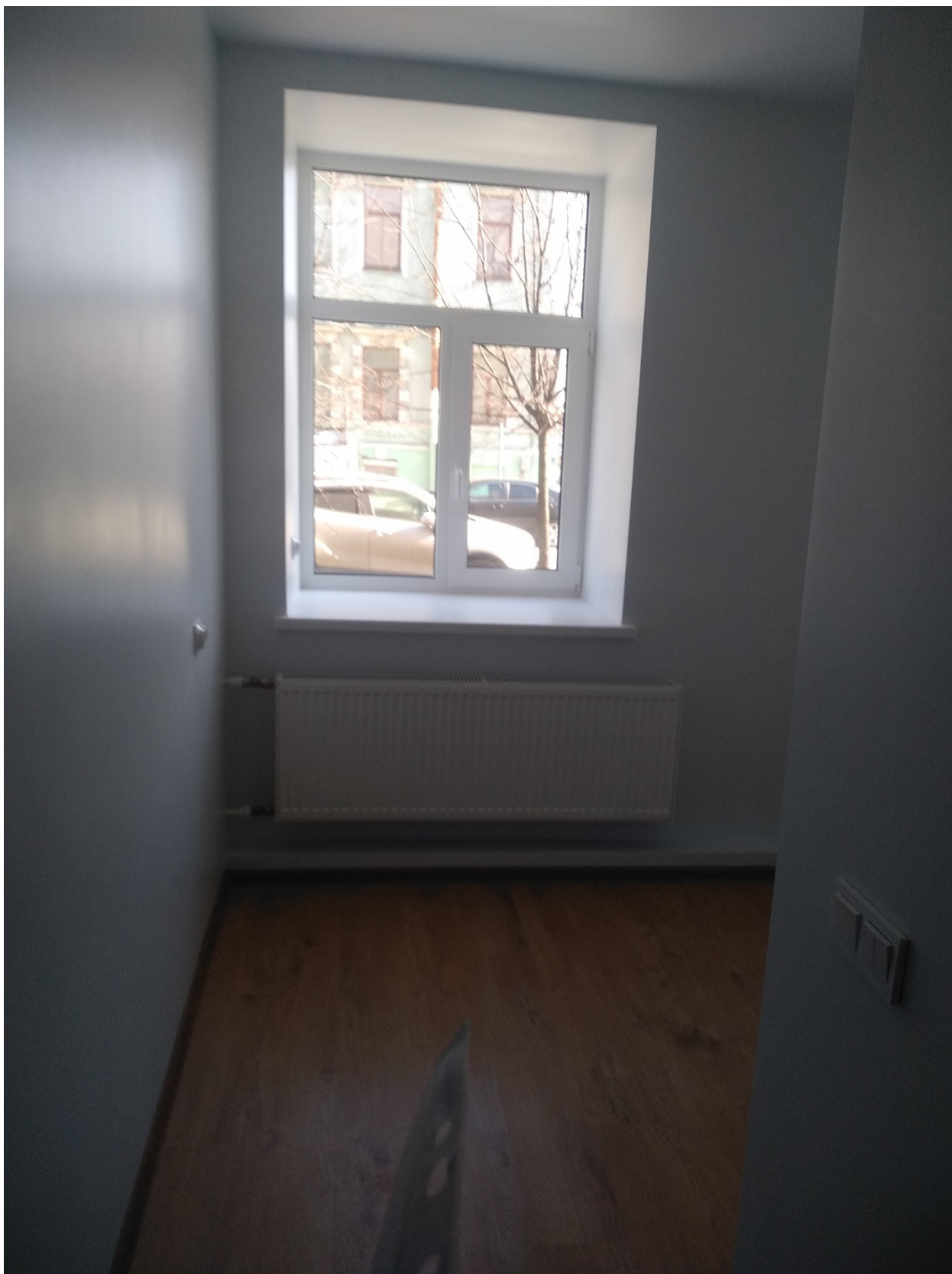
15. Фрагмент интерьера комнаты помещение (№10);
