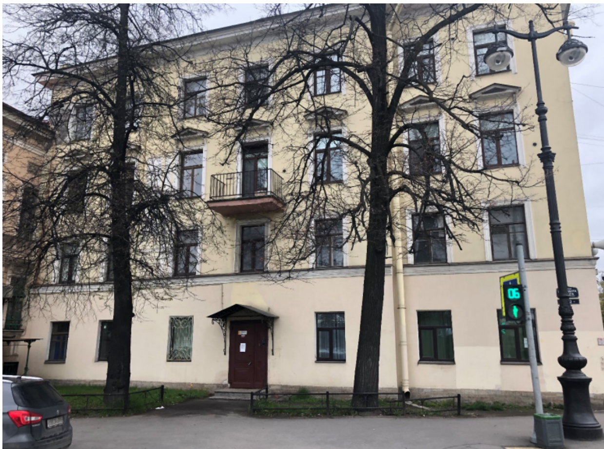
1. Вид на фасад здания с наб. Лейтенанта Шмидта;
