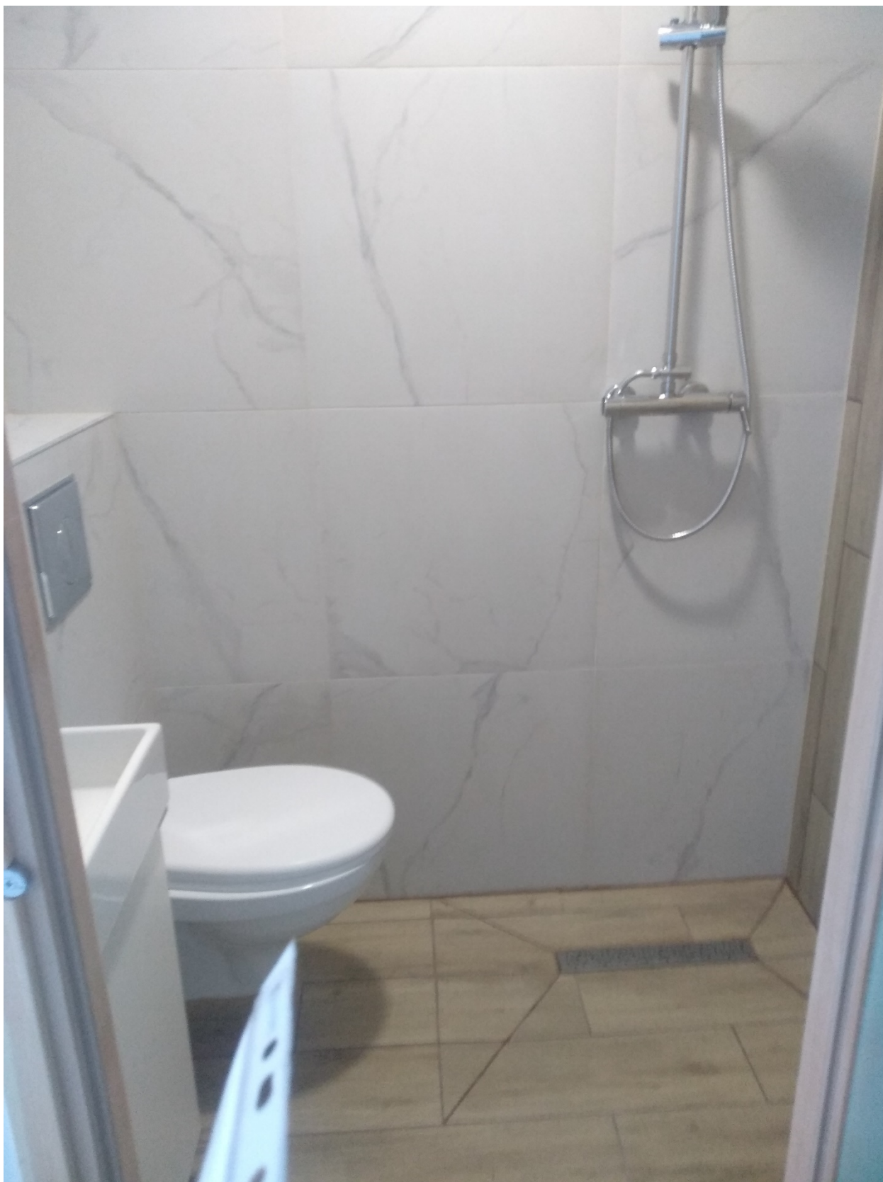
16.Фрагмент интерьера совмещенного санузла помещение (№11)
