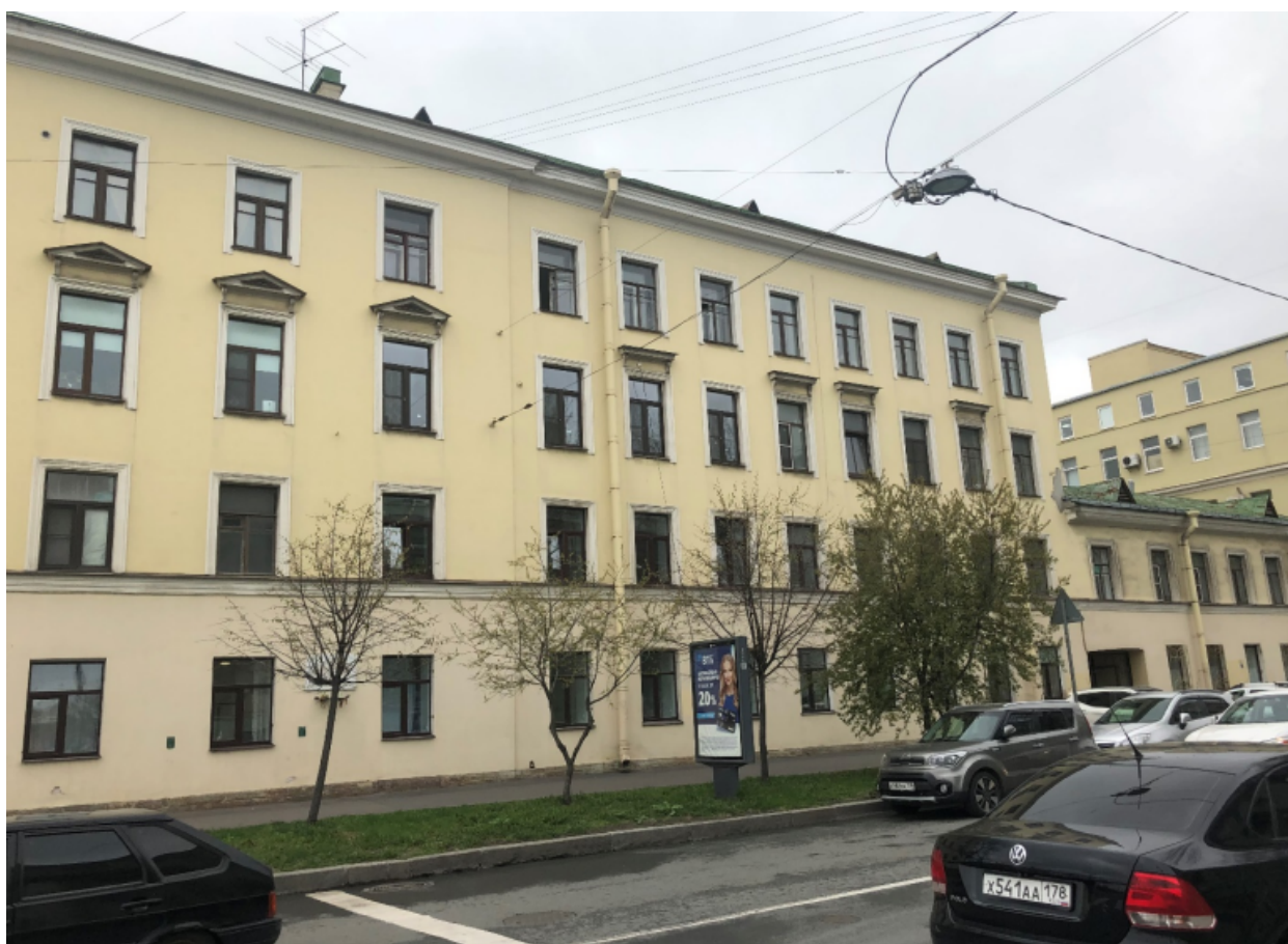
2. Вид на фасад здания с 17-ой линии В.О.;
