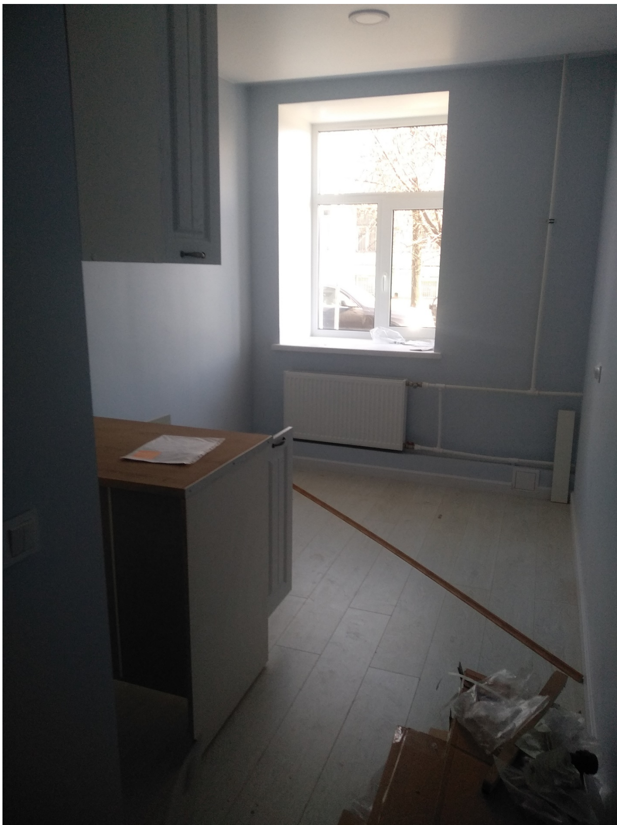
13. Фрагмент интерьера комнаты помещение (№12);
