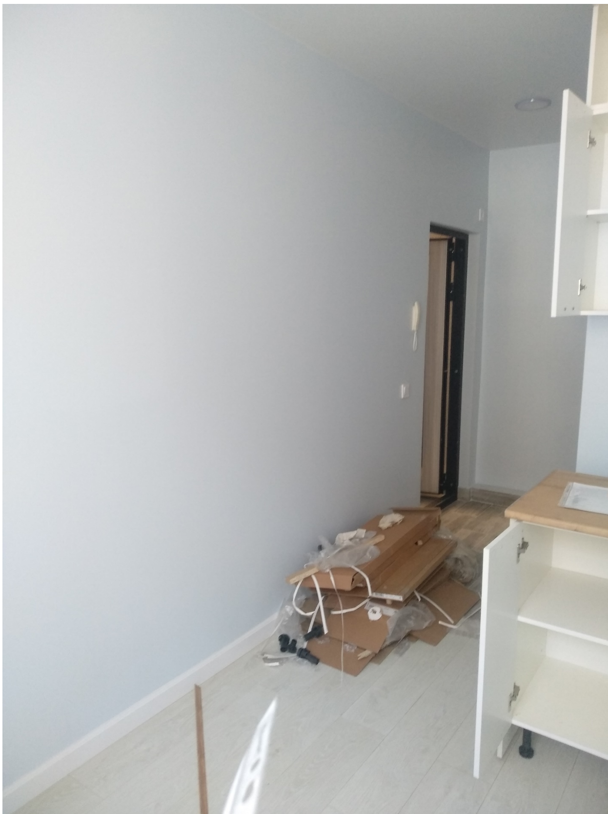
14.Фрагмент интерьера комнаты помещение (№12);
