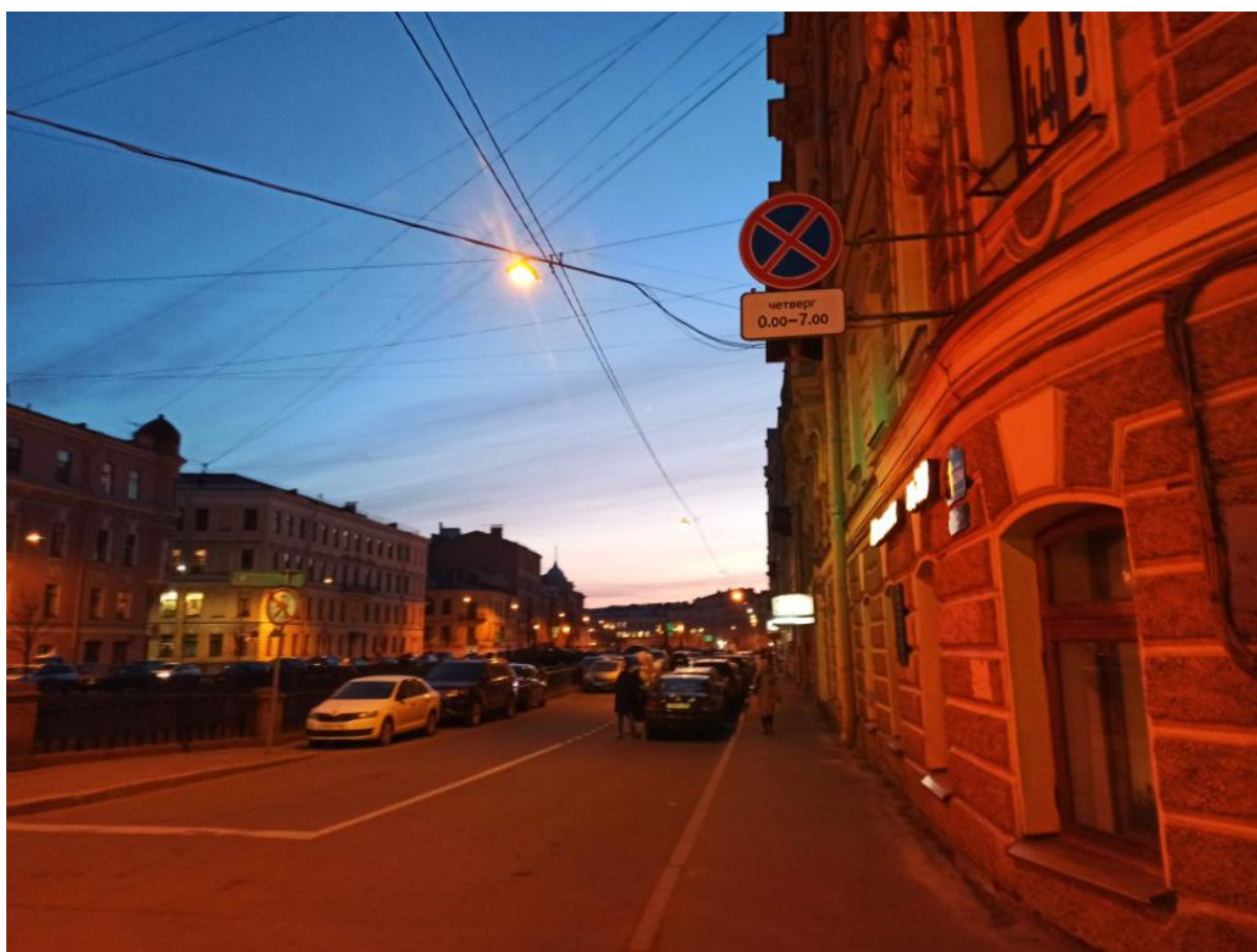
Фото 4 Фрагмент фасада объекта культурного наследия регионального значения «Дом С.О. Китнера»
