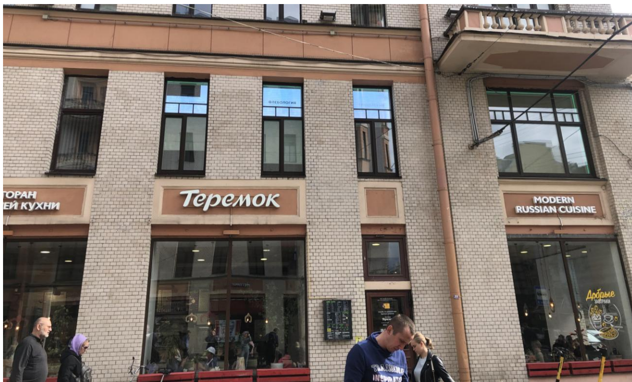
Фото 5. Вид на фрагмент лицевого северного фасада.
