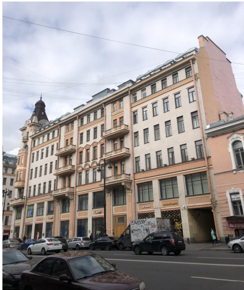
Фото 2. Вид на лицевой западный и торцевой фасады.
