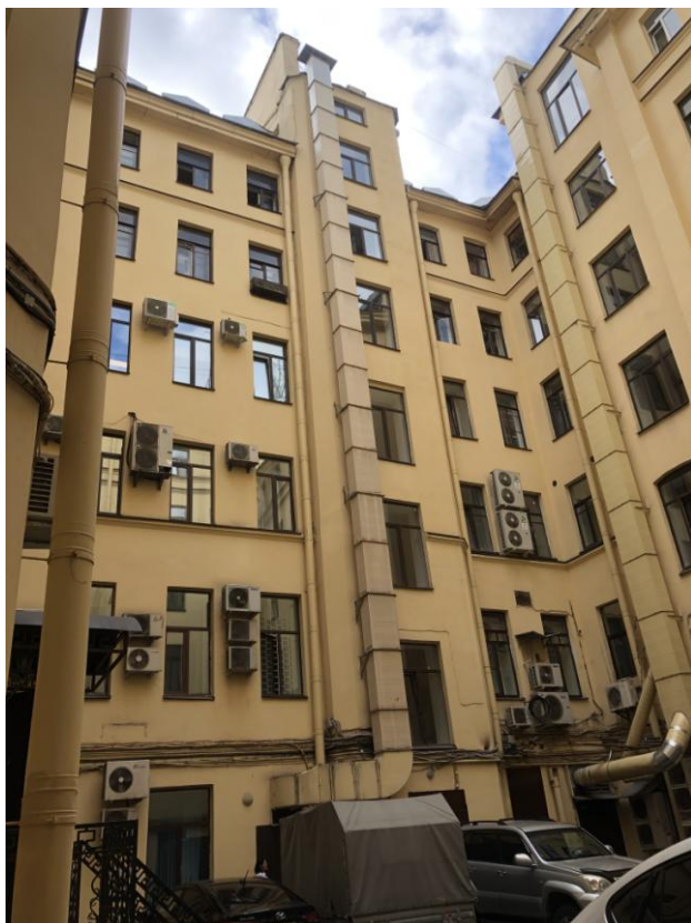
Фото 6. Вид на дворовые фасады.
