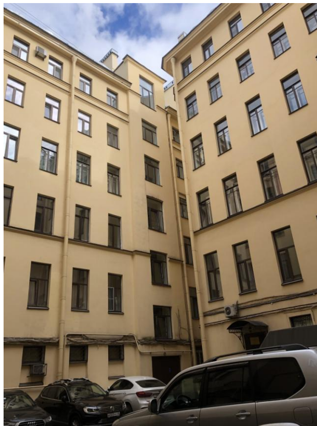
Фото 7. Вид на дворовые фасады.
