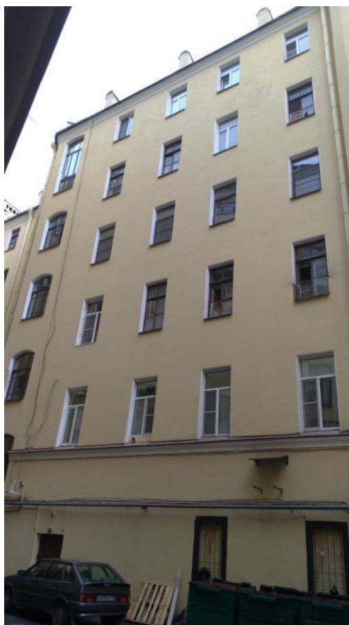
Фото 4 Фрагмент дворового фасада выявленного объекта культурного наследия «Дом Н.В.Безобразовой»
