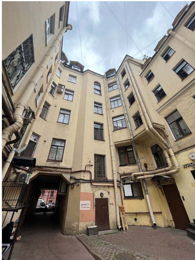
Фото №4. Дворовый (восточный) фасад здания.
