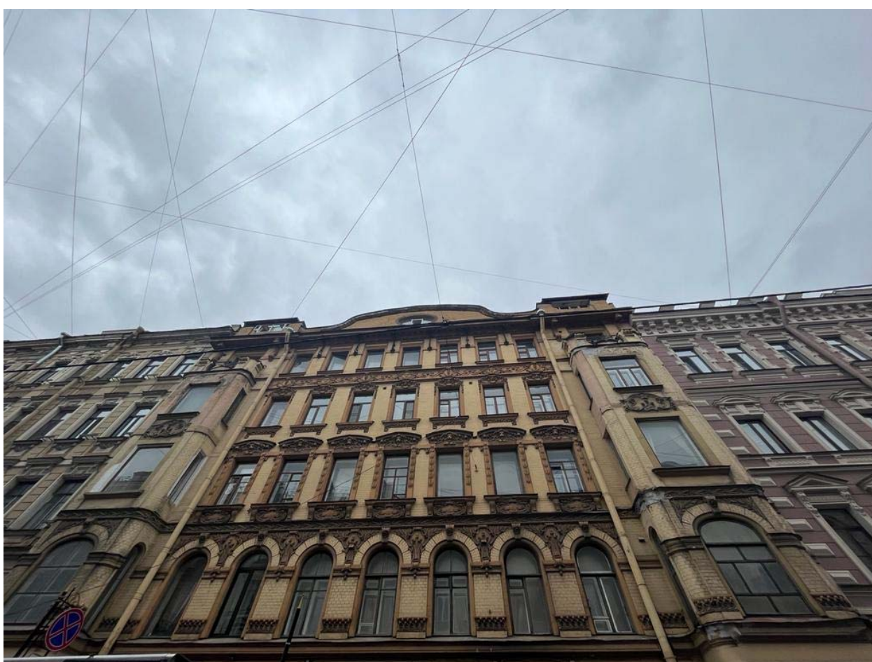
Фото №2. Лицевой (западный) фасад здания.
