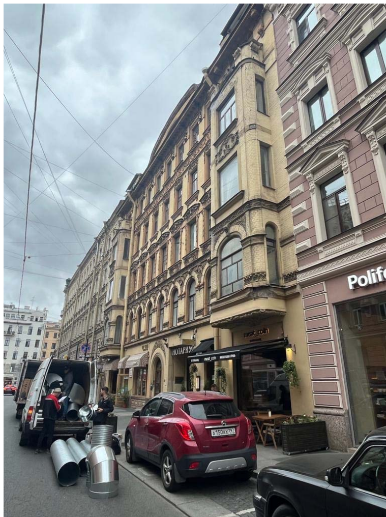
Фото №1. Лицевой (западный) фасад здания.
