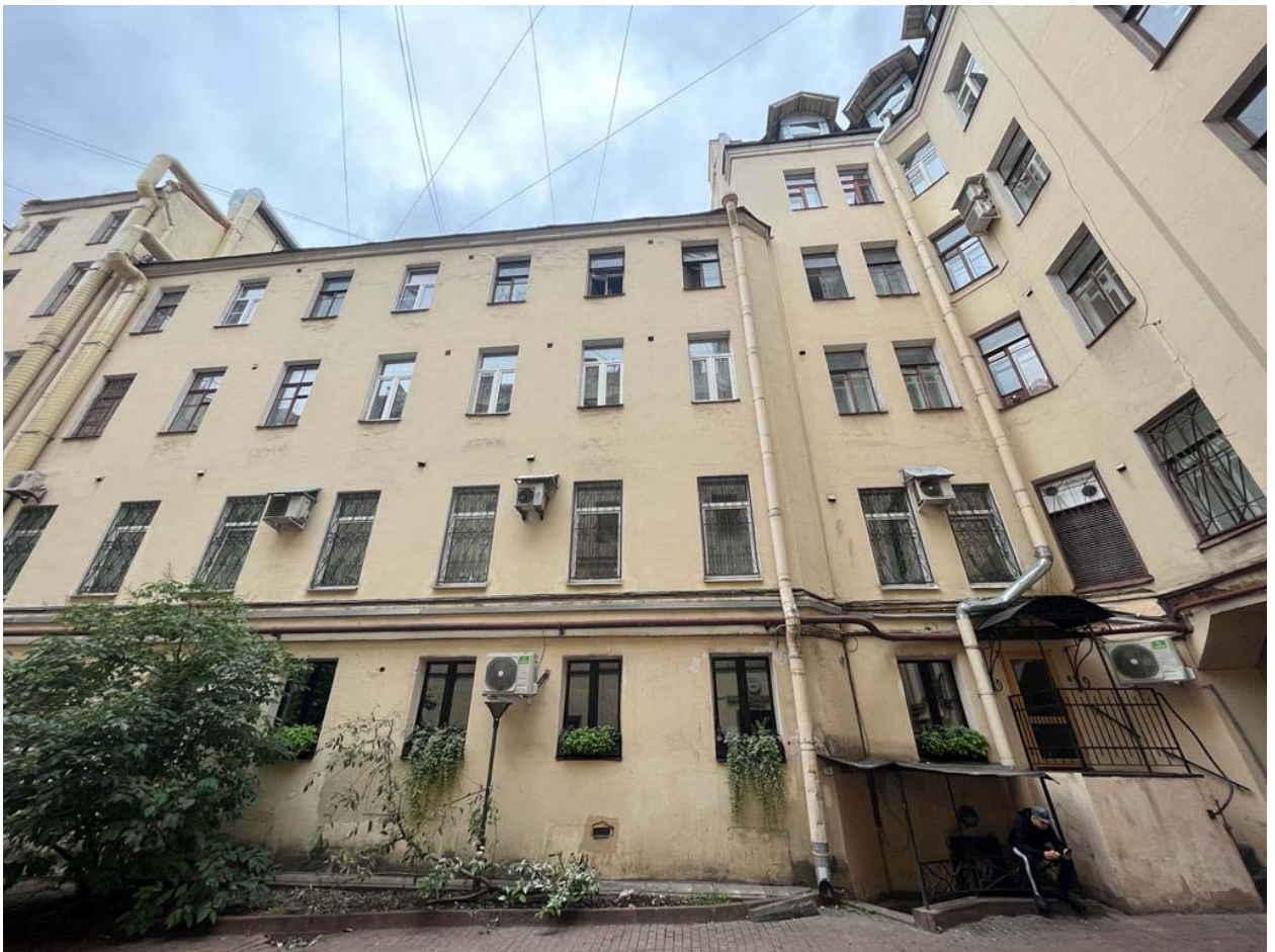
Фото №6. Дворовый (северный) фасад здания.
