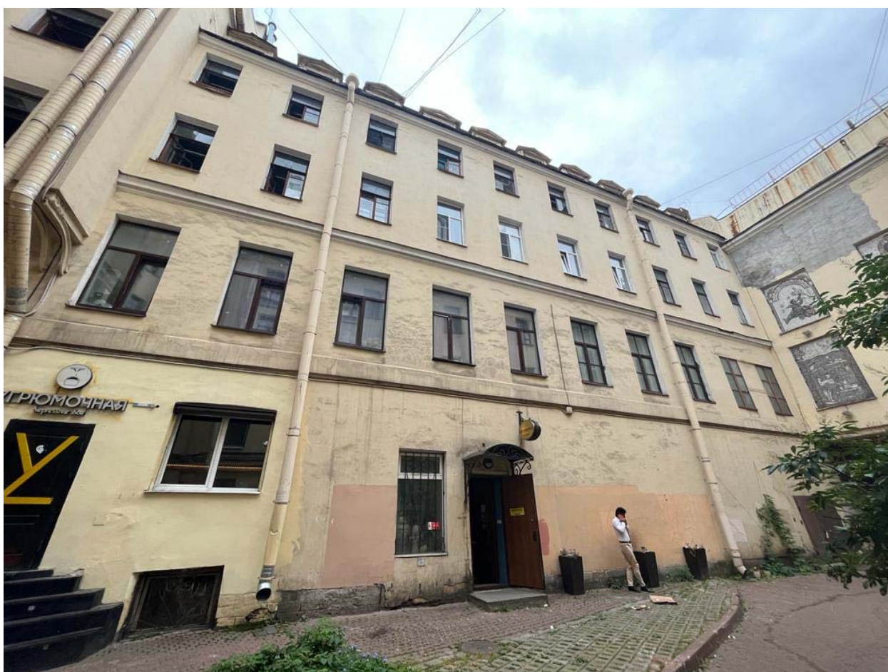
Фото №5. Дворовый (южный) фасад здания.
