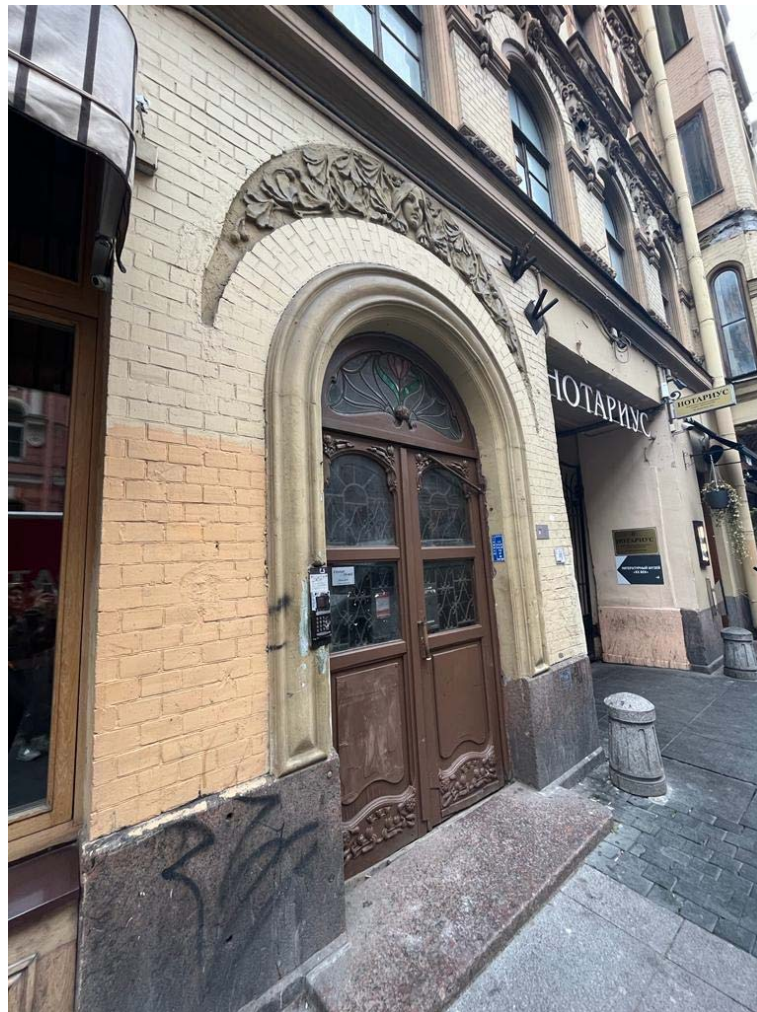
Фото №3. Лицевой (западный) фасад здания, вход в общедомовую лестничную клетку.
