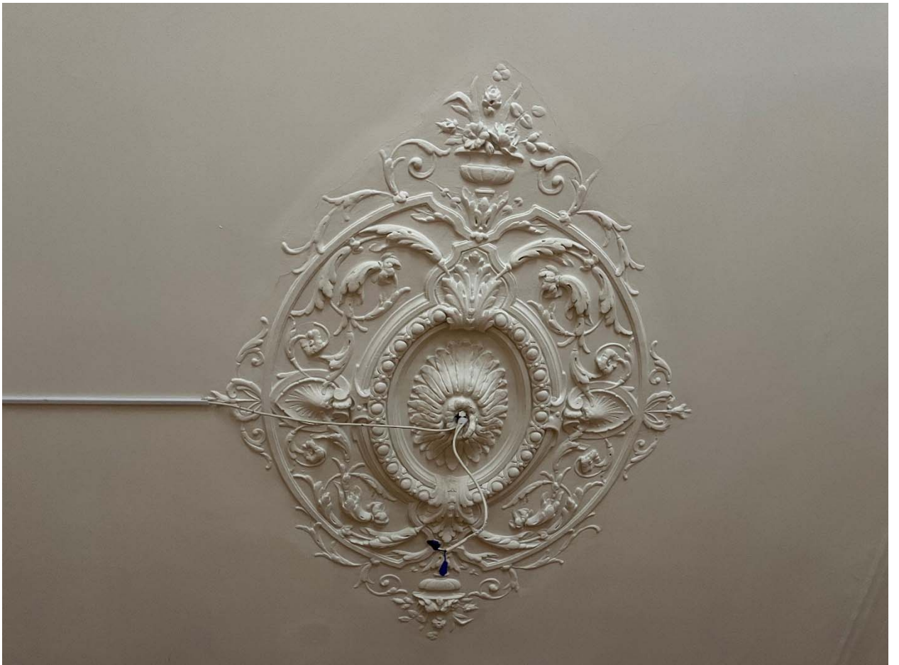
Фото №22. Комната. Отделка потолка.
