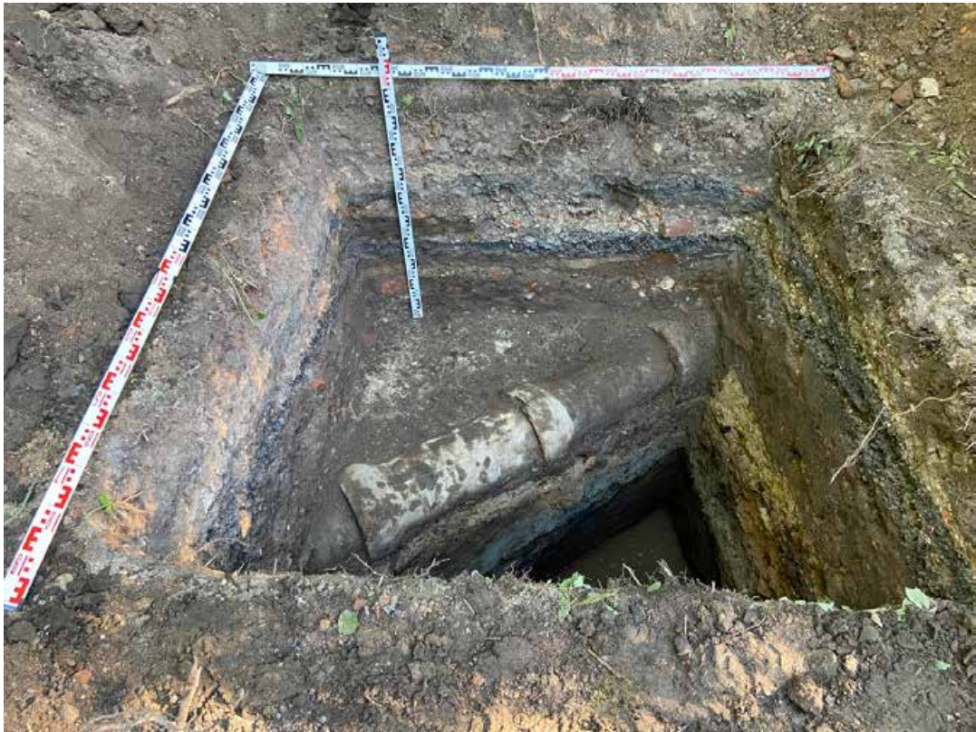
Рис. 34. Санкт-Петербург, пр-кт. Аптекарский, д. 16/1, литера. И (кадастровый номер: 78:07:0003299:1237); Санкт-Петербург, пр-кт. Аптекарский, д. 16/2, литера. И (кадастровый номер: 78:07:0003299:1236); Санкт-Петербург, пр-кт. Аптекарский, д. 16/3, литера. И (кадастровый номер: 78:07:0003299:1235). Шурф №1. Фиксация планиграфии на уровне материка. Вид на юг.
