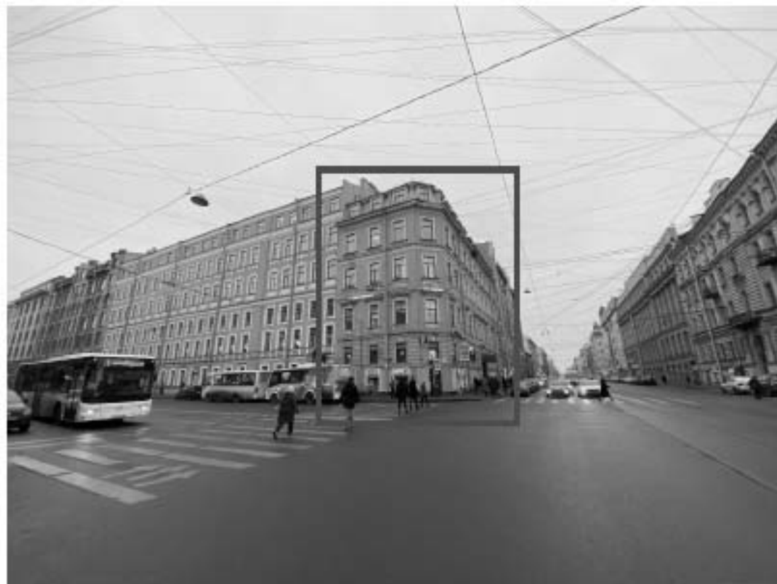
4. «Комплекс построек табачной фабрики «Лаферм». Производственный корпус» (г. Санкт-Петербург, Средний пр. В.О., дом 36/40, литера А). Общий вид с пересечения Среднего проспекта В.О. и 9-ой линии В.О. Дата съемки: 11.11.2019 г.
