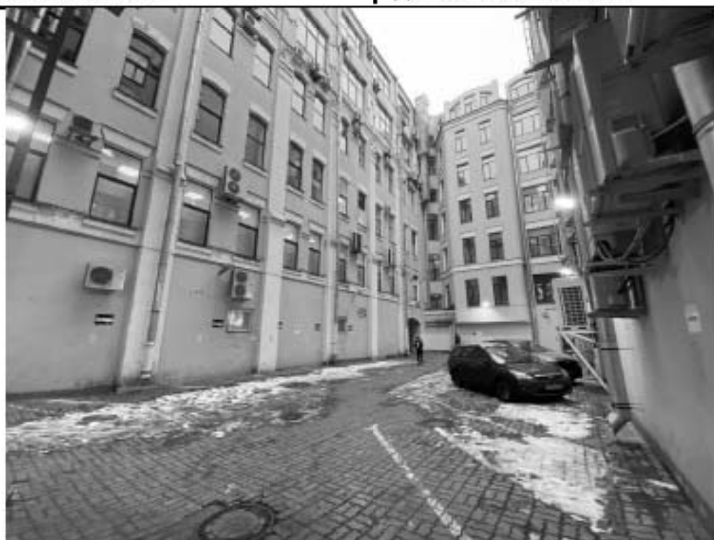
21. Общий вид открытого внутреннего двора №3. Дата съемки: 11.11.2019 г.
