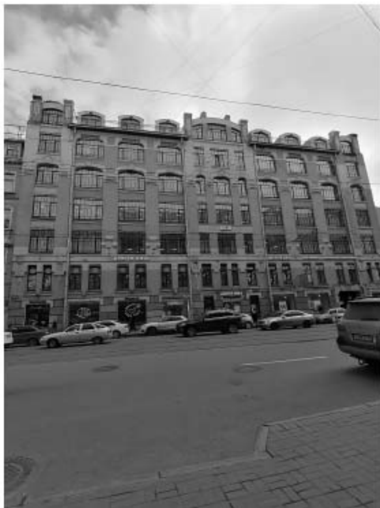
18. Выявленный объект культурного наследия «Производственный корпус», входящий в состав выявленного объекта культурного наследия «Комплекс построек табачной фабрики «Лаферме»» по адресу: г. Санкт-Петербург, Средний проспект В.О., дом 38, корпус 1, литера К Вид с северо-запада Дата съемки: 01 апреля 2021 г.
