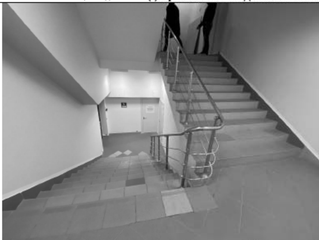
28. Фрагмент лестничного марша между 1 и 2 этажом лит. И. Дата съемки: 11.11.2019 г.
