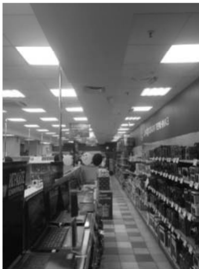
48. Фрагмент пом. 1-Н (205) второго этажа лит. Б. Дата съемки: 11.11.2019 г.
