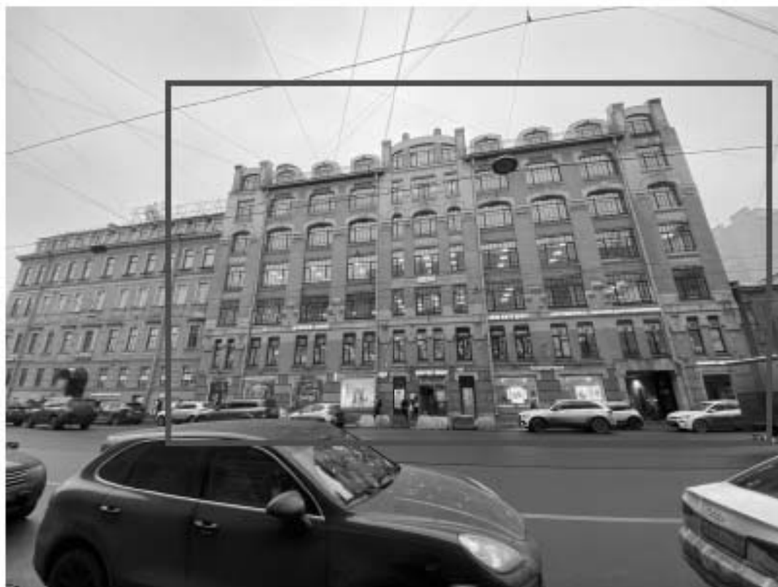
1. «Комплекс построек табачной фабрики «Лаферм». Производственный корпус» (г. Санкт-Петербург, Средний пр. В.О., дом 38, корпус 1, литера К). Общий вид северного лицевого фасада со стороны Среднего проспекта В.О. Дата съемки: 11.11.2019 г.
