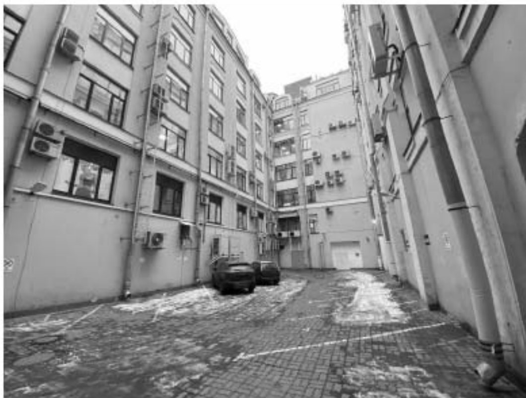
22. Общий вид открытого внутреннего двора №3. Дата съемки: 11.11.2019 г.
