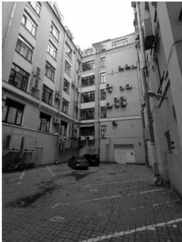
16. Выявленный объект культурного наследия «Производственный корпус», входящий в состав выявленного объекта культурного наследия «Комплекс построек табачной фабрики «Лаферма»» по адресу: г. Санкт-Петербург, Средний проспект В.О., дом 38, корпус 1, литера К Вид с юго-запада Дата съемки: 23 июня 2021 г.
