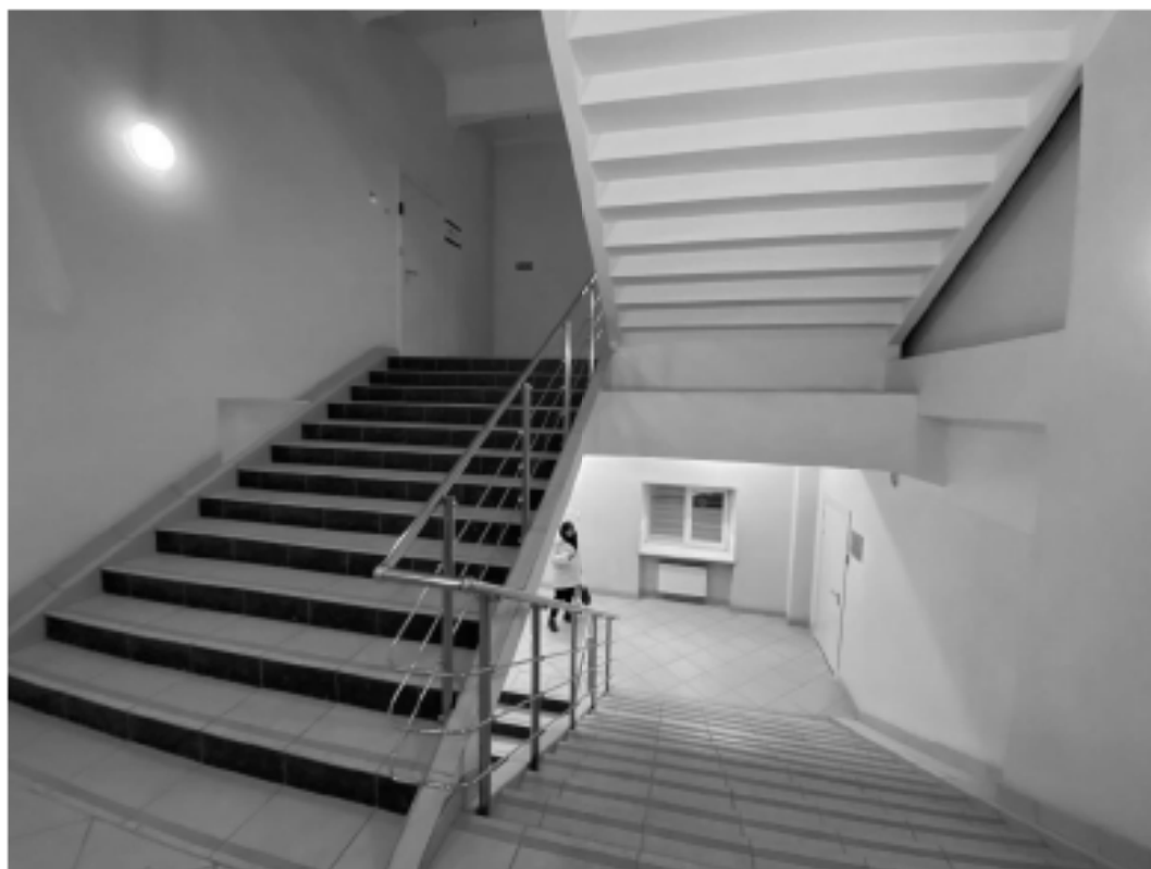
34. Фрагмент лестничного марша между вторым и третьим этажом лит. И. Дата съемки: 11.11.2019 г.
