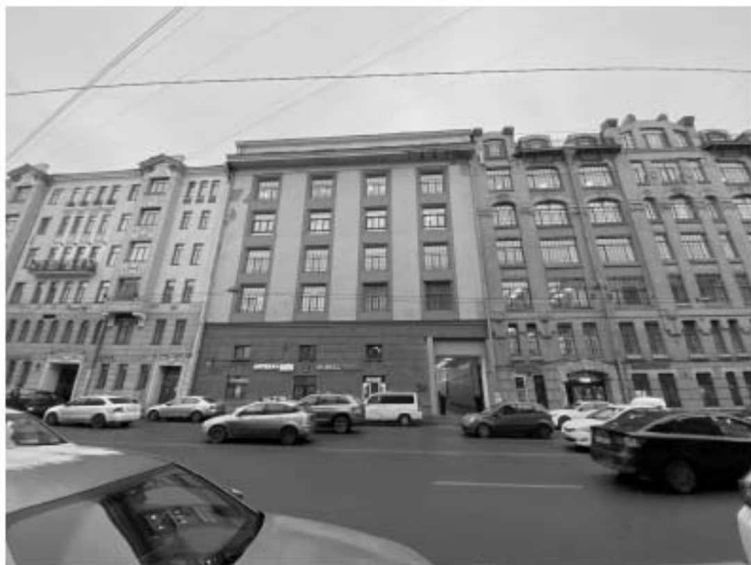
9. «Комплекс построек табачной фабрики «Лаферм». Производственный корпус» (г. Санкт-Петербург, Средний пр. В.О., дом 36/40, литера А). Общий вид восточного лицевого фасада со стороны 9-ой линии В.О. Дата съемки: 11.11.2019 г.
