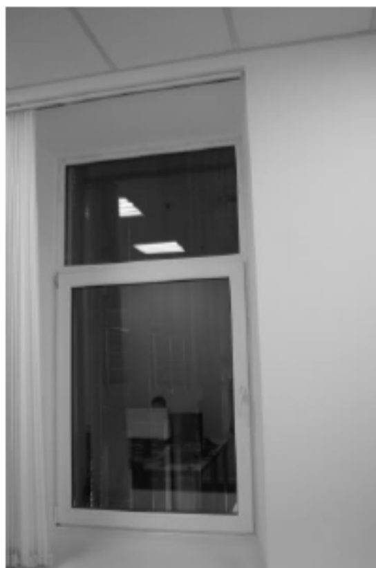
75. Фрагмент пом. 1-Н (583) пятого этажа лит. А. Дата съемки: 11.11.2019 г.
