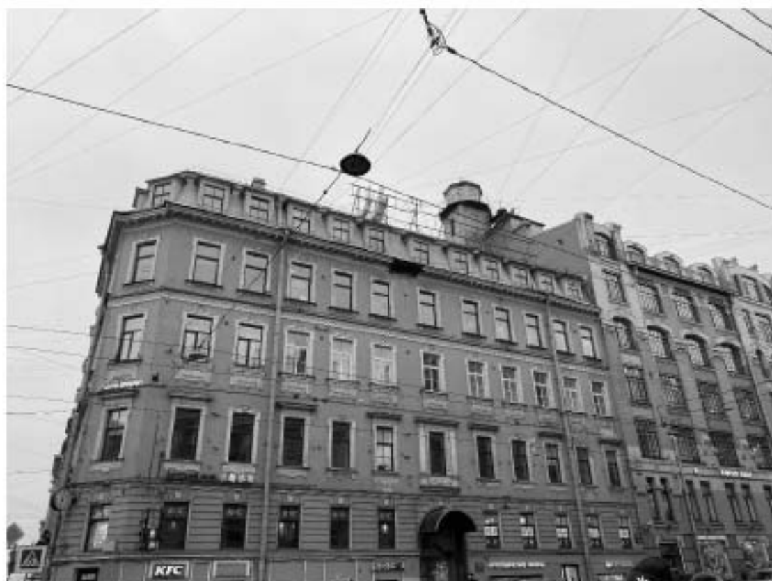
3. «Комплекс построек табачной фабрики «Лаферм». Производственный корпус» (г. Санкт-Петербург, Средний пр. В.О., дом 36/40, литера А). Фрагмент северного лицевого фасада. Дата съемки: 11.11.2019г.
