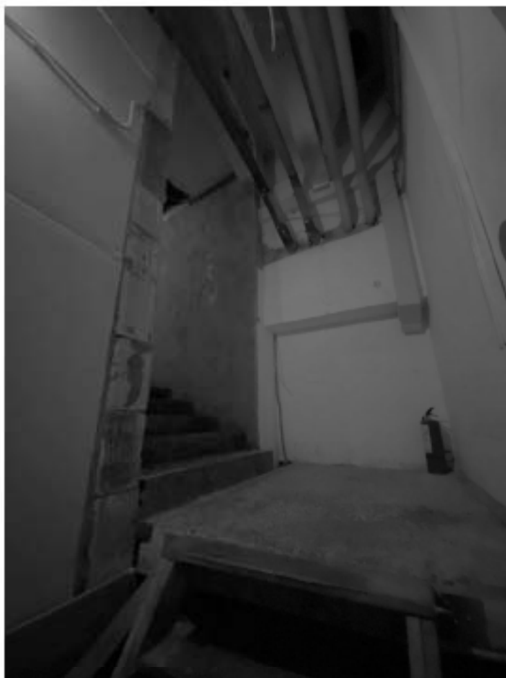
61. Фрагмент пом. 1-Н(1002) седьмого этажа лит. Б. Дата съемки: 11.11.2019 г.
