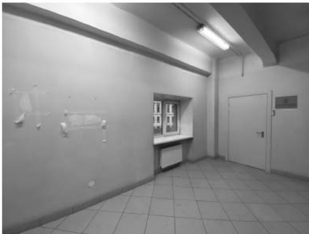
29. Общий вид пом. 1-Н(193) второго этажа лит. И. Дата съемки: 11.11.2019 г.
