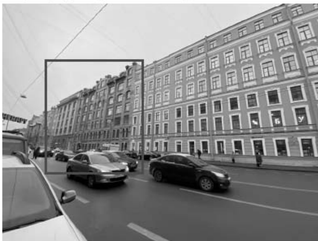
6. «Комплекс построек табачной фабрики «Лаферм». Производственный корпус» (г. Санкт-Петербург, Средний пр. В.О., дом 36/40, литеры Б, И). Общий вид восточного лицевого фасада со стороны 9-ой линии В.О. Дата съемки: 11.11.2019 г.
