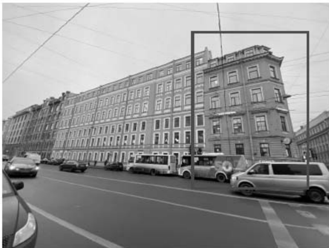
5. «Комплекс построек табачной фабрики «Лаферм». Производственный корпус» (г. Санкт-Петербург, Средний пр. В.О., дом 36/40, литера А). Общий вид восточного лицевого фасада со стороны 9-ой линии В.О. Дата съемки: 11.11.2019 г.
