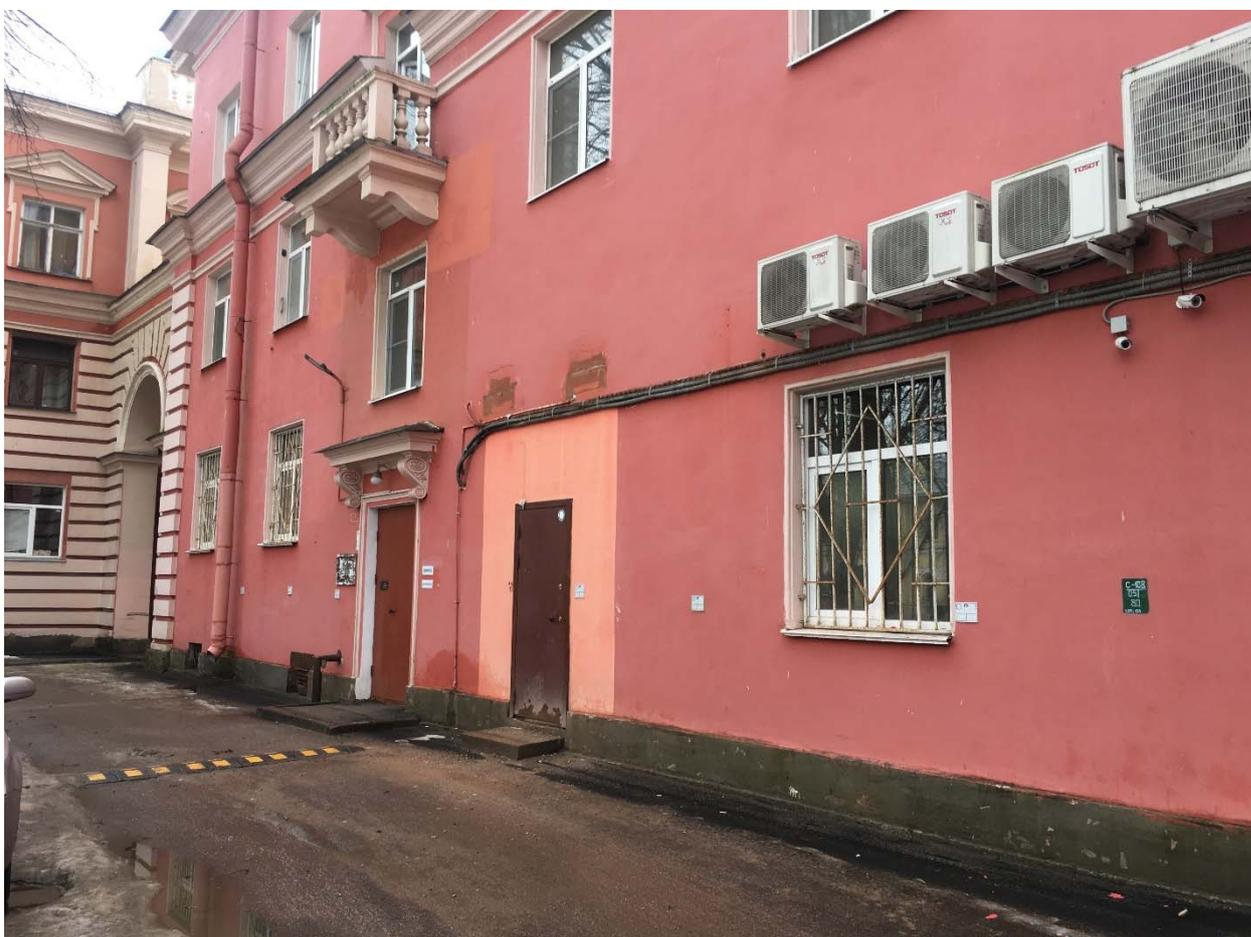
**Фото №5.** Дворовый (северный) фасад здания, поздний вход в помещение №3-Н на месте исторического оконного проема.
