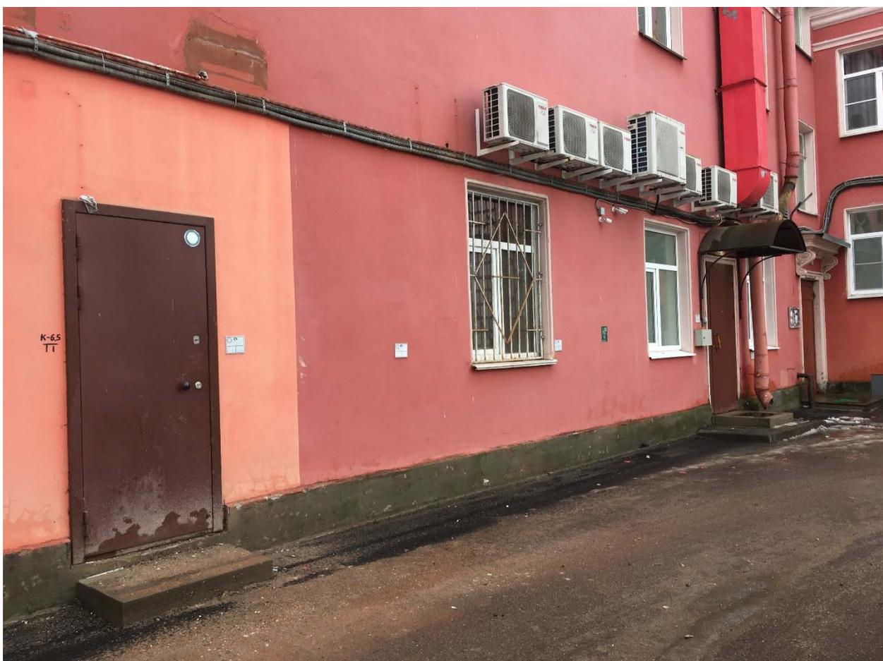
**Фото №6.** Дворовый (северный) фасад здания, поздний вход в помещение №3-Н на месте исторического оконного проема.
