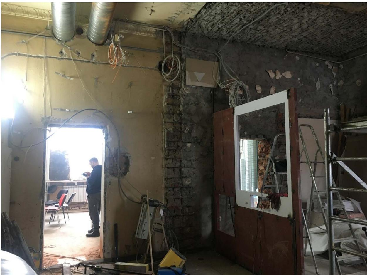
**Фото №8.** Помещение №3-Н. Пом. №№ 7, 8, 9, 10, 11, 12 (согласно планам ПИБ и плану вторичного объекта недвижимости) – объединены за счет демонтажа ненесущих перегородок.
