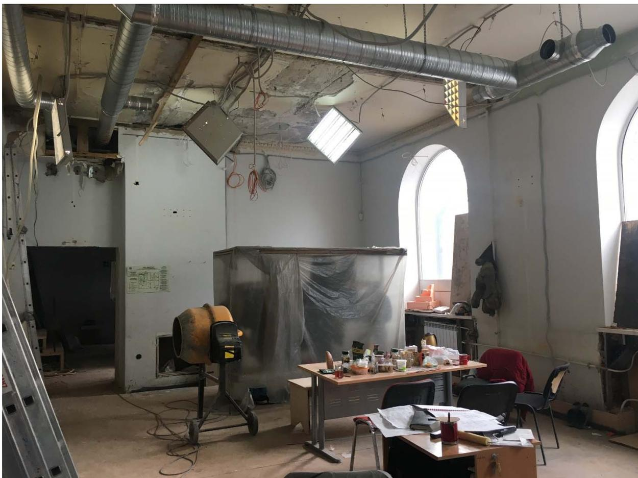
**Фото №11.** Помещение №3-Н. Пом. №№ 2, 3,4, 5, 6 (согласно планам ПИБ и плану вторичного объекта недвижимости) – объединены за счет демонтажа ненесущих перегородок.
