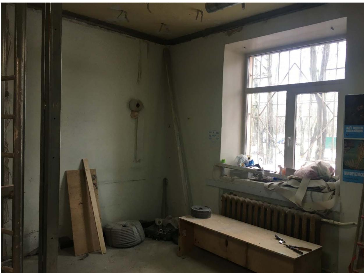
**Фото №24.** Помещение №3-Н. Пом. №№ 13, 14, 15, 16, 19 (согласно планам ПИБ и плану вторичного объекта недвижимости) – объединены за счет демонтажа ненесущих перегородок.
