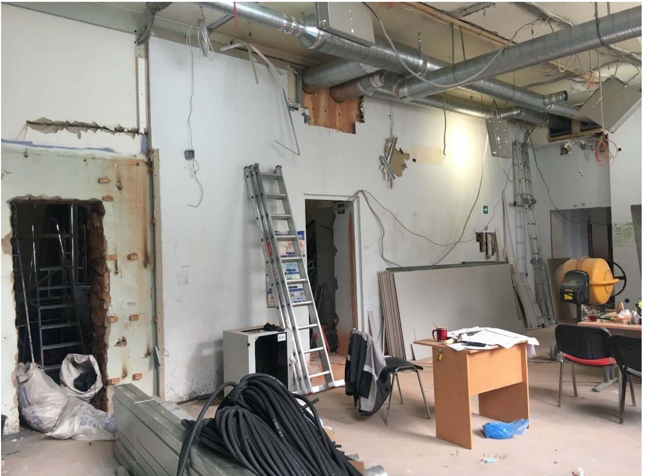
**Фото №10.** Помещение №3-Н. Пом. №№ 2, 3,4, 5, 6 (согласно планам ПИБ и плану вторичного объекта недвижимости) – объединены за счет демонтажа ненесущих перегородок.
