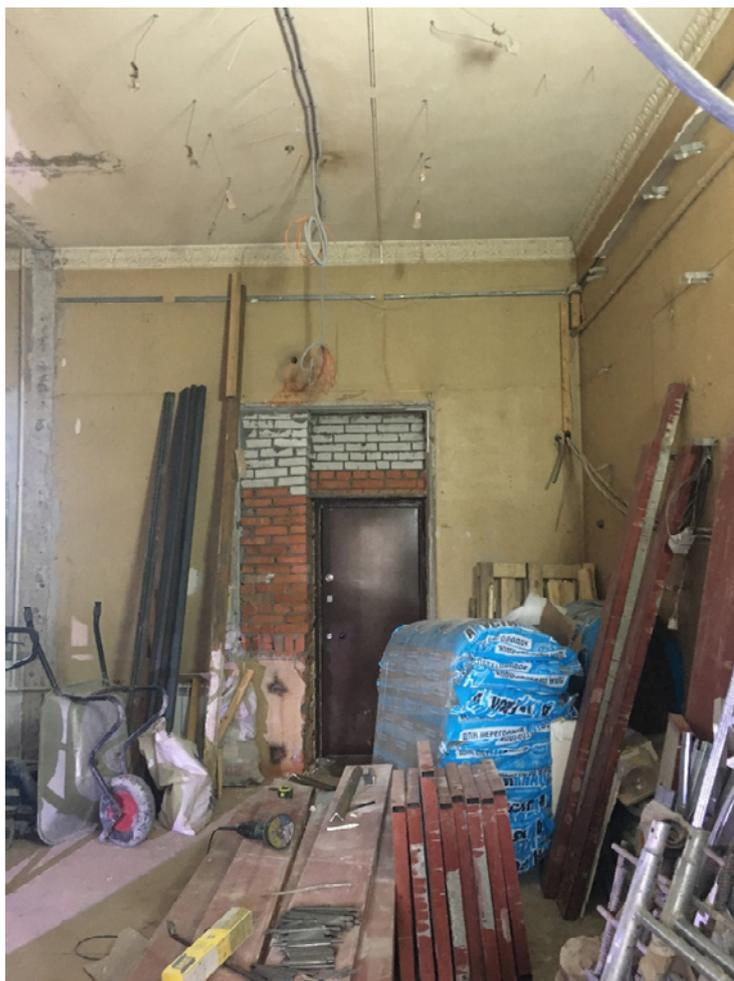
**Фото №9.** Помещение №3-Н. Пом. №№ 7, 8, 9, 10, 11, 12 (согласно планам ПИБ и плану вторичного объекта недвижимости) – объединены за счет демонтажа несущих перегородок.
