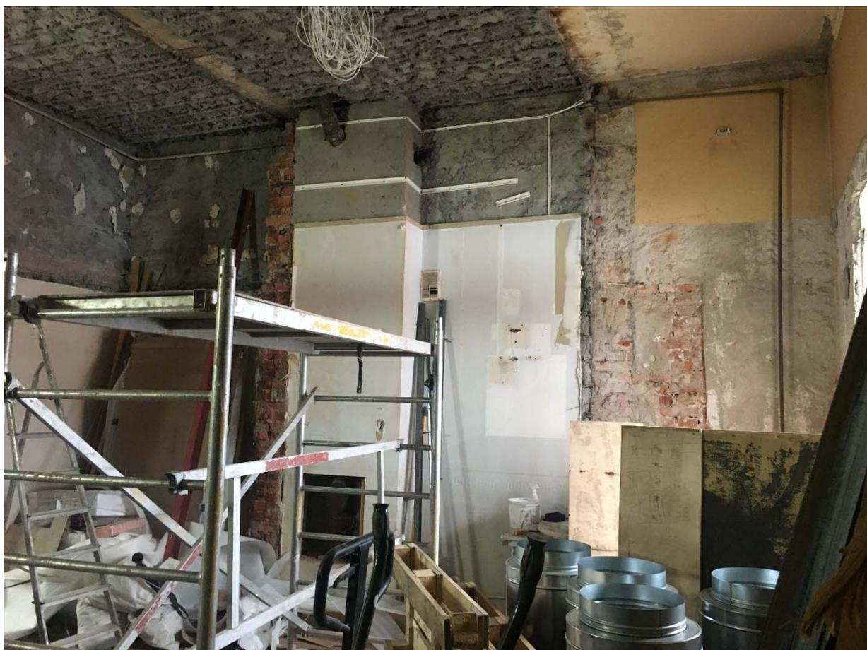
**Фото №7.** Помещение №3-Н. Пом. №№ 7, 8, 9, 10, 11, 12 (согласно планам ПИБ и плану вторичного объекта недвижимости) – объединены за счет демонтажа ненесущих перегородок.
