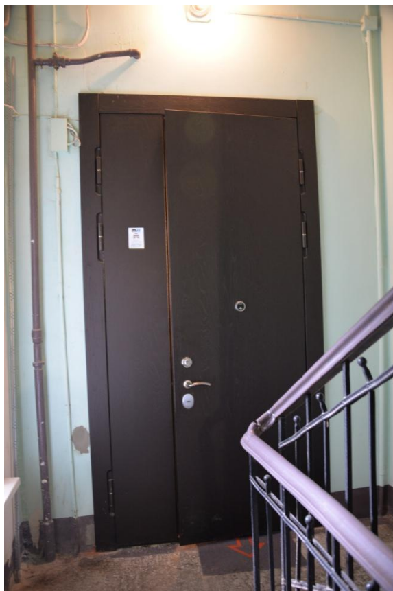
5. Входная дверь в квартиру №4
