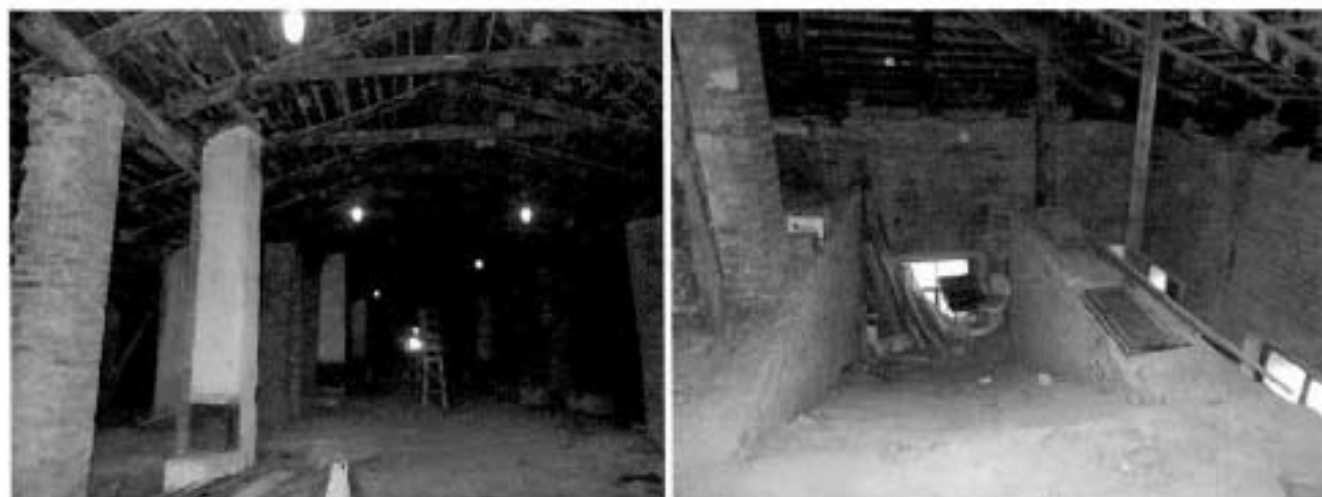
10, 11. Общий вид чердака.
