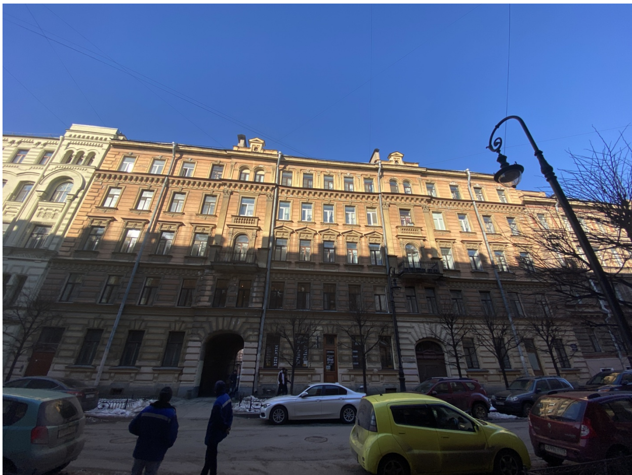
Фото 1. Общий вид выявленного объекта культурного наследия «Дом А.И. Афанасьева», расположенного по адресу: г. Санкт-Петербург, Пушкинская ул., 17. Лицевой восточный фасад.
