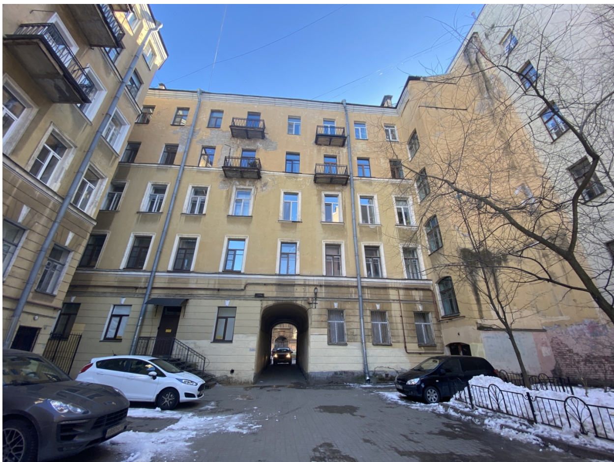
Фото 4. Западный дворовой фасад лицевого корпуса. Вид с запада.
