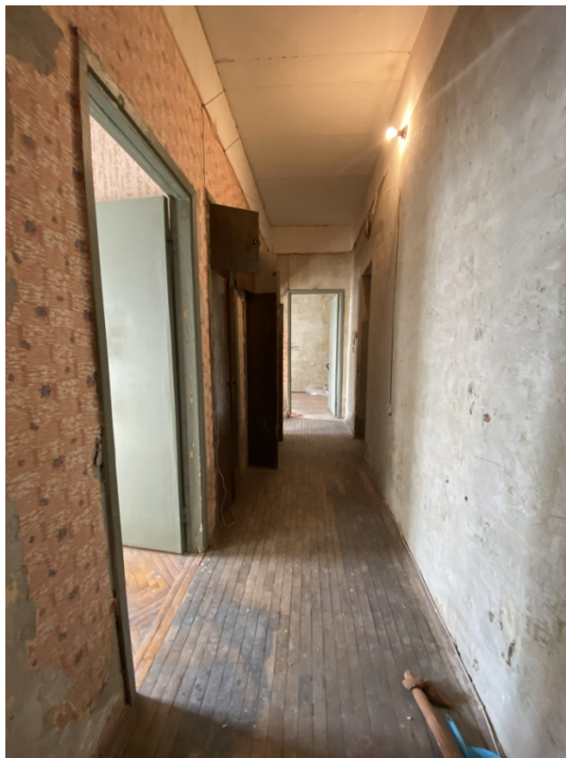
Фото 10. Помещение № 5. Коридор. Вид с севера.
