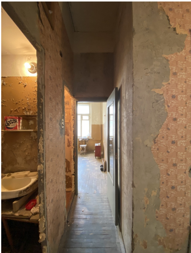
Фото 11. Помещение № 5. Коридор. Вид с запада.
