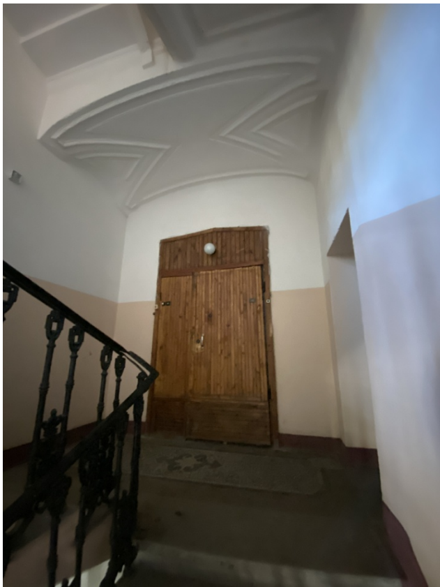
Фото 7. Вход в тамбур, ведущий в кв.№ 46. Общий вид с лестничной клетки.
