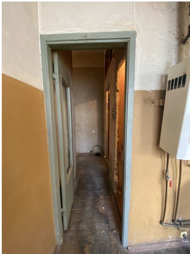
Фото 12. Помещение № 5. Коридор. Вид с востока.
