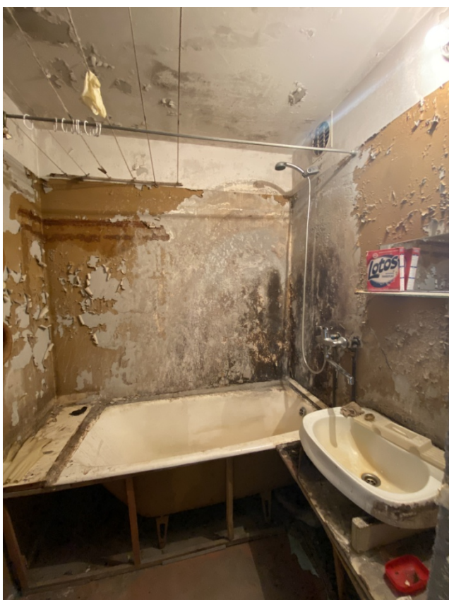
Фото 13. Помещение № 6. Ванная. Вид с юга.
