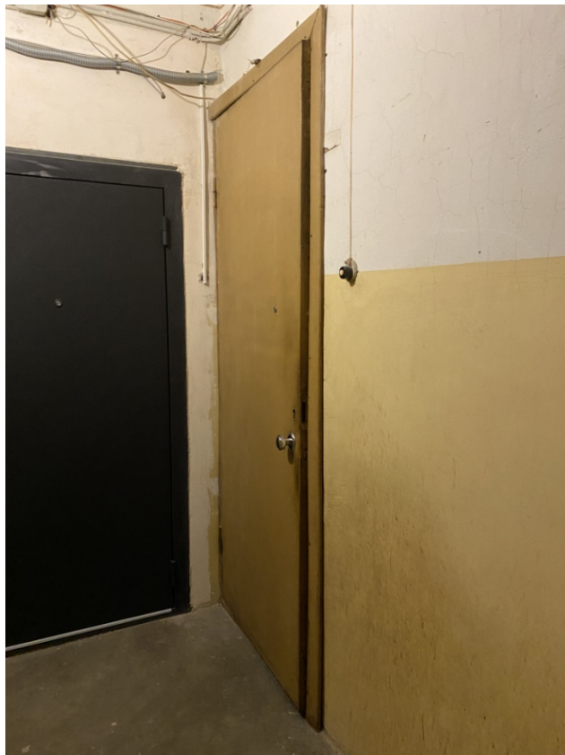
Фото 8. Вход в кв.№ 46. Общий вид с тамбура.
