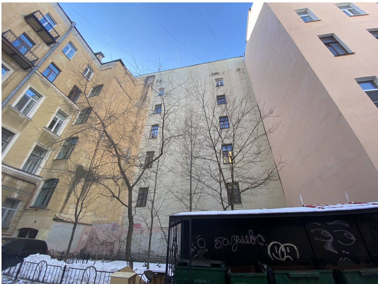
Фото 6. Фрагмент дворового фасада лицевого корпуса. Вид с северо-запада.
