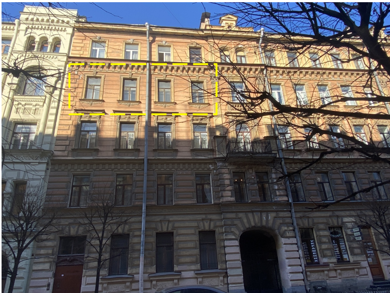
Фото 3. Фрагмент лицевого восточного фасада. Окна экспертируемой квартиры № 46. Вид с востока.
