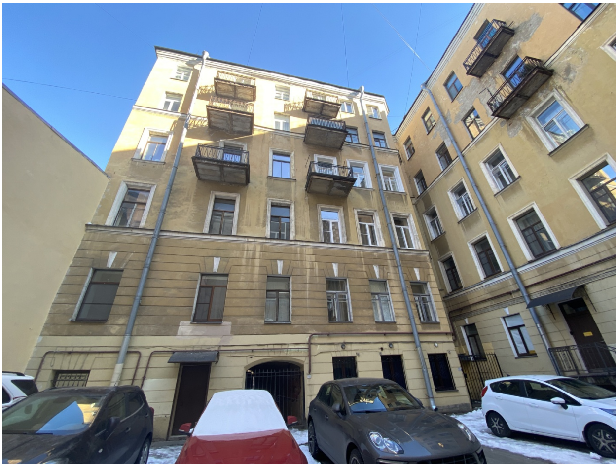
Фото 5. Южный фасад дворового флигеля. Вид с юга.
