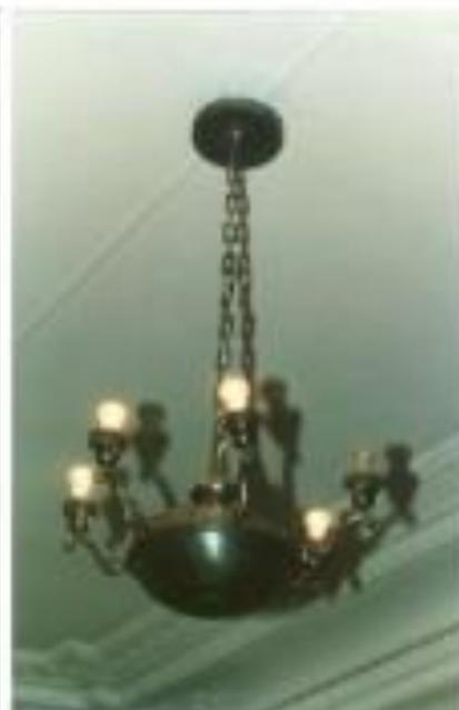
люстра на 6 свт. (латунь, литье, патинирование). Потолочная часть колоколообразная. Гладкий шток в нижней части заканчивается объемной деталью в форме желудя и изогнутыми кронштейнами, поддерживающими корпус люстры в форме широкого обода-тарелки с поддоном матированного стекла, в центре которого – многолепестковая розетка, выполненная в технике алмазной грани. По верхнему краю обода закреплены 6 светоточек в форме факелов. Время: нач. XX в. Размер: в – ок. 150, diam – ок. 65 см.
