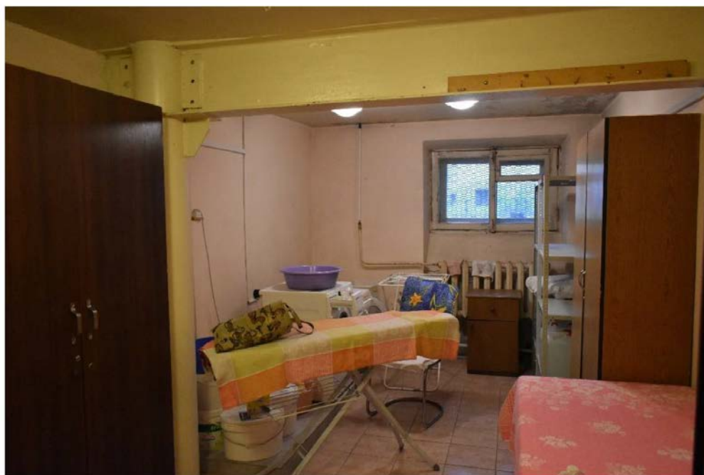
17. Объект культурного наследия федерального значения «Больница», входящий в состав объекта культурного наследия федерального значения «Монастырь Воскресенский Новодевичий» по адресу: г. Санкт-Петербург, Московский проспект, д. 100, лит. П. Помещение подвала.
