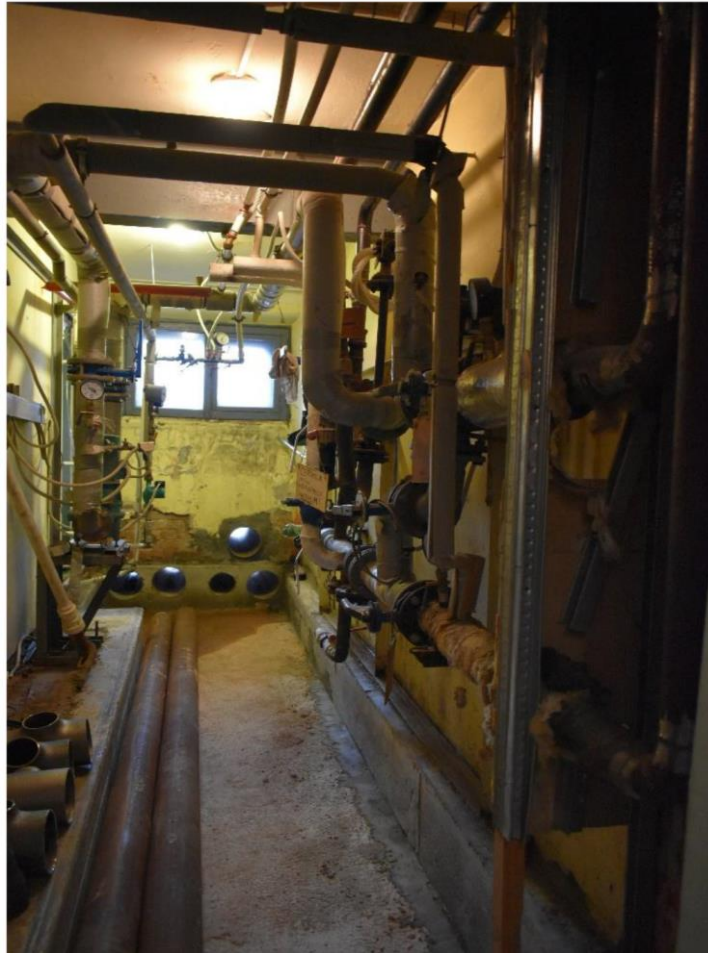
15. Объект культурного наследия федерального значения «Больница», входящий в состав объекта культурного наследия федерального значения «Монастырь Воскресенский Новодевичий» по адресу: г. Санкт-Петербург, Московский проспект, д. 100, лит. П. Подвал. Фрагмент интерьера.
