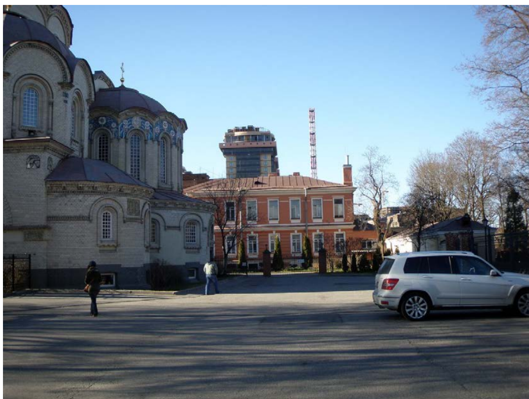
22. Воскресенский Новодевичий монастырь. Больница. Вид с юга 2013 г. Фотография. https://www.citywalls.ru .
