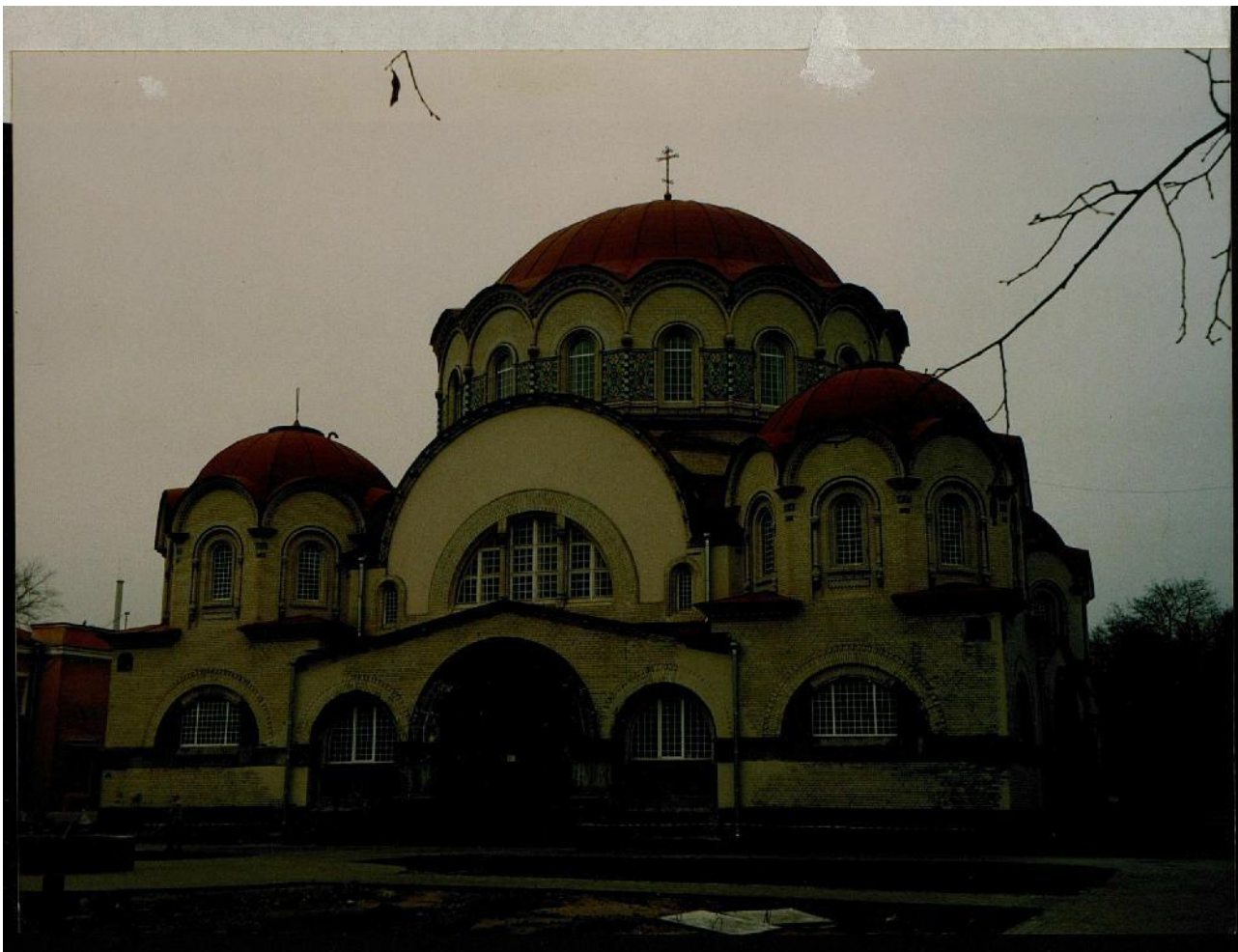
Санкт-Петербург, Московский район, Московский пр., 100. Воскресенский Новодевичий монастырь. Комплекс. 1848-1861, 1869-1870-е, 1895, 1900—1906, 1907-1914 гг. Церковь Казанской иконы Божией Матери. Западный фасад. Фото 13 Луцко Е. 2003.
