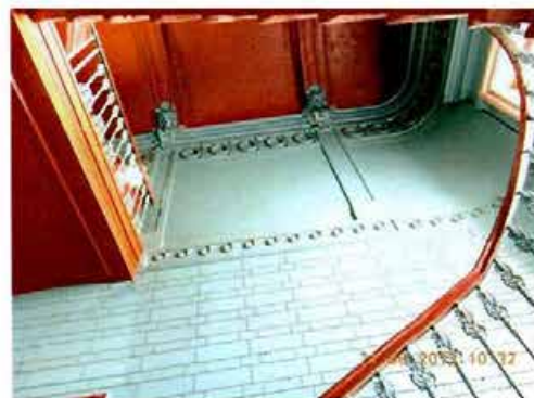
Фото 15. Галерная ул., д. 35. Лестница. Фрагмент.
