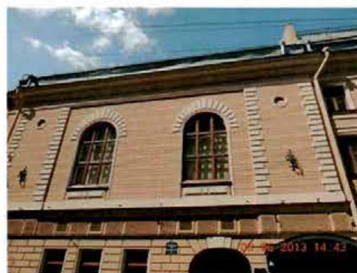
Фото 2. Фрагмент фасада по Галерной ул., д. 33.
