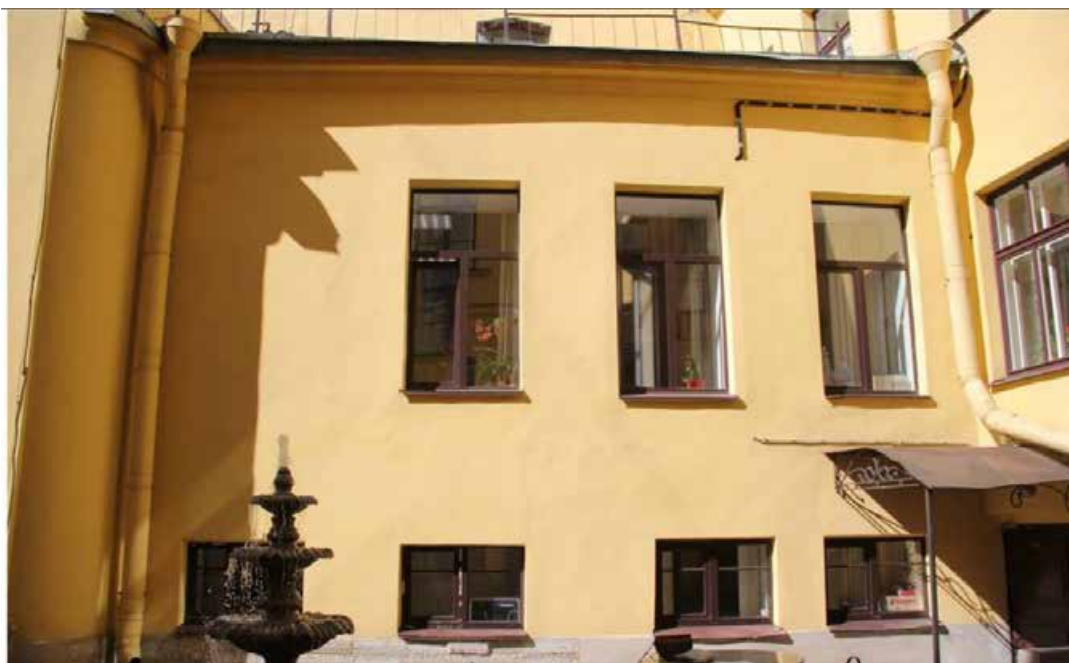
23. Объект культурного наследия федерального значения «Дом фон Дервиза С.П. с дворовыми флигелями», расположенный по адресу: г. Санкт-Петербург, Адмиралтейский район, Галерная ул., д. 35, литера А (Английская наб., 34, Галерная ул., 33, 35). Дворовой фасад в осях 11-17/Л (оси по проекту). Фрагмент.
