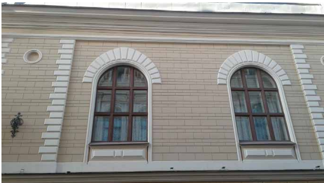
16. Объект культурного наследия федерального значения «Дом фон Дервиза С.П. с дворовыми флигелями», расположенный по адресу: г. Санкт-Петербург, Адмиралтейский район, Галерная ул., д. 35, литера А (Английская наб., 34, Галерная ул., 33, 35). Лицевой фасад по Галерной улице дом №33. Фрагмент.
