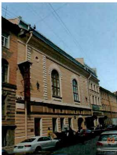
Фото 1. Лицевой фасад по Галерной ул., д. 33.
