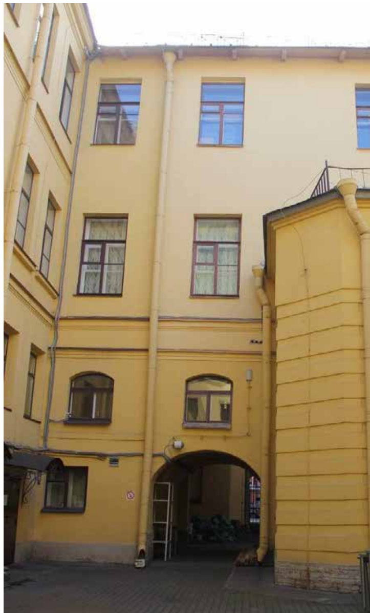
22. Объект культурного наследия федерального значения «Дом фон Дервиза С.П. с дворовыми флигелями», расположенный по адресу: г. Санкт-Петербург, Адмиралтейский район, Галерная ул., д. 35, литера А (Английская наб., 34, Галерная ул., 33, 35). Дворовой фасад в осях Г-Л/10-11 (оси по проекту). Общий вид.
