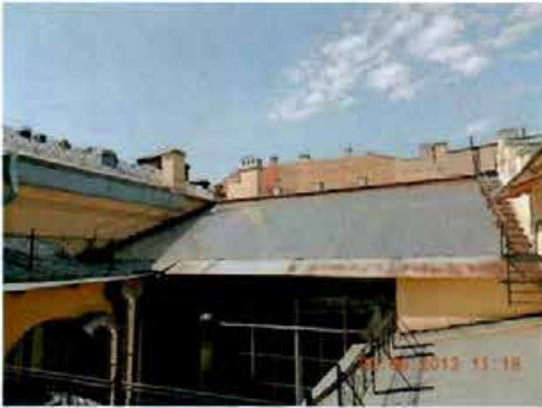
Фото 10. Галерная ул., д. 33. Вид крыши.
