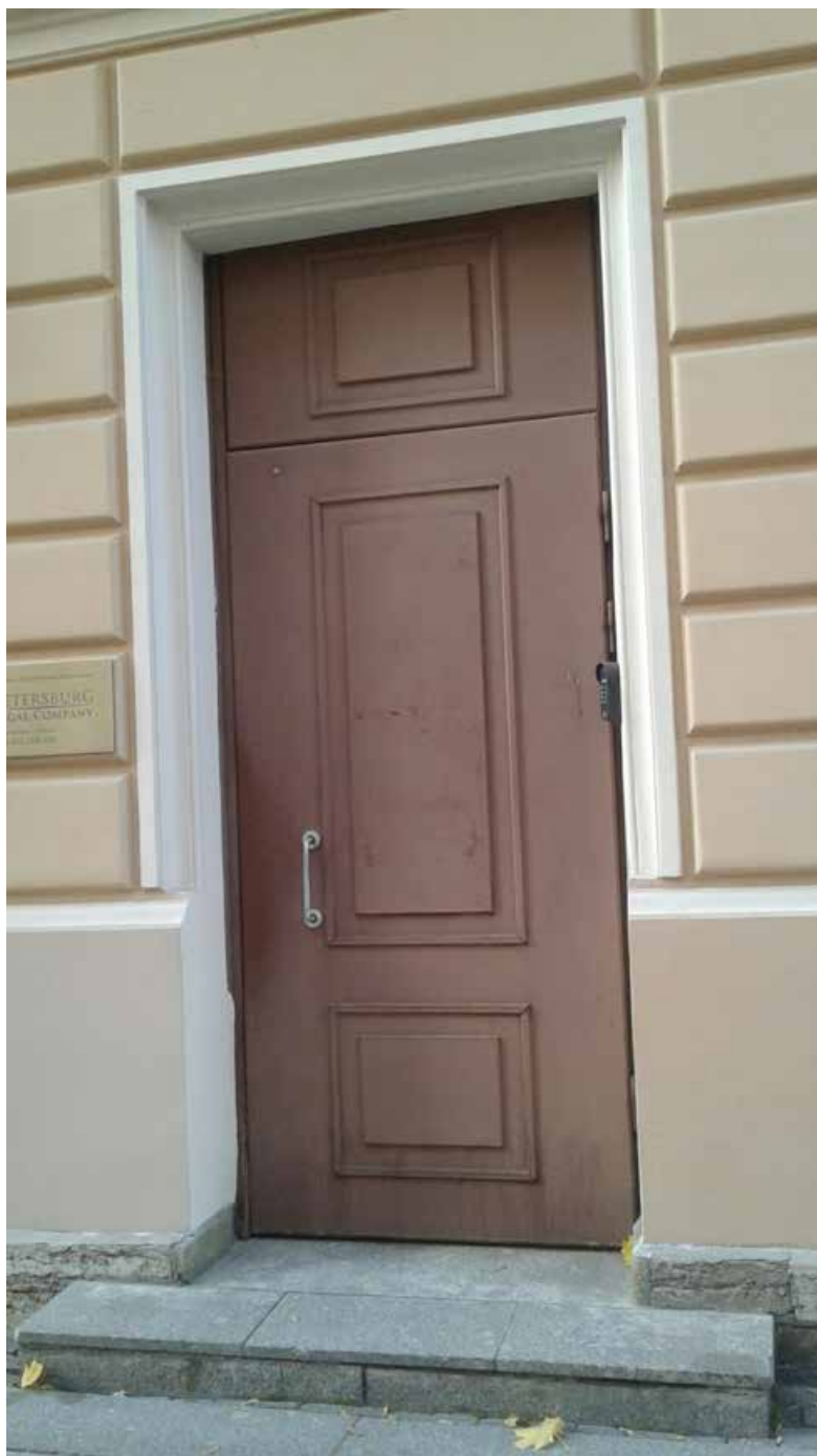
20. Объект культурного наследия федерального значения «Дом фон Дервиза С.П. с дворовыми флигелями», расположенный по адресу: г. Санкт-Петербург, Адмиралтейский район, Галерная ул., д. 35, литера А (Английская наб., 34, Галерная ул., 33, 35). Лицевой фасад по Галерной улице дом №33. Дверное заполнение (позднее).
