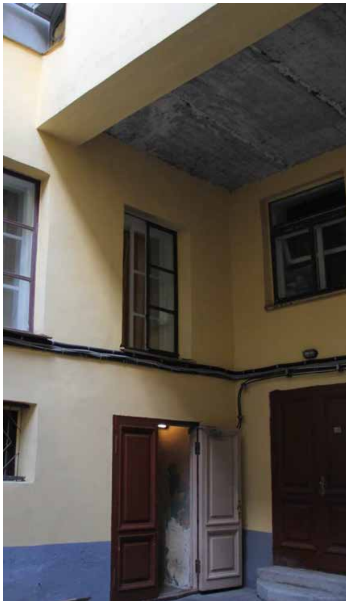
30. Объект культурного наследия федерального значения «Дом фон Дервиза С.П. с дворовыми флигелями», расположенный по адресу: г. Санкт-Петербург, Адмиралтейский район, Галерная ул., д. 35, литера А (Английская наб., 34, Галерная ул., 33, 35). Дворовый фасад в осях 1-9/К-Л (оси по проекту). Фрагмент.
