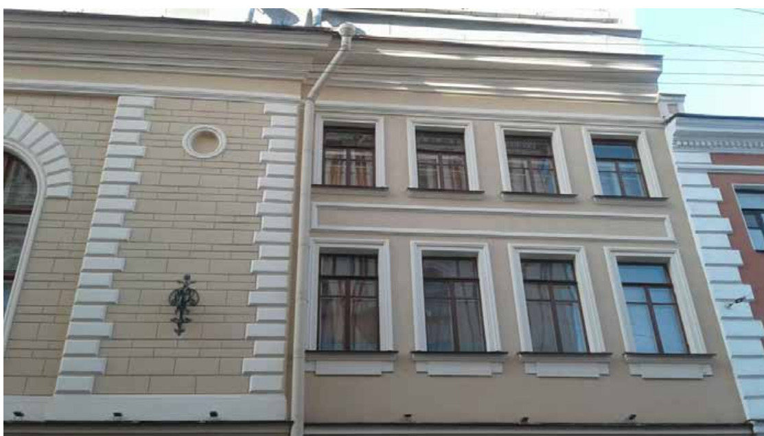
17. Объект культурного наследия федерального значения «Дом фон Дервиза С.П. с дворовыми флигелями», расположенный по адресу: г. Санкт-Петербург, Адмиралтейский район, Галерная ул., д. 35, литера А (Английская наб., 34, Галерная ул., 33, 35). Лицевой фасад по Галерной улице дом №33. Фрагмент.
