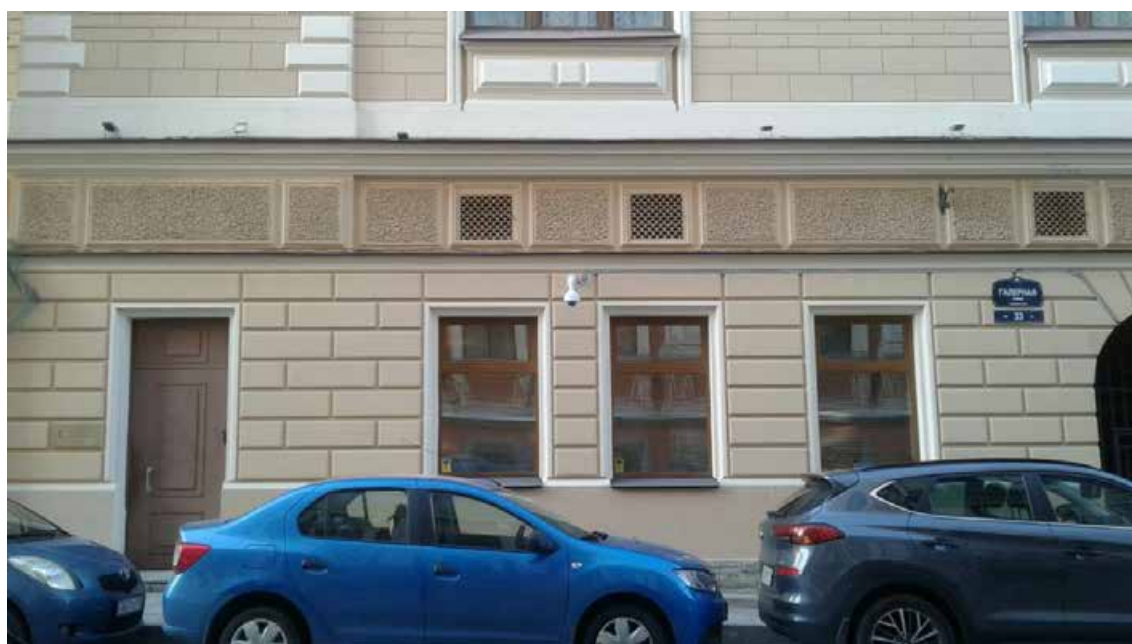
15. Объект культурного наследия федерального значения «Дом фон Дервиза С.П. с дворовыми флигелями», расположенный по адресу: г. Санкт-Петербург, Адмиралтейский район, Галерная ул., д. 35, литера А (Английская наб., 34, Галерная ул., 33, 35). Лицевой фасад по Галерной улице дом №33. Фрагмент.
