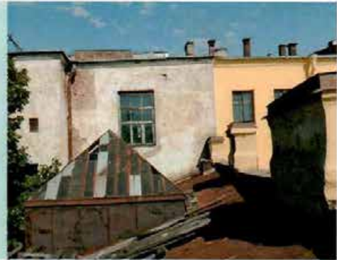
Фото 11. Галерная ул., д. 35. Вид крыши.
