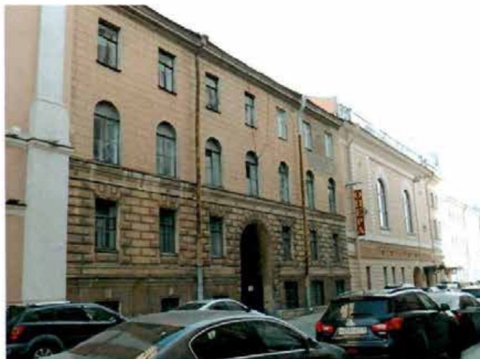
Фото 3. Лицевой фасад по Галерной ул., д. 35.
