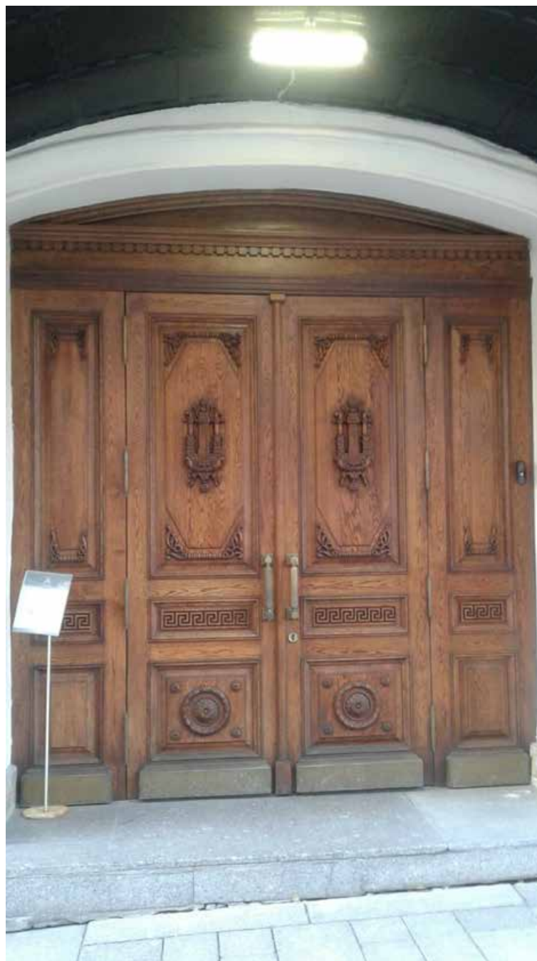
19. Объект культурного наследия федерального значения «Дом фон Дервиза С.П. с дворовыми флигелями», расположенный по адресу: г. Санкт-Петербург, Адмиралтейский район, Галерная ул., д. 35, литера А (Английская наб., 34, Галерная ул., 33, 35). Лицевой фасад по Галерной улице дом №33. Дверное заполнение.
