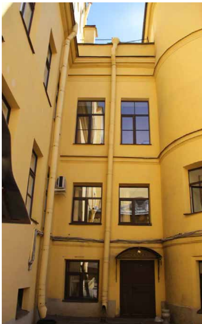
24. Объект культурного наследия федерального значения «Дом фон Дервиза С.П. с дворовыми флигелями», расположенный по адресу: г. Санкт-Петербург, Адмиралтейский район, Галерная ул., д. 35, литера А (Английская наб., 34, Галерная ул., 33, 35). Дворовый фасад в осях 17-9/Б-Е' (оси по проекту). Фрагмент.
