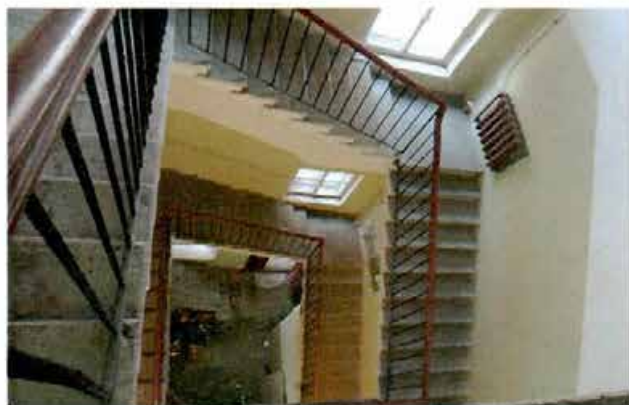
Фото 16. Галерная ул., д. 35. Лестница в западном флигеле.
