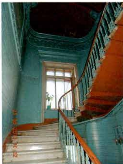
Фото 14. Галерная ул., д. 35. Лестница.
