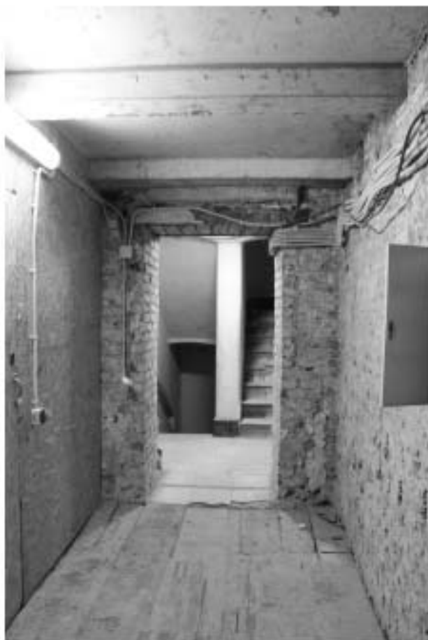
Фото 33. Флигель №3. Вид на площадку исторической лестницы из коридора 2-го этажа.
