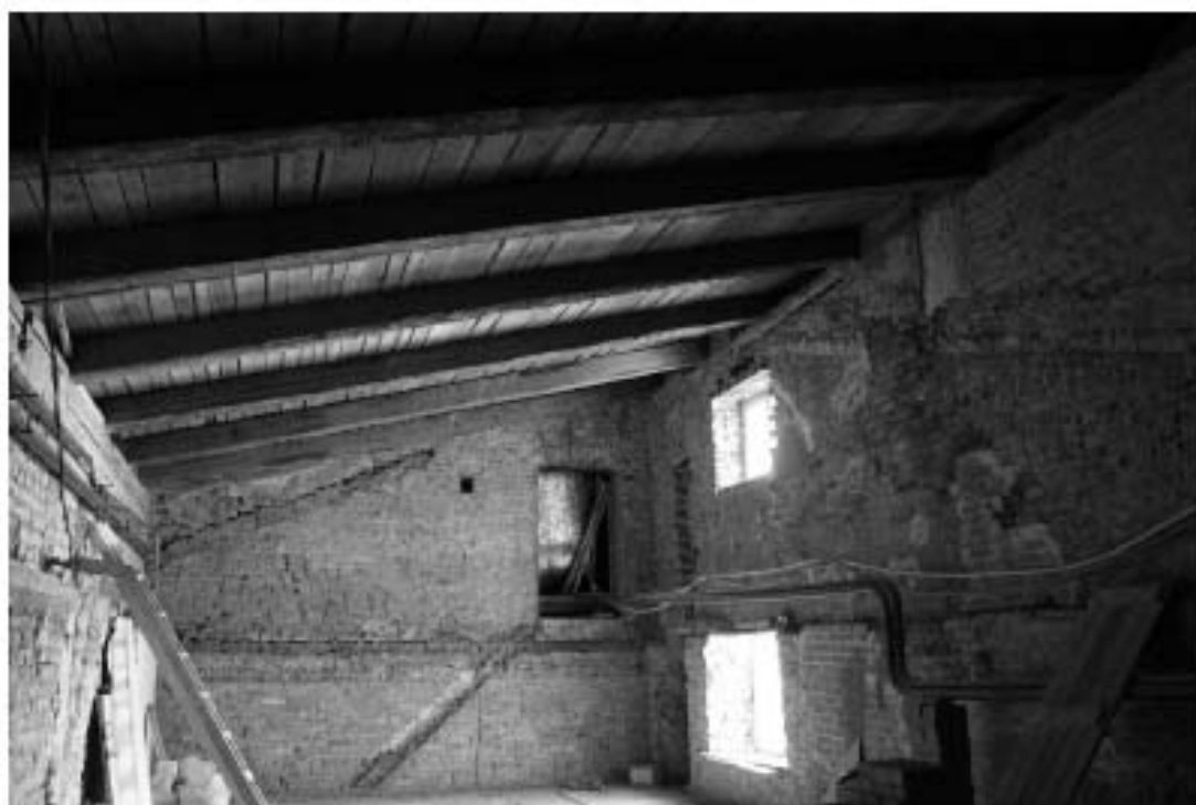
Фото 41. Флигель №3. Северная часть чердака.
