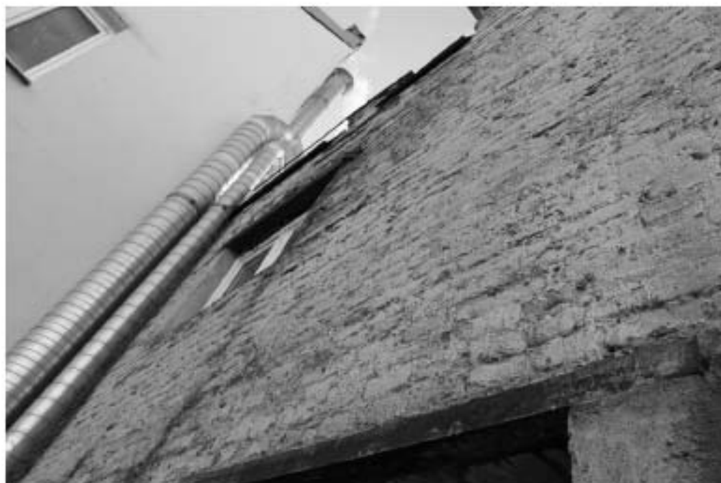
Фото 18. Фрагмент восточного фасада флигеля № 3. Вид с балкона
