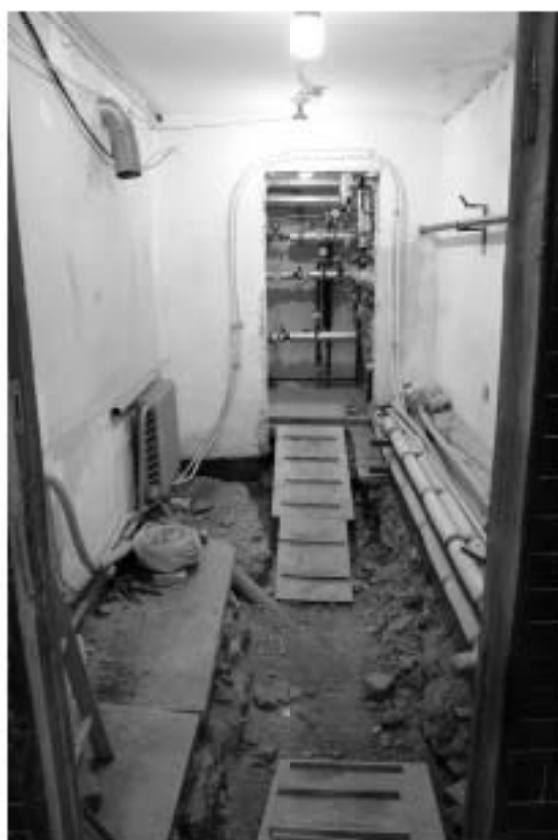
Фото 28. Флигель №3. 1 этаж. Северная часть продольного коридора с траншеей с прокладкой коммуникаций.
