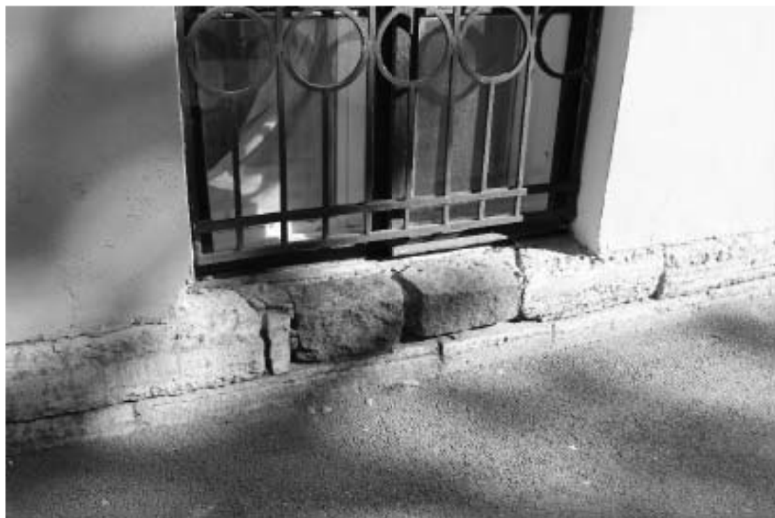
Фото 9. Фрагмент цоколя западного фасада флигеля №3
