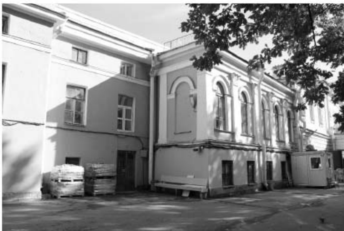
Фото 12. Общий вид западного фасада флигеля №4 и фрагмента фасада флигеля №3
