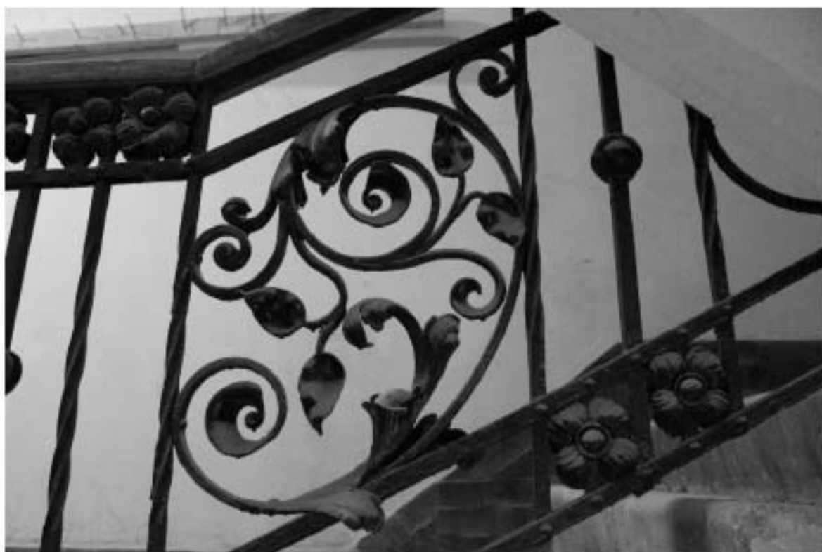
Фото 24. Флигель №4. Поздняя лестница. Фрагмент ограждения.
