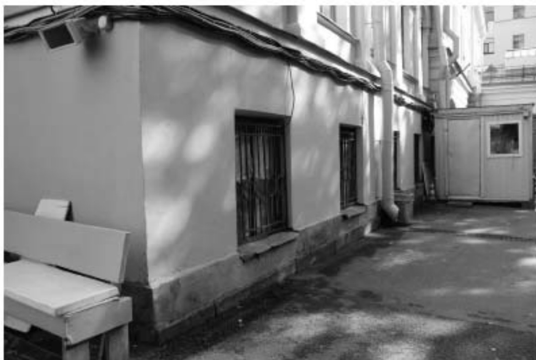
Фото 15. Общий вид на цоколь западного фасада флигеля №4
