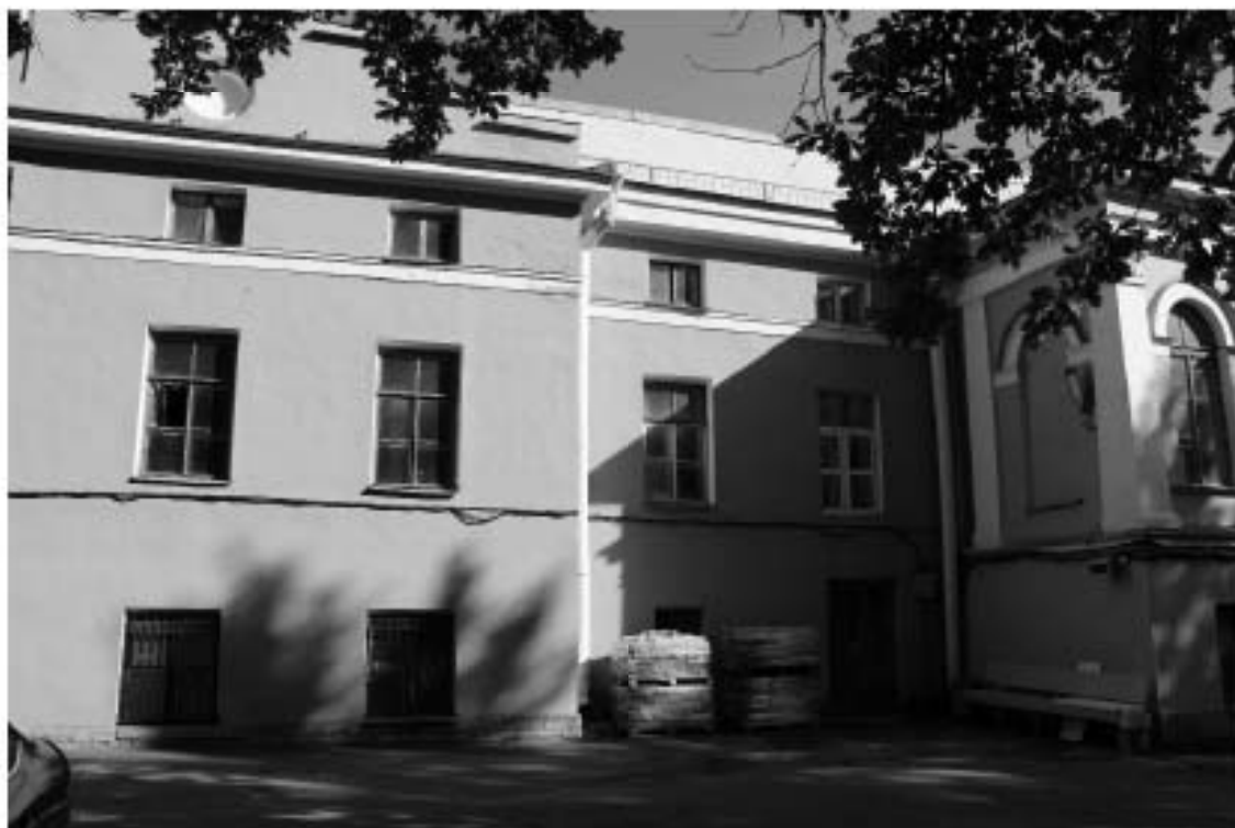
Фото 10. Фрагмент западного фасада флигеля №3
