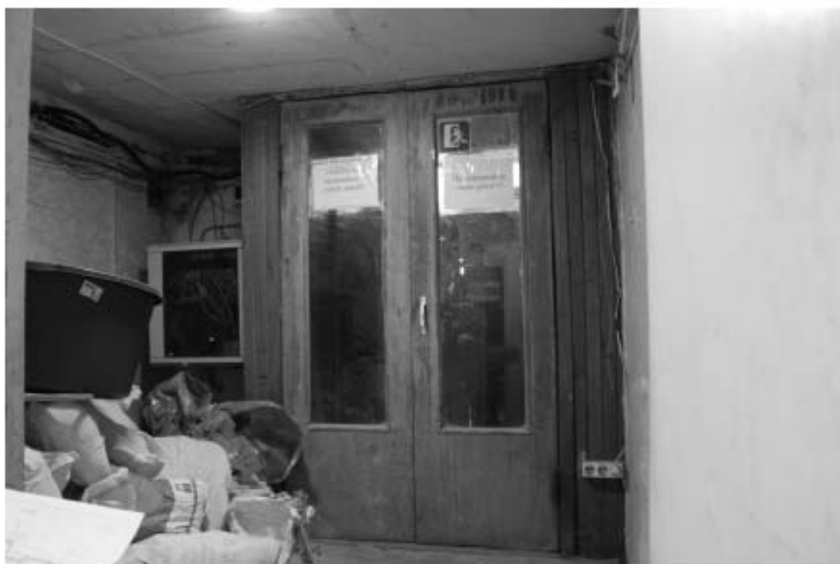
Фото 26. Флигель №3. Вид из интерьера на западный вход
