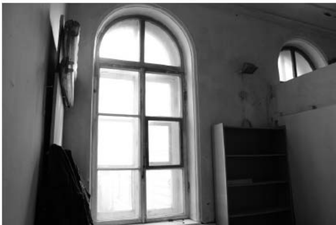
Фото 36. Флигель №4. Фрагмент помещения 2-го этажа. Окна на южной стороне.
