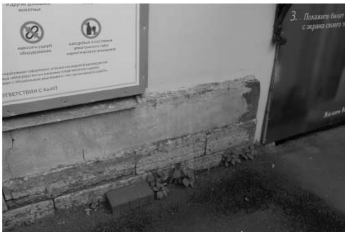
Фото 4. Фрагмент цоколя на южном фасаде флигеля №4
