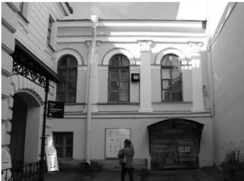
Фото 1. Общий вид южного фасада флигеля № 4 с юго-востока.
