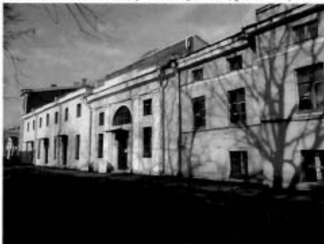
9. Восточный дворовый фасад (флигели)
