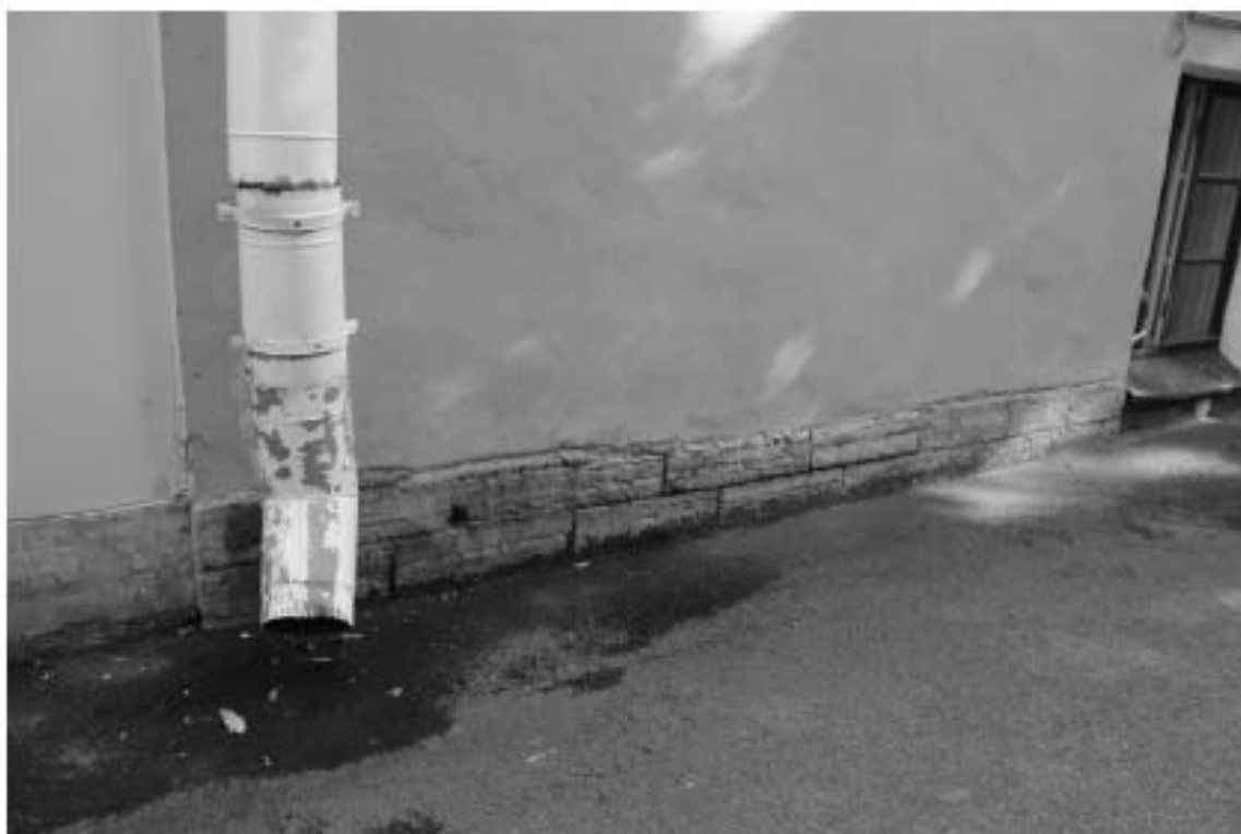
Фото 8. Фрагмент цоколя западного фасада флигеля №3
