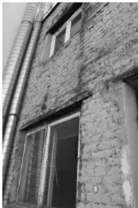
Фото 19. Фрагмент восточного фасада флигеля № 3. Вид с балкона
