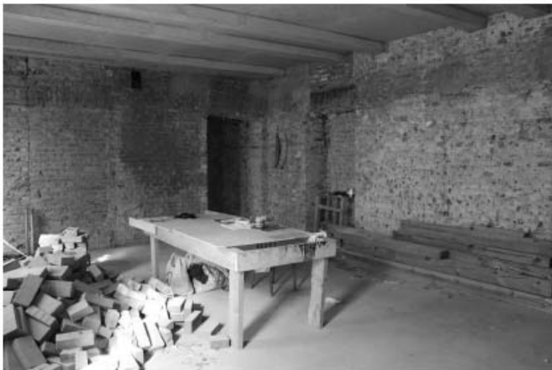
Фото 35. Флигель №3. 2 этаж. Вид на северную и восточную стену.
