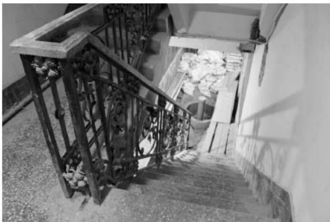
Фото 25. Флигель №4. Поздняя лестница. Фрагмент ограждения с площадки 2 этажа.
