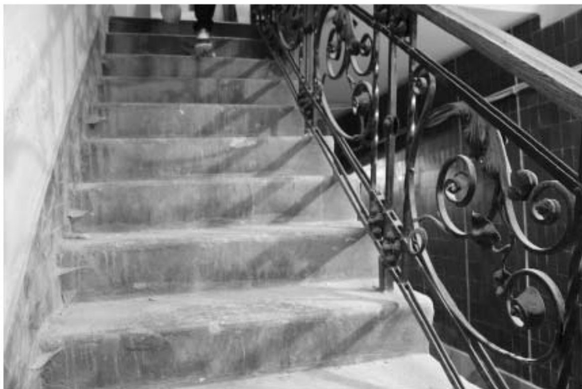
Фото 23. Флигель №4. Поздняя лестница. Фрагмент ограждения.
