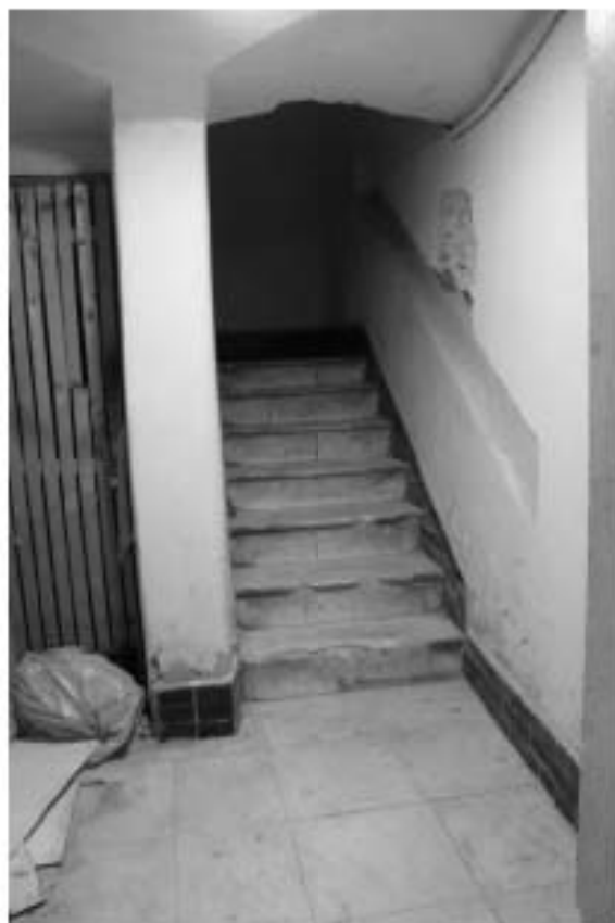
Фото 31. Флигель №3. 1 этаж. Нижний марш исторической лестницы.
