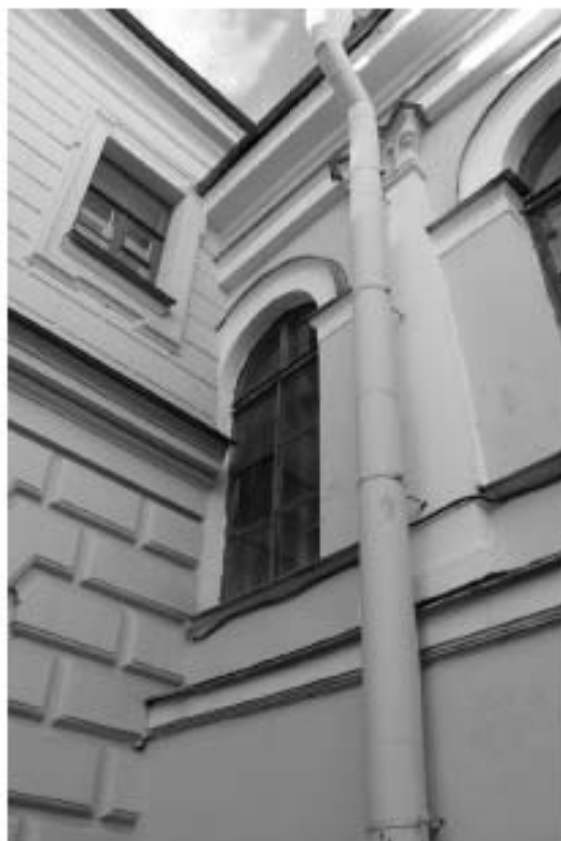
Фото 5. Фрагмент южного фасада флигеля №4
