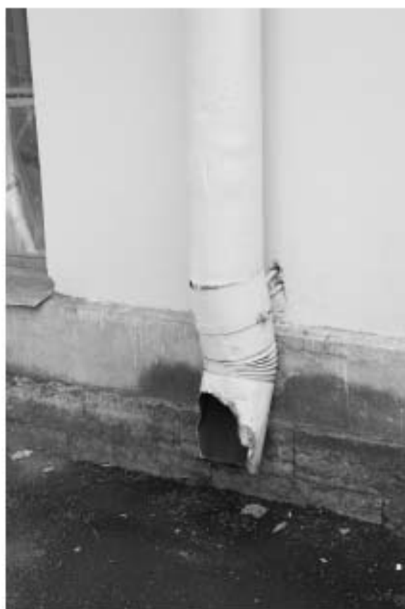
Фото 6. Фрагмент цоколя и водосточной трубы на южном фасаде флигеля №4
