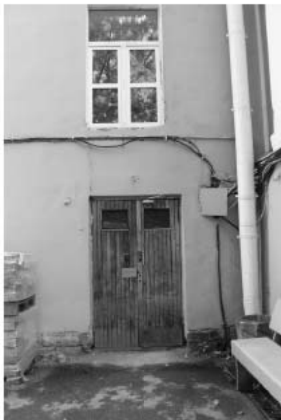
Фото 11. Вход в здание. Западный фасад флигеля №3.
