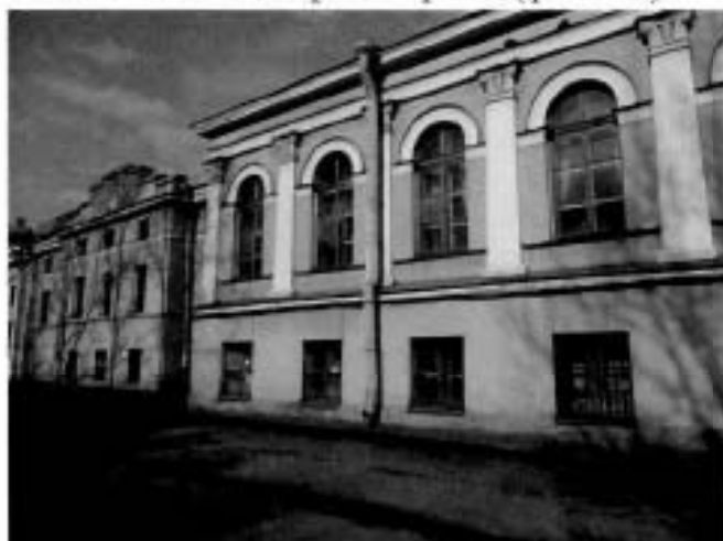
10. Восточный дворовый фасад (флигели)
