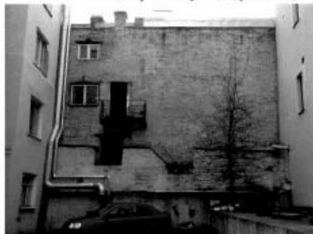
4. Восточный дворовый фасад (флигели)
