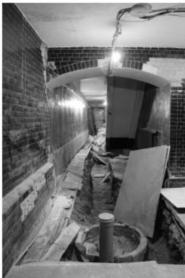
Фото 30. Флигель №3. 1 этаж. Арка. Вид со стороны бывшего двора.
