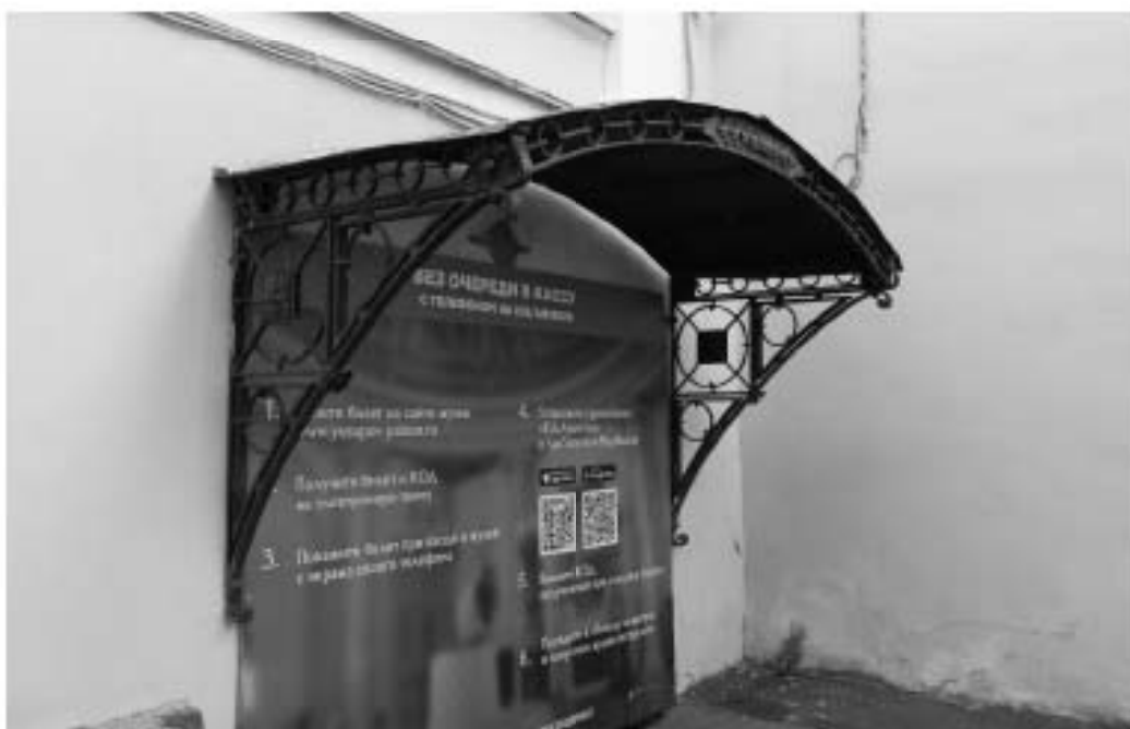
Фото 2. Металлический козырек над главным входом с южной стороны флигеля № 4
