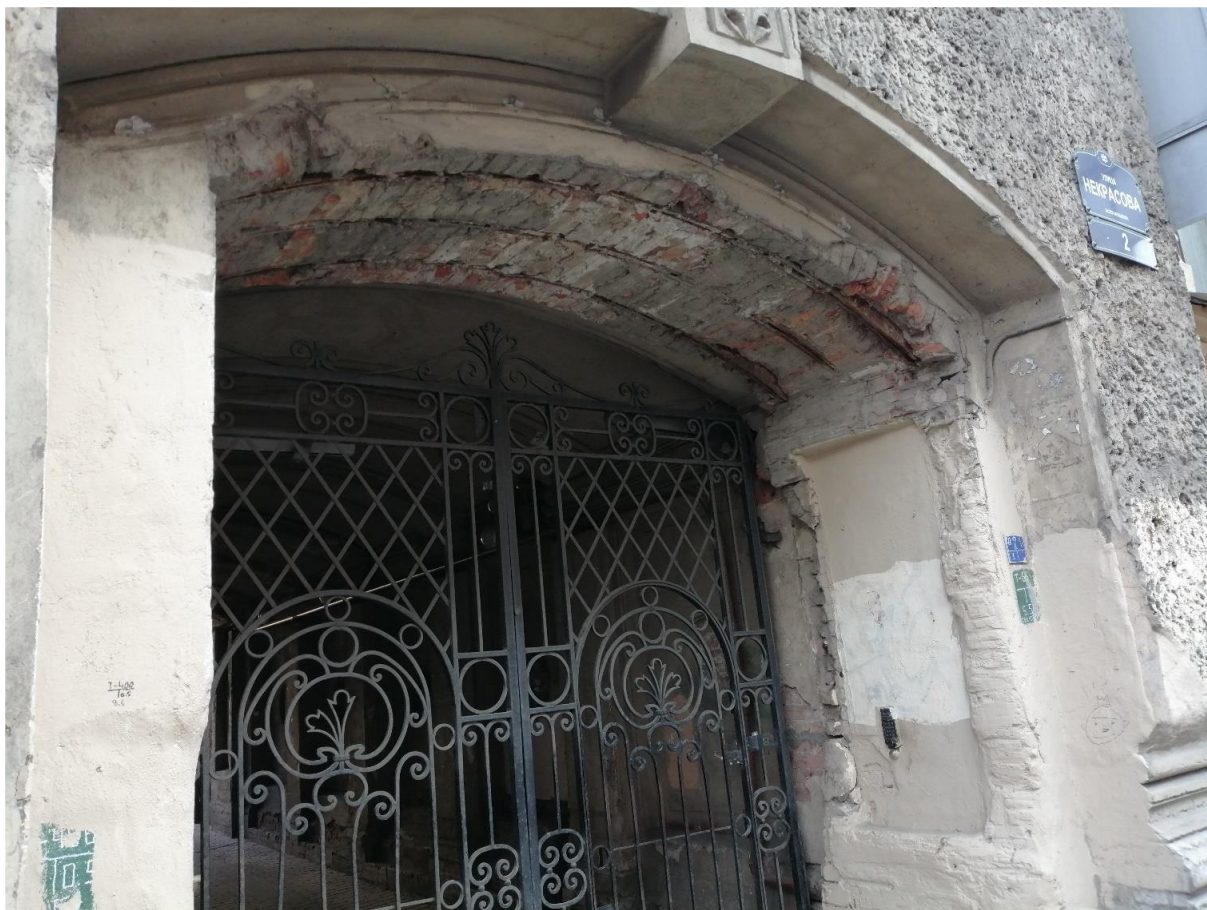
Фото 10. Металлические ворота арочного проезда со стороны лицевого фасада 4-х этажного лицевого корпуса по ул. Некрасова.
