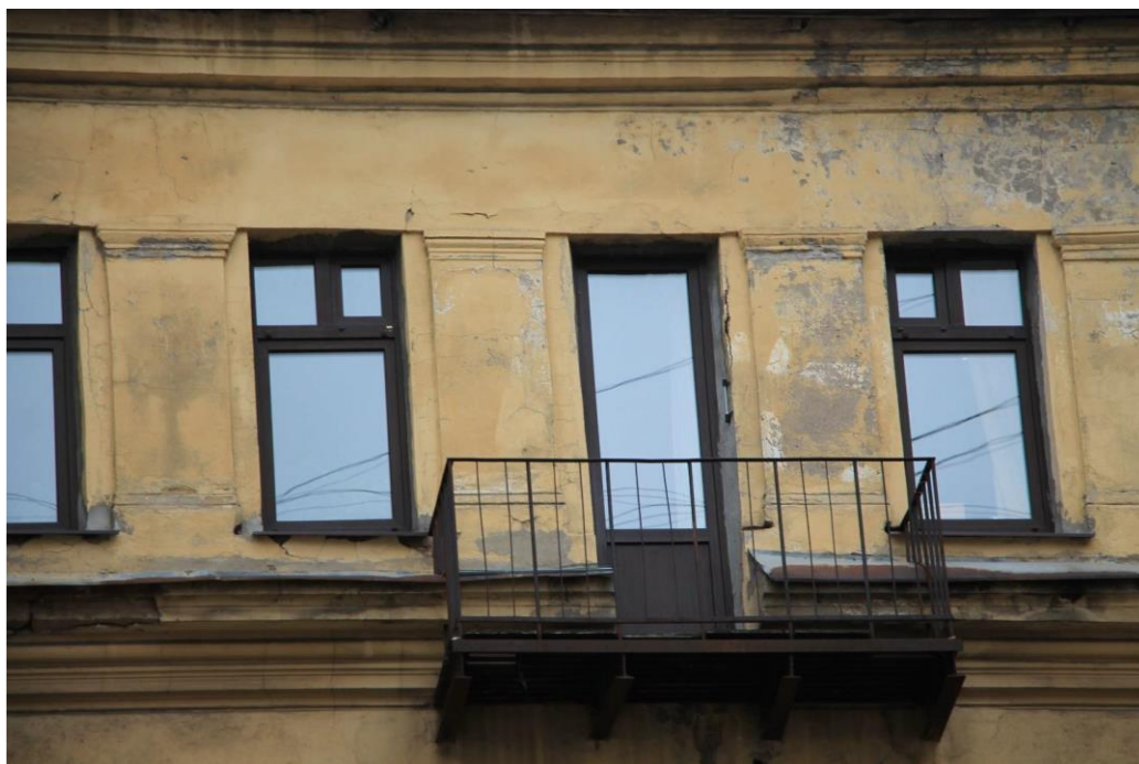
Фото 23. Балкон в уровне 5 этажа дворового фасада поперечного внутриворотового корпуса.
