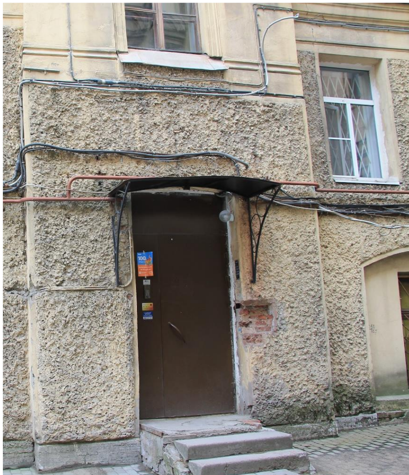
Фото 26. Уп্লощенный ризалит входа дворового фасада внутривдорового корпуса, вход с бетонным крыльцом на лестницу №3.
