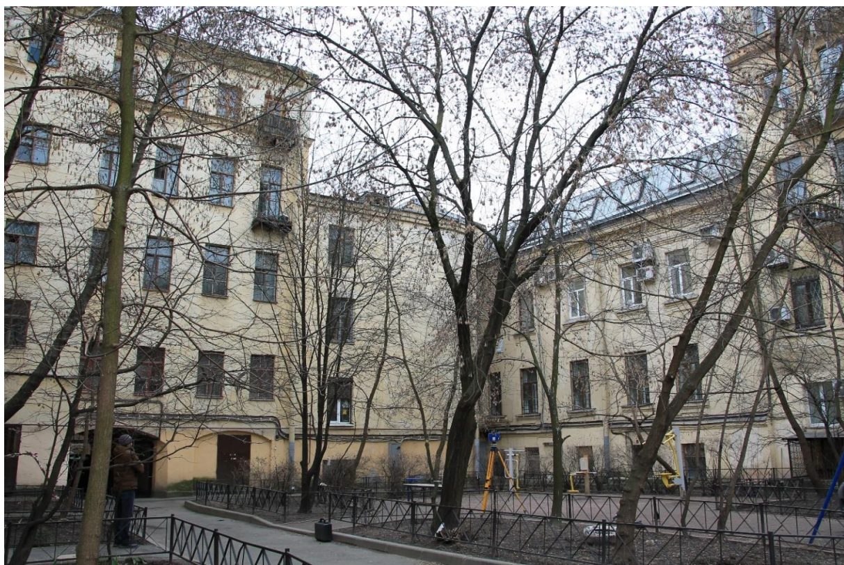
Фото 19. Вид на дворовые фасады в месте пересечения 5-и этажного внутридворового корпуса с угловым 3-х этажным лицевым корпусом.
