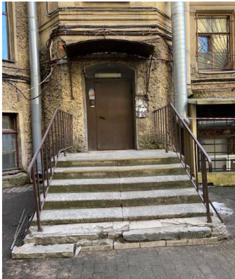
Фото 24. Трехгранный ризалит лестничной клетки, крыльцо входа на лестницу №2 со стороны дворового фасада
