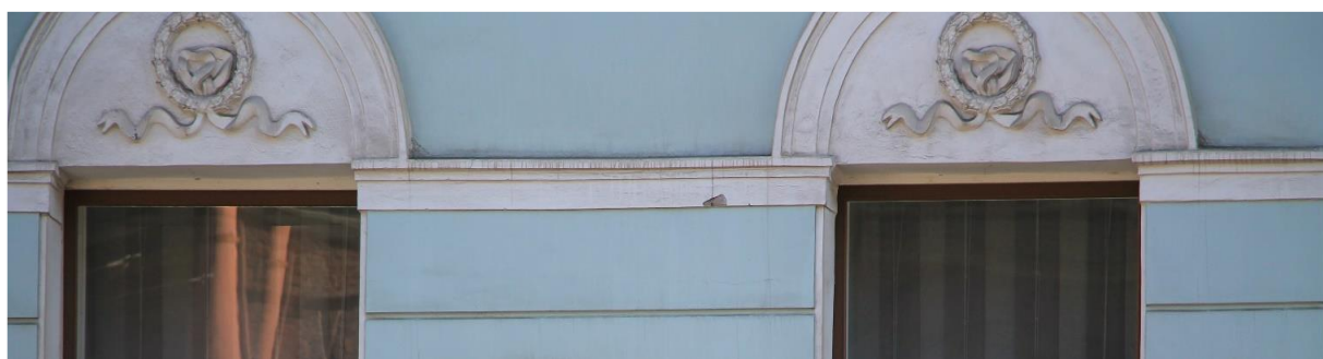
Фото 8. Декор оконных проемов лицевого фасада углового 3-х этажного лицевого корпуса по Литейному пр. (линейные сандрики на стилизованных кронштейнах с растительным орнаментом, профилированные архивольты с лепным рельефом в виде венка с лентами – в тимпанах).
