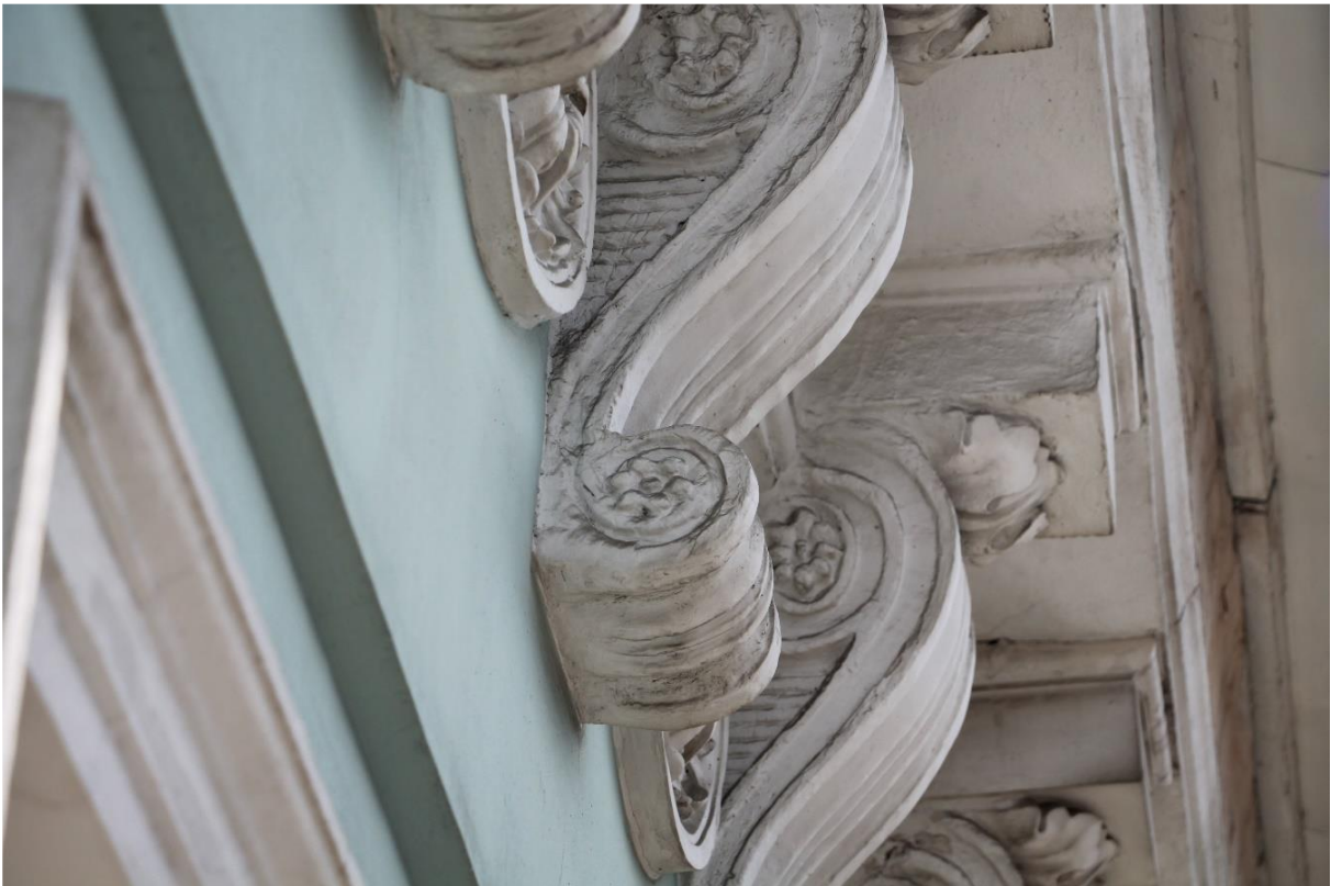
Фото 5. Фрагмент венчающего карниза с кронштейнами лицевого фасада углового 3-х этажного лицевого корпуса по Литейному пр.
