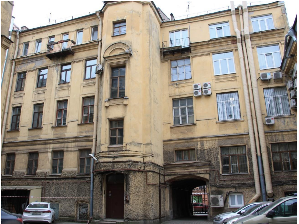
Фото 20. Дворовый фасад 4-х этажного лицевого корпуса по ул. Некрасова с арочным проездом, лестничным ризалитом.
