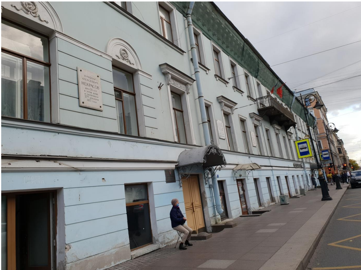
Фото 2. Протяженный лицевой фасад по Литейному пр. (в стиле классицизма) углового 3-х этажного лицевого корпуса
