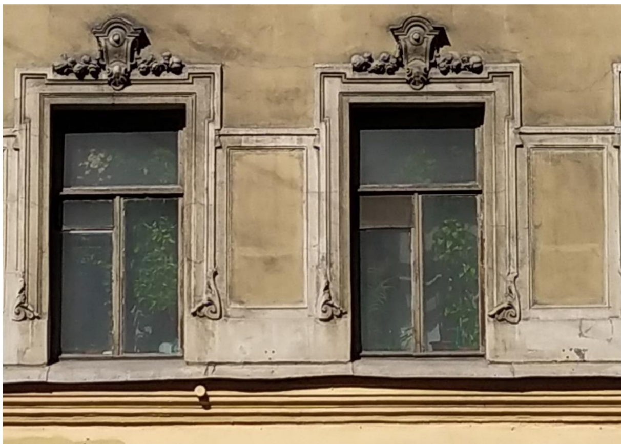
Фото 16. Фрагмент лицевого фасада 4-х этажного лицевого корпуса по ул. Некрасова. Декор оконных проемов на уровне 2 этажа (профилированные фигурные наличники с замковым камнем и с растительным орнаментом)
