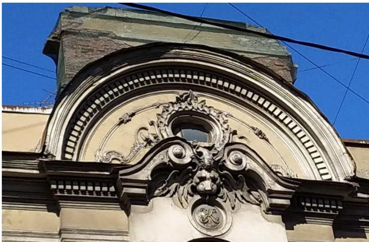
Фото 12. Фрагмент лицевого фасада 4-х этажного лицевого корпуса по ул. Некрасова. Полуциркульный фронтон с лепной композицией (лепной рельеф со стилизованным изображением грифона в поле, лепное обрамление растительного орнамента люкарны, лепная декоративная рама растительного орнамента).
