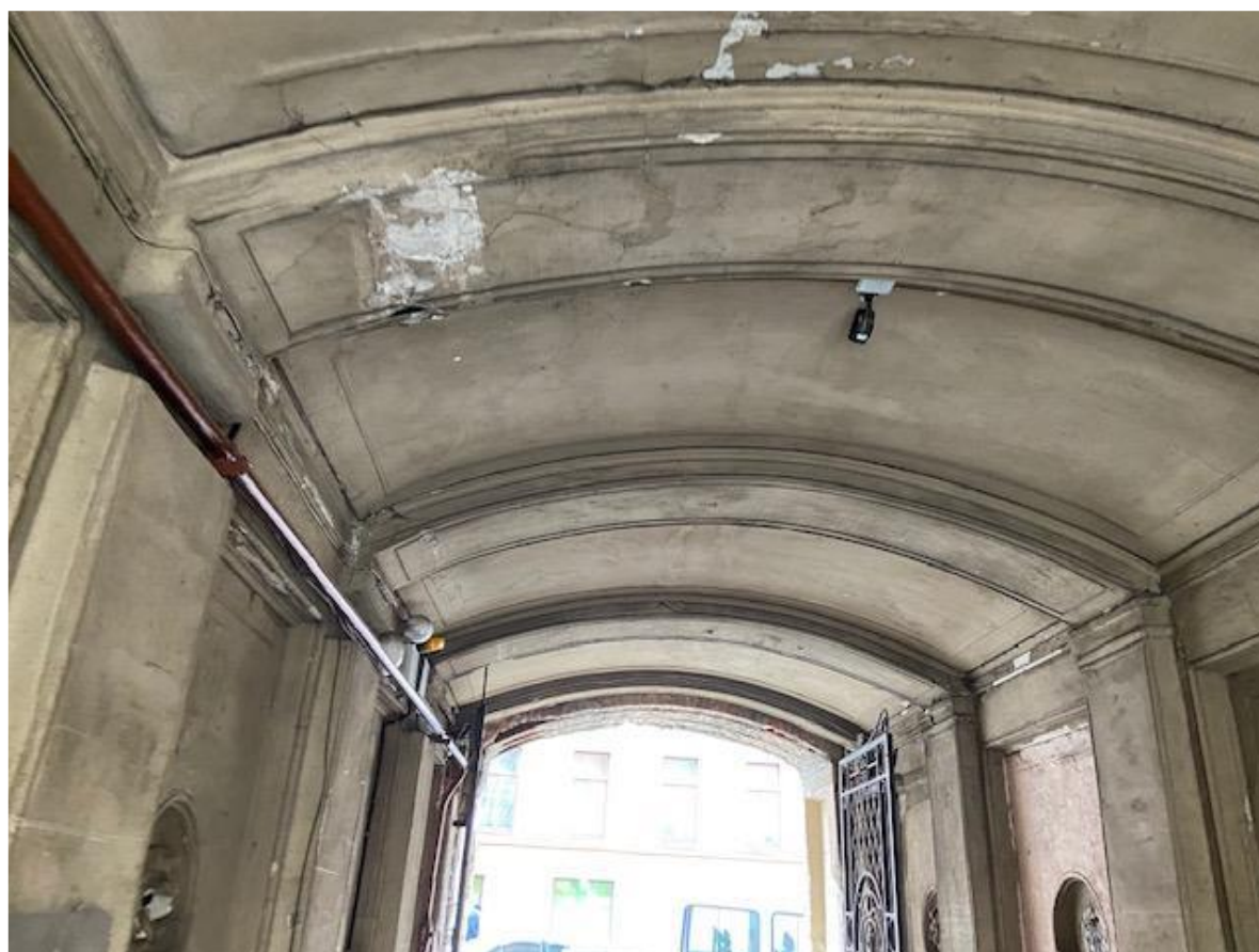
Фото 13. Вид на штукатурное оформление арочного проезда во двор лицевого фасада 4-х этажного лицевого корпуса по ул. Некрасова.
