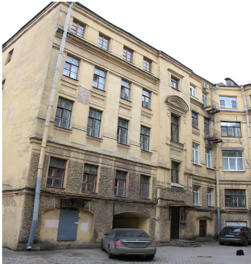
Фото 22. Дворовой фасад 5-ти этажного внутриворного корпуса.
