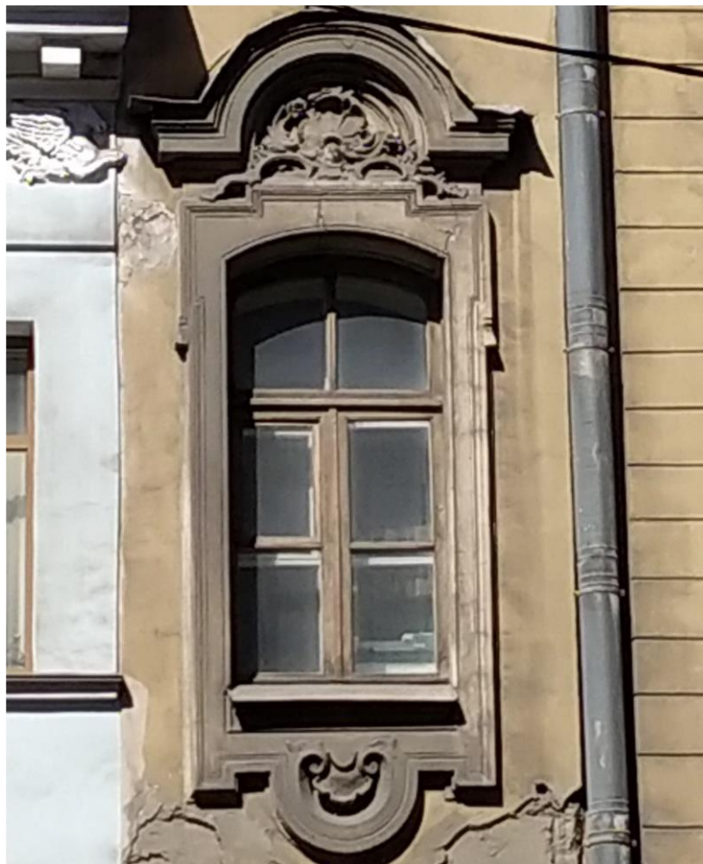
Фото 17. Фрагмент лицевого фасада 4-х этажного лицевого корпуса по ул. Некрасова в месте примыкания к угловому 3-х этажному корпусу. Декор оконного проема на уровне 2 этажа.
