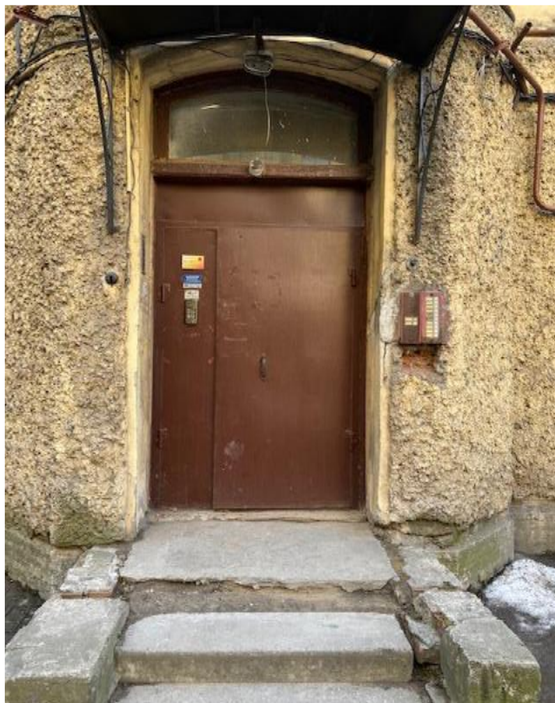
Фото 24. Вход на лестницу №1 с крыльцом со стороны дворового фасада 4-х этажного лицевого корпуса по ул. Некрасова.
