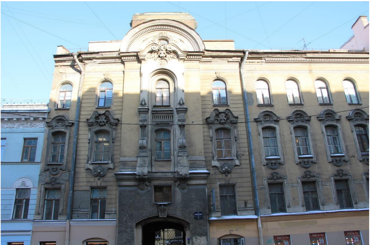
Фото 9. Лицевой фасад 4-х этажного лицевого корпуса по ул. Некрасова (в приемах эклектики). По третьей световой оси – уплощенный ризалит с арочным проездом во двор.
